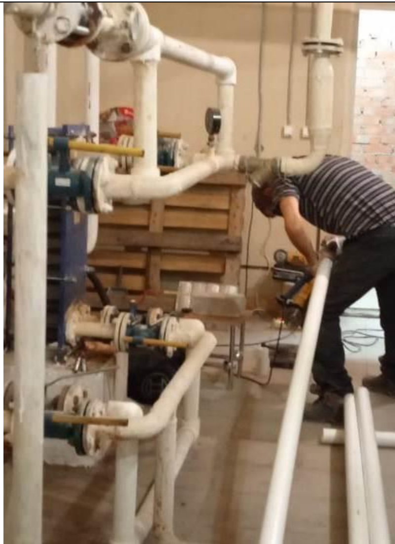
Выполнение работы по замене ввода ХВС с металла на пластик.
