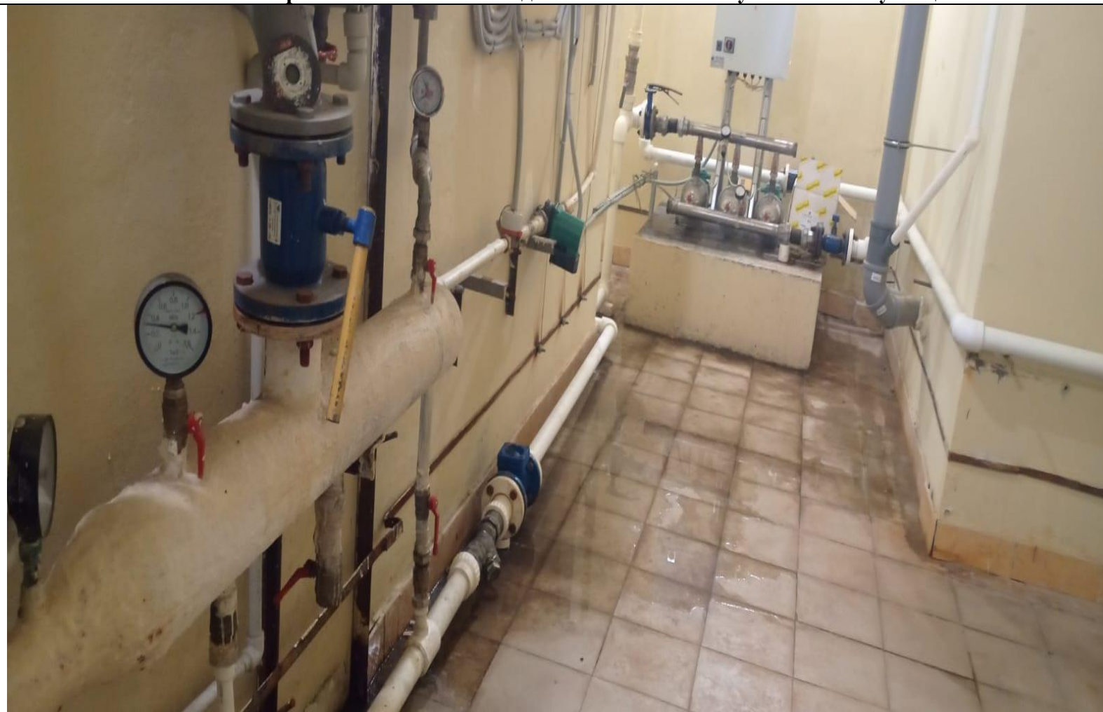
Выполнение работы по сезонной подготовке теплового пункта к эксплуатации.
