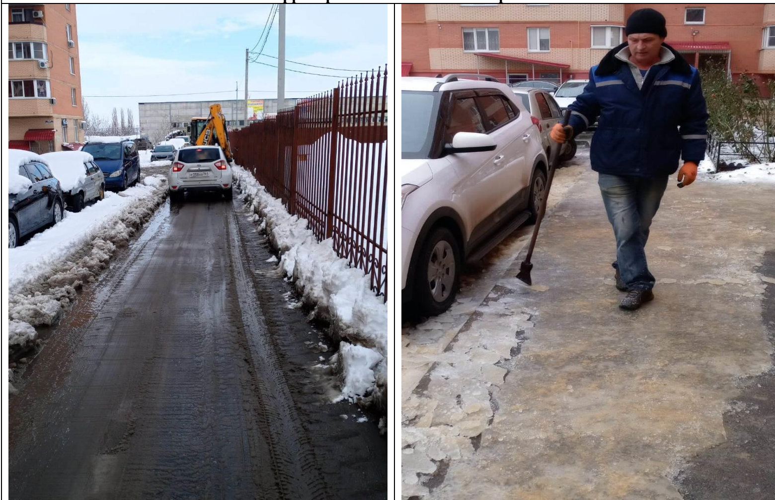
Очистка территории от снега и посыпка реагентами.
