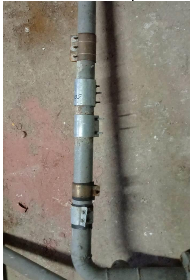
Выполнение работы по замене ввода ХВС с металла на пластик.
