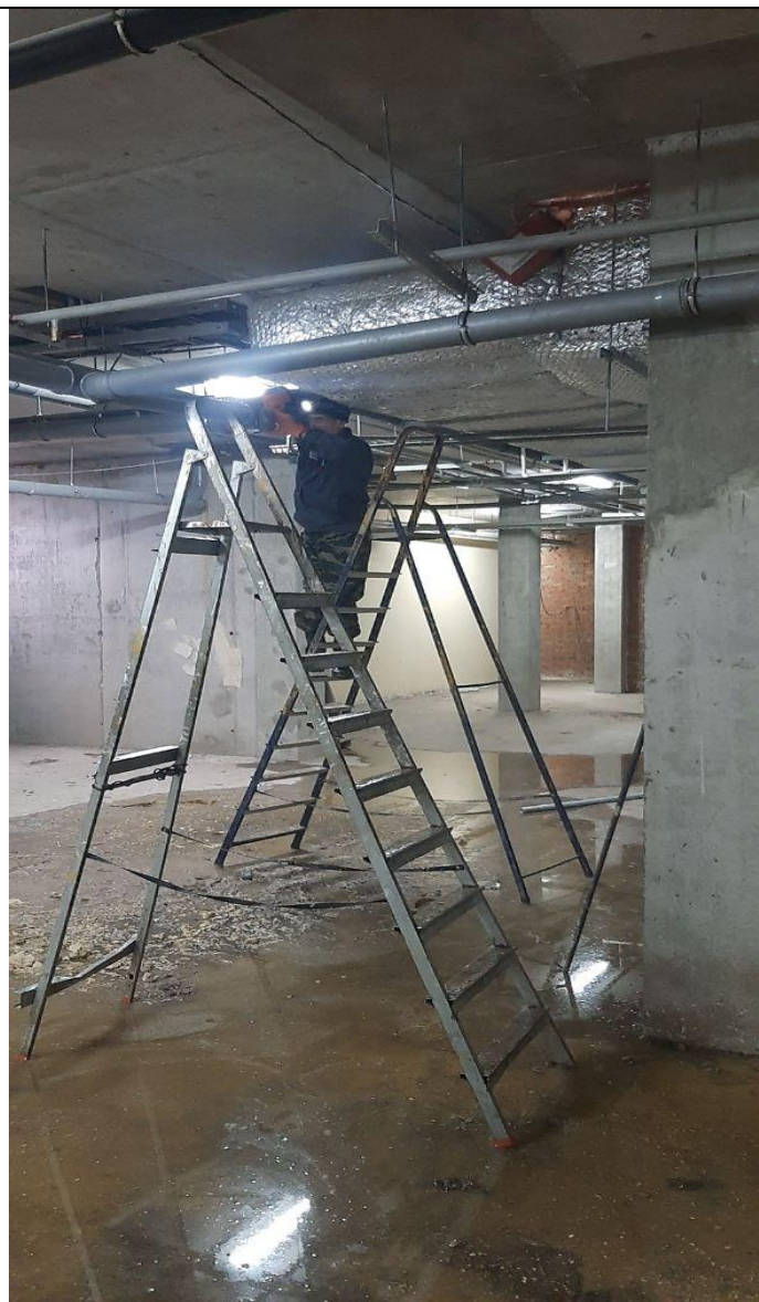
Замена лежаков канализации.
