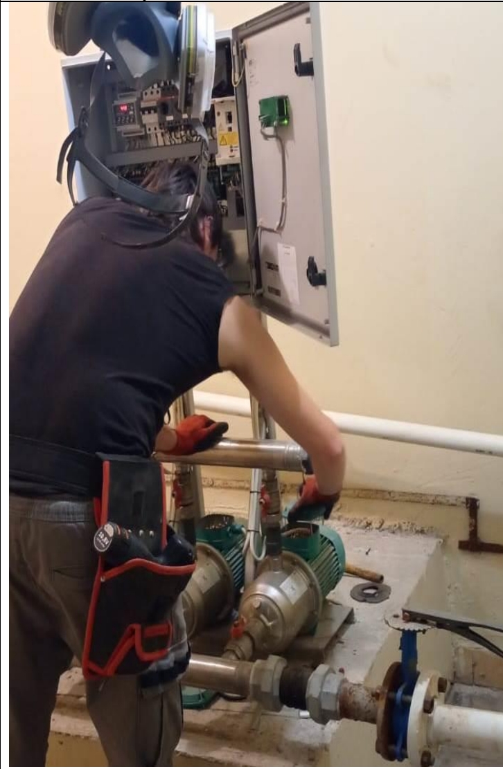
Обслуживание насосной станции.
