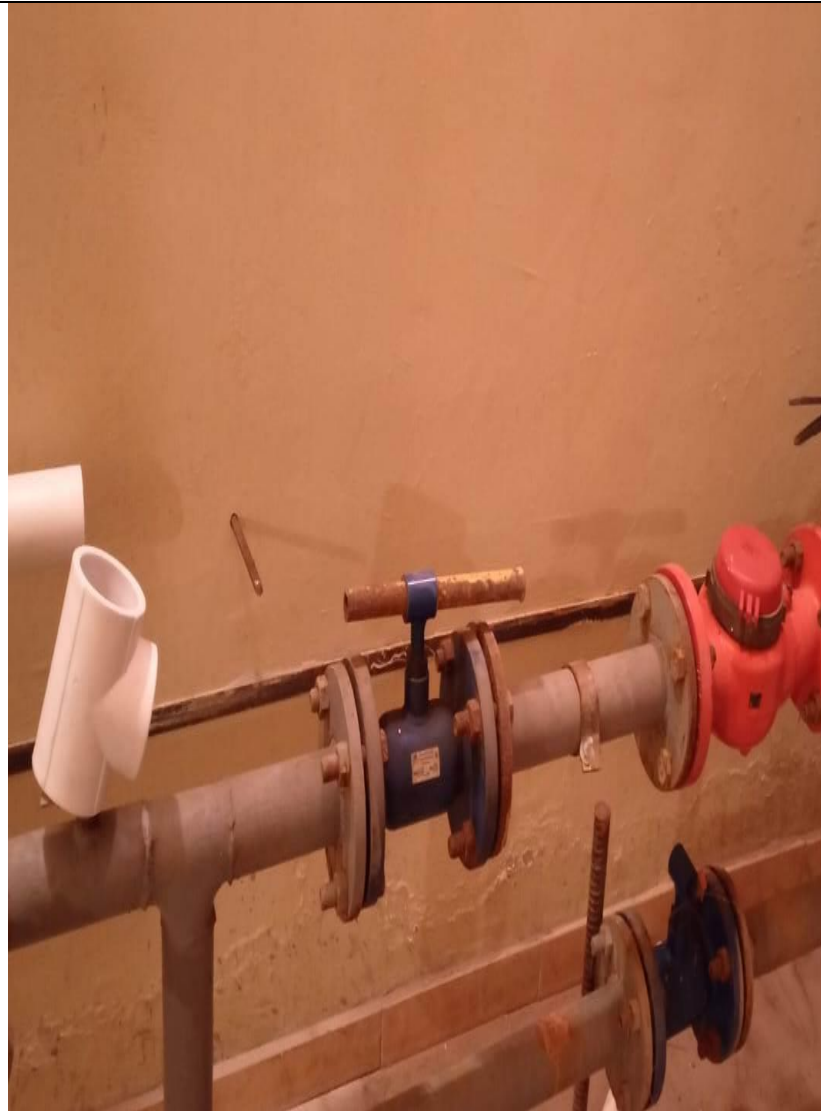
Замена ввода ХВС с металла на пластик.
