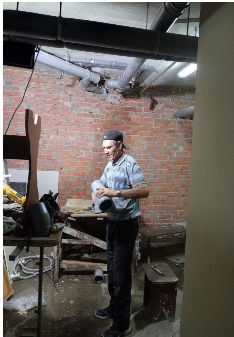
Замена лежаков канализации.
