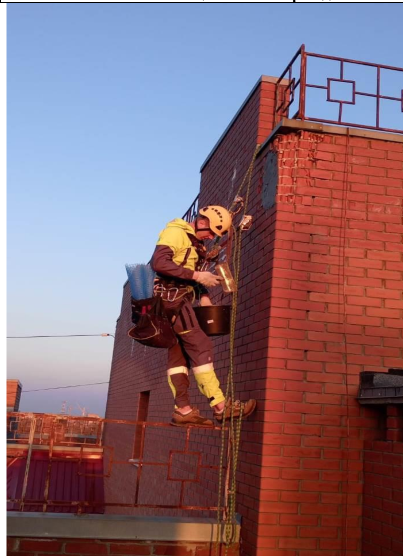
Восстановление целостности фасада.
