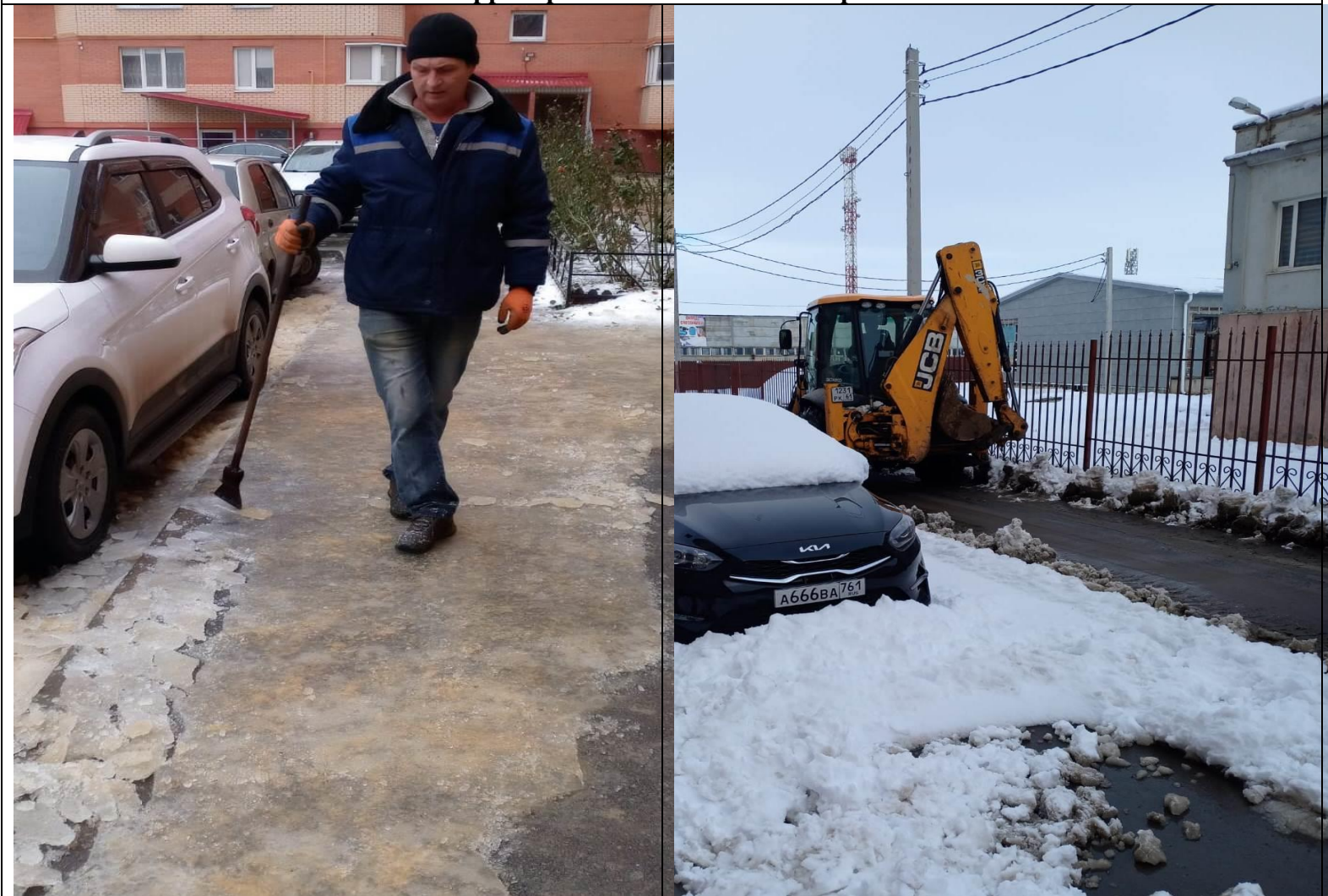
Очистка территории от снега и посыпка реагентами.
