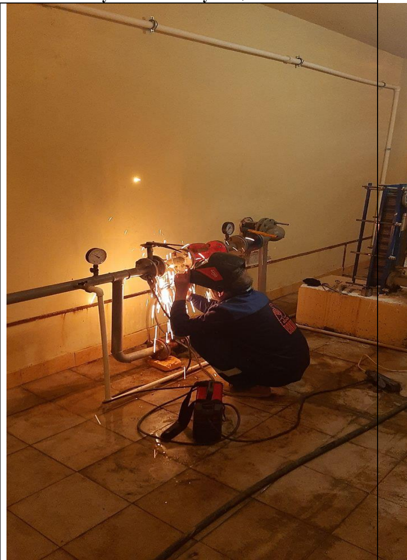
Выполнение работы по сезонной подготовке теплового пункта к эксплуатации.
