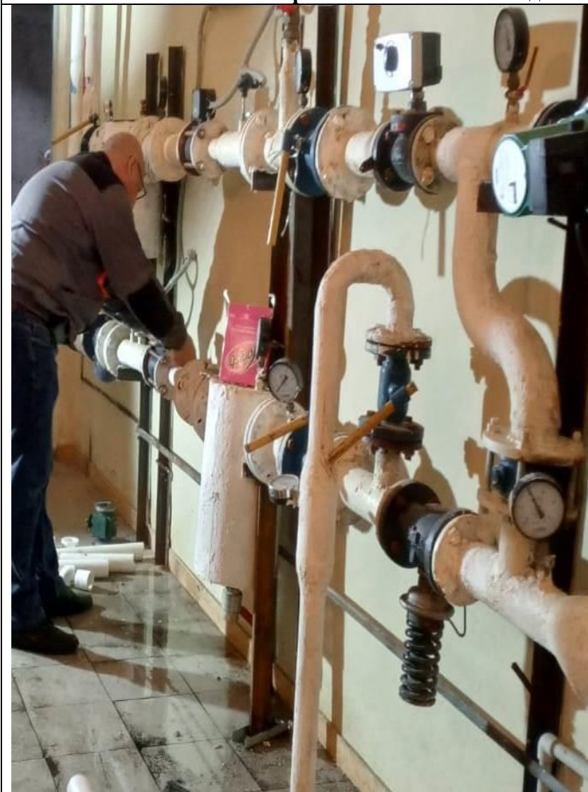
Выполнение работы по сезонной подготовке теплового пункта к эксплуатации.
