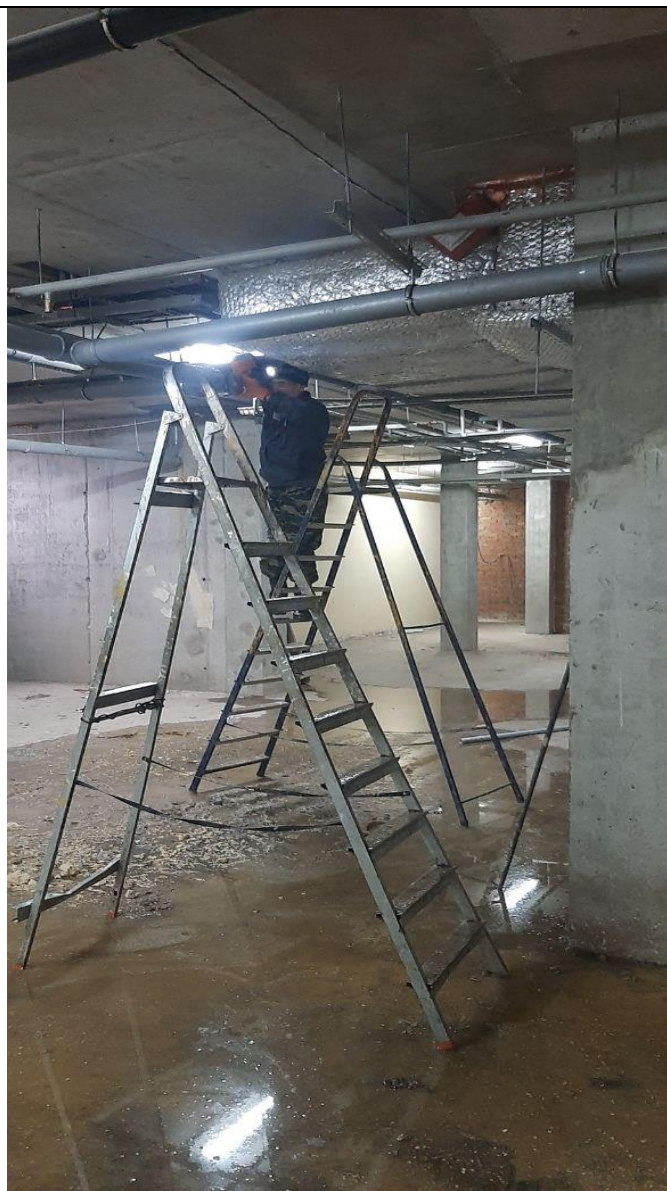
Замена лежаков канализации.
