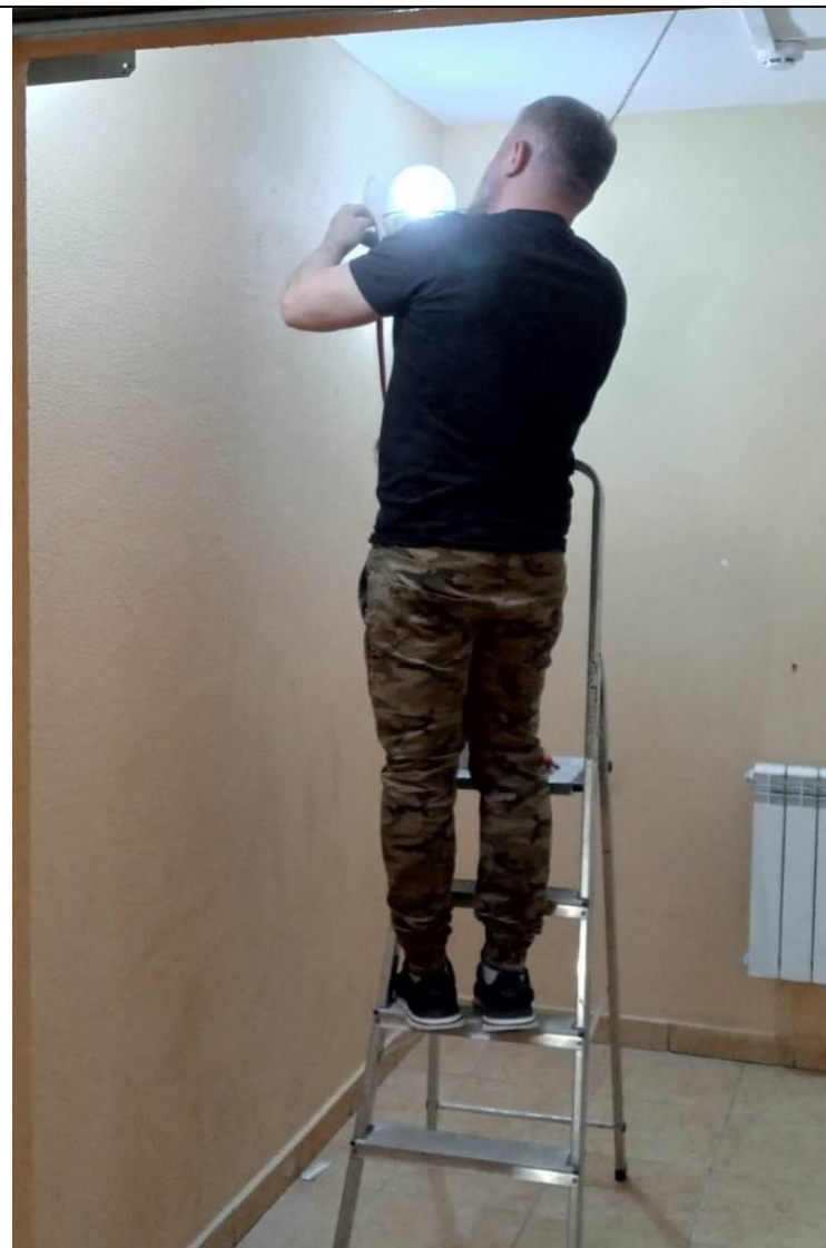
Замена светильников в МОП.
