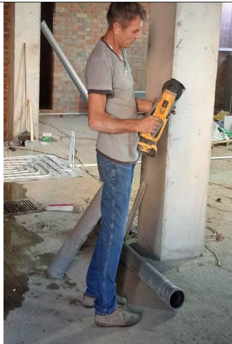
Замена участка лежака .
