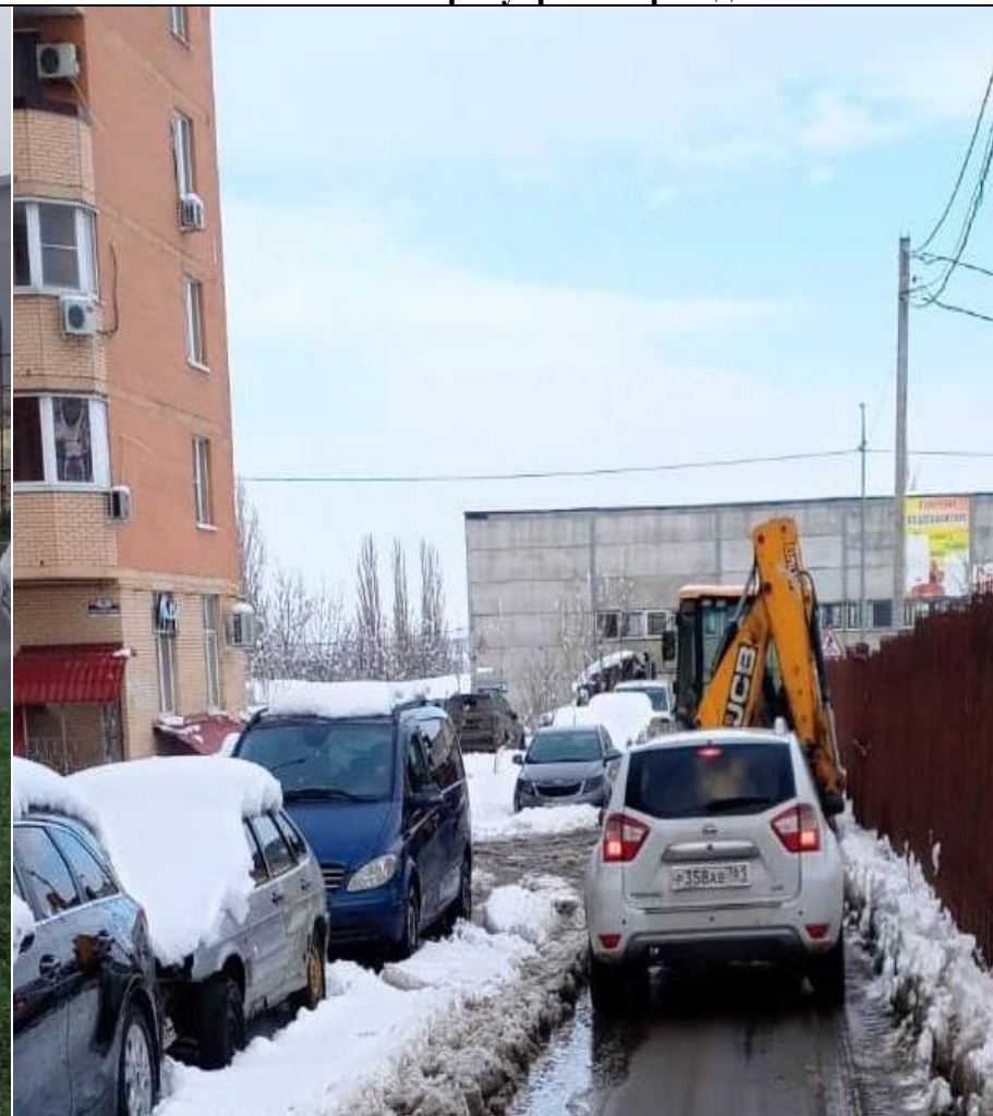
Очистка тротуаров и проездов.
