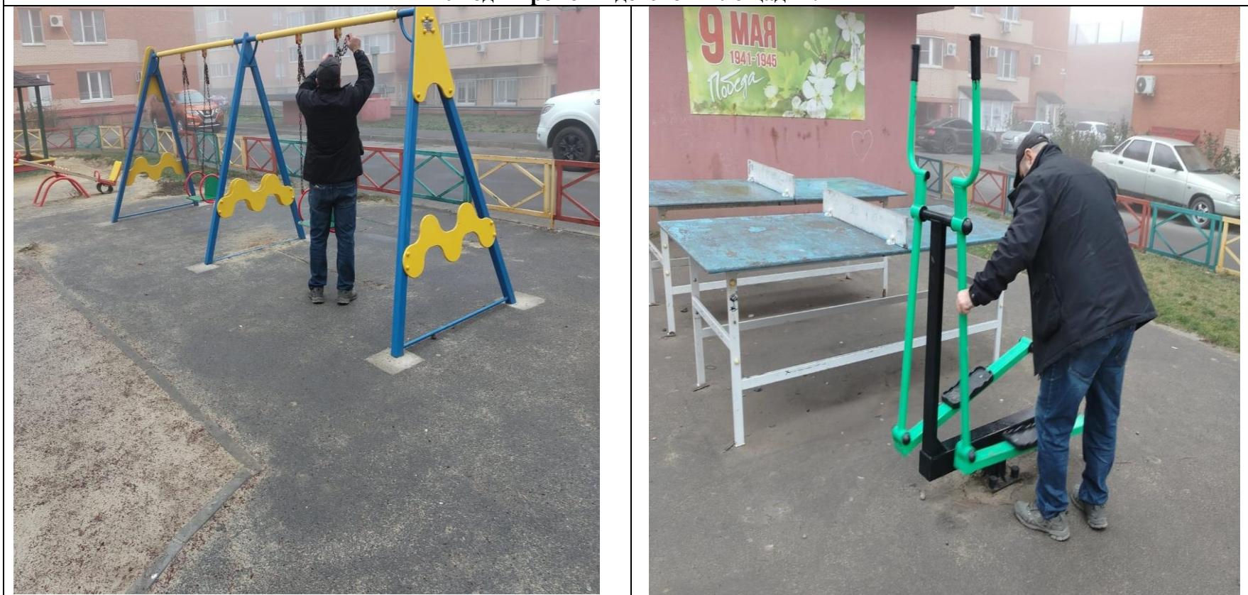
Уход и ремонт детской площадки.
