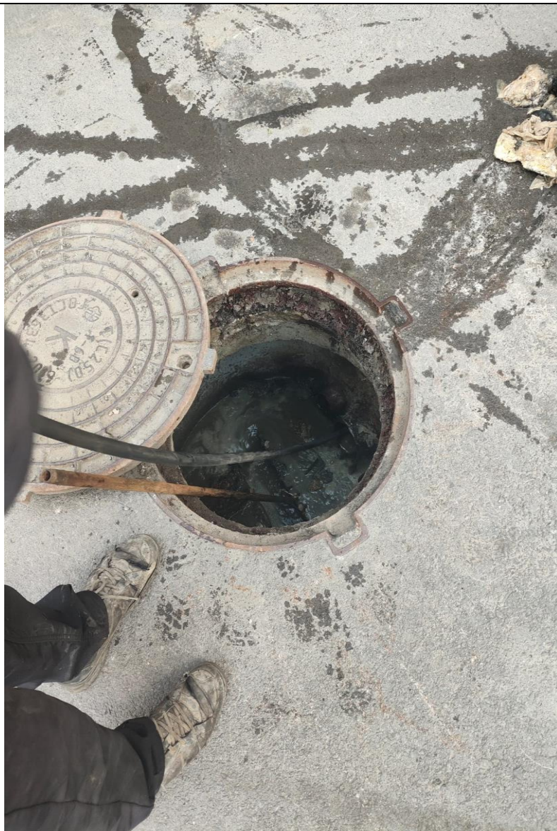
Гидродинамическая промывка выпуска.
