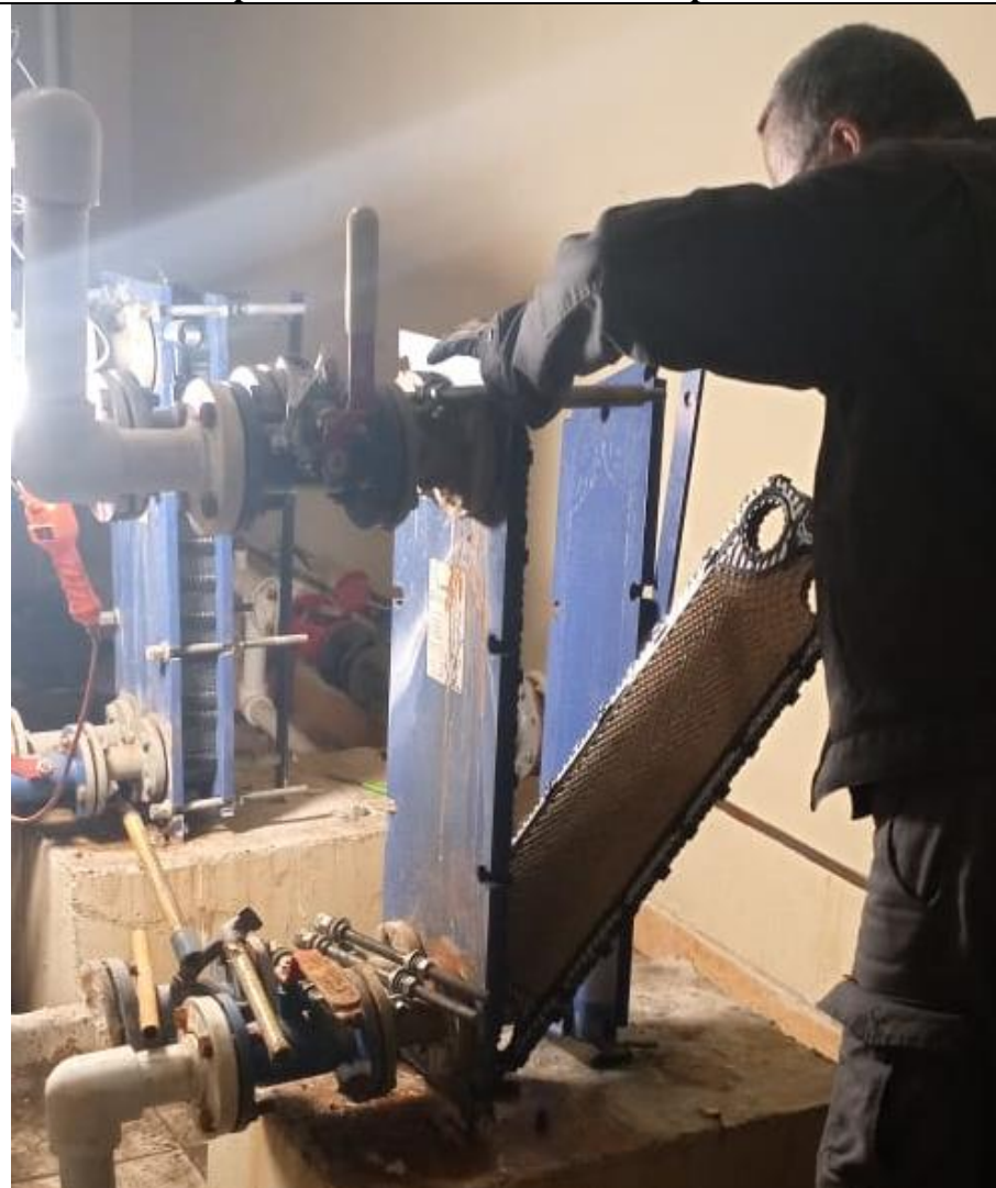
Сборка теплообменника после промывки
