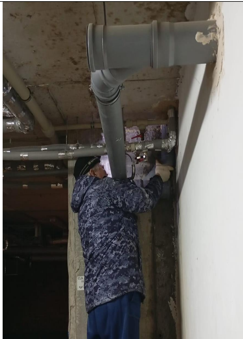
Замена лежаков канализации.
