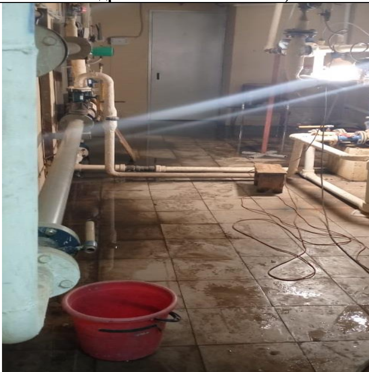
Подготовка теплового пункта к эксплуатации (гидравлические испытания)
