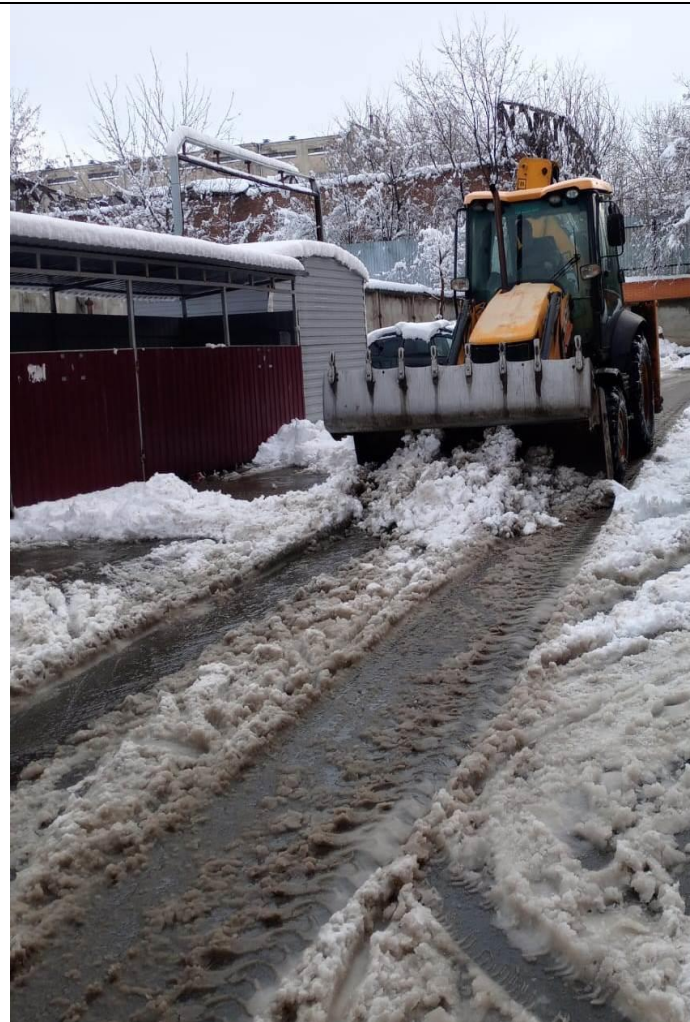
Очистка от снега.
