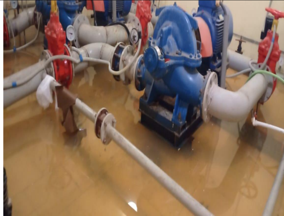
Устранение неисправности в системе водоснабжения.
