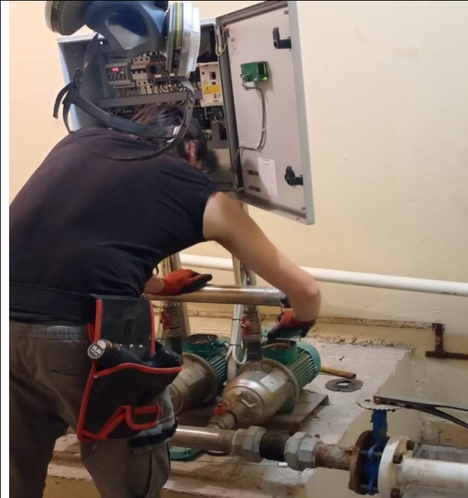
Обслуживание насосной станции.
