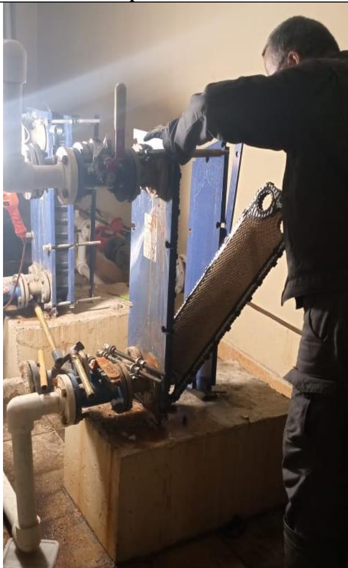
Подготовка к промывке теплообменника
