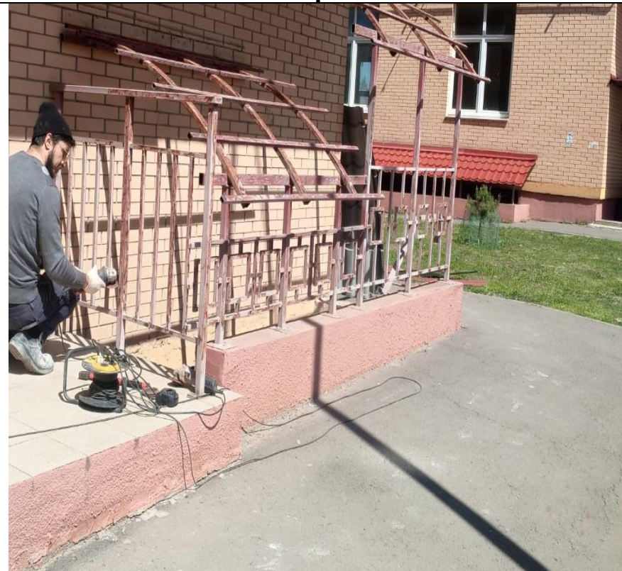
Ремонт и покраска навесов
