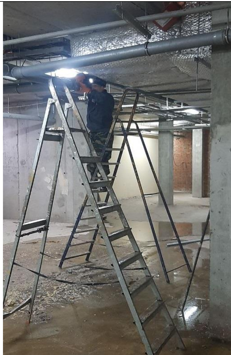
Замена лежаков канализации.
