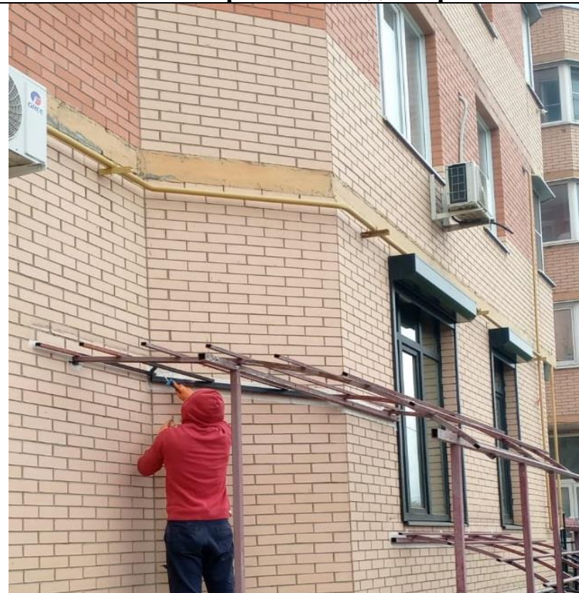
Ремонт и покраска. Фасадные работы
