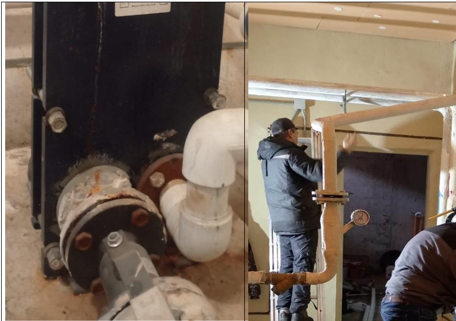
4.2 Насосная станция холодного водоснабжения.
