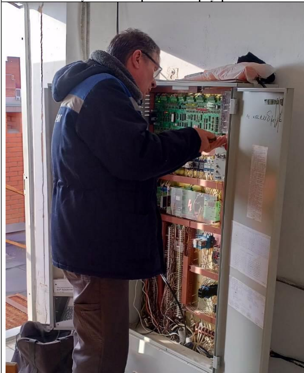
Техобслуживание лифтового шкафа управления.
