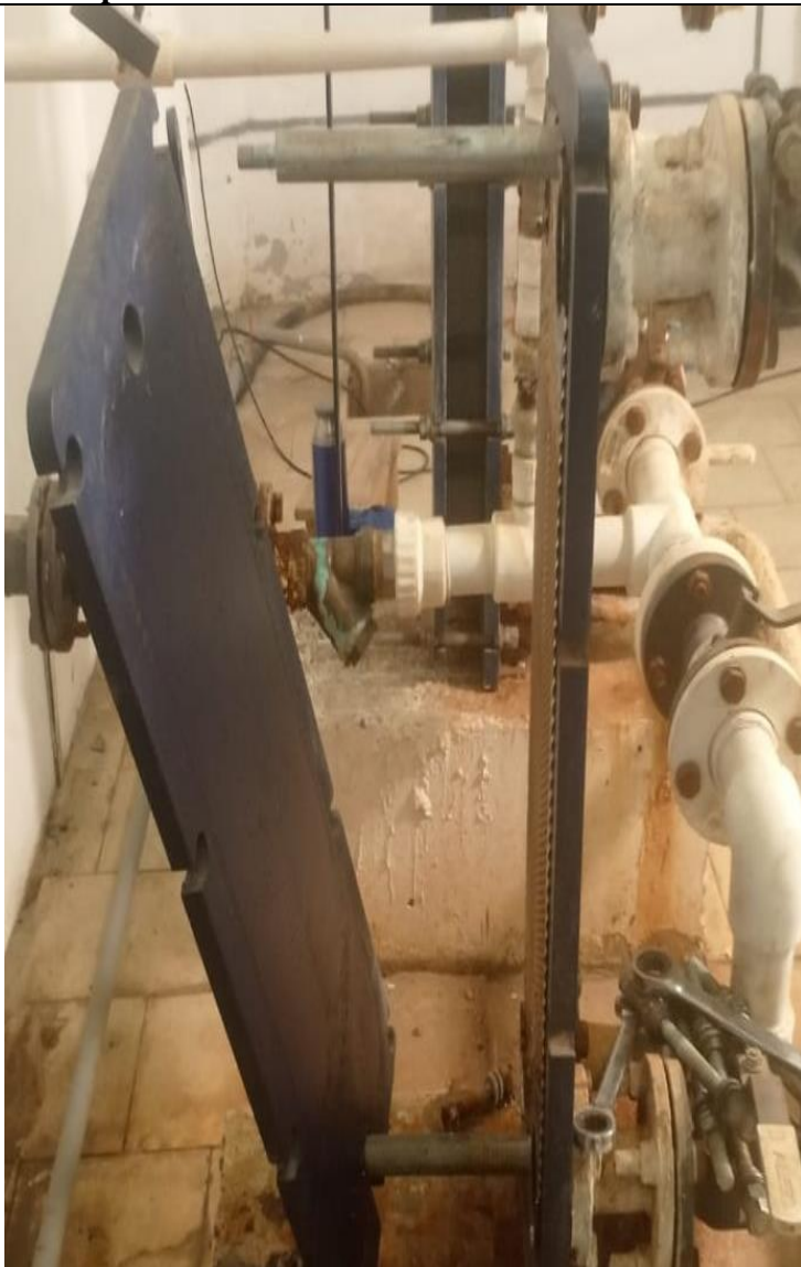
Промывка теплообменника.
