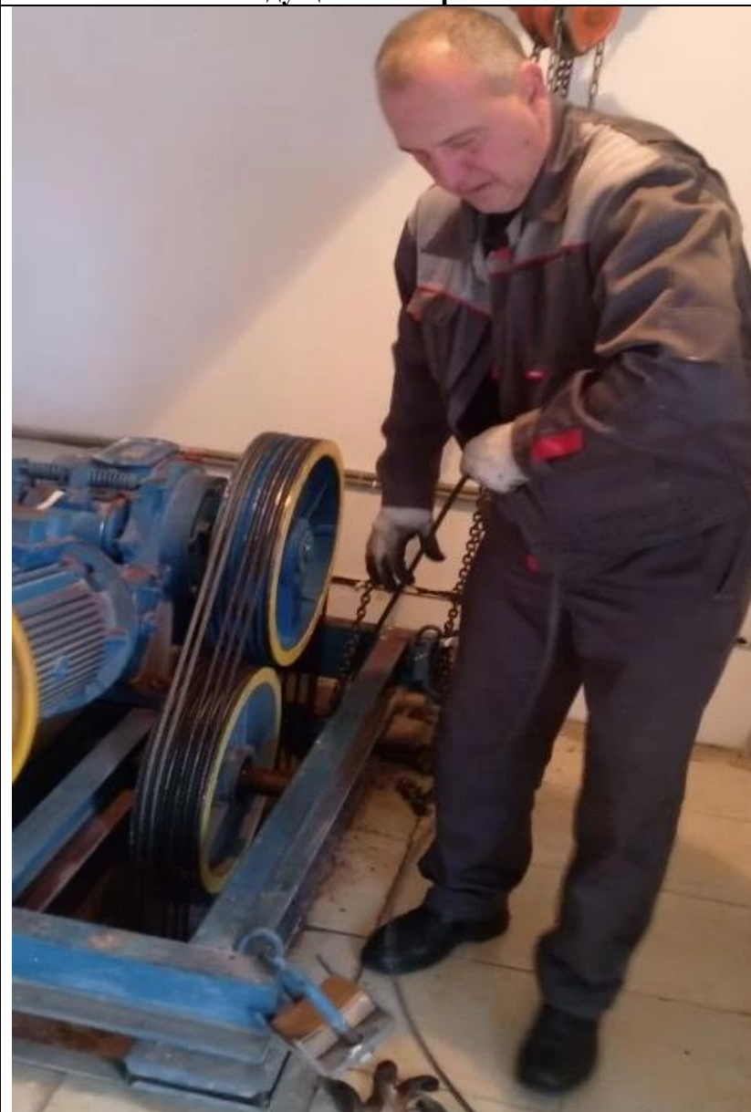
Замена канатоведущего шкифа и тяговые канаты
