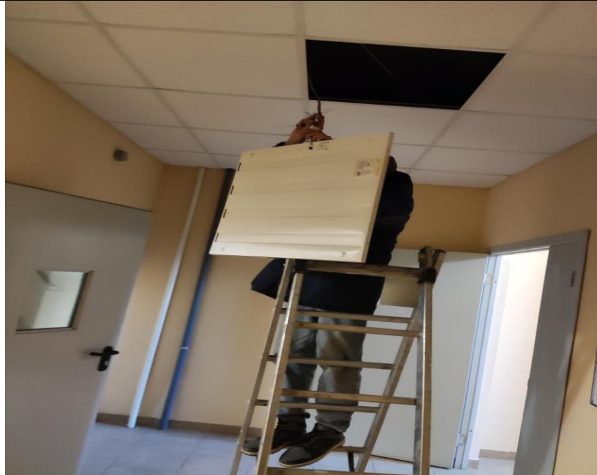
Замена вышедших из строя ламп и светильников основного и аварийного освещения МОП
