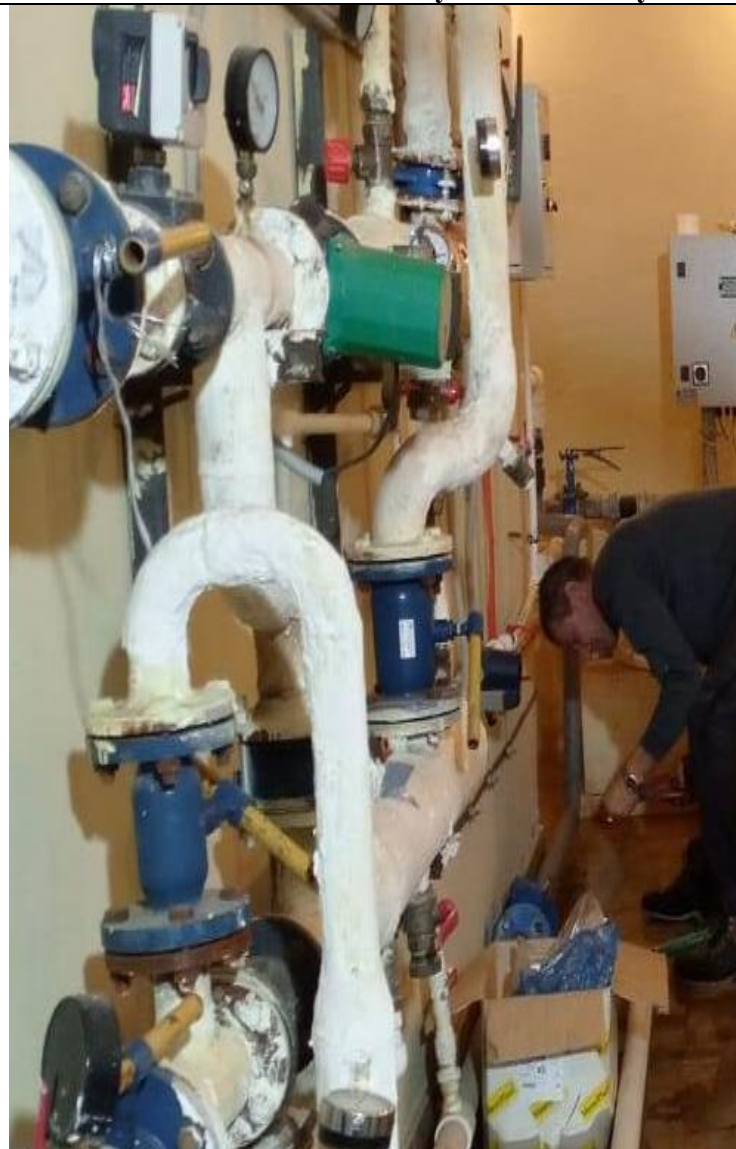
Подготовке теплового пункта к эксплуатации.
