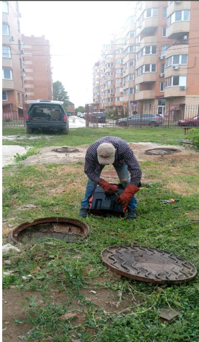
Прочистка магистральных колодцев.
