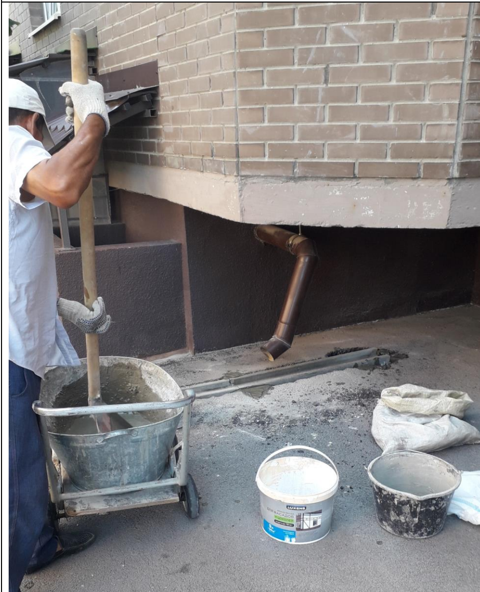
Восстановление ливневой канализации.
