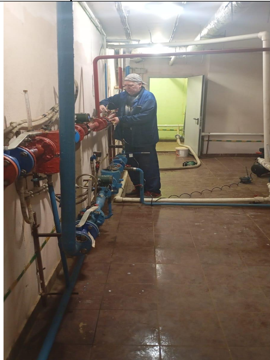
Промывка системы отопления.
