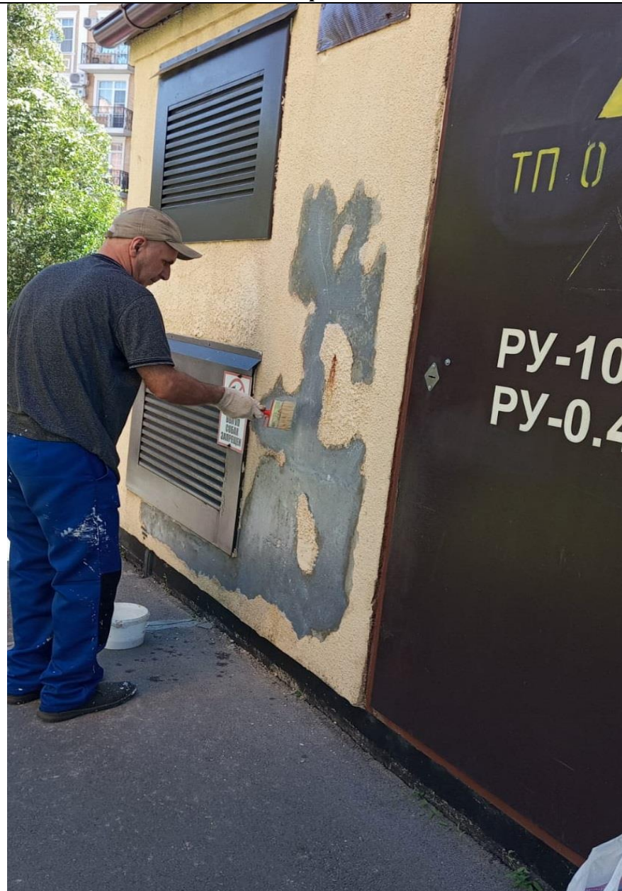
Ремонт фасада ТП
