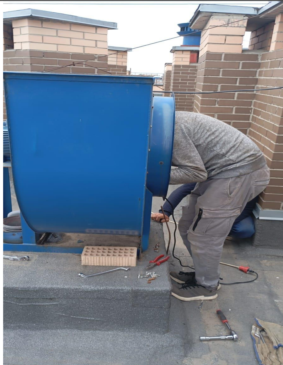
Замена двигателя дымоудаления
