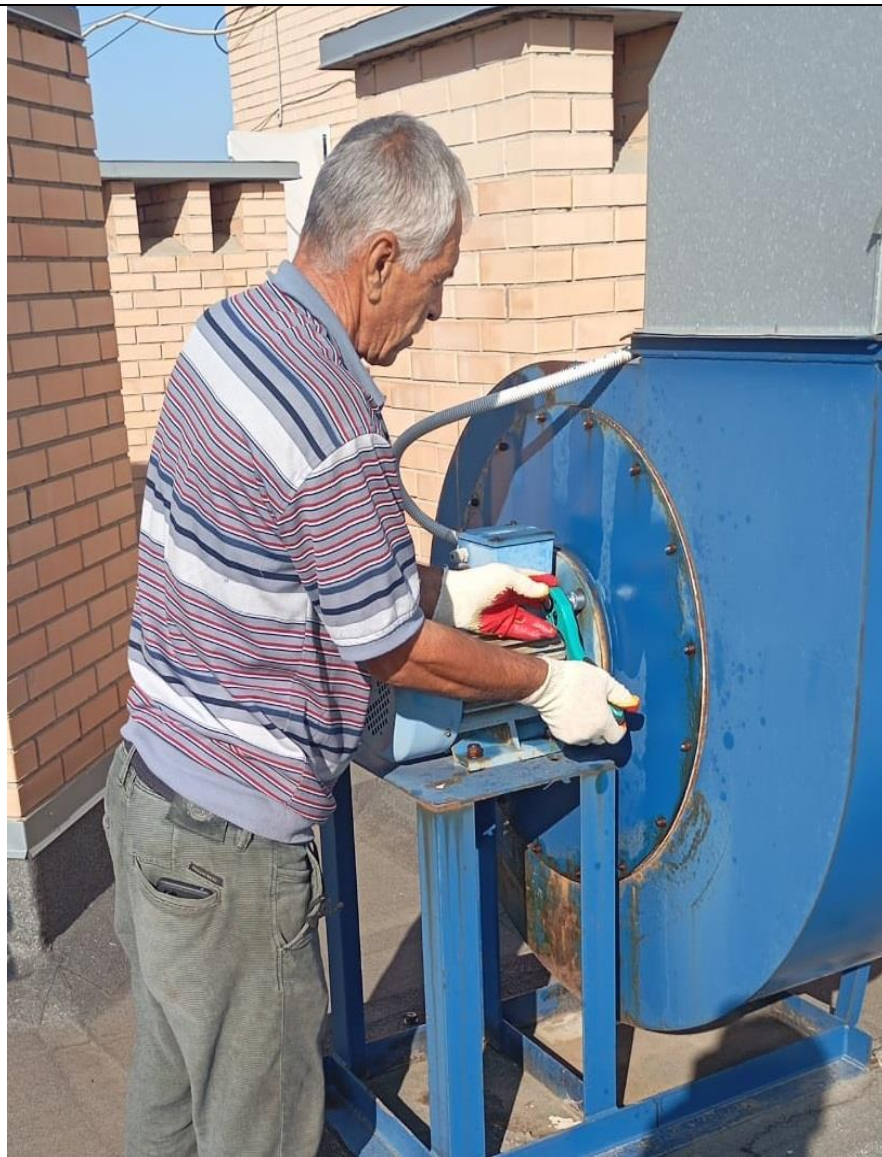
Демонтаж двигателя вентиляции
