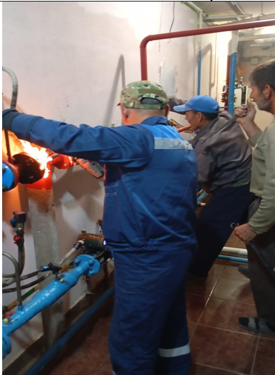
Ремонт подающей тепломагистрали
