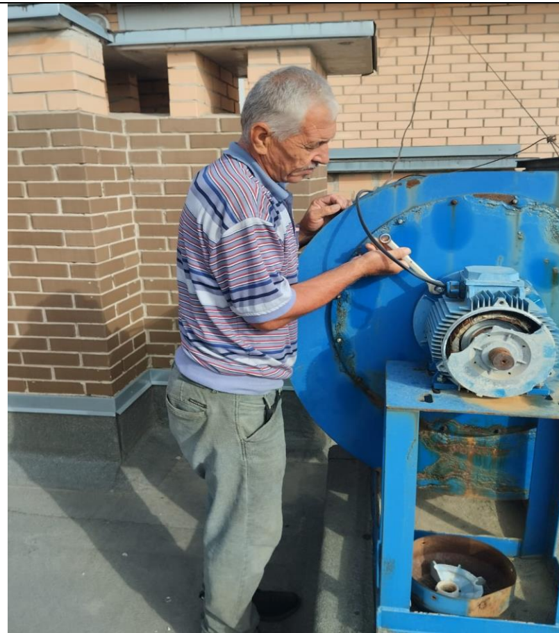
Демонтаж двигателя вентиляции
