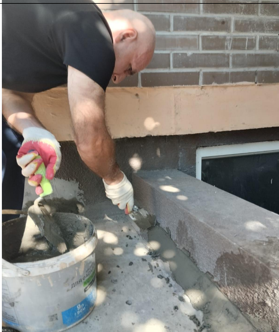
Ремонт цоколя здания
