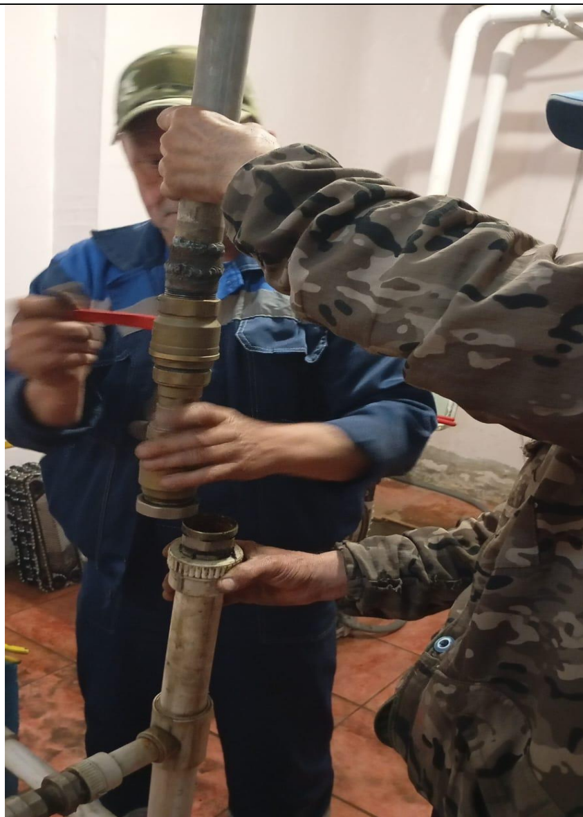
Замена запорной арматуры.
