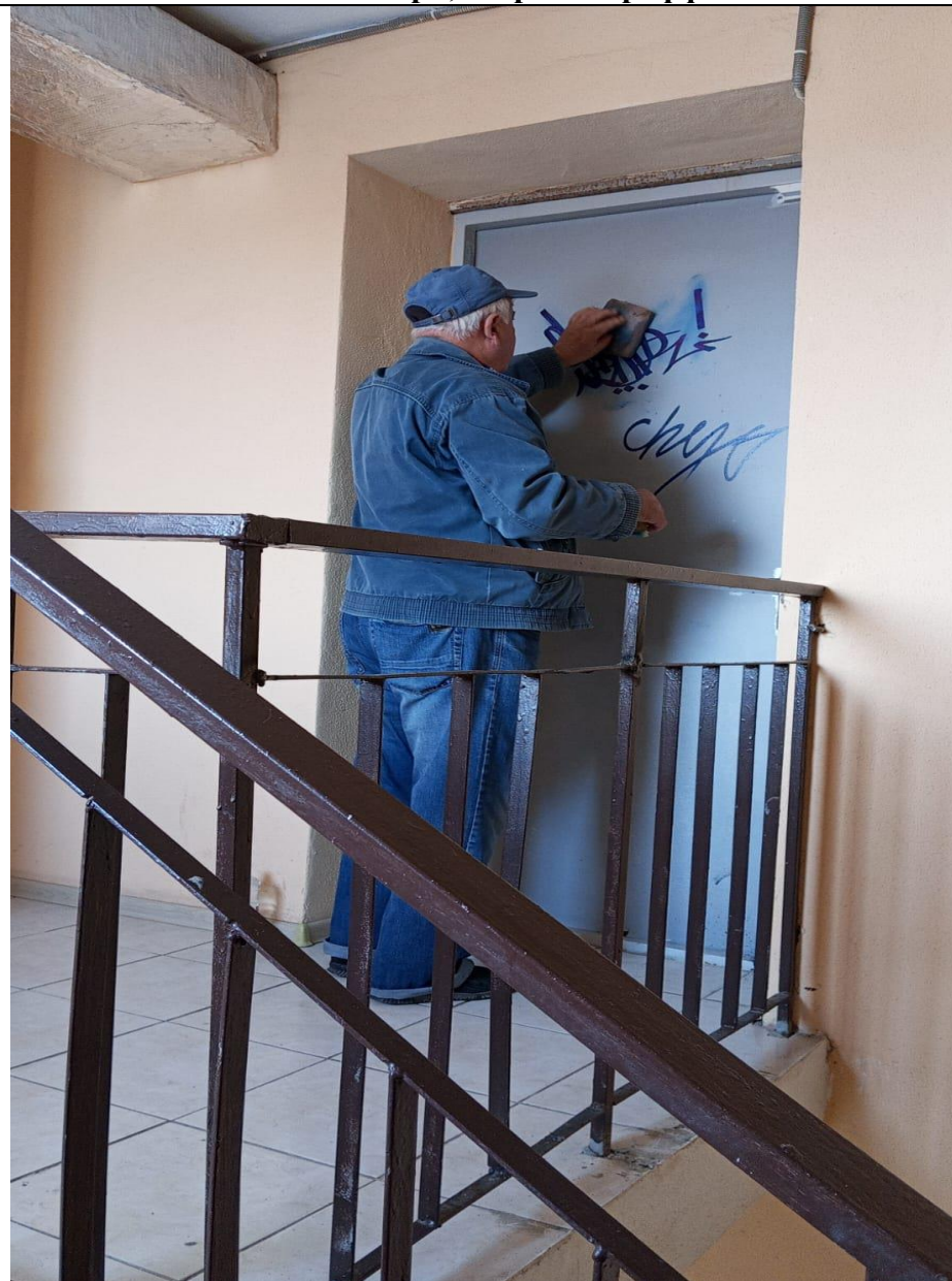
Очистка двери, закразка граффити
