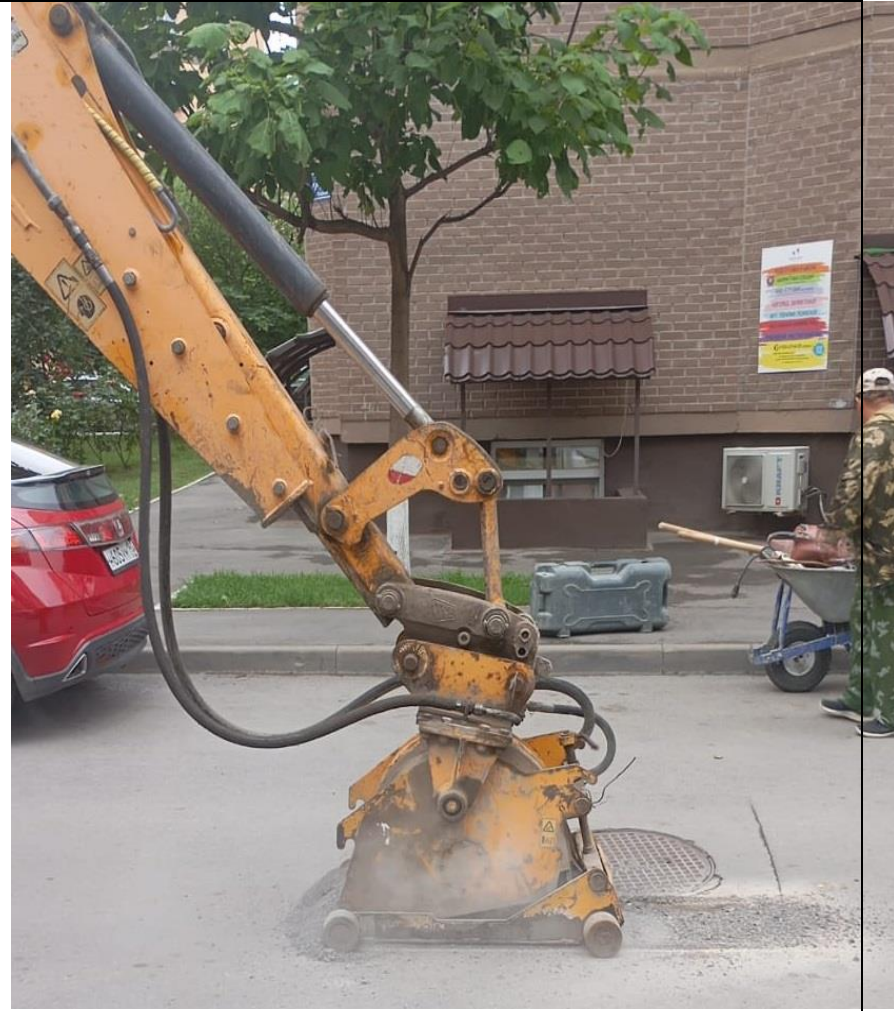
Ремонт канализационных колодцев
