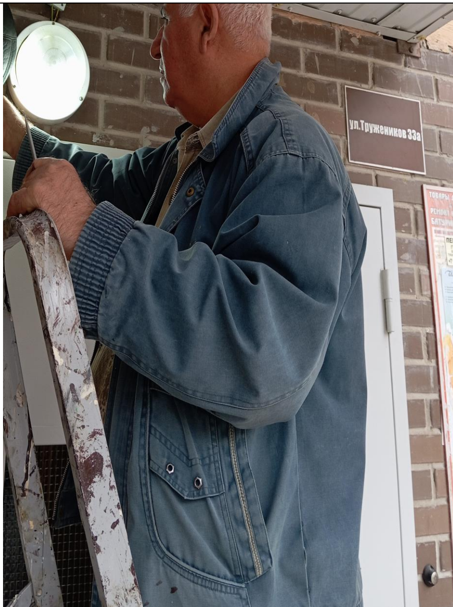
Замена светильников входных групп.
