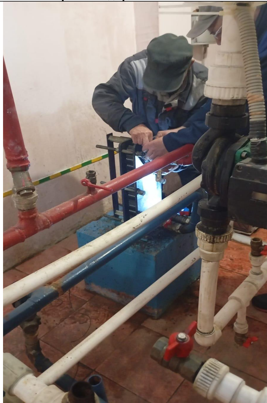
Устранение дефекта теплообменника
