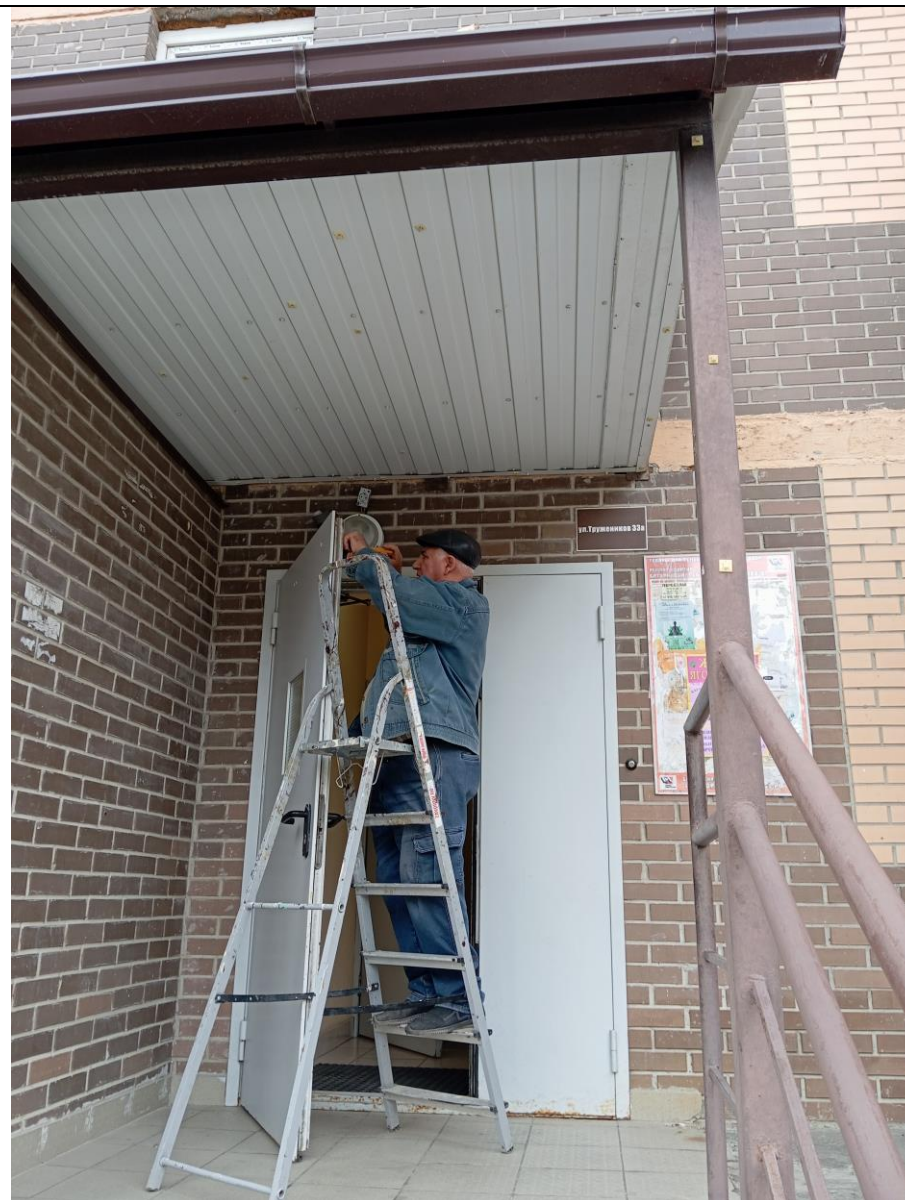
Ремонт (замена) ламп освещения
