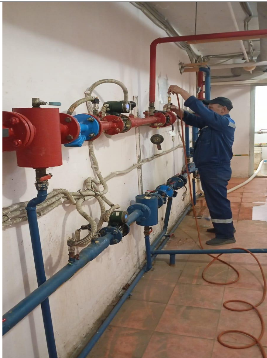
Промывка системы отопления
