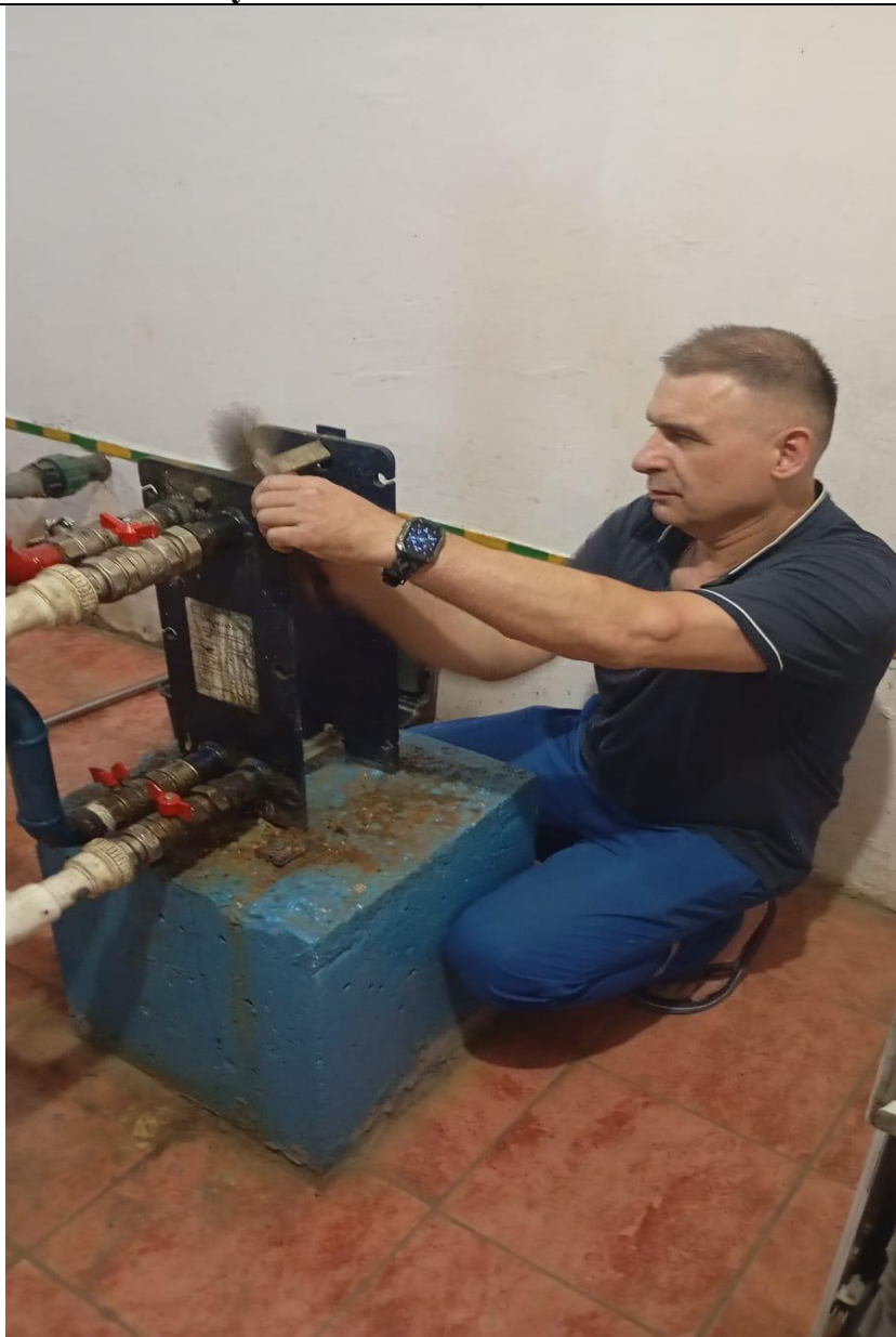
Обслуживание теплообменника
