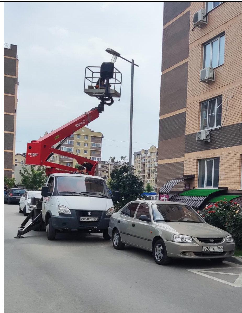
Замена ламп и пускателей в кобрах уличного освещения.
