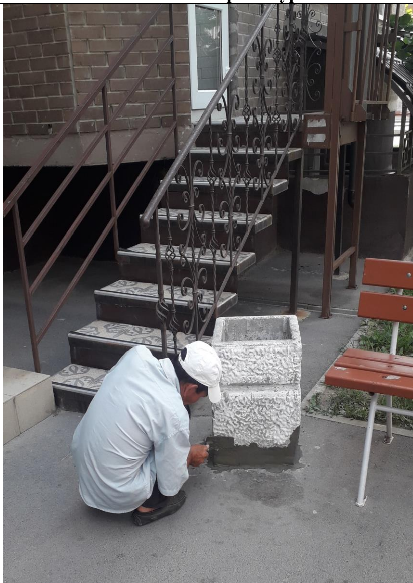
Ремонт и покраска урн.
