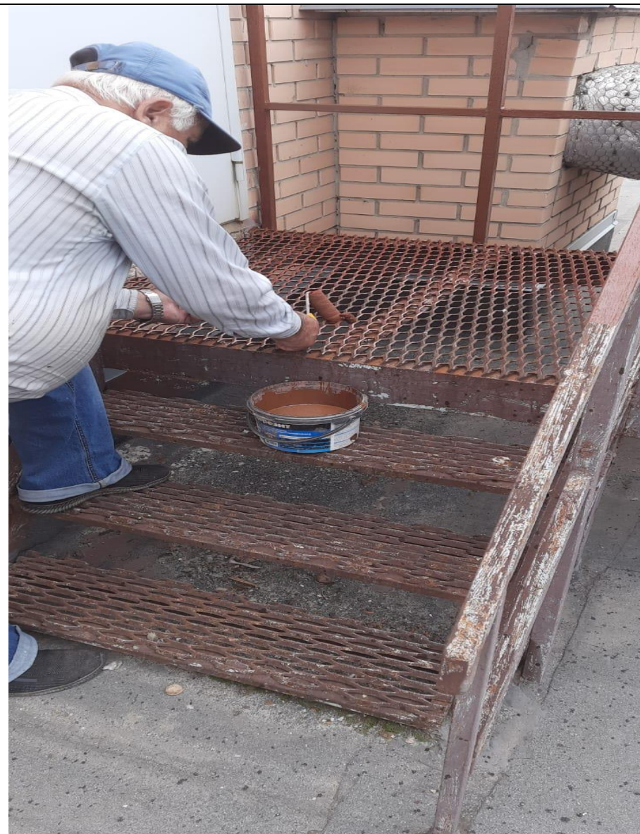
Покраска лестничной площадки на крыше
