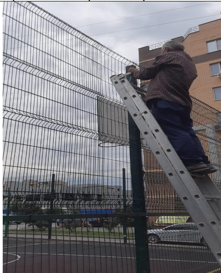
Крепление защитного ограждения на спортивной площадке.
