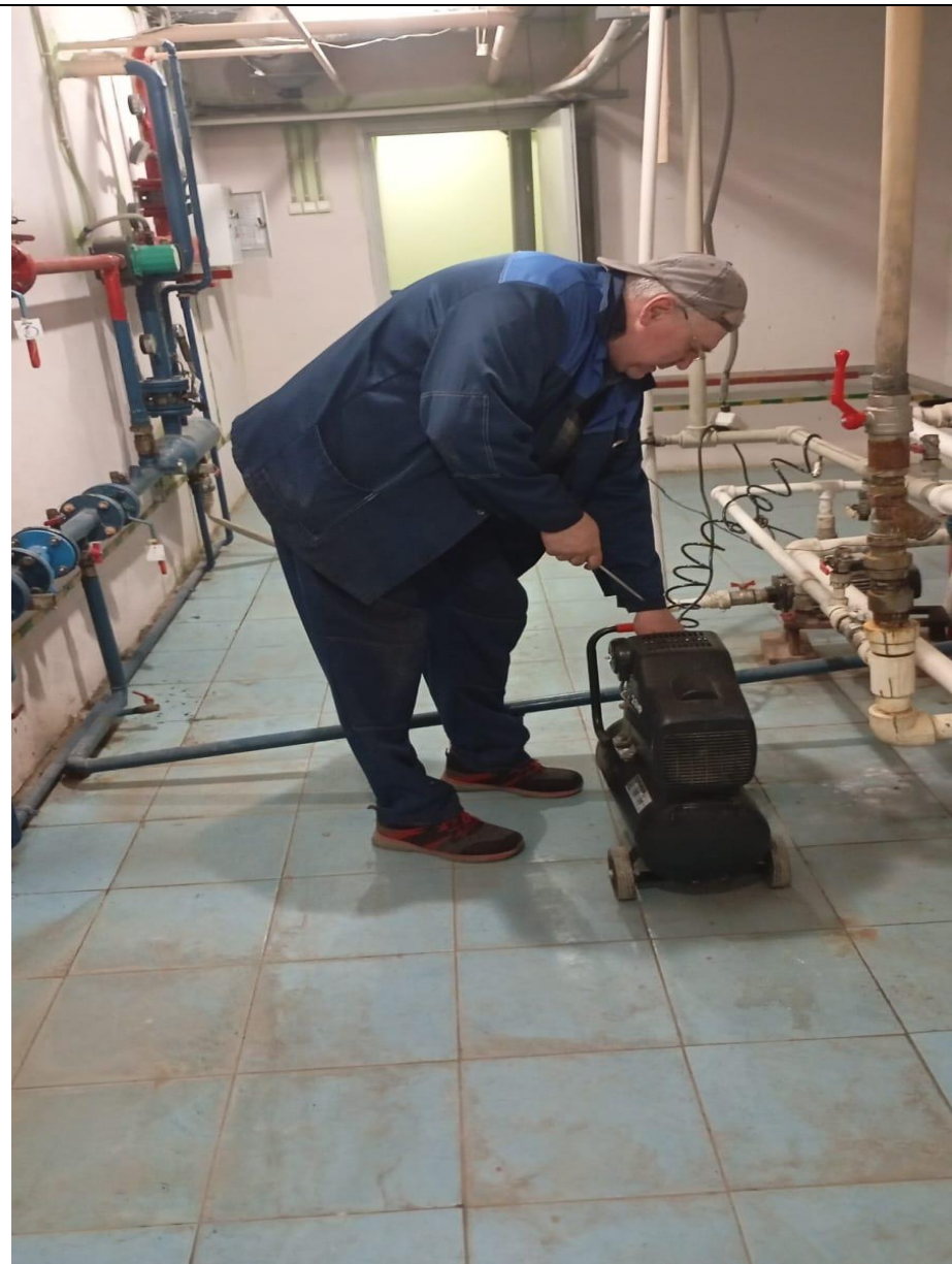
Промывка системы отопления.
