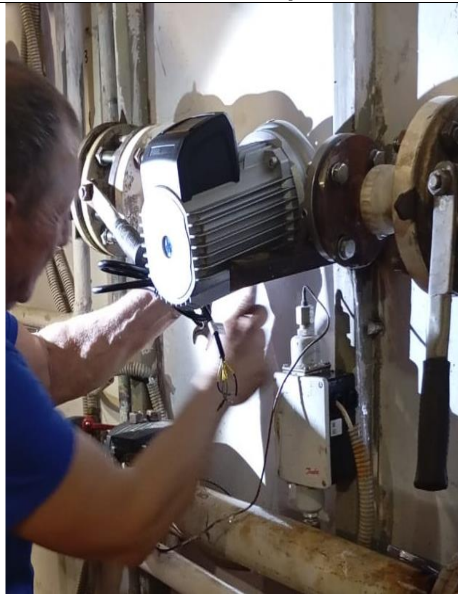
Ремонт насоса на подаче горячей воды.
