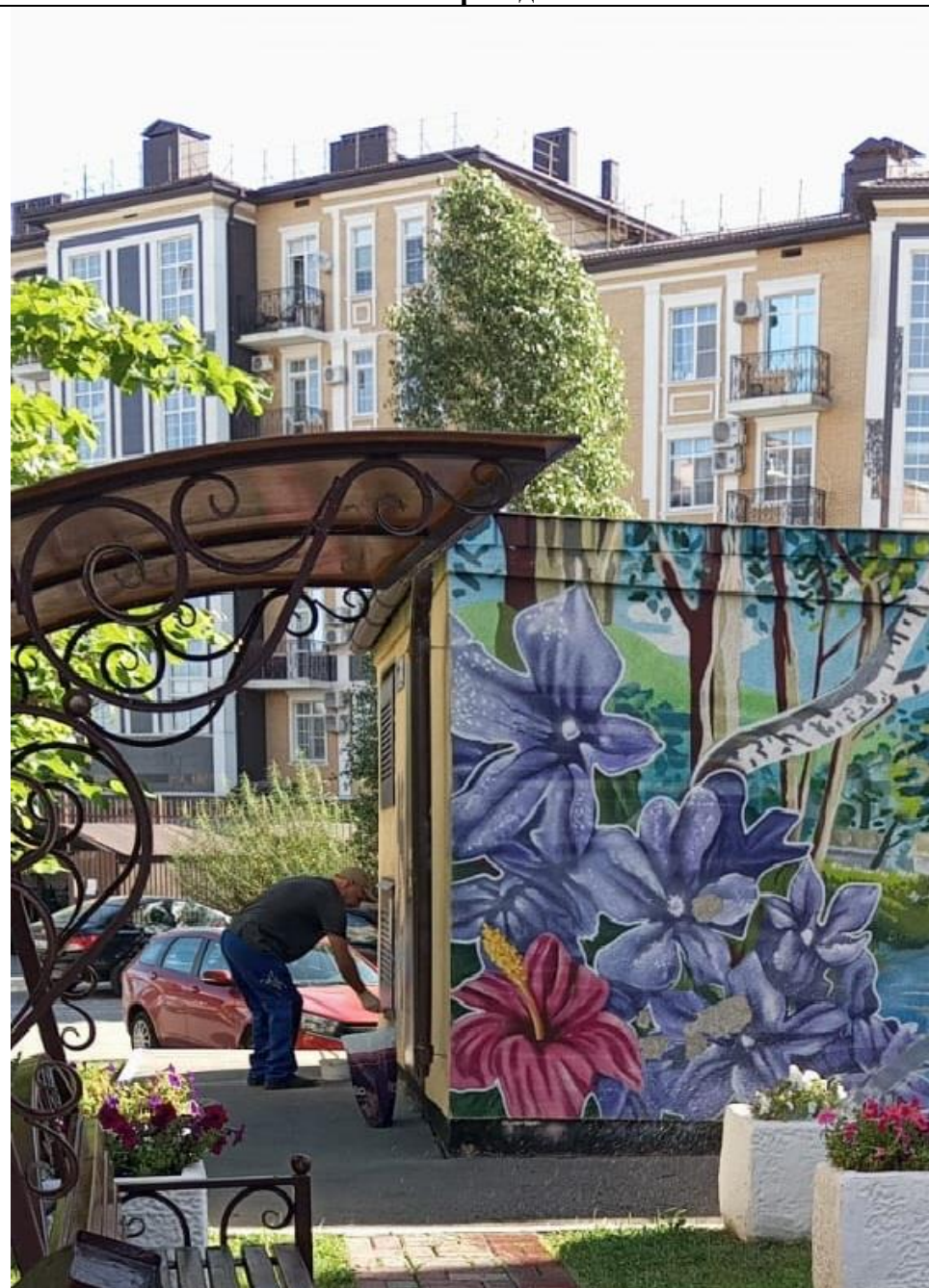
Ремонт фасада ТП
