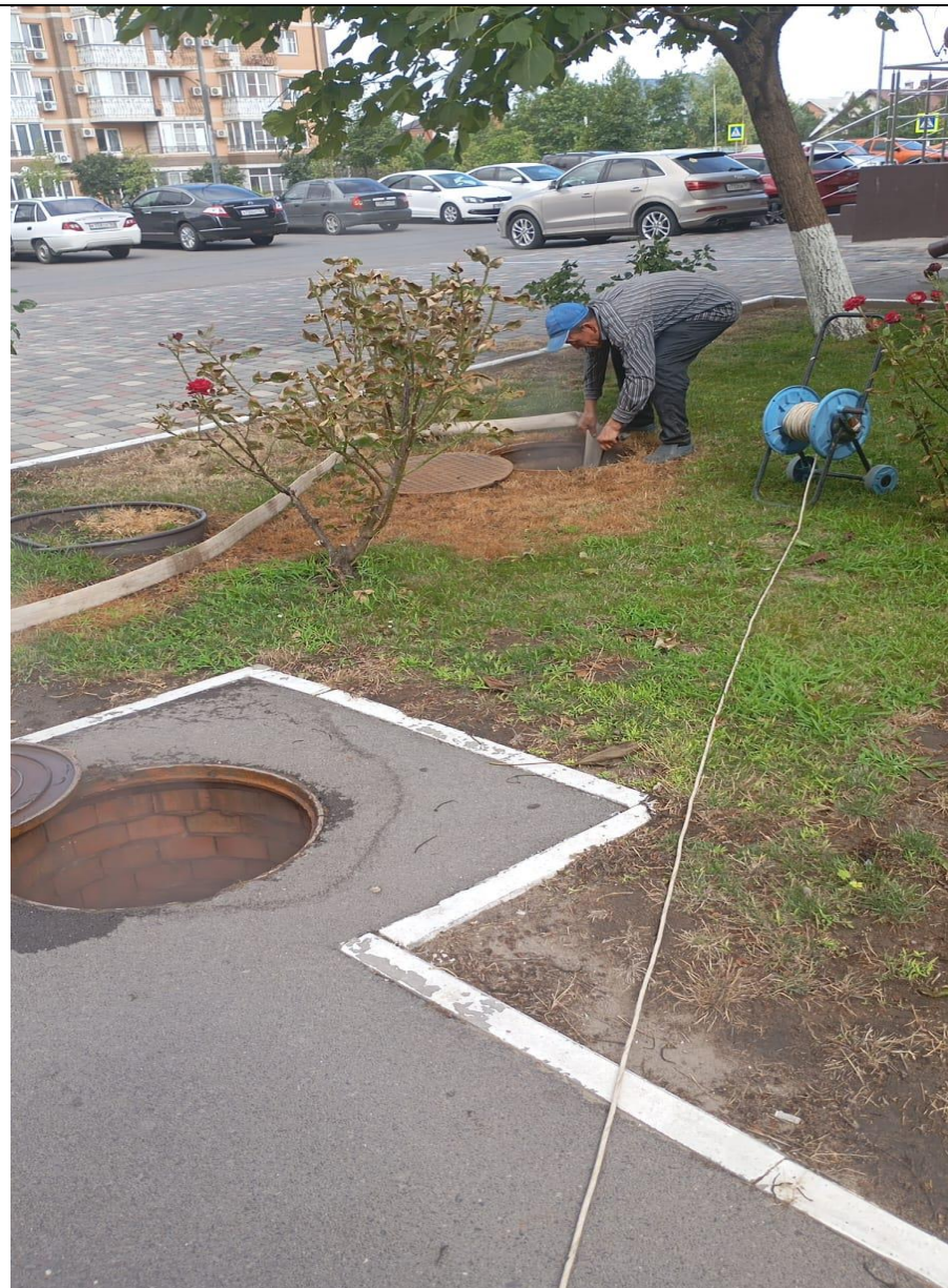
Откачка воды из колодца для ремонта на тепломагистрали
