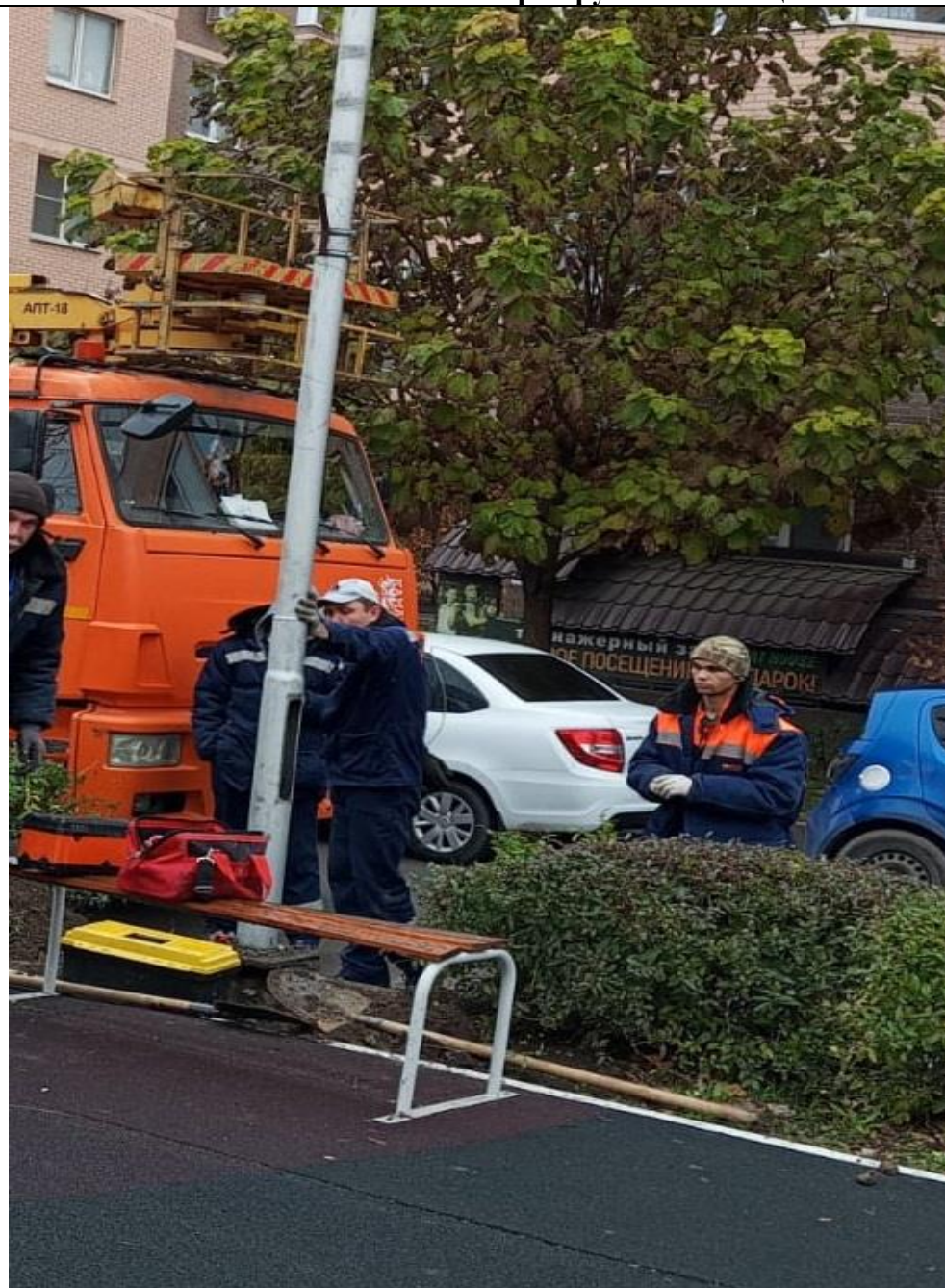
Ремонт кабельной линии опор наружного освещения
