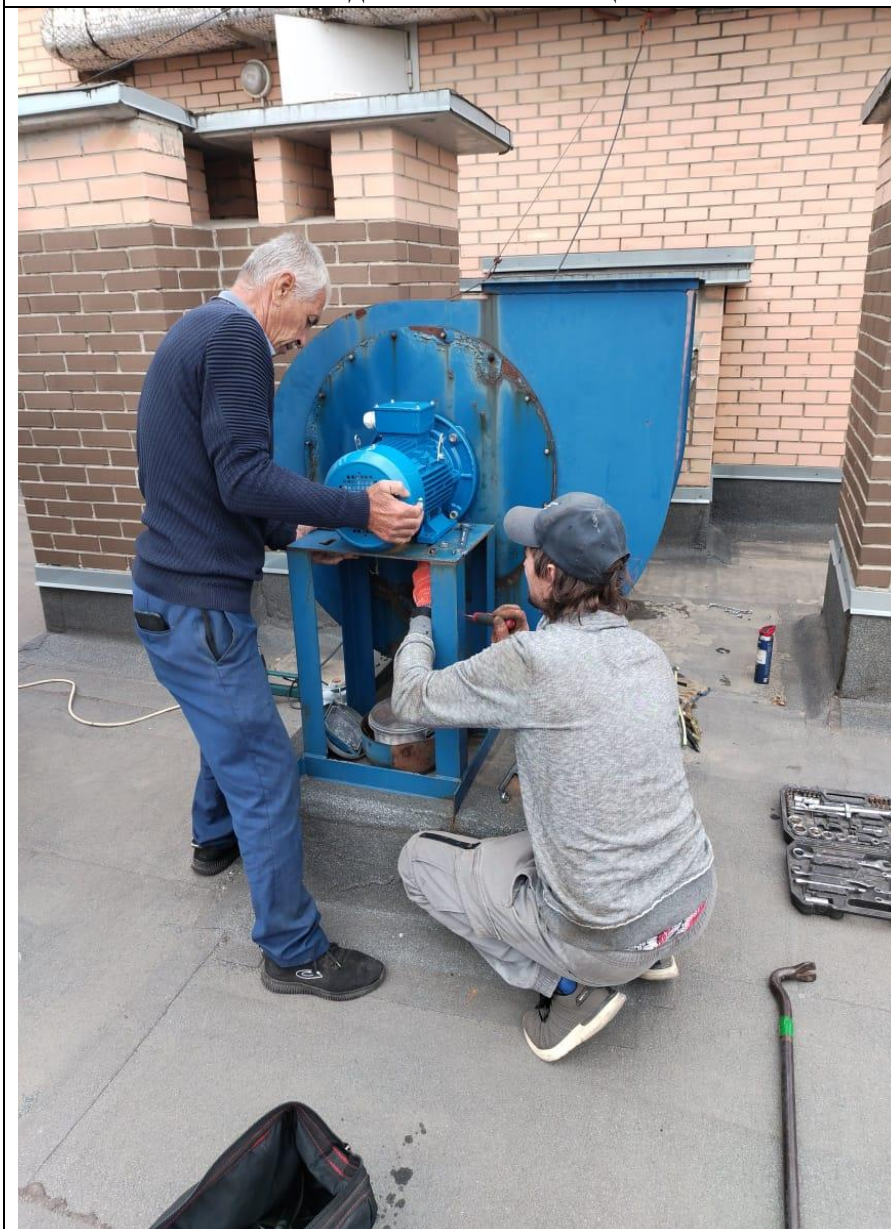
Замена двигателя вентиляции
