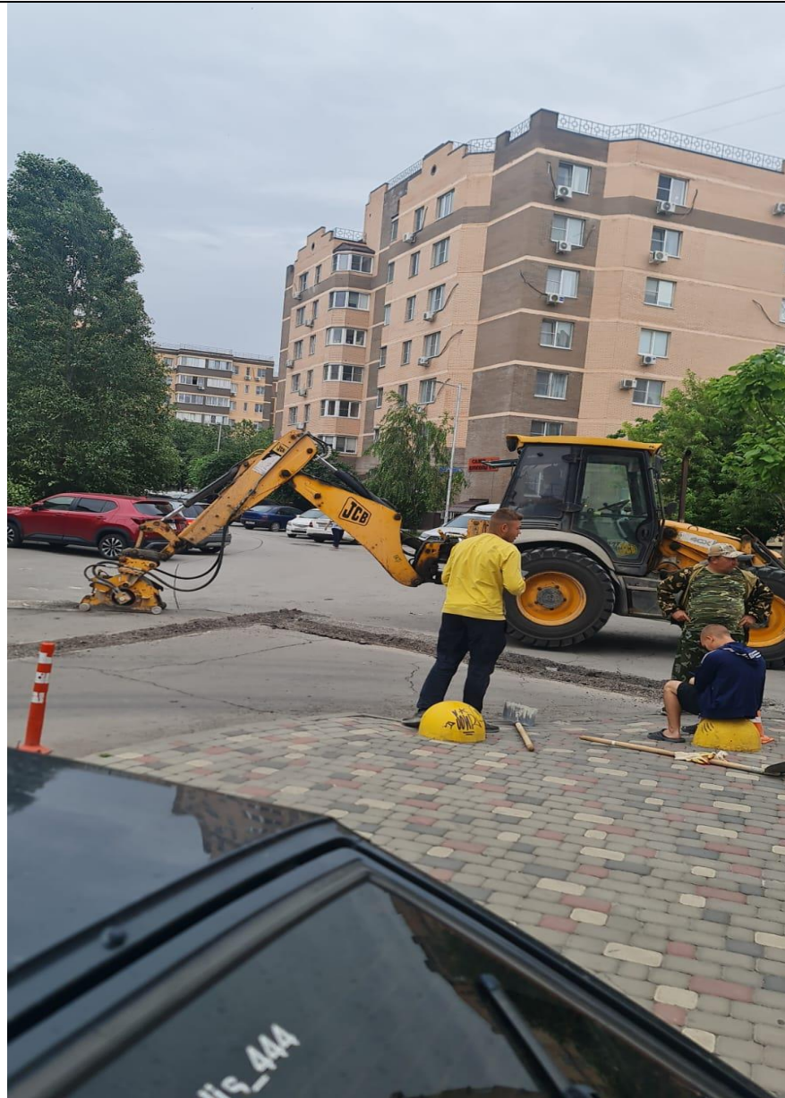
Ремонт канализационных люков
