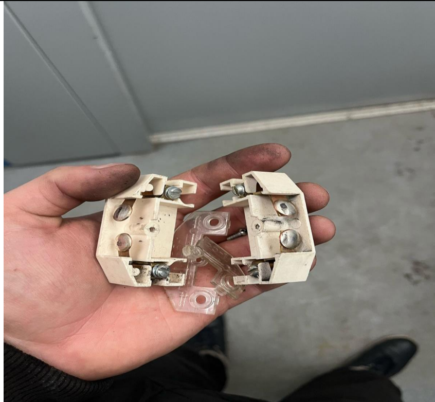
Замена контакта ДК
