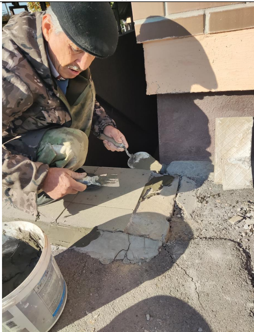
Замена напольной плитки на входных группах и ступеней в подвал.
