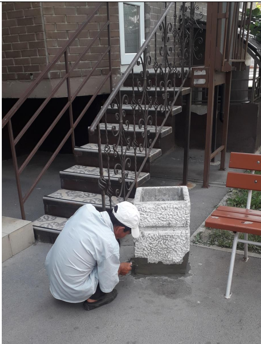
Ремонт и покраска урн.
