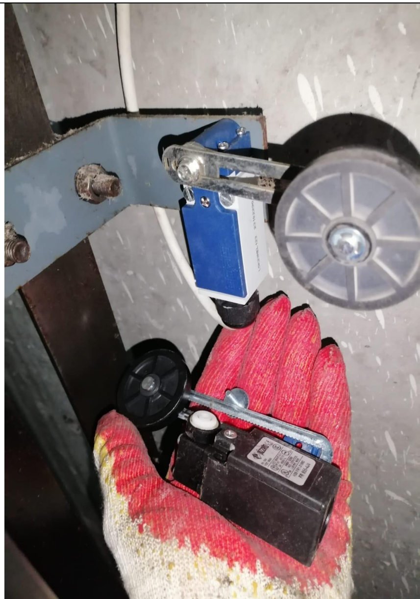
Замена концевого выключателя
