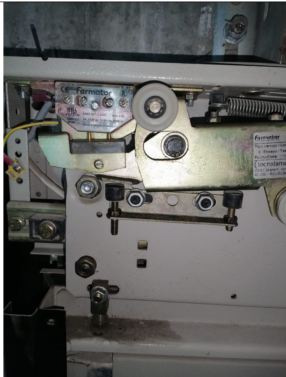
Регулировка замка ДШ
