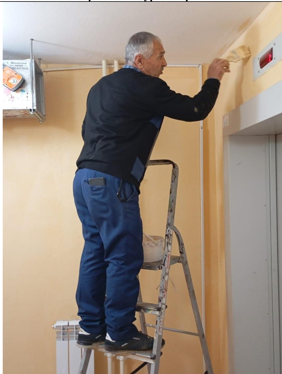
Покраска тамбуров лифтовых
