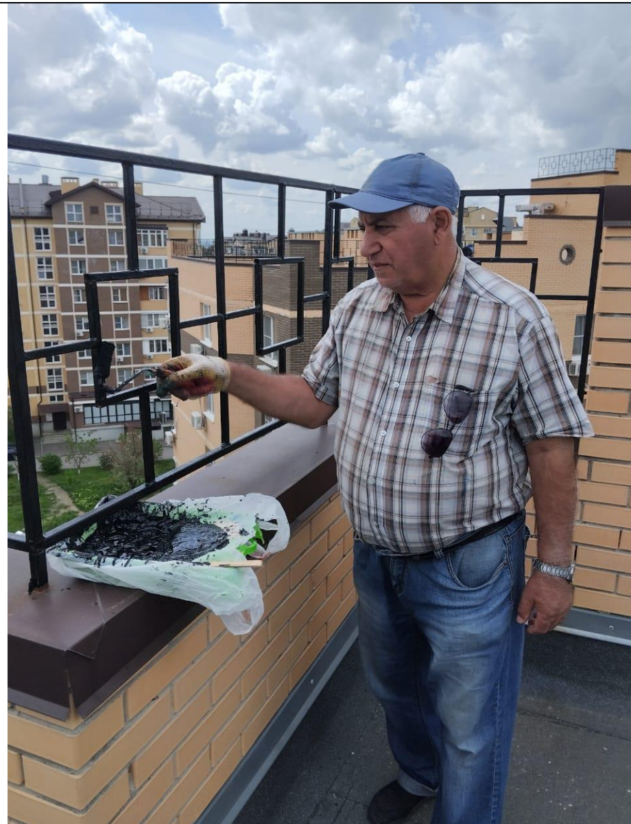
Покраска ограждений крыши
