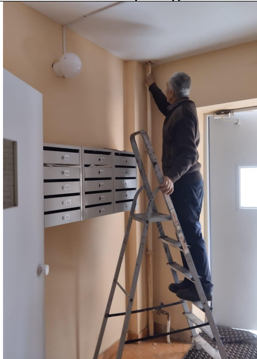
Ремонт и покраска трубы.
