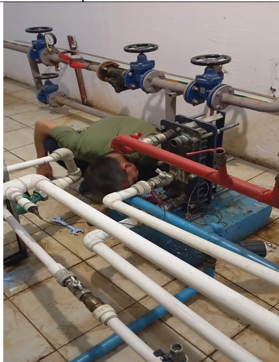
Сборка теплообменника
