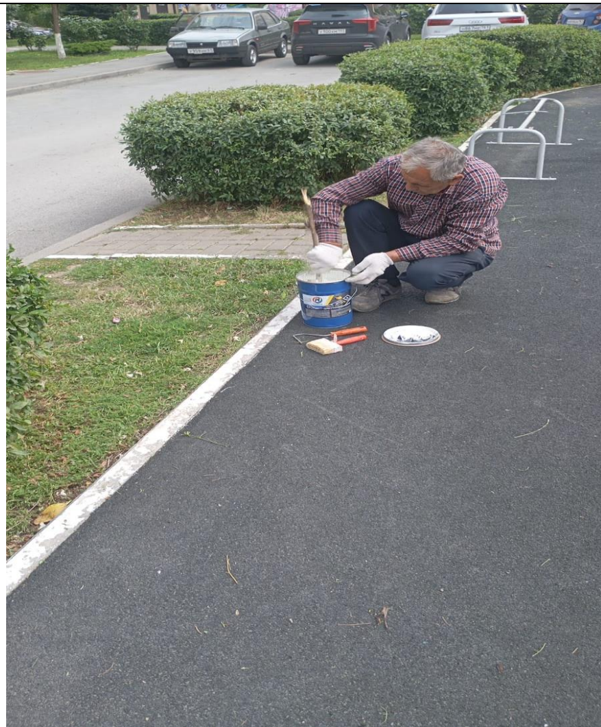
Покраска бордюров на прилегающей детской площадке
