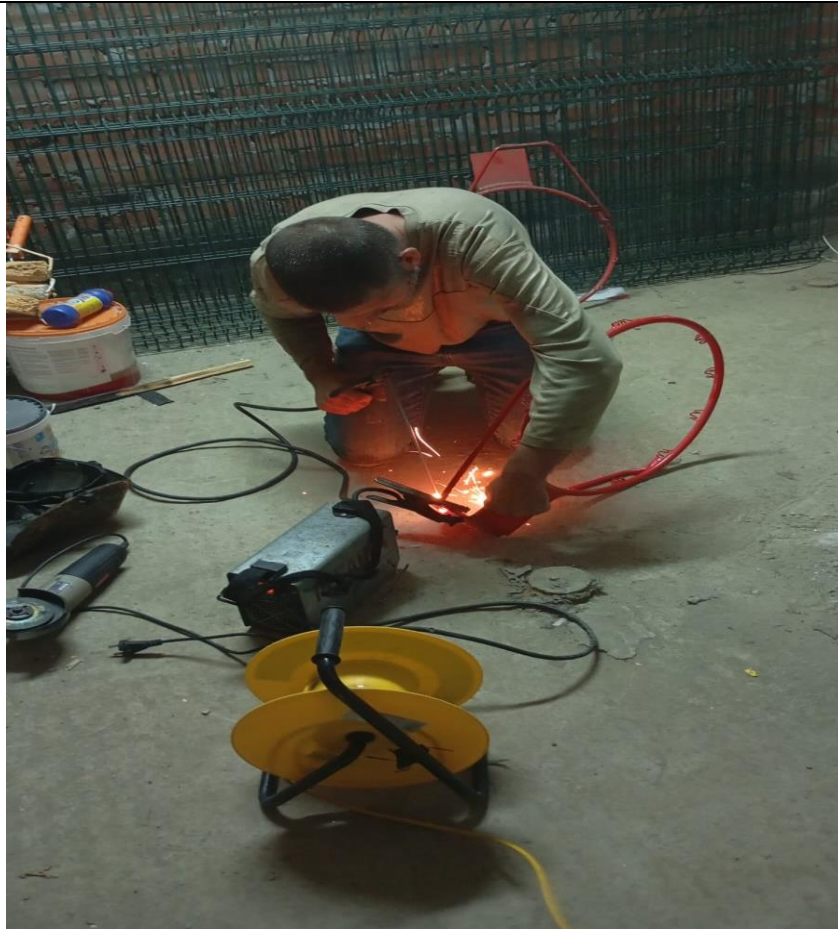
Ремонт баскетбольных колец
