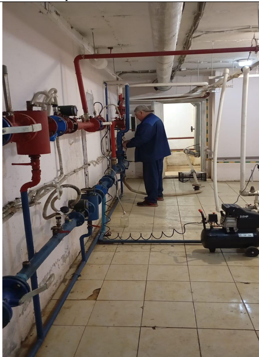
Промывка системы отопления.
