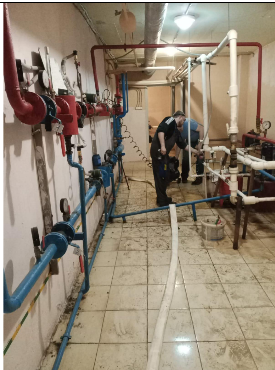
Промывка системы отопления.
