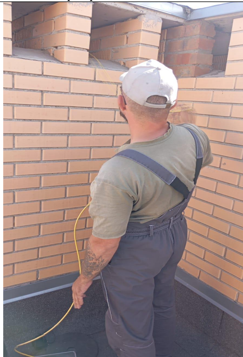
Проверка шахты вентиляции
