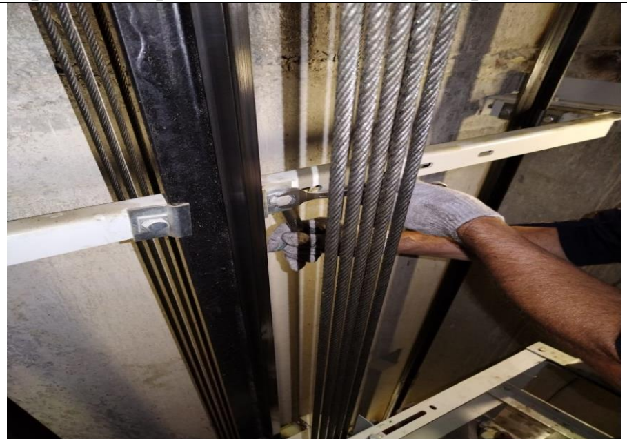
Проведение работ по выставлению направляющих.
