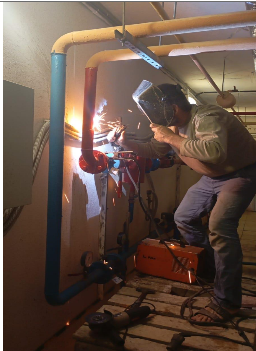
Вваривание резьбы на тепловую магистраль
