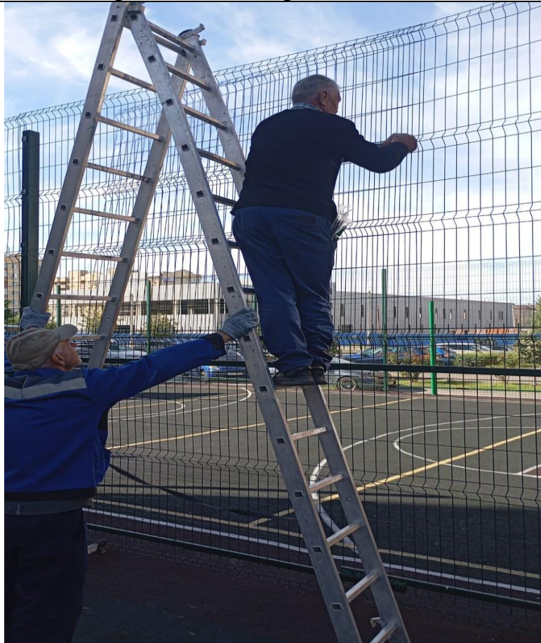
Ремонт ограждения спортивной площадки
