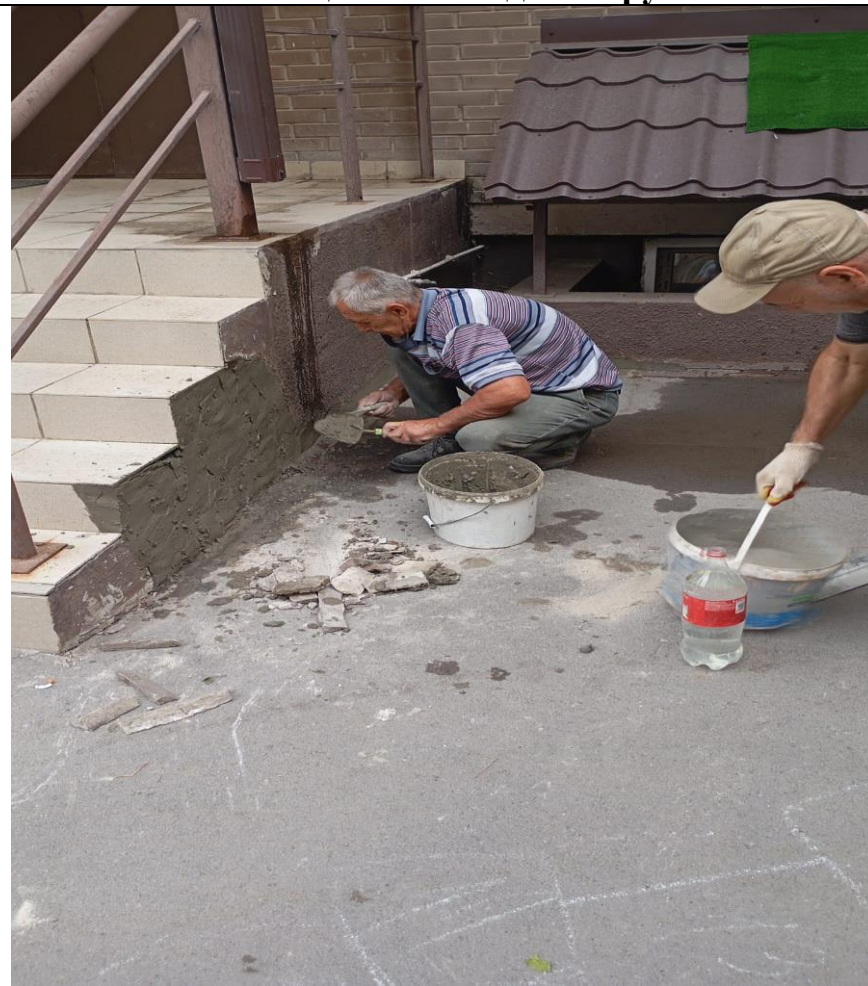
Ремонт цоколя входных групп.
