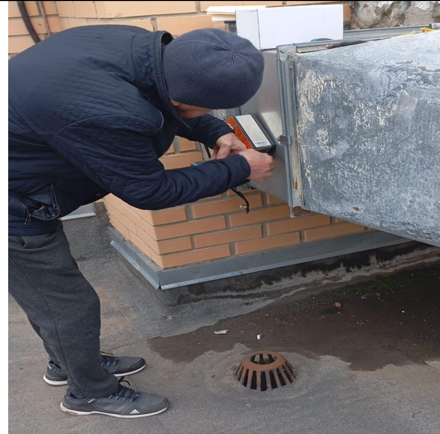
Замена приводов системы ДУ
