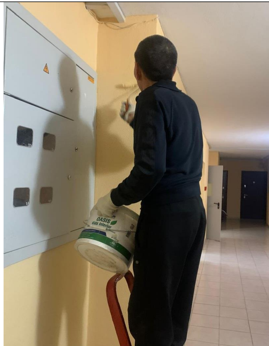
Покраска стен МОП
