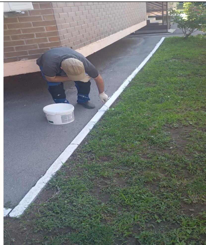
Покраска дорожных бордюров
