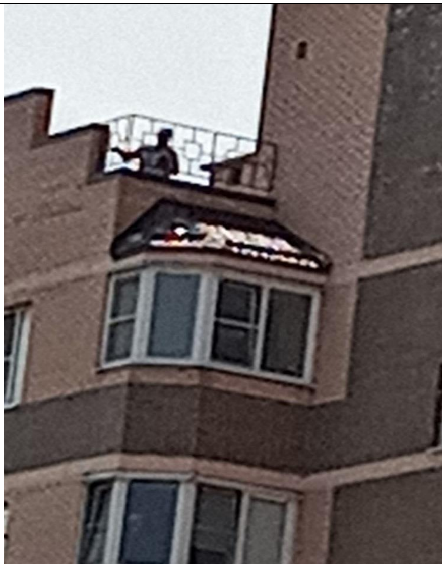
Покраска ограждений на крыше
