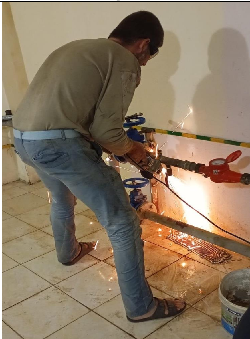
Ремонт магистрали холодной воды
