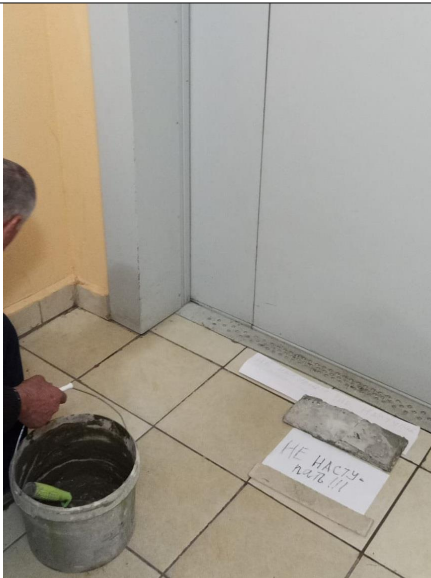
Ремонт напольной плитки
