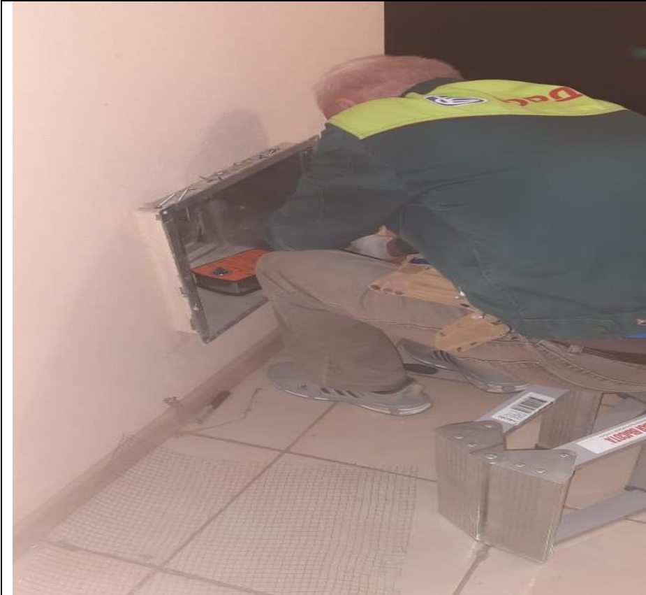
Замена приводов на клапанах ДУ
