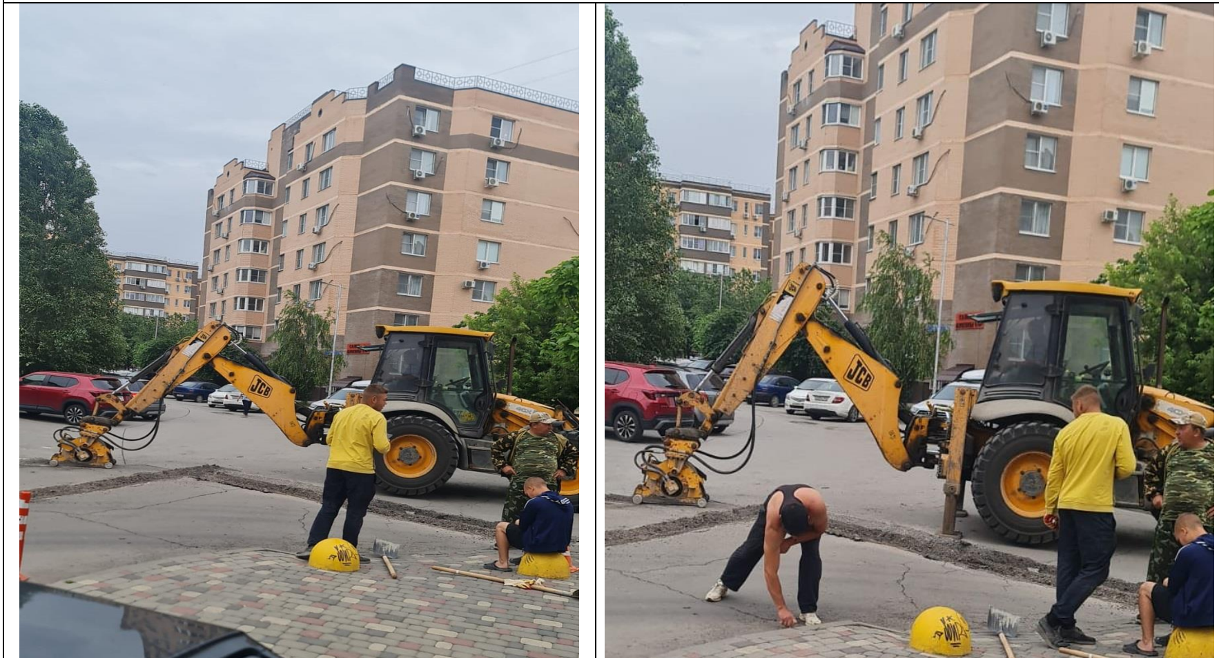
Ремонт канализационных люков.
