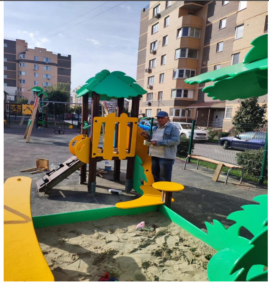
Ремонт детской площадки
