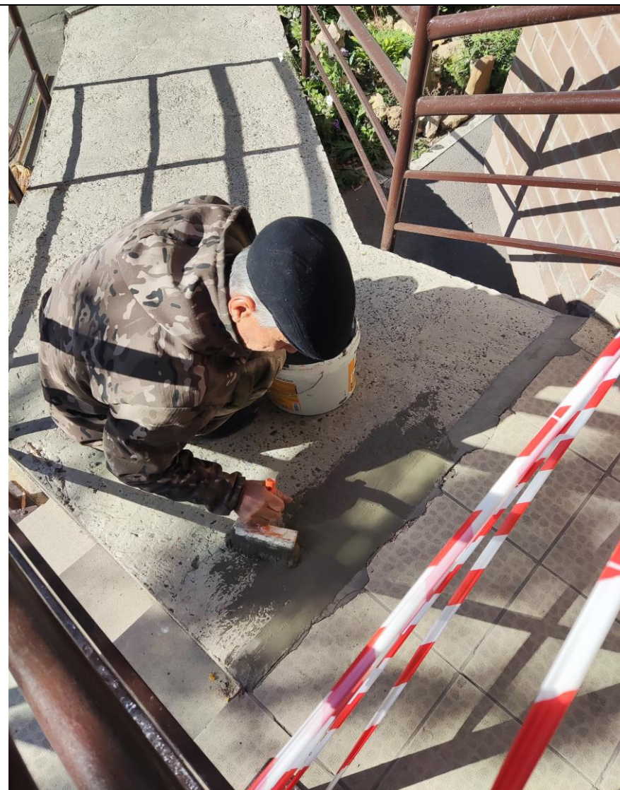
Обработка пандусов гидроизоляцией, покраска металлических частей.
