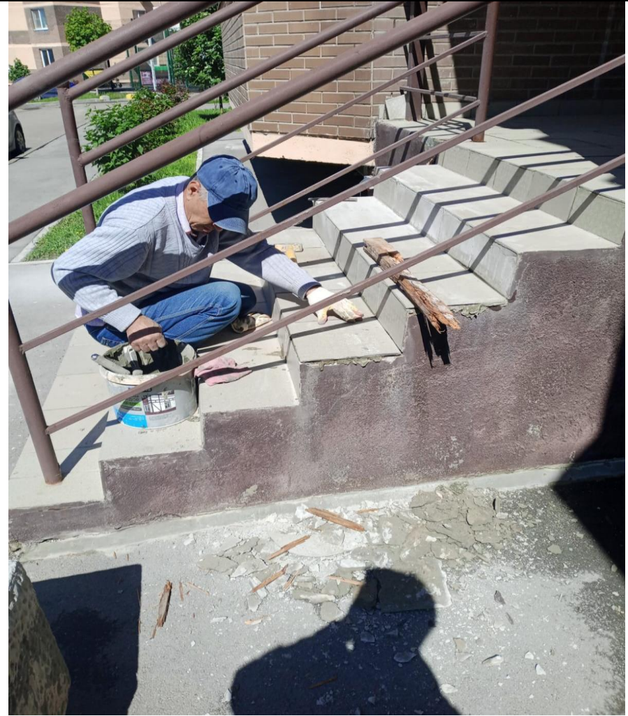
Замена плитки входных групп.
