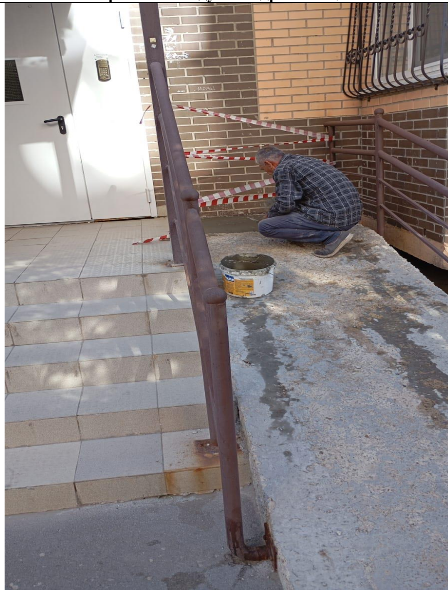
Обработка пандусов гидроизоляцией
