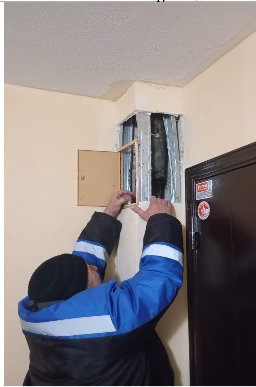
Ремонт ливнёвки в конструкции здания
