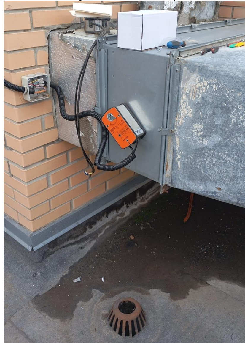
Замена приводов системы дымоудаления.
