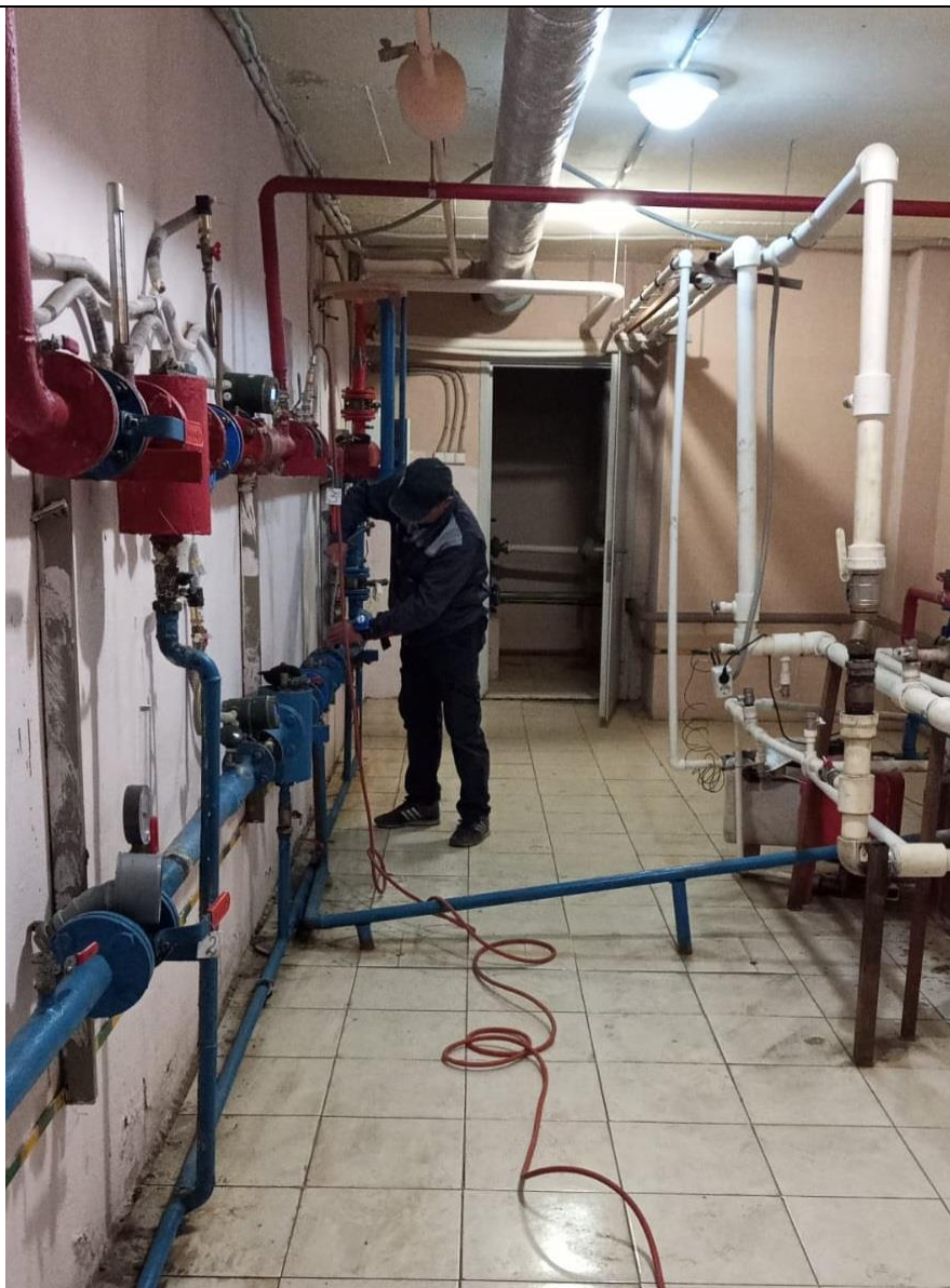
Промывка системы отопления.
