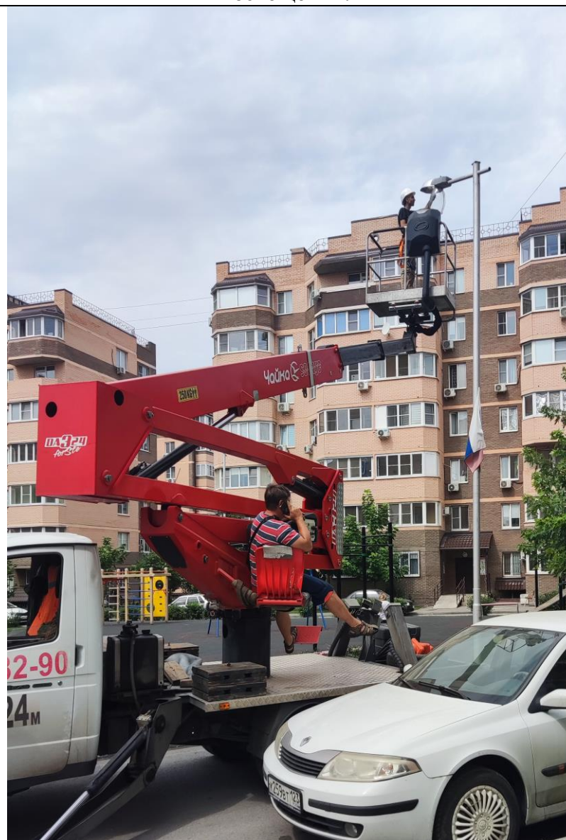
Замена ламп и пускателей в кобрах уличного освещения.
