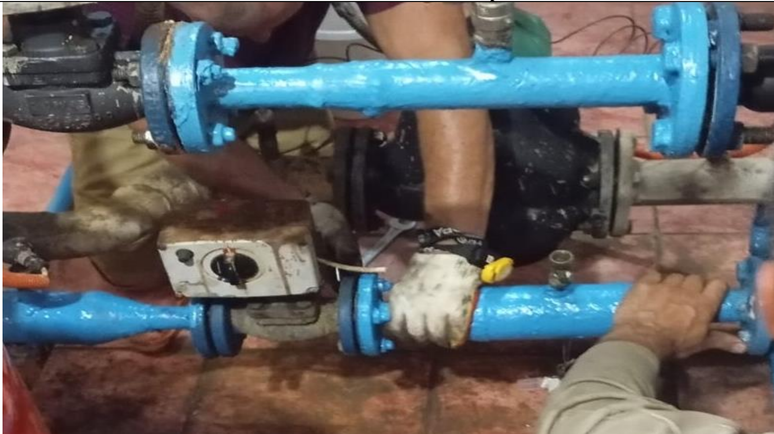
Монтаж насоса на тепло магистрали.
