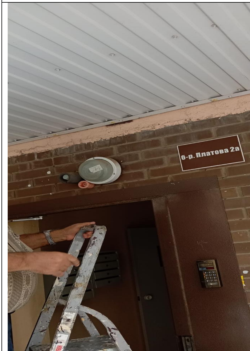
Замена ламп на входных группах
