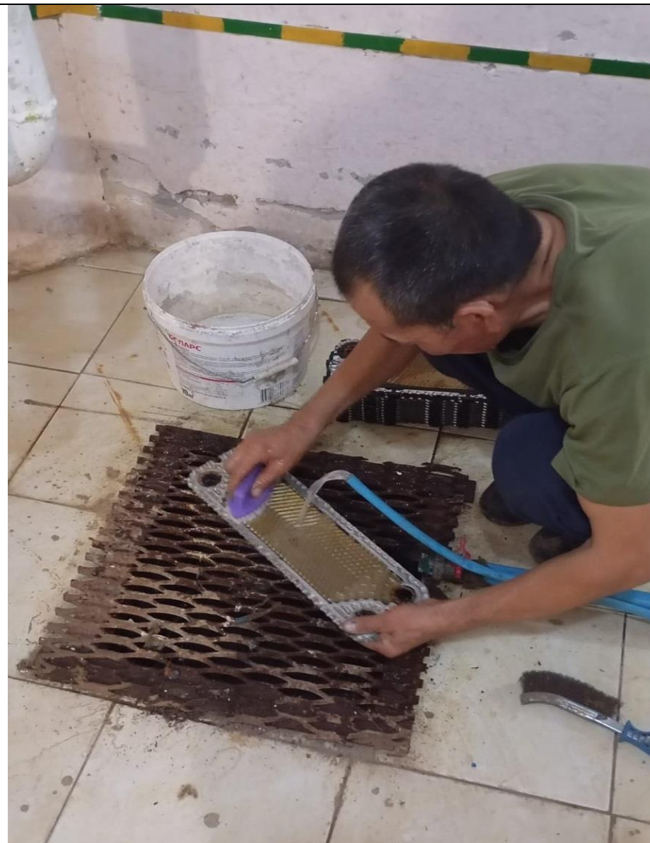
Мытье пластин теплообменника
