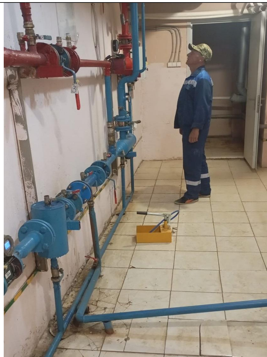
Гидравлические испытания.
