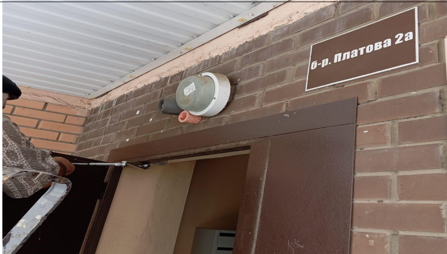
Регулировка доводчика входной двери
