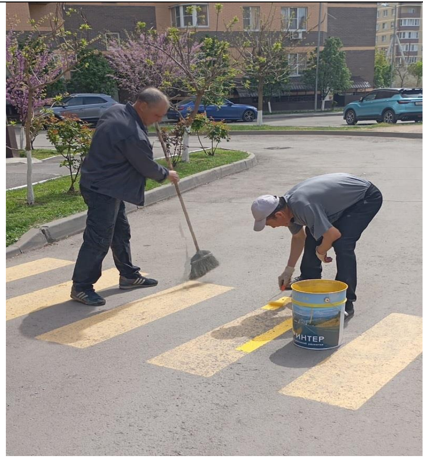
Восстановление пешеходного перехода
