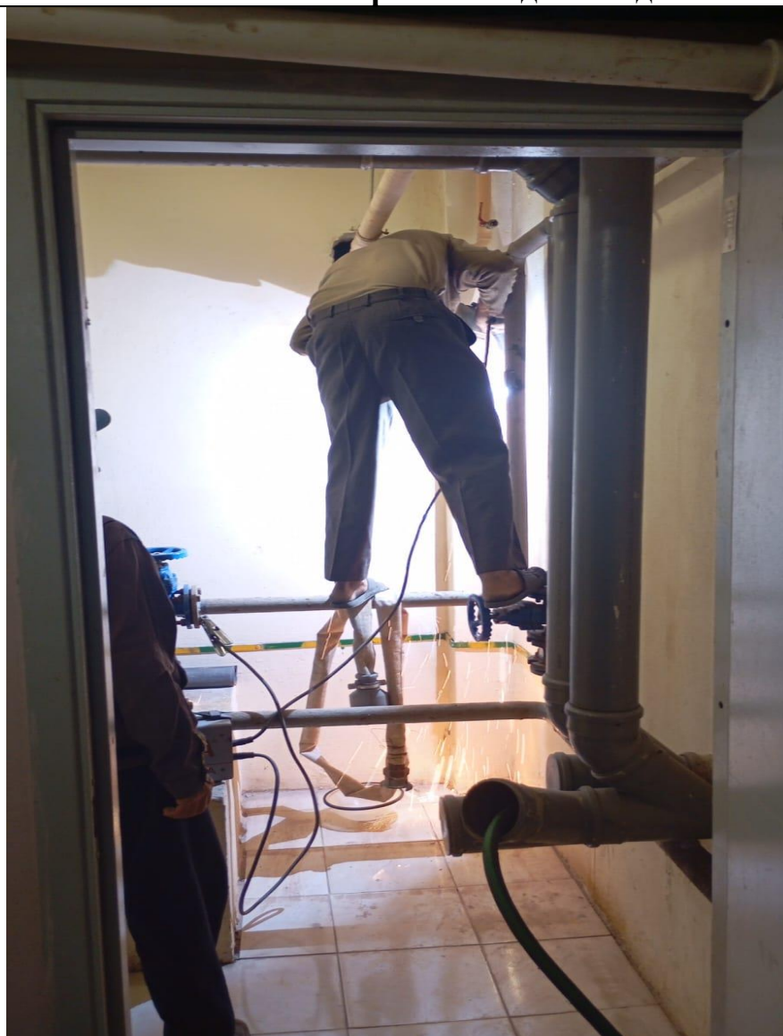
Ремонт магистрали холодной воды.
