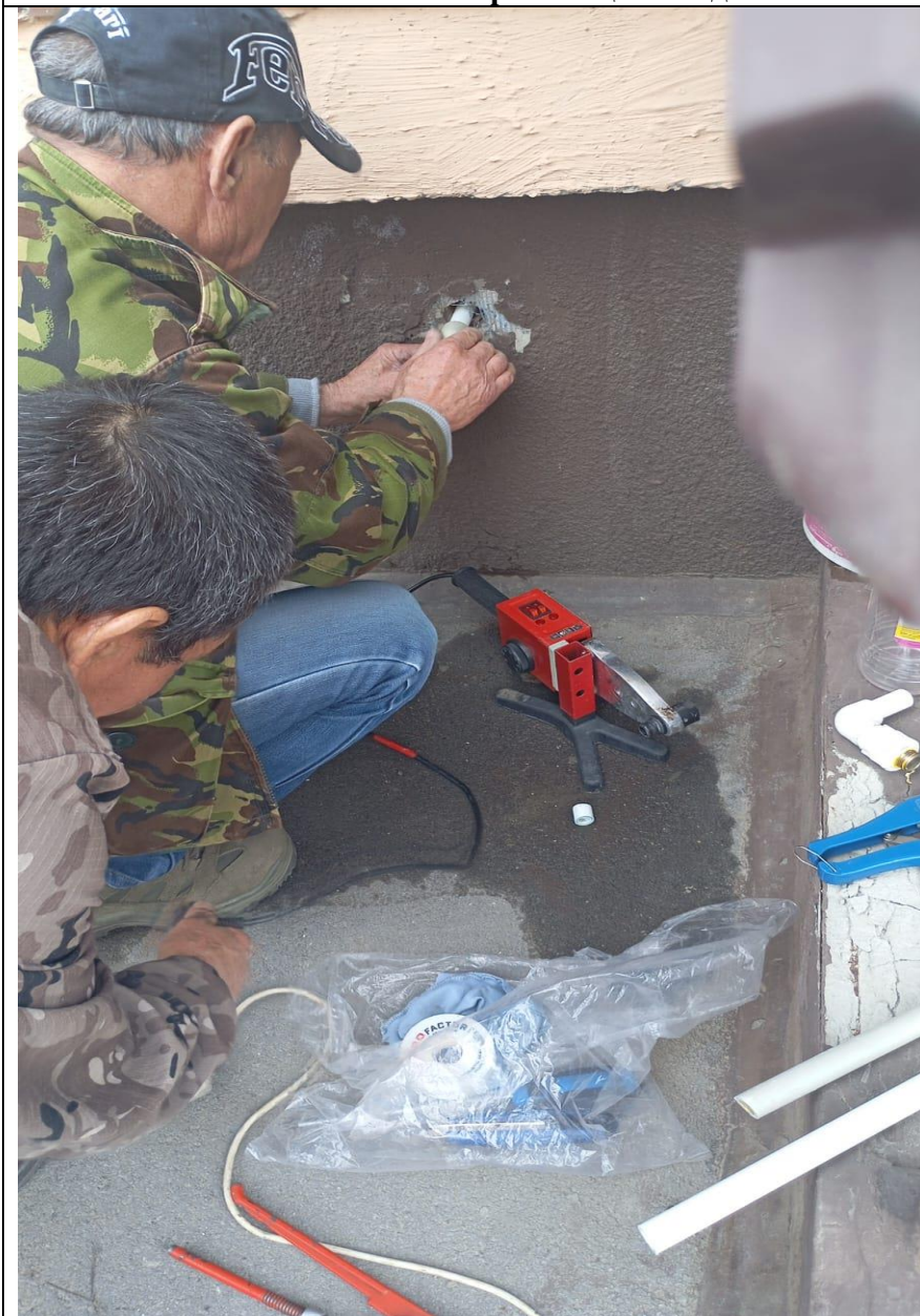
Ремонт поливочного крана в цоколе дома.
