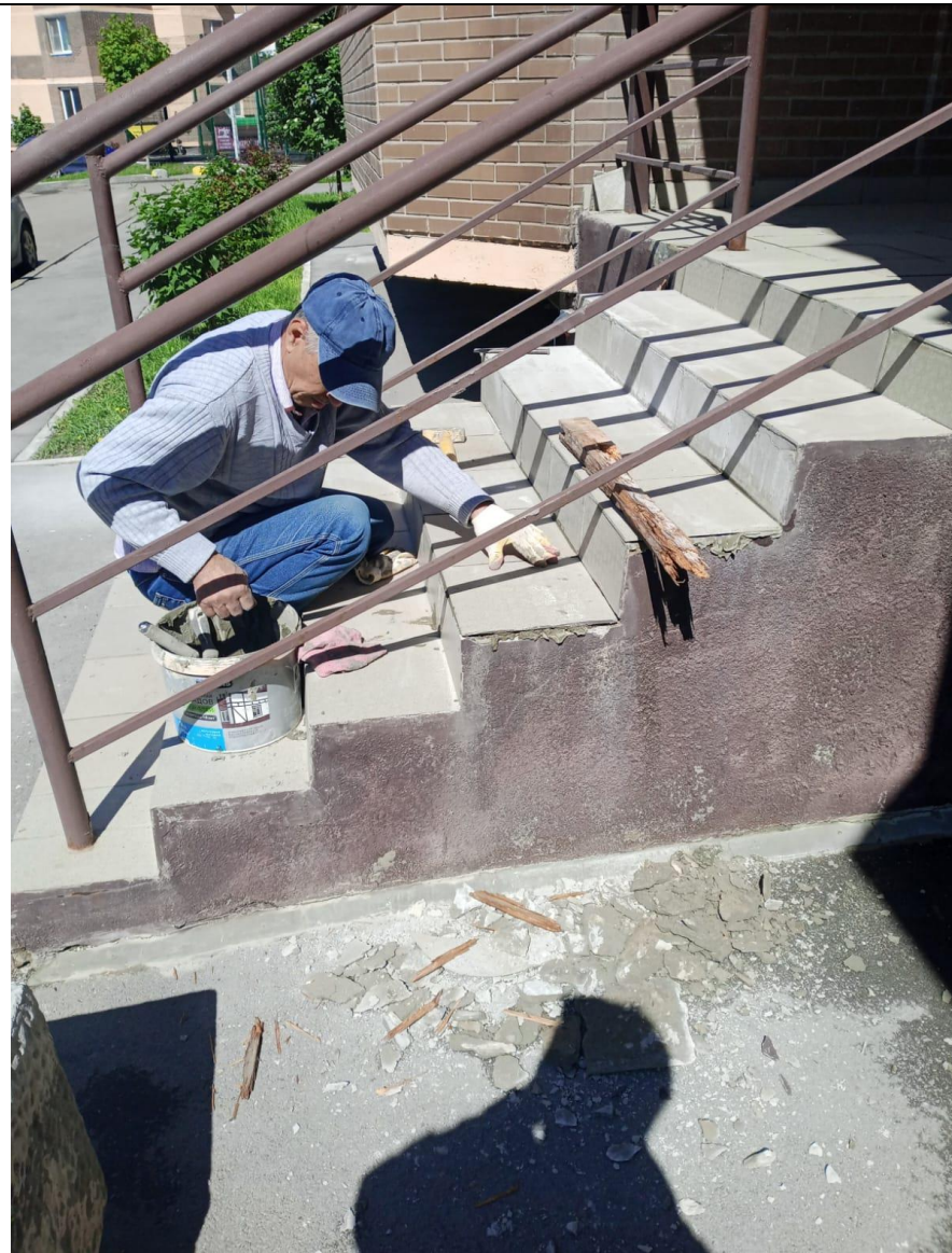
Замена плитки входных групп.
