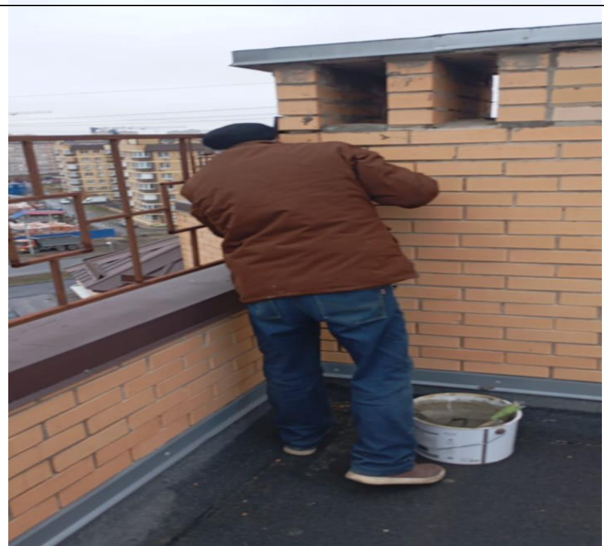
Ремонтные работы на крыше.
