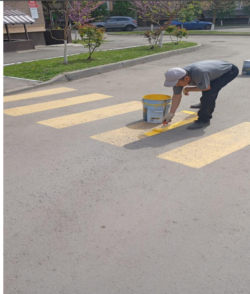
Покраска пешеходного перехода.
