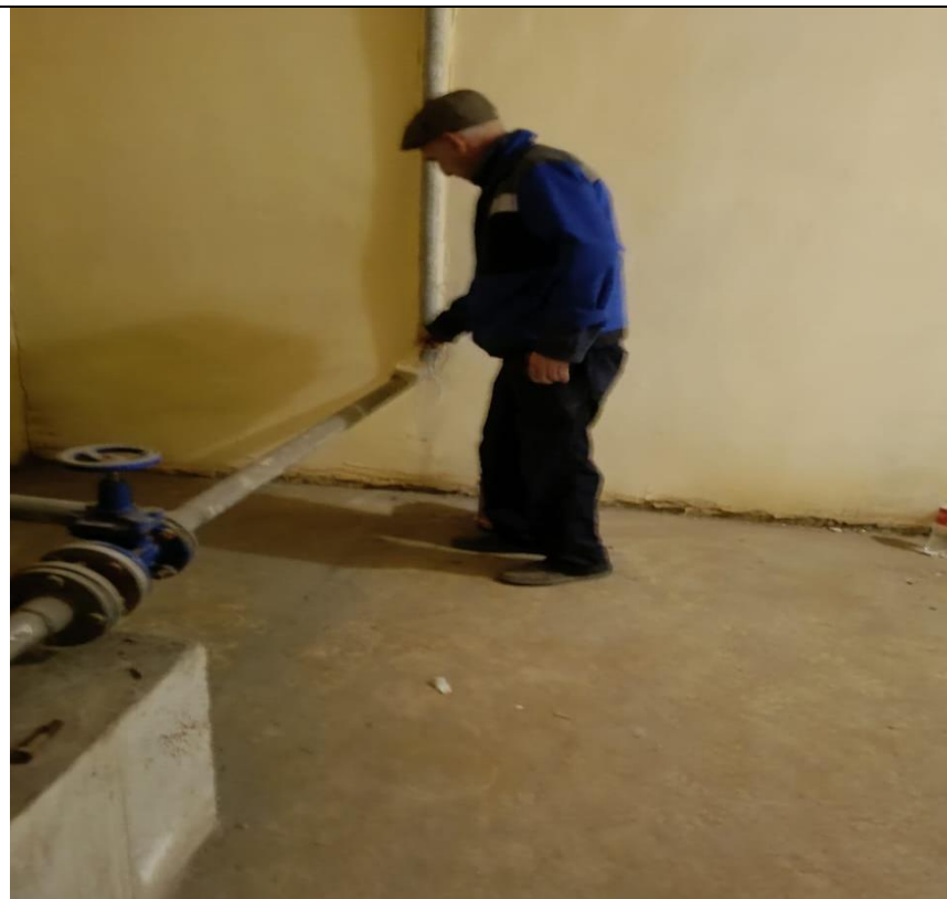
Уборка в помещении насосной станции
