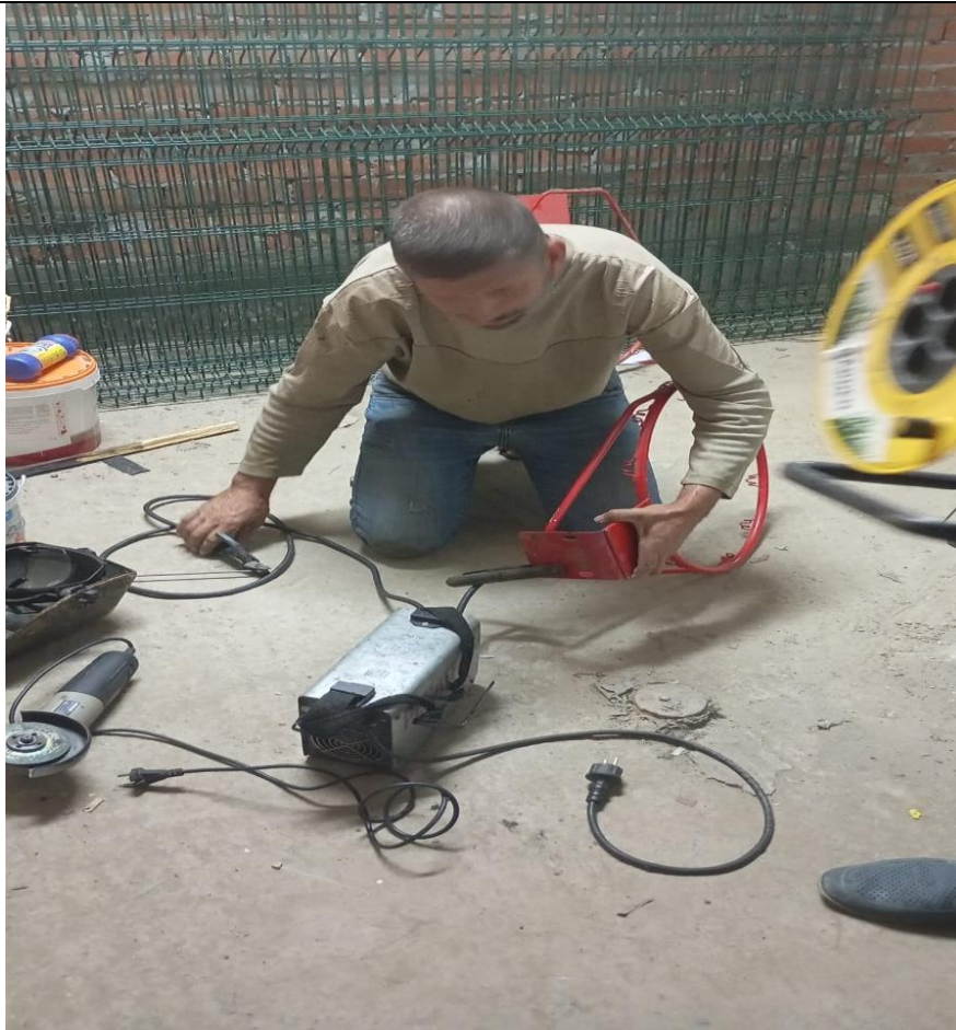
Ремонт баскетбольных колец
