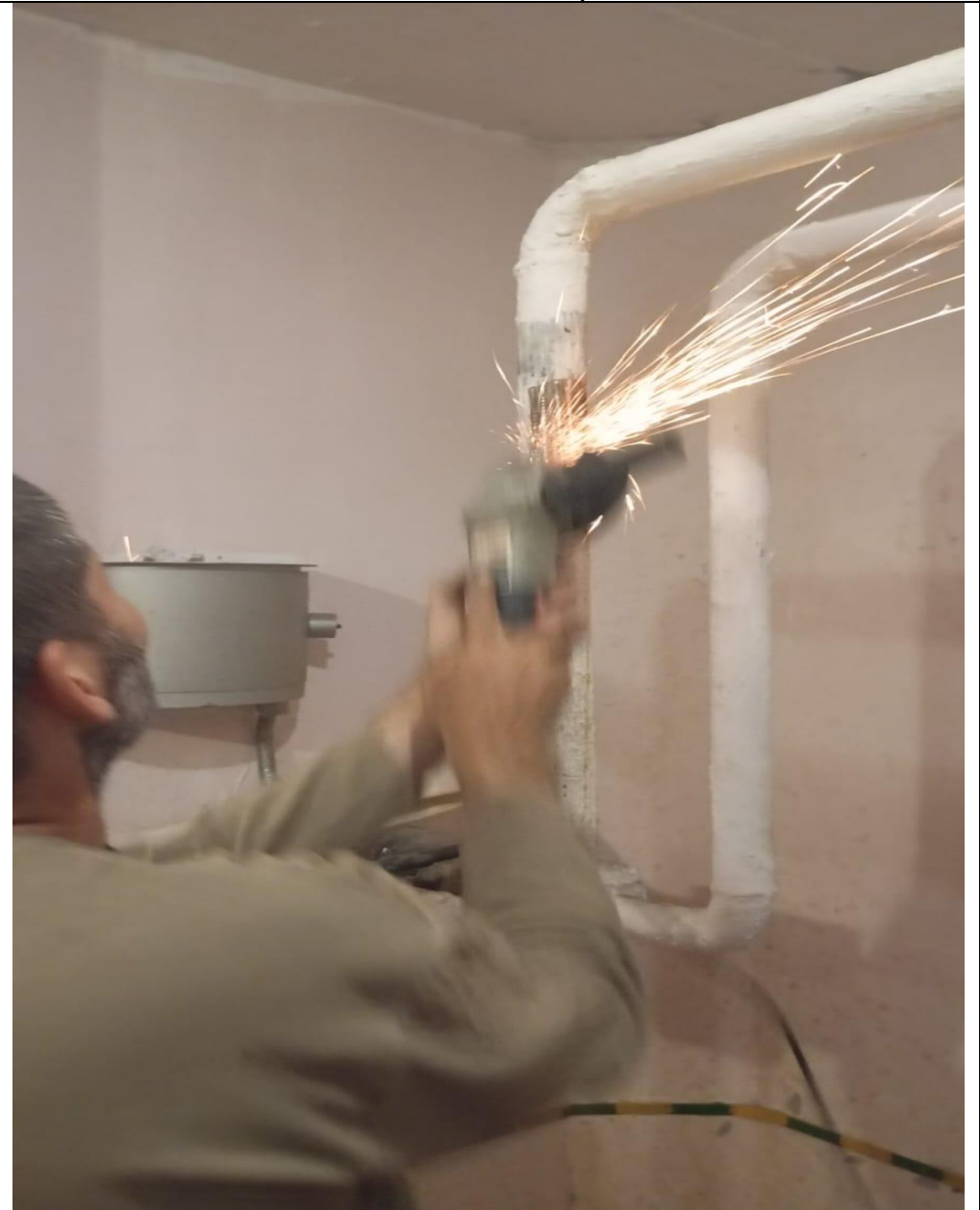
Подготовка к сварке
