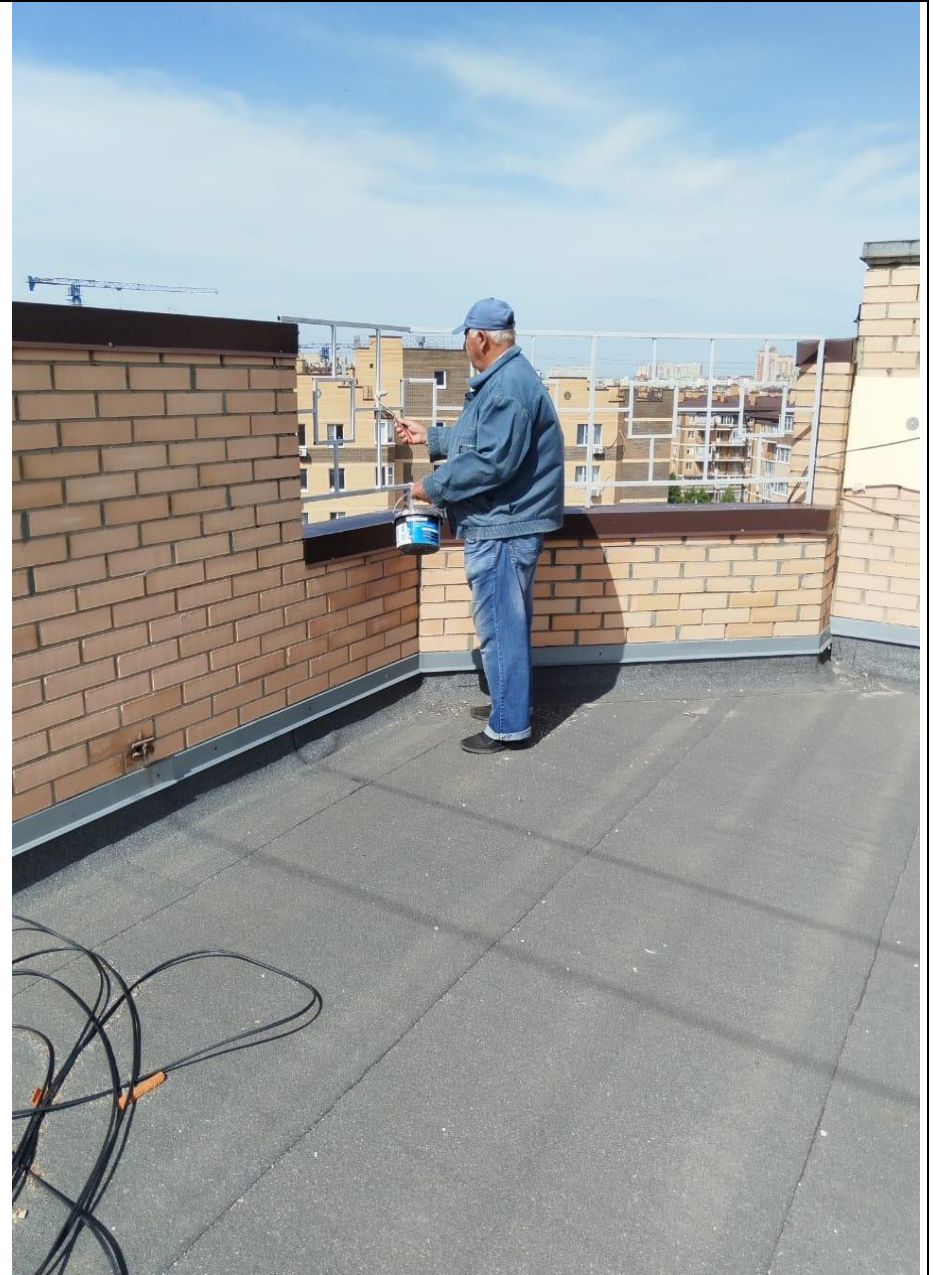
Покраска ограждений на крыше
