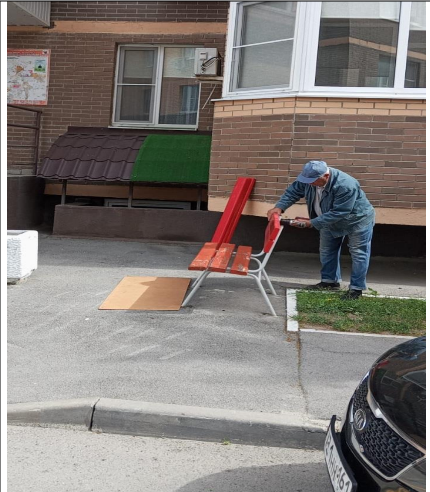
Ремонт скамеек на территории.
