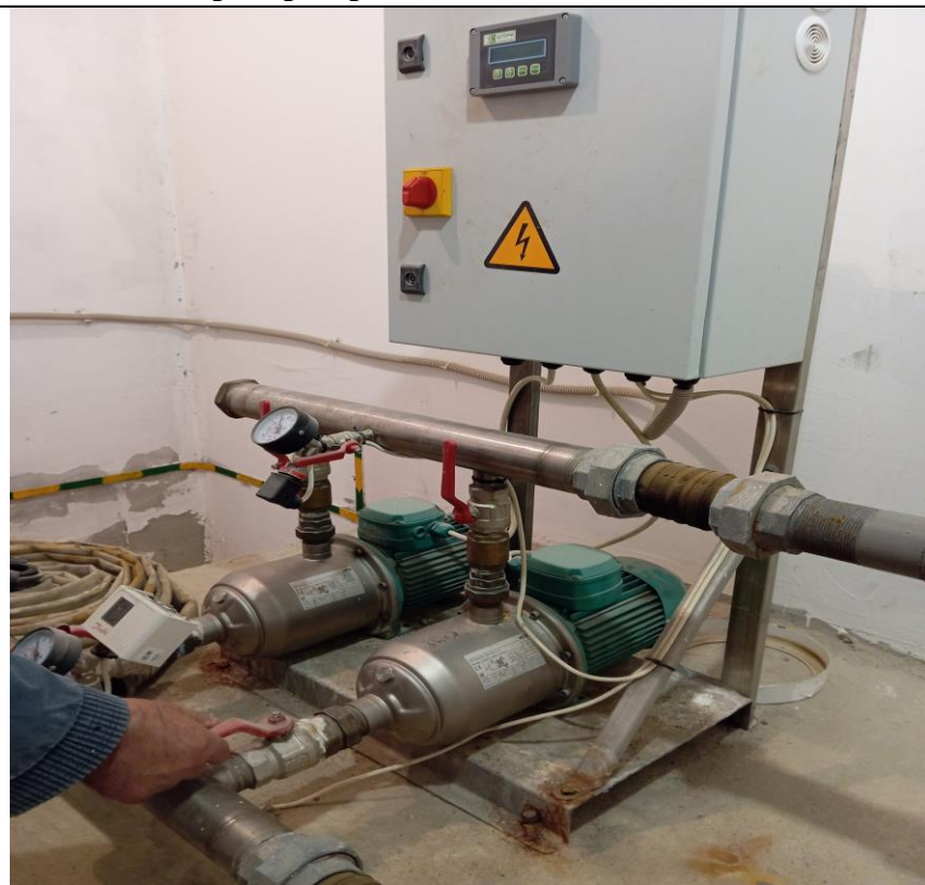
Проверка работы насосной станции
