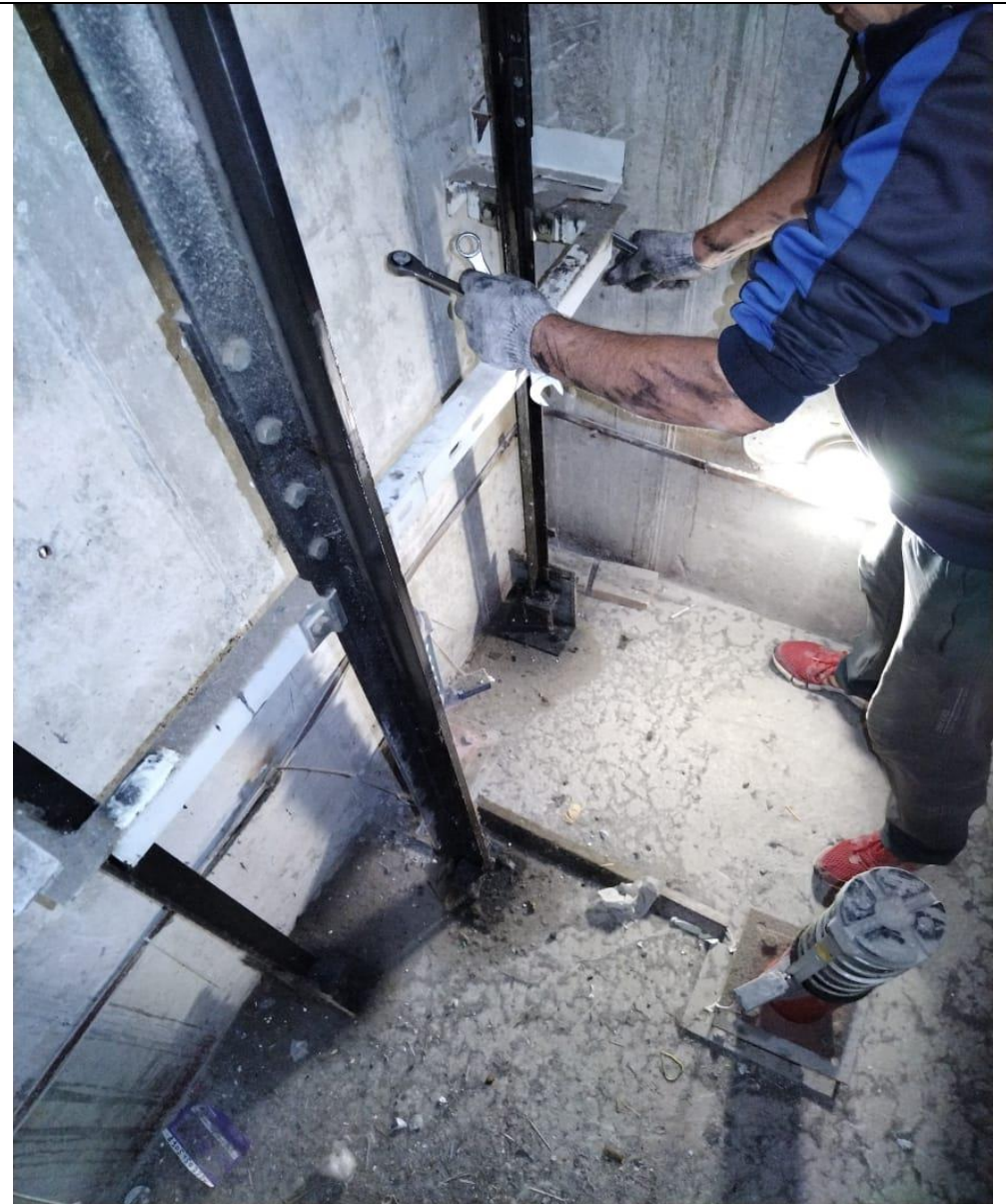
Проведение работ по выставлению направляющих.
