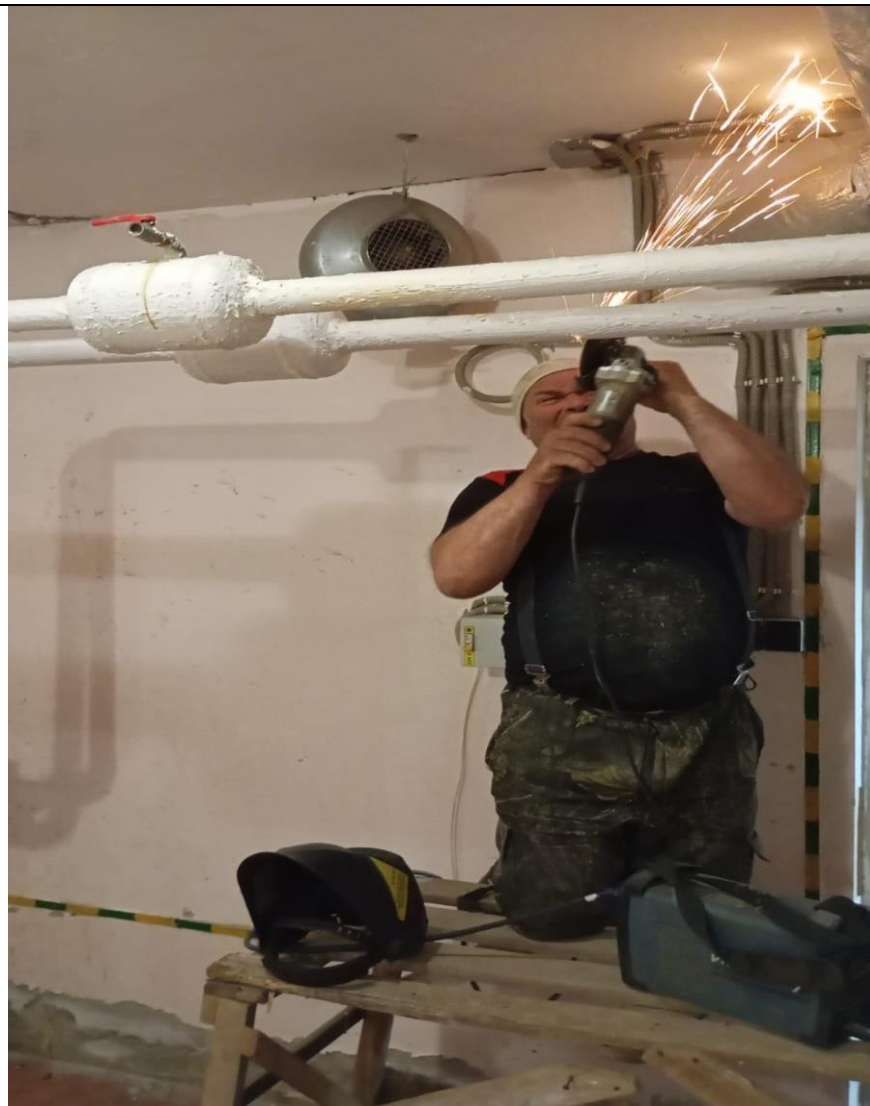
Замена участка трубы
