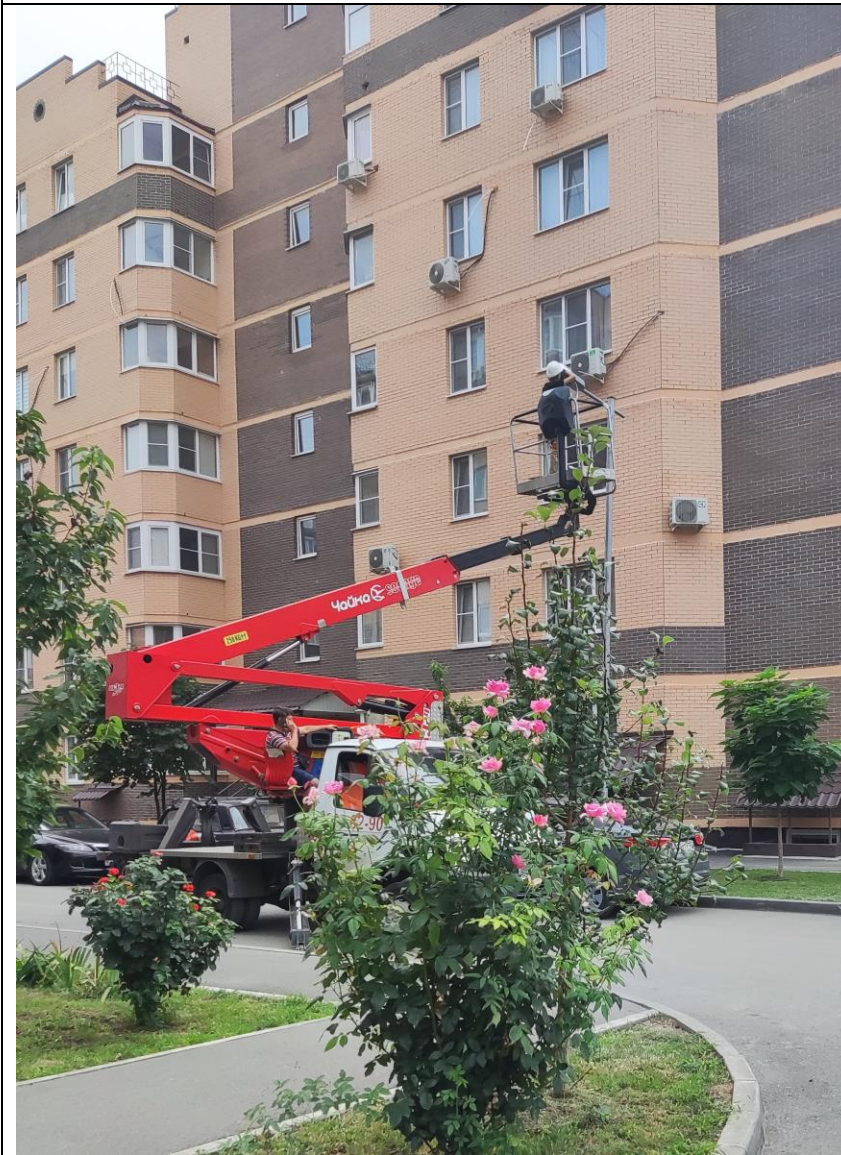
Замена ламп и пускателей в кобрах уличного освещения.
