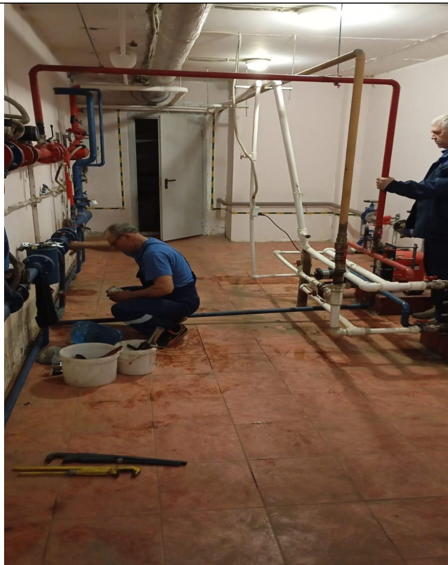
Протяжка фланцевых соединений
