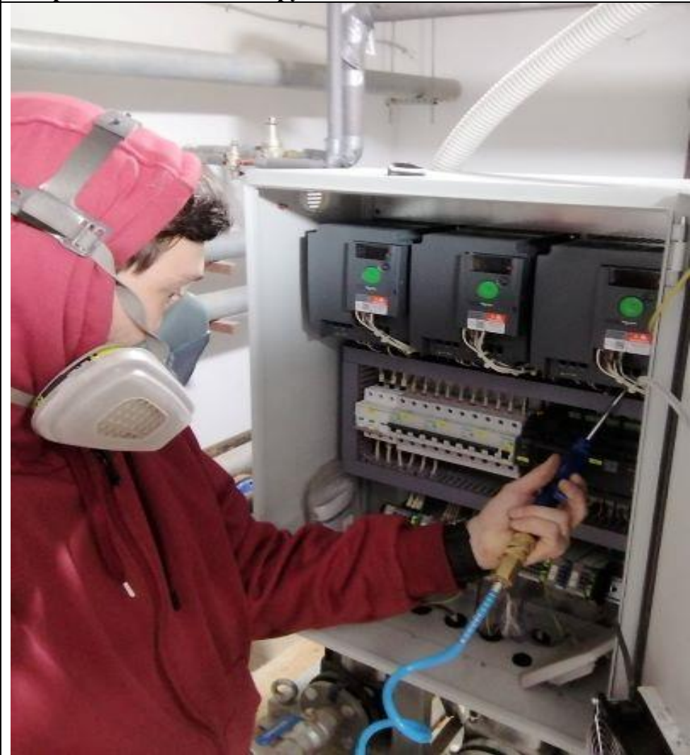
Прочистка от пыли оборудования водоснабжения в насосной
