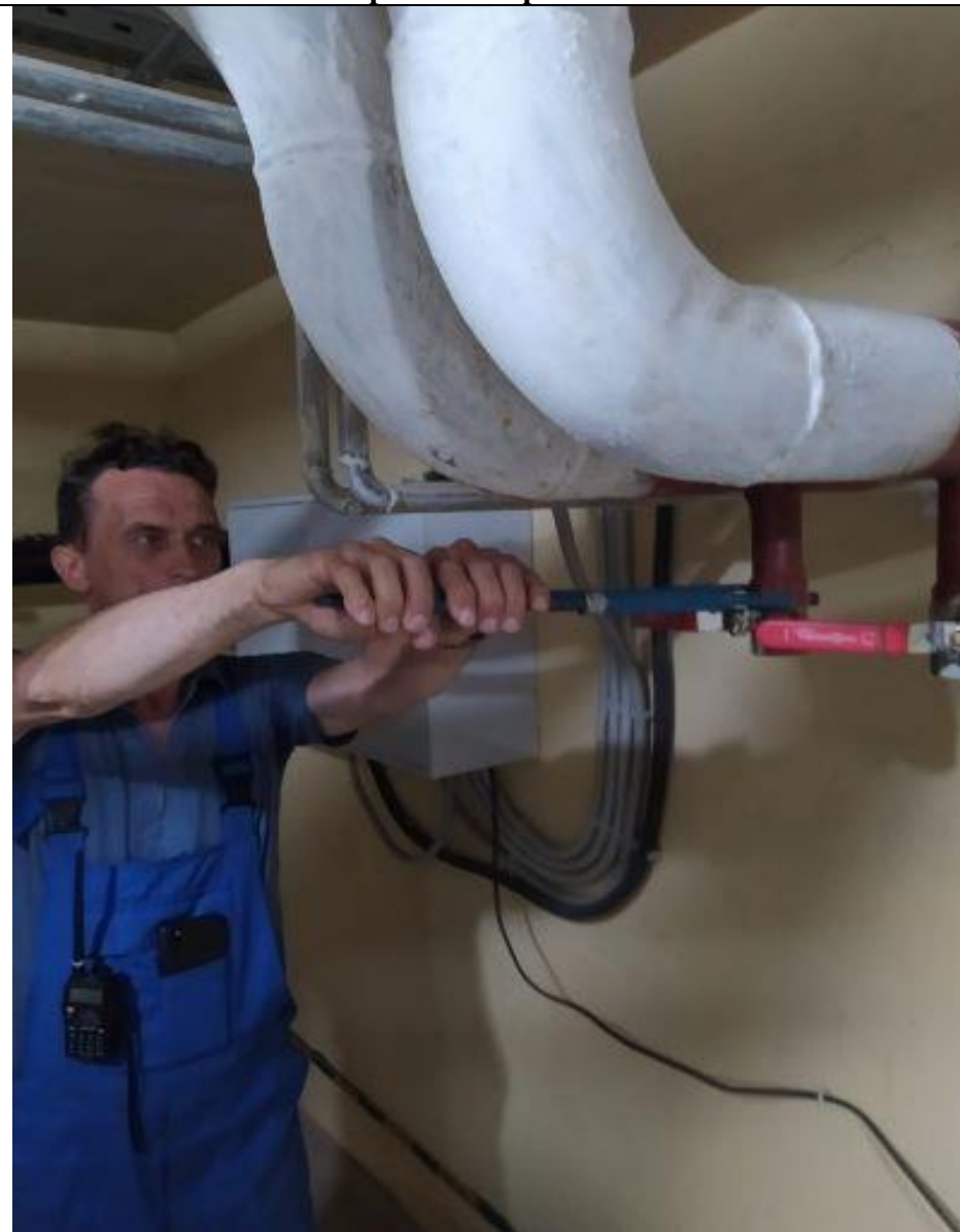
Ремонт крана на сбросе отопления
