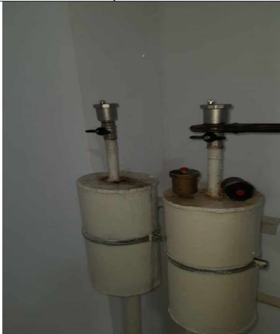
Замена автовоздушников в системе отопления
