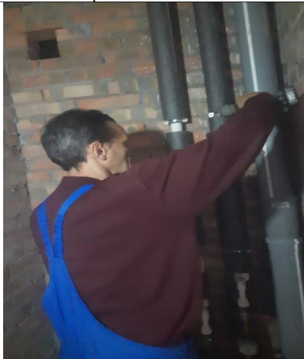
Замена ревизии канализационного стояка
