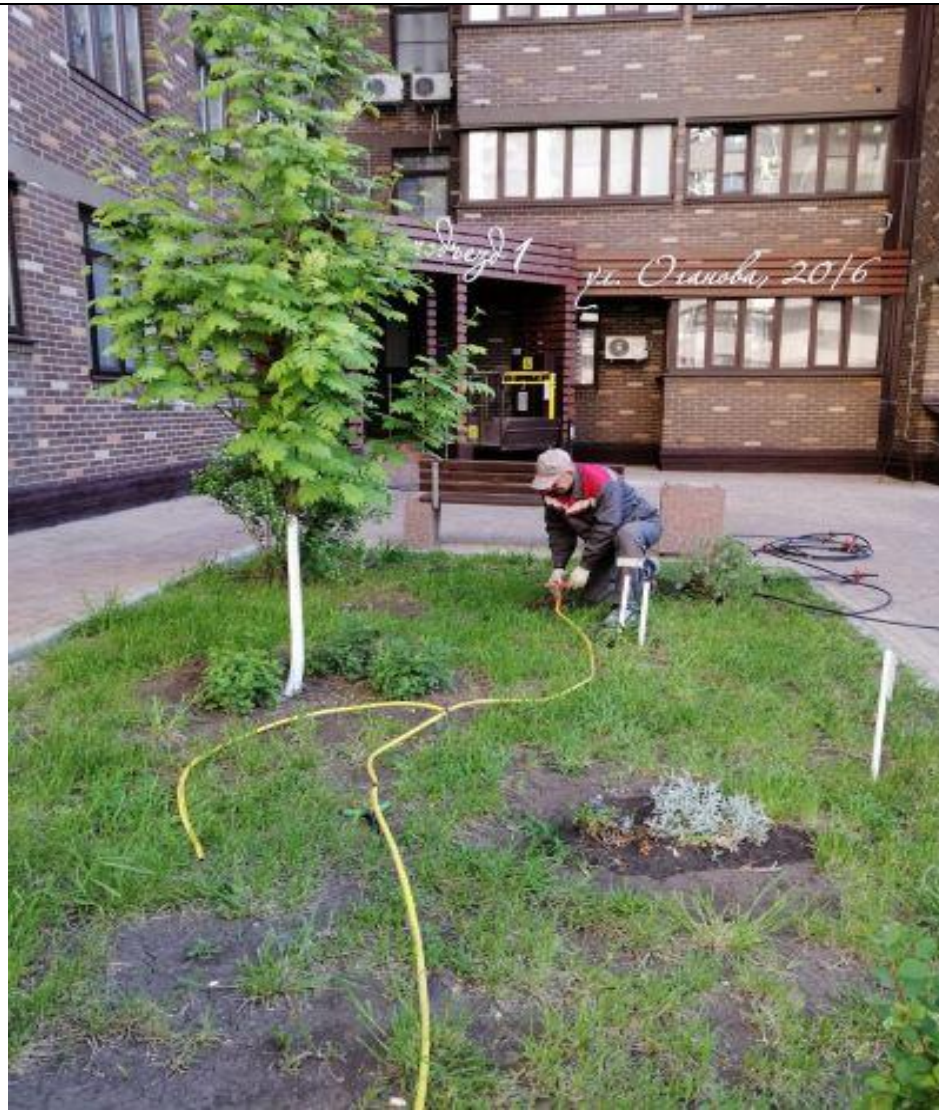
Ремонт капельного полива
