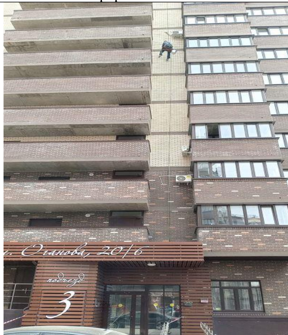
Восстановление теплоизоляционных швов поэтажного перекрытия
