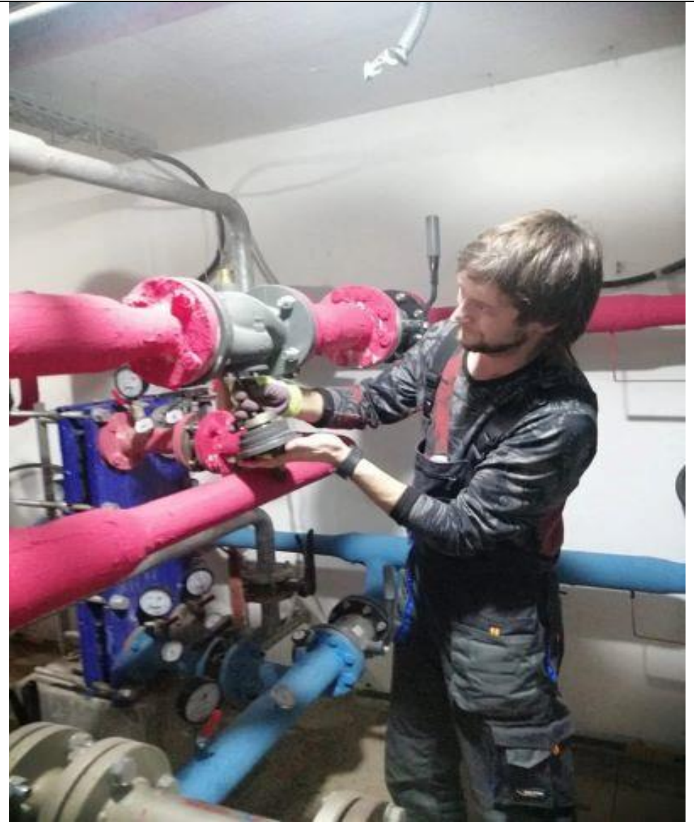
Ремонт клапана ГВС
