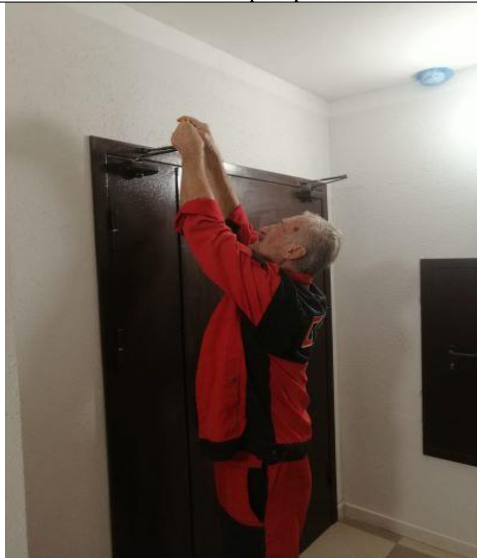
Ремонт доводчика двери лифтового холла
