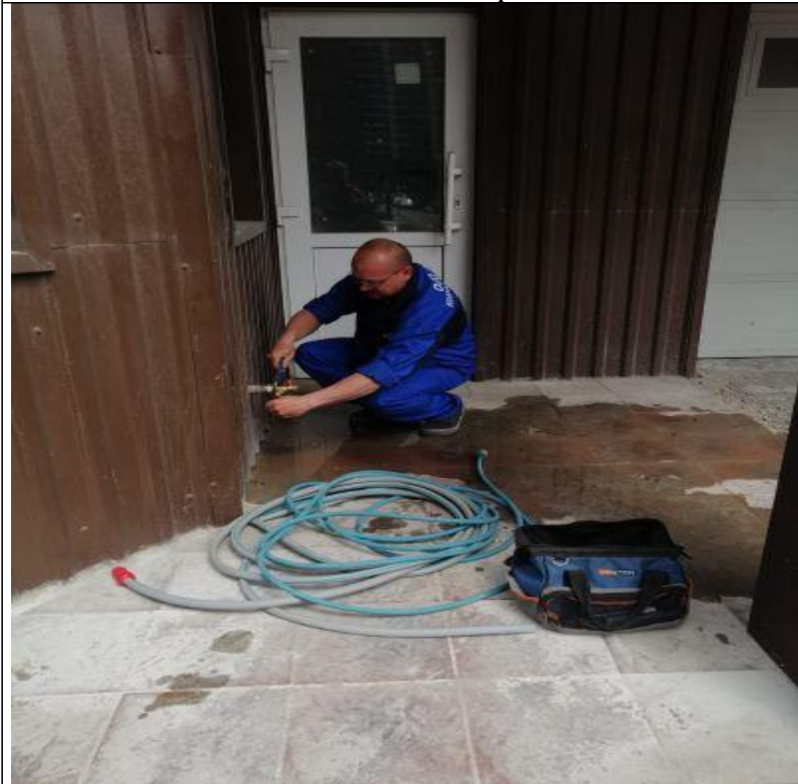
Замена поливочного крана
