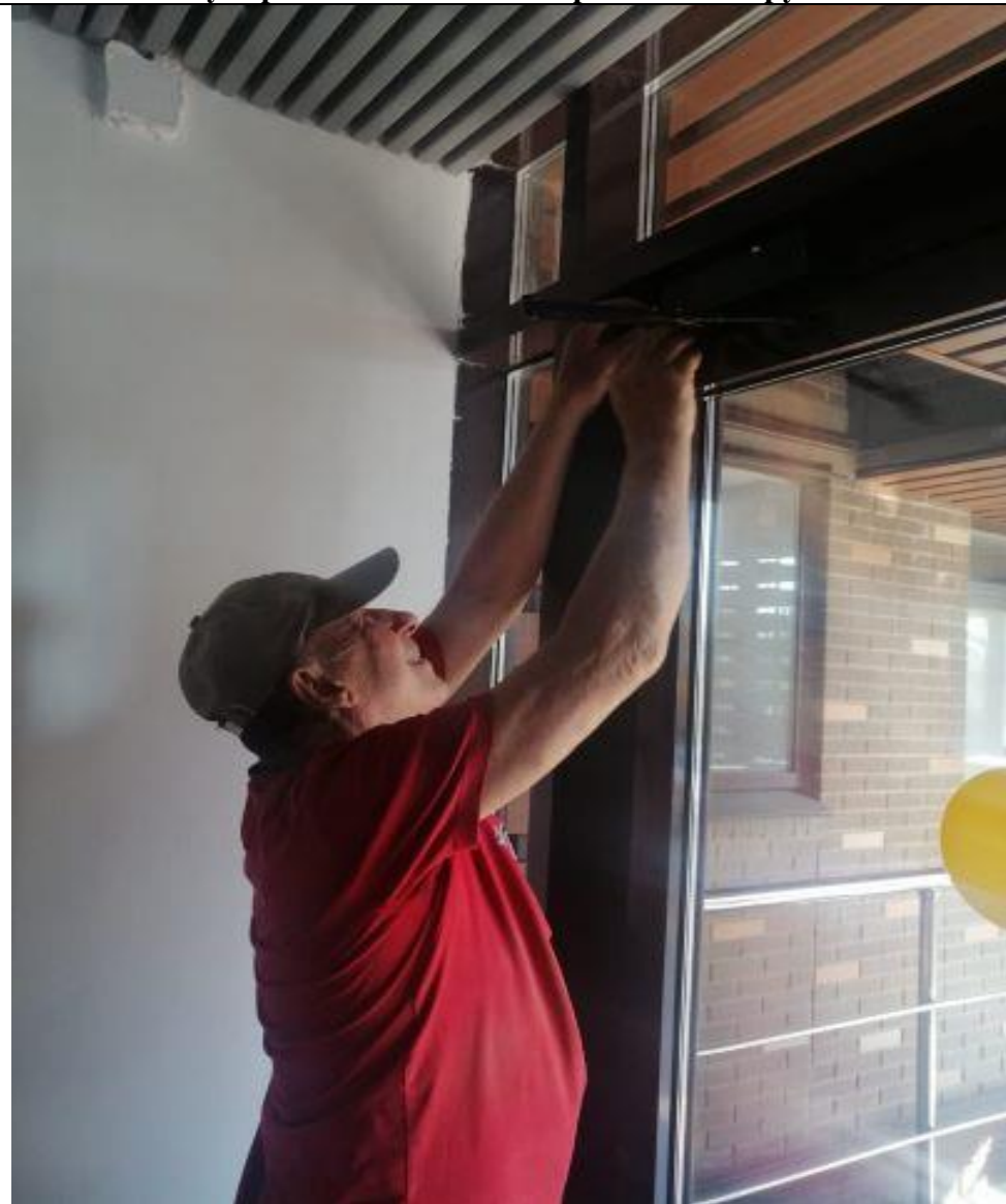
Регулировка доводчика двери входной группы
