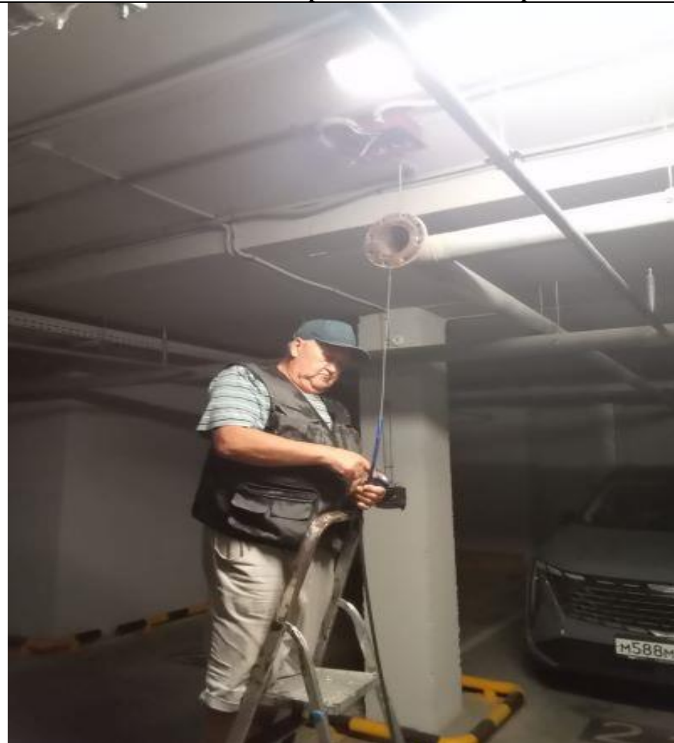
Укладка кабеля обогрева водостока на парковке
