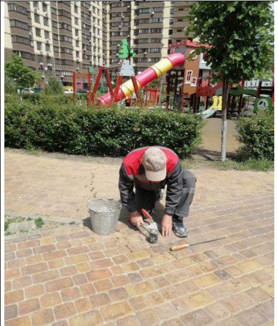
Ремонт тротуарной плитки
