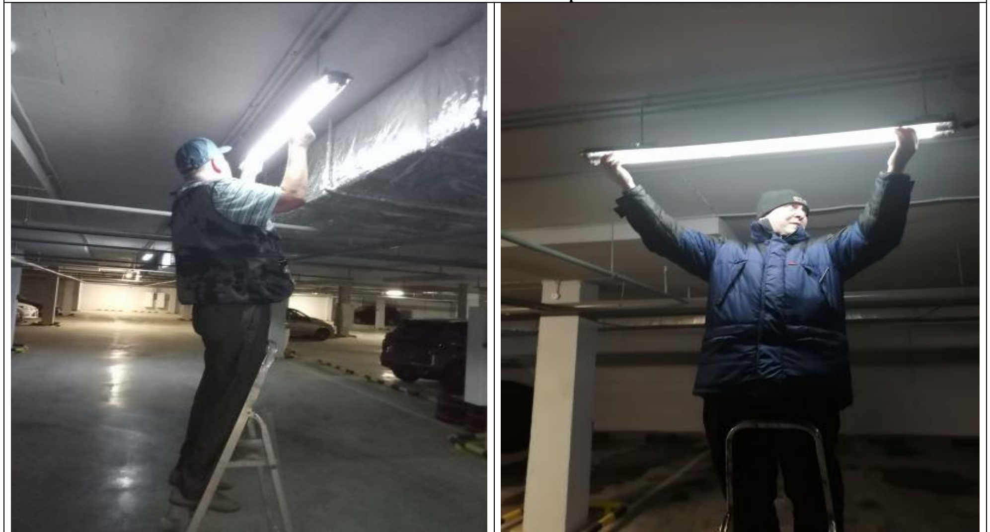
Замена светильников на парковке
