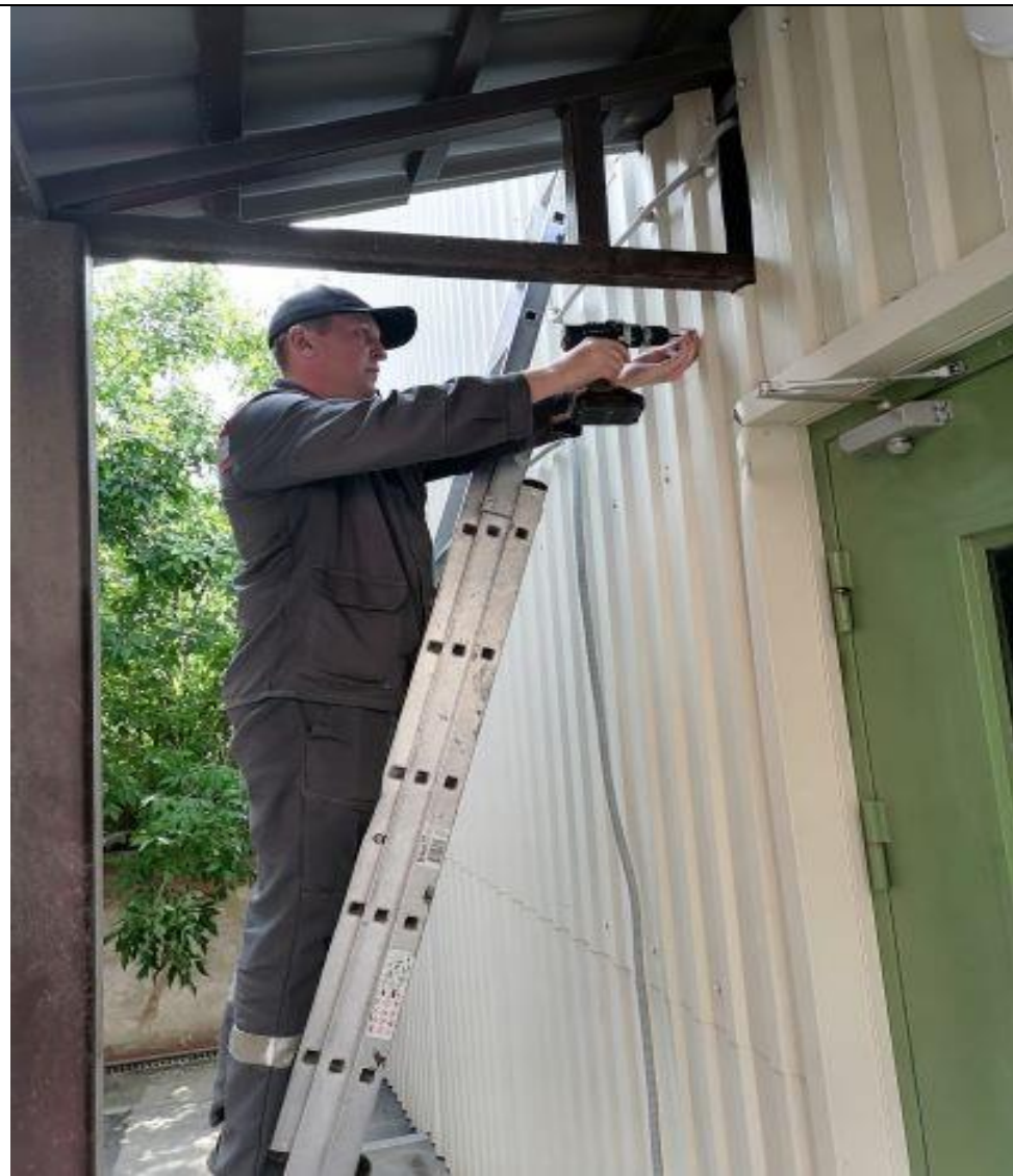
Установка прожектора на парковке 8
