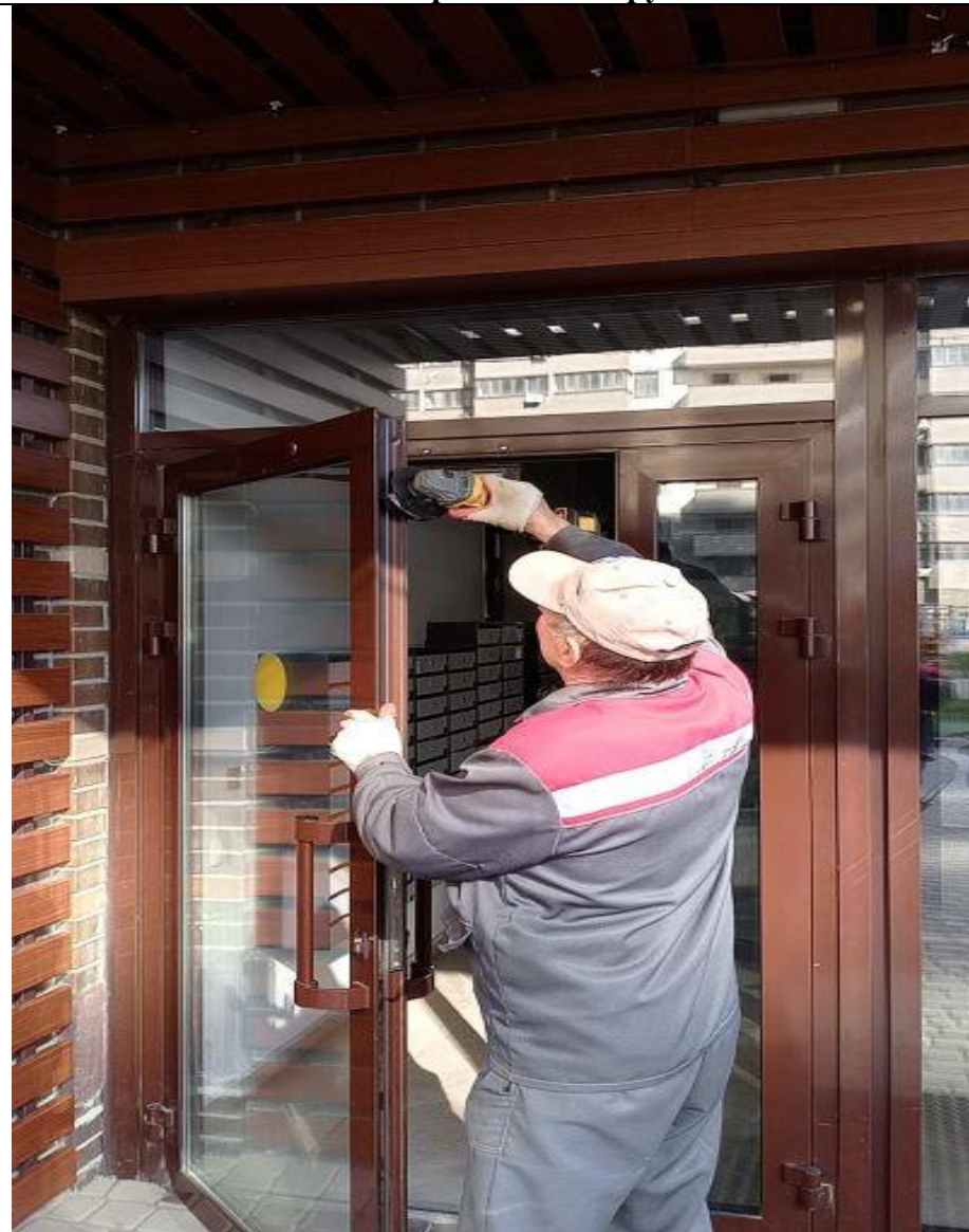
Ремонт двери входной группы
