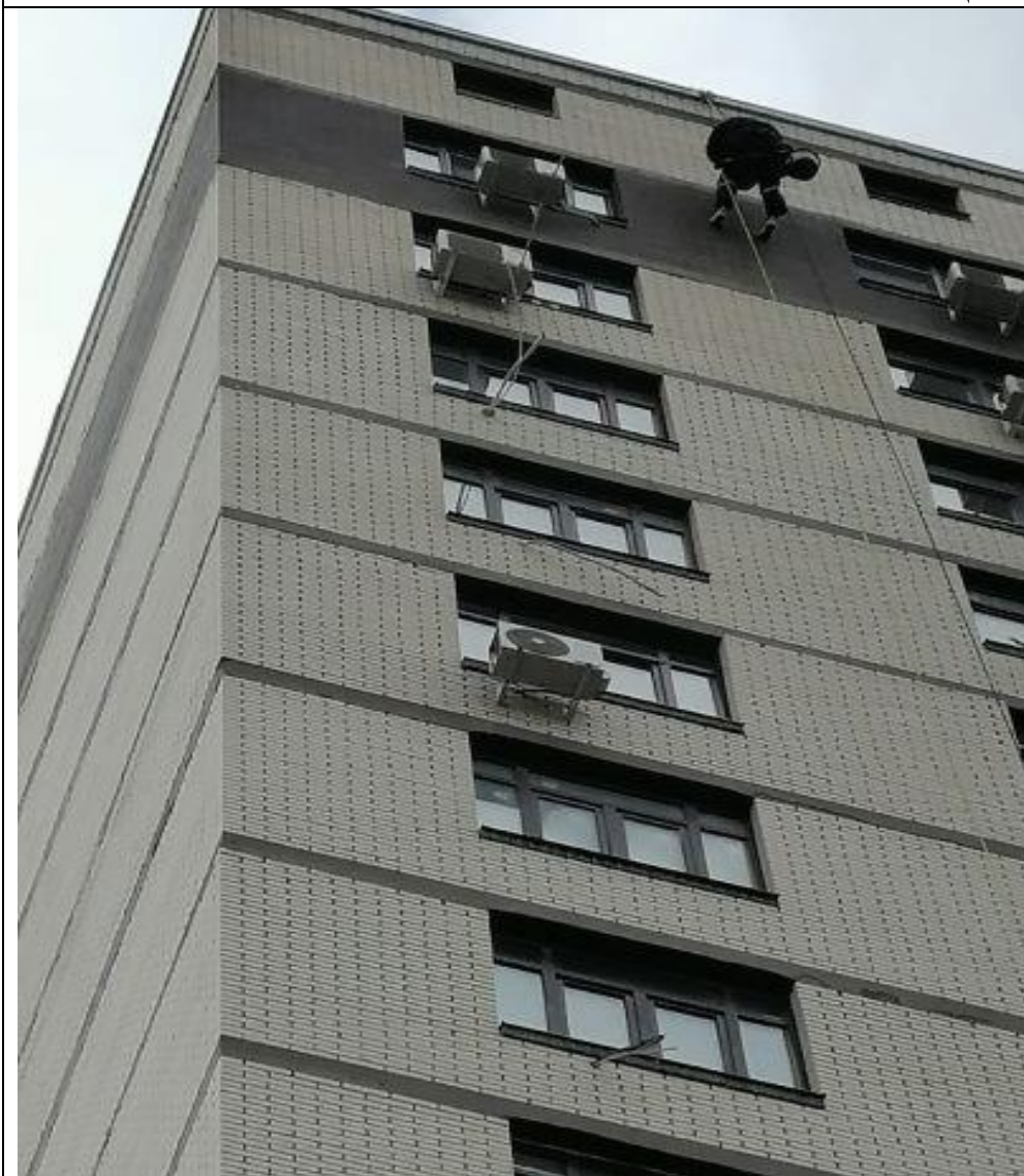
Восстановление теплоизоляционных швов поэтажного перекрытия
