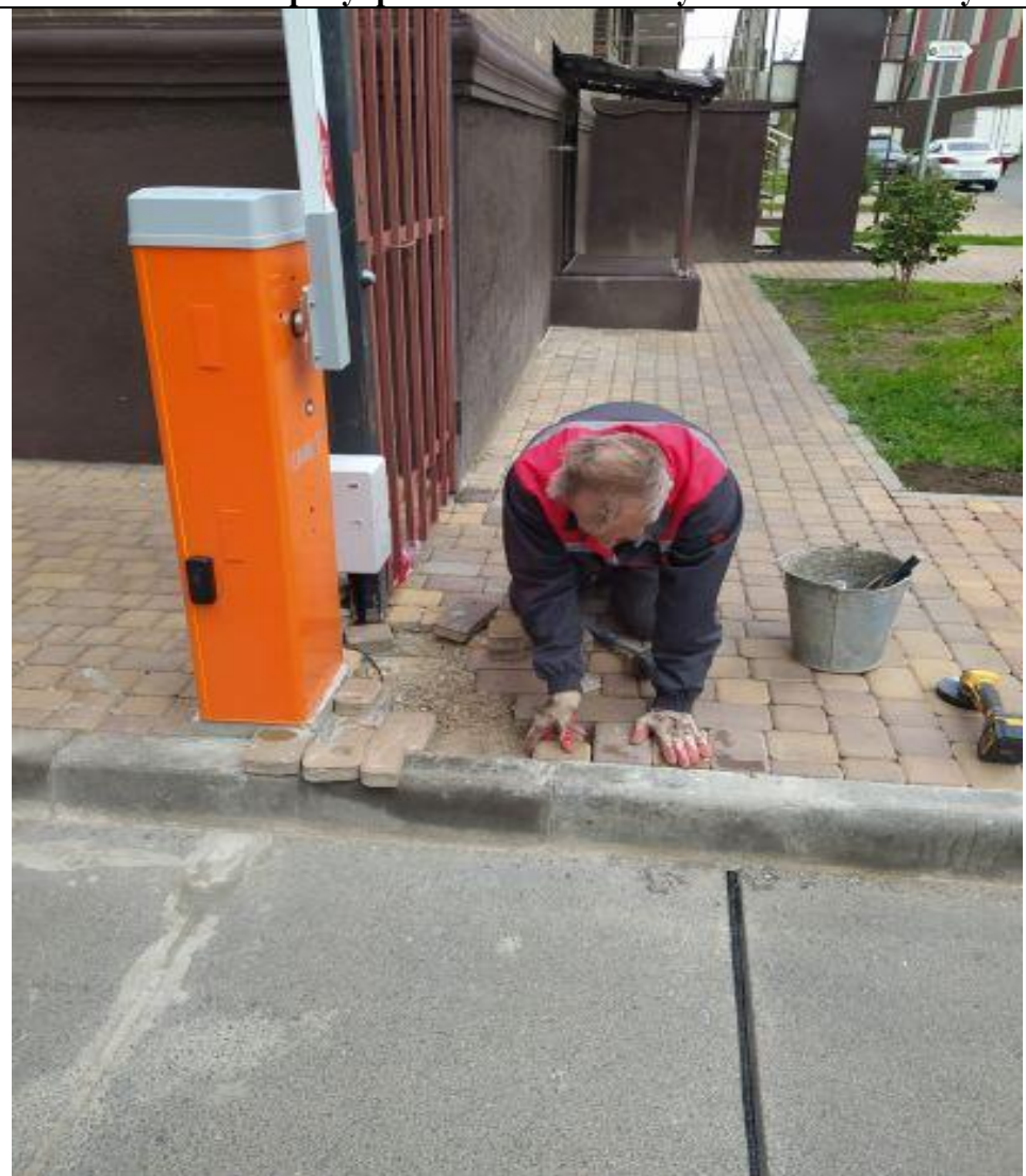
Восстановление тротуарной плитки после установки шлагбаума
