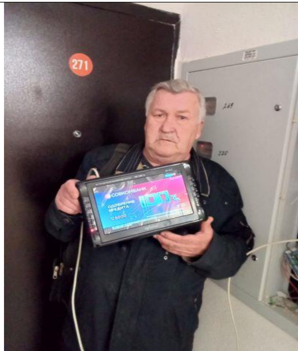
Ремонт телевизионного кабеля
