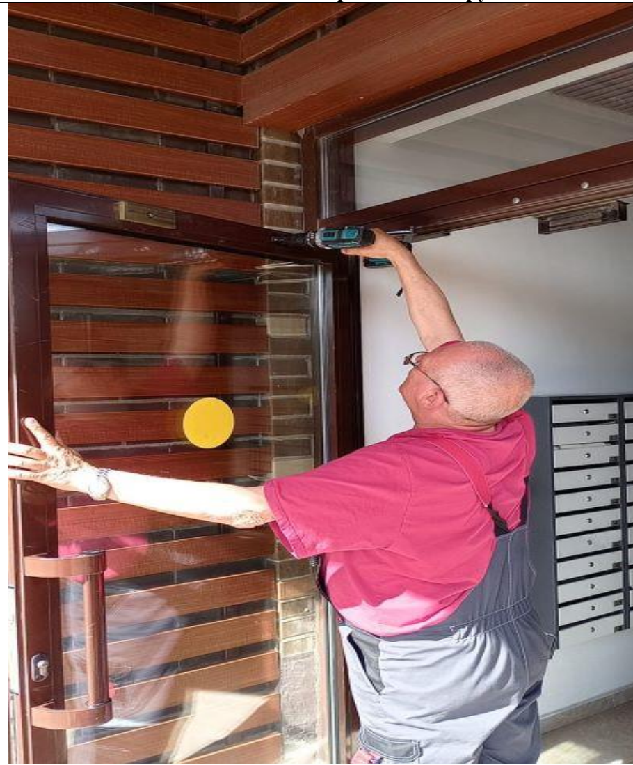
Замена доводчика двери входной группы
