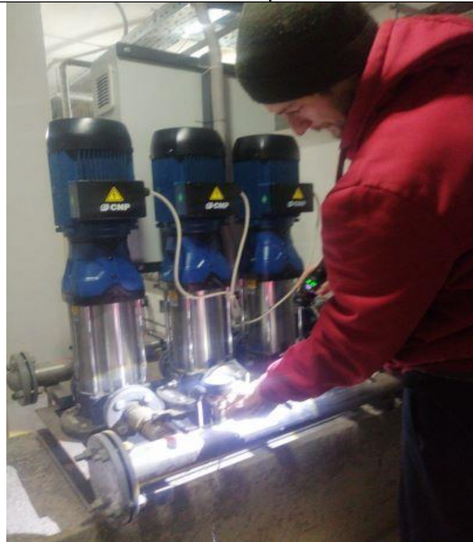
Ревизия насосной установки
