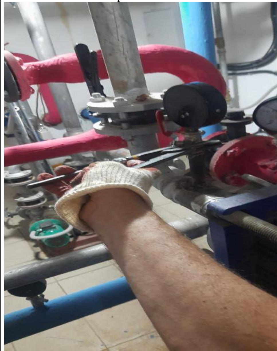
Замена резьбы ГВС в ИТП
