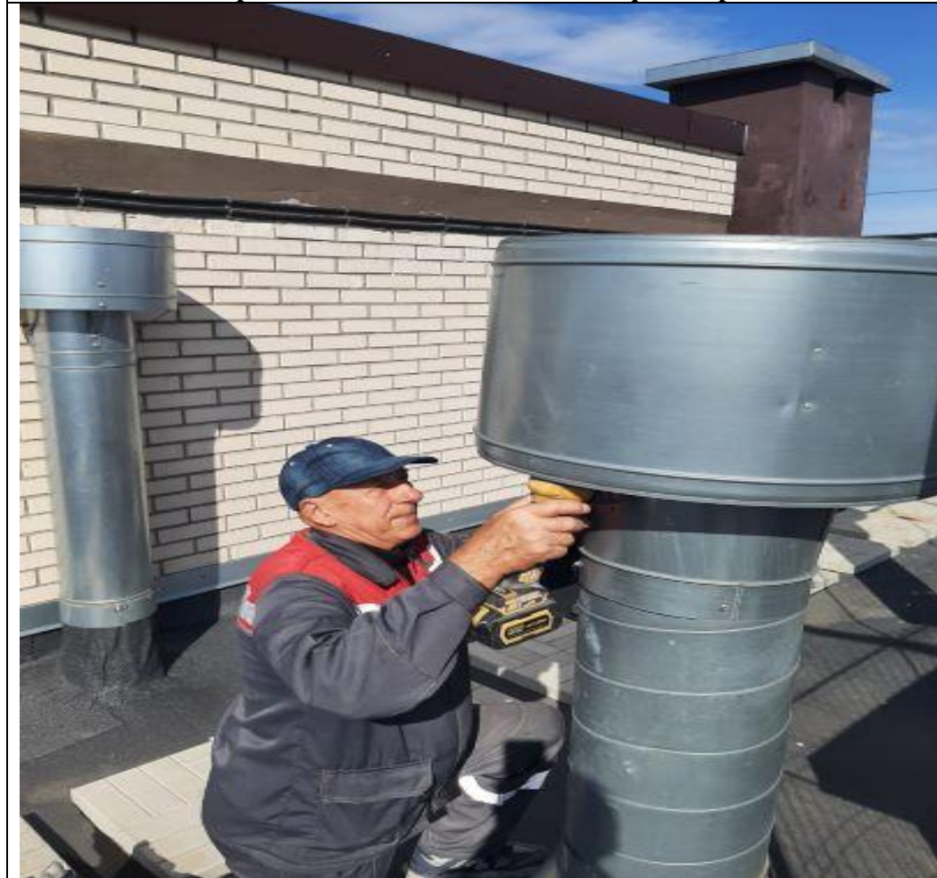
Крепление вентиляционного дефлектора
