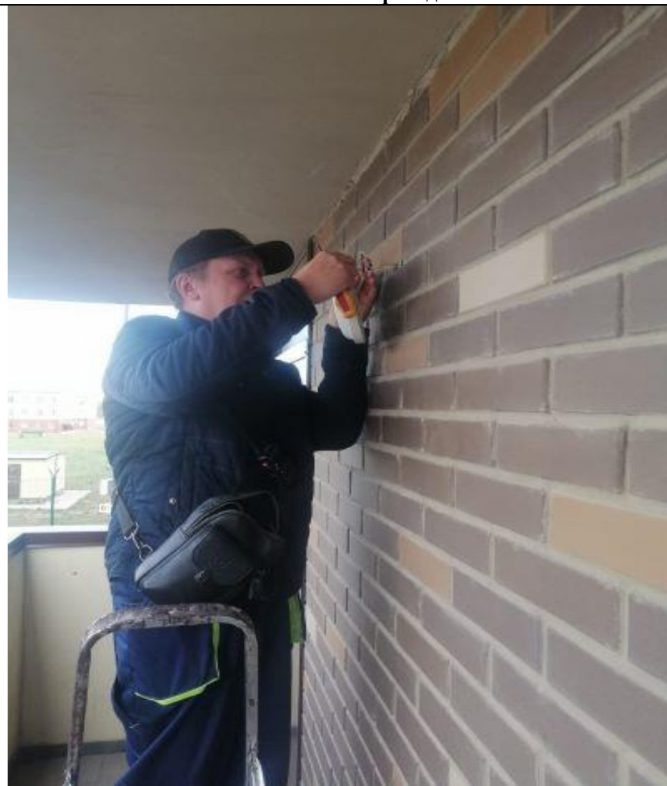
Замена светильника на переходном балконе
