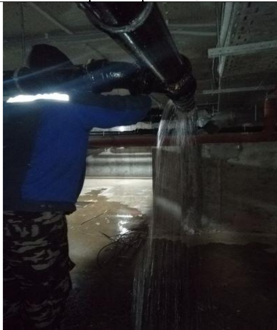
Устранение засора канализации
