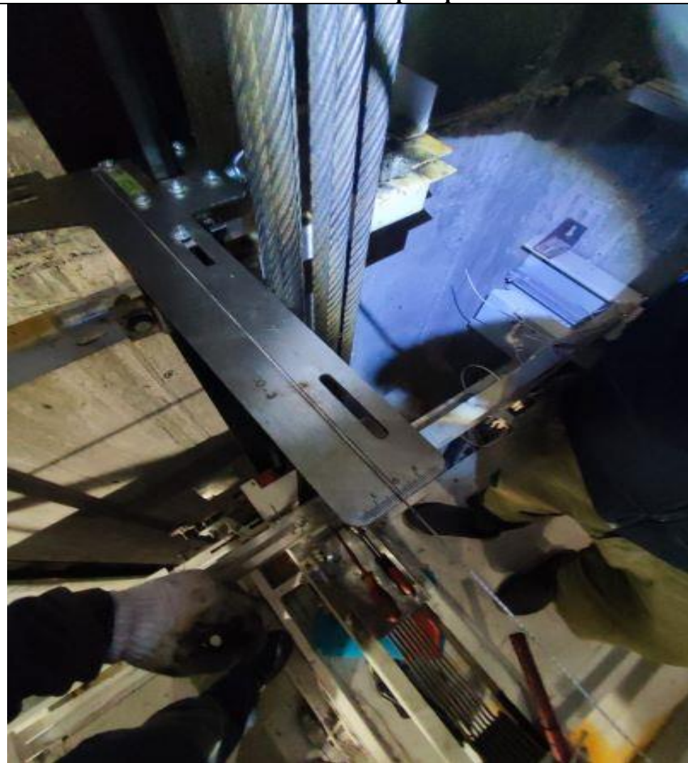
Плановый осмотр лифта
