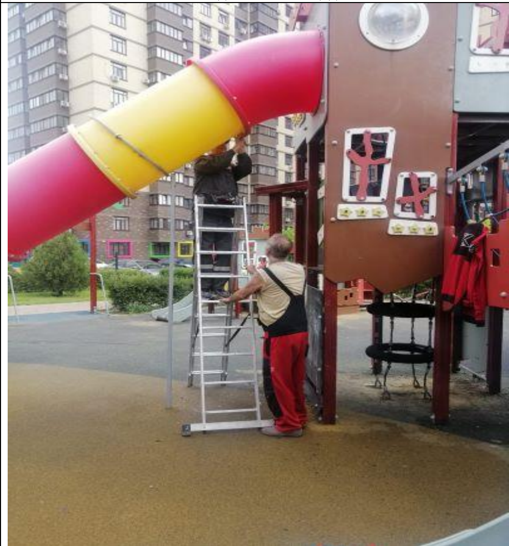
Ремонт детской площадки
