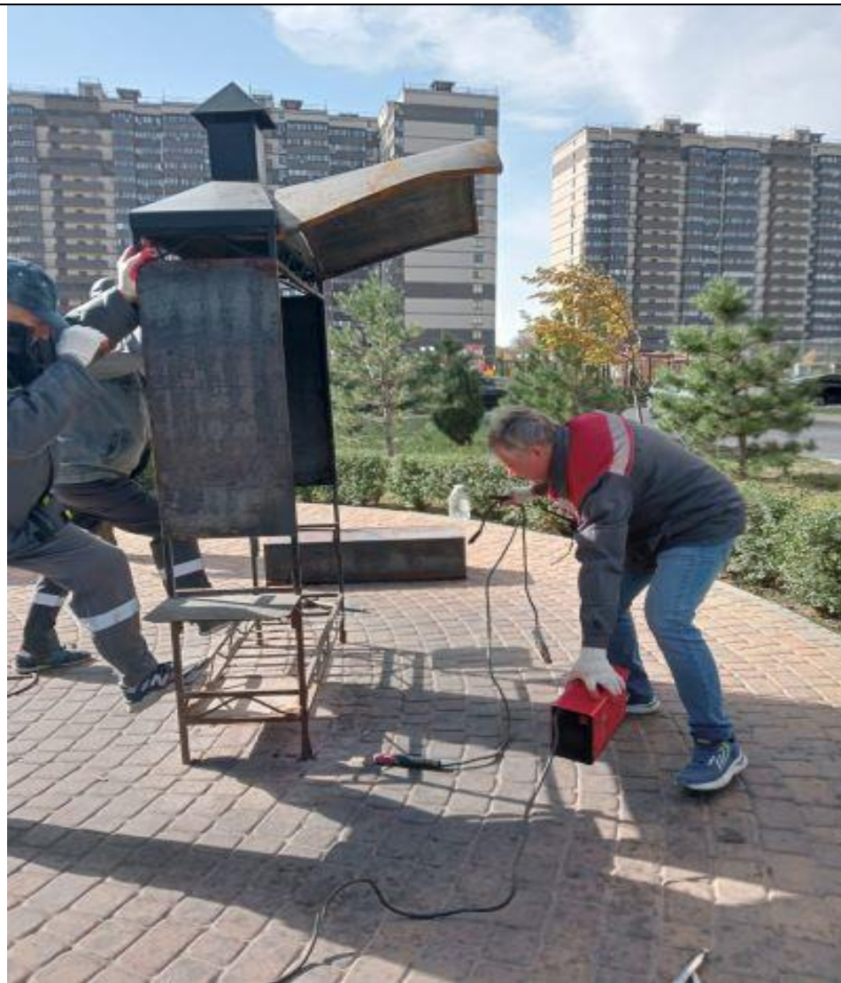
Ремонт мангальной зоны
