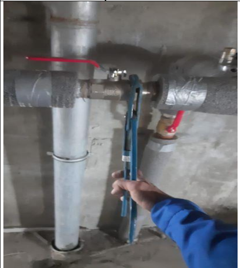
Замена крана на тех. этаже
