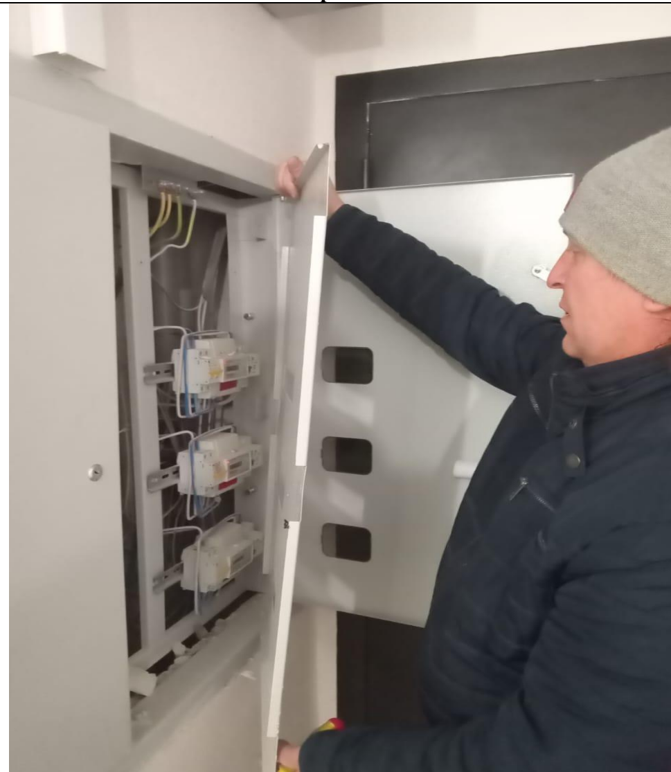
Ремонт электрического щитка
