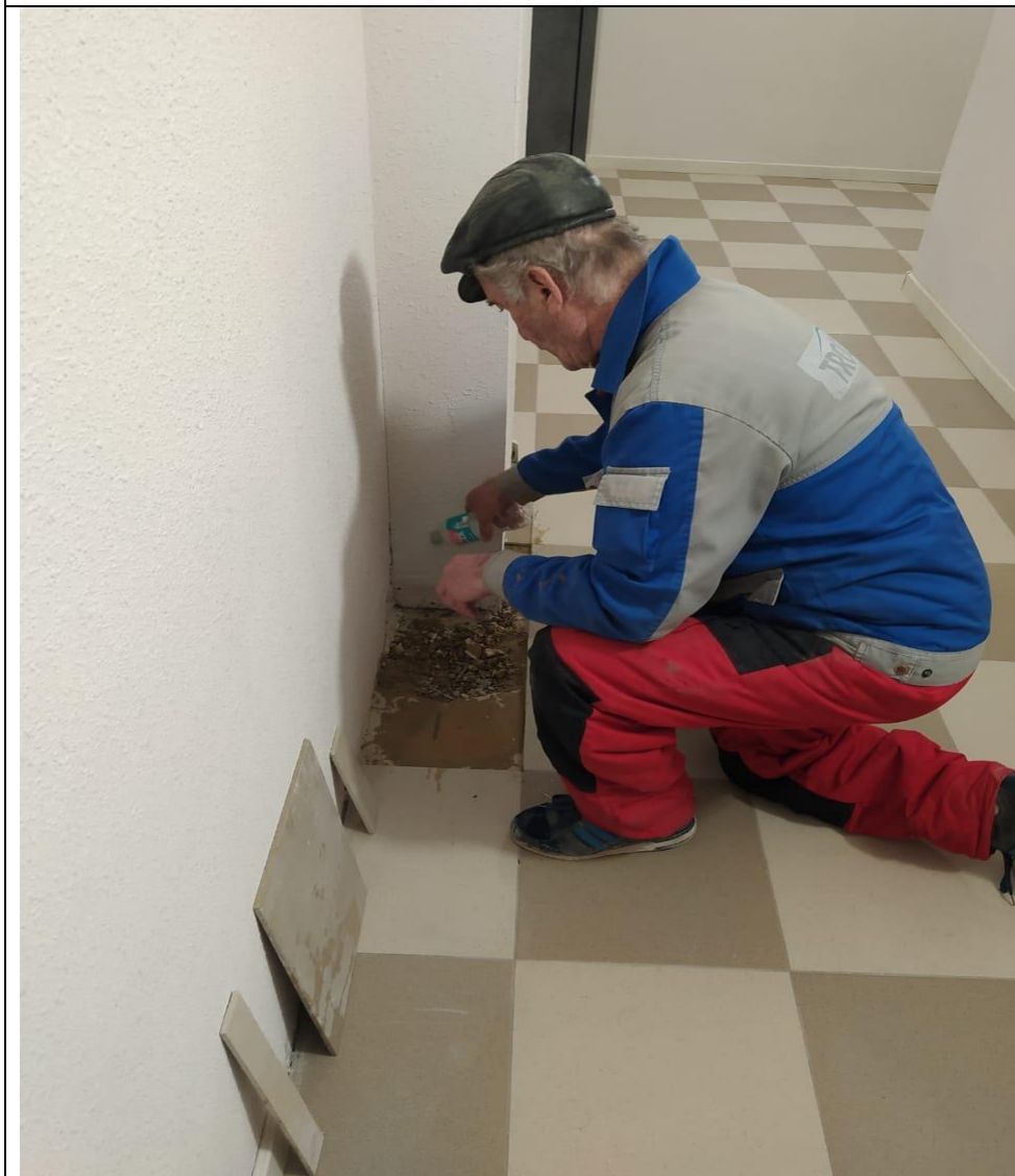
Замена плитки в МОП
