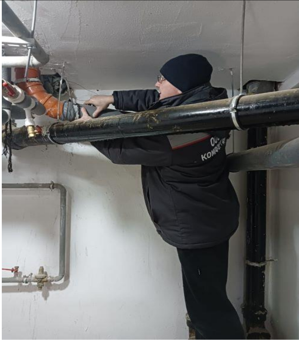
Ремонт стыка канализационных труб
