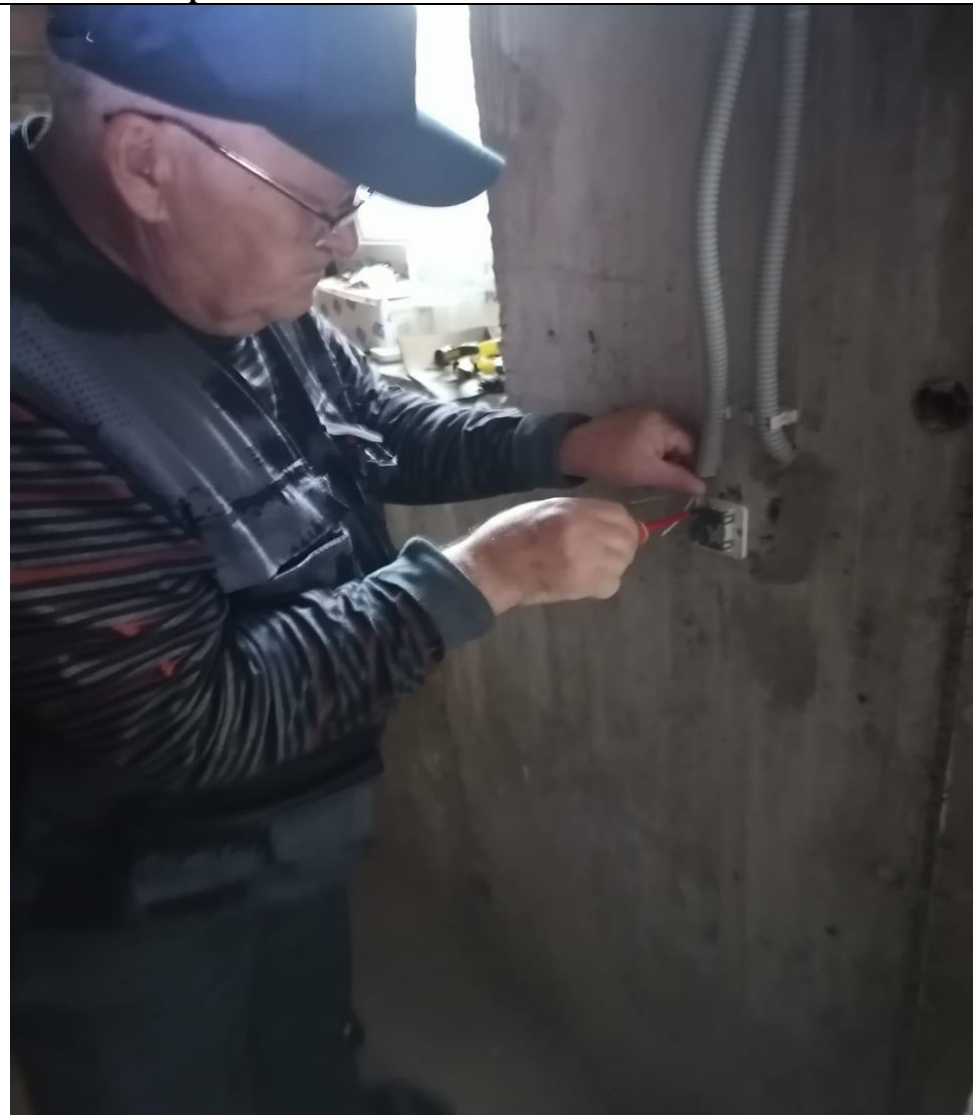
Монтаж проходных выключателей в подвальном помещении
