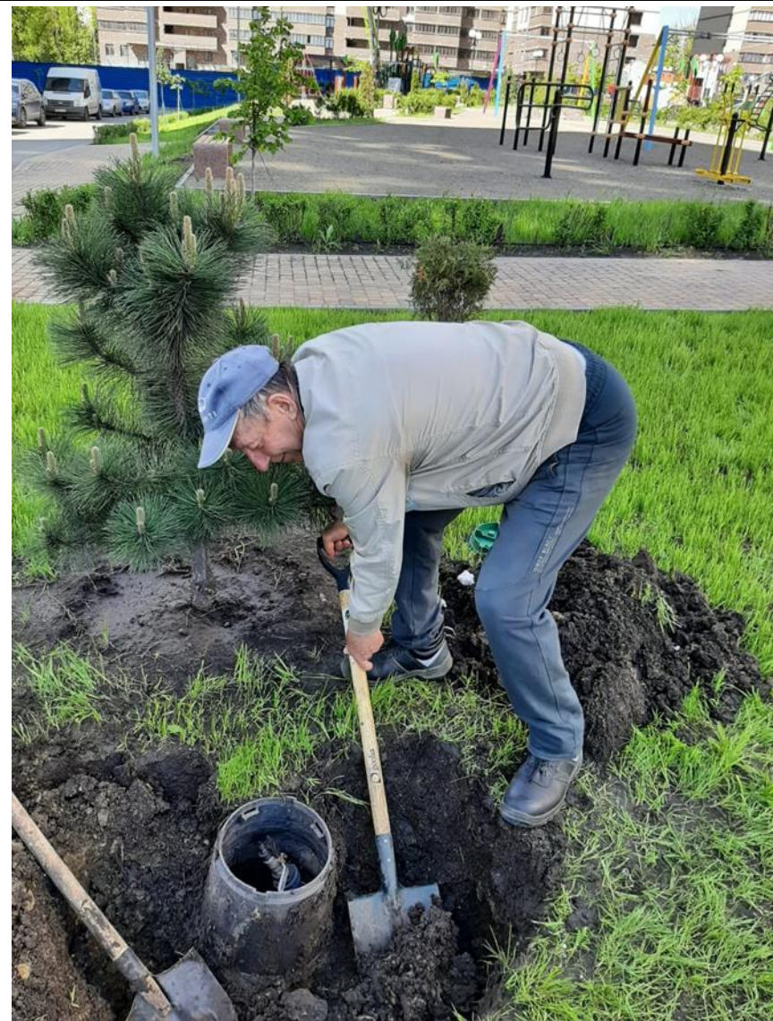
Ремонт лючка автополива
