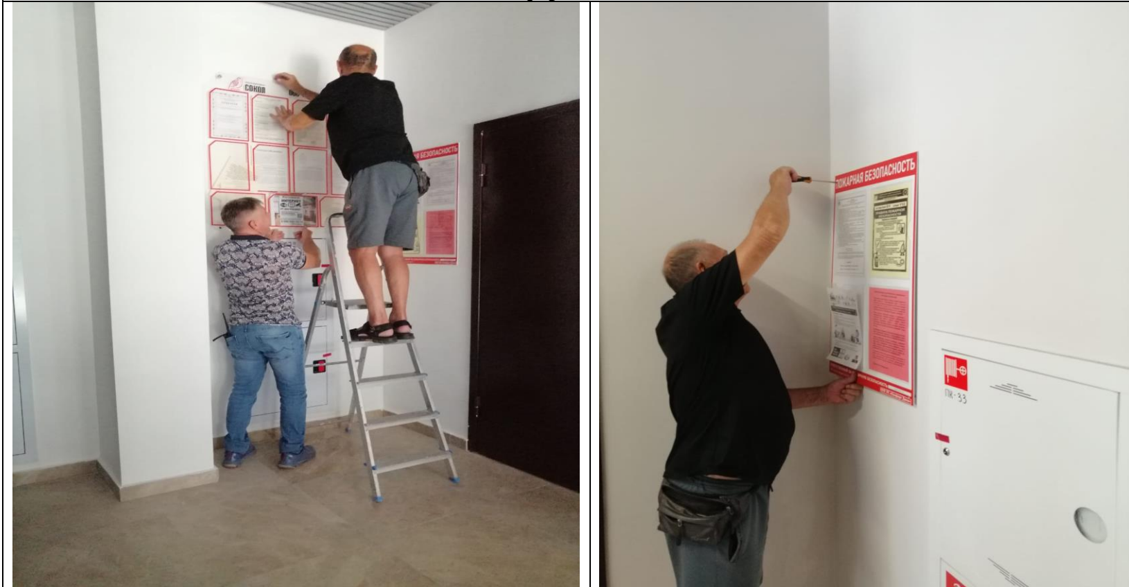
Установка информационных стендов
