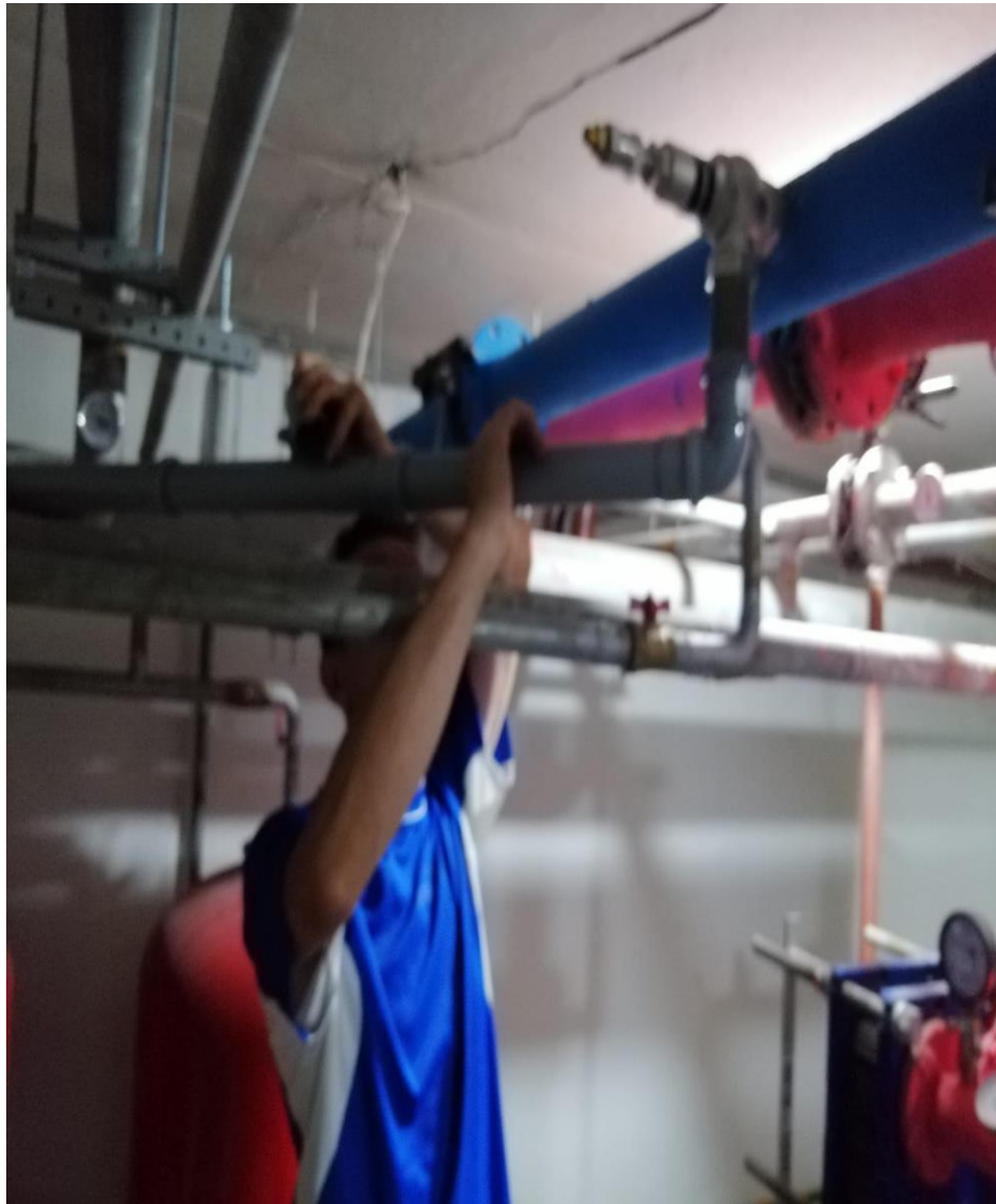
Монтаж водоотведения сбросного клапана отопления в ИТП
