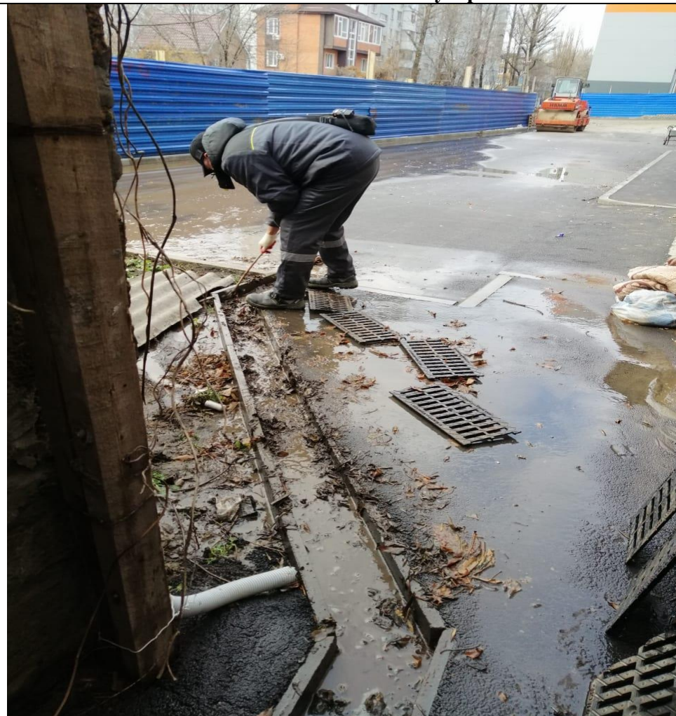
Очистка ливневок от мусора
