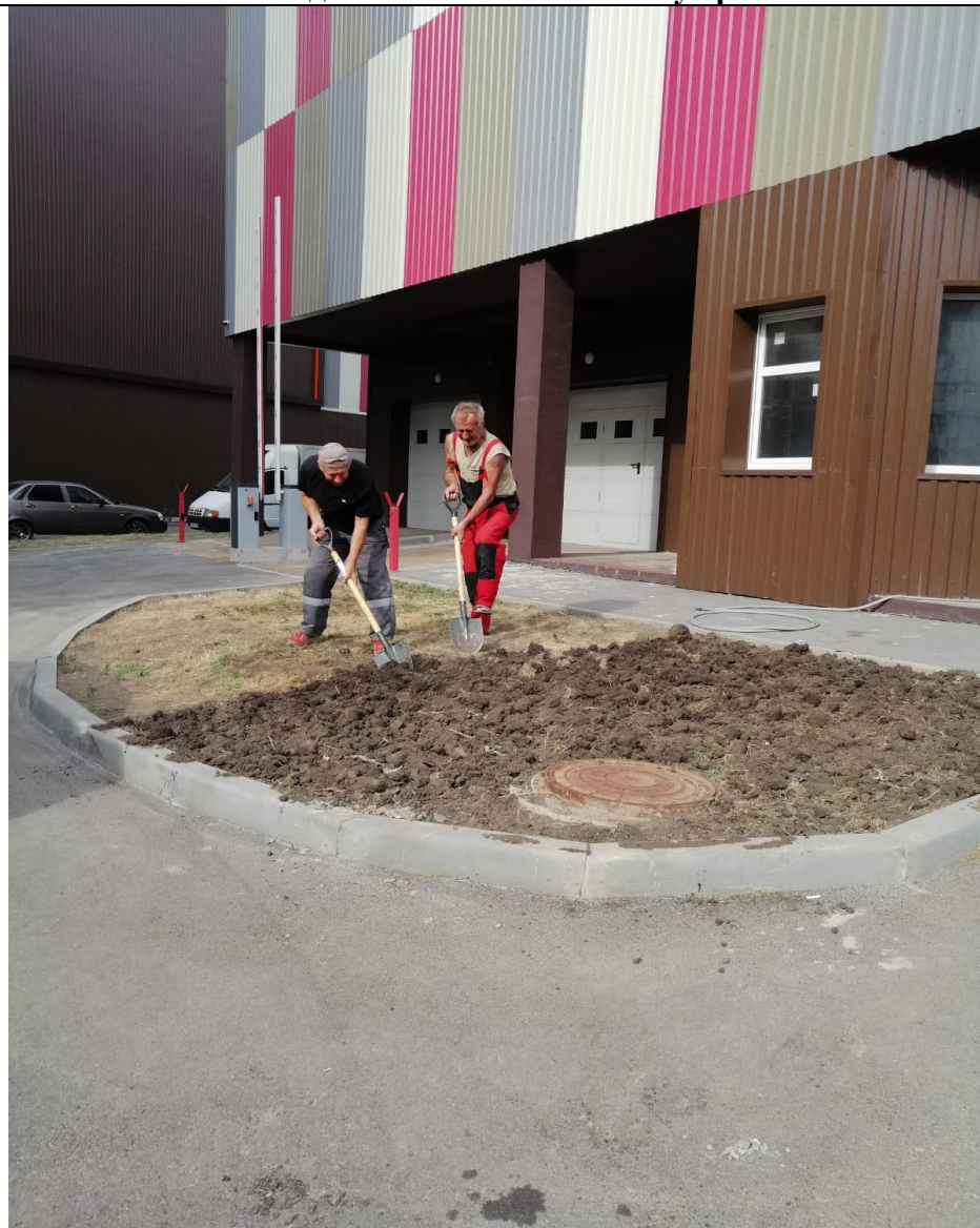
Подготовка газона к посеву травы
