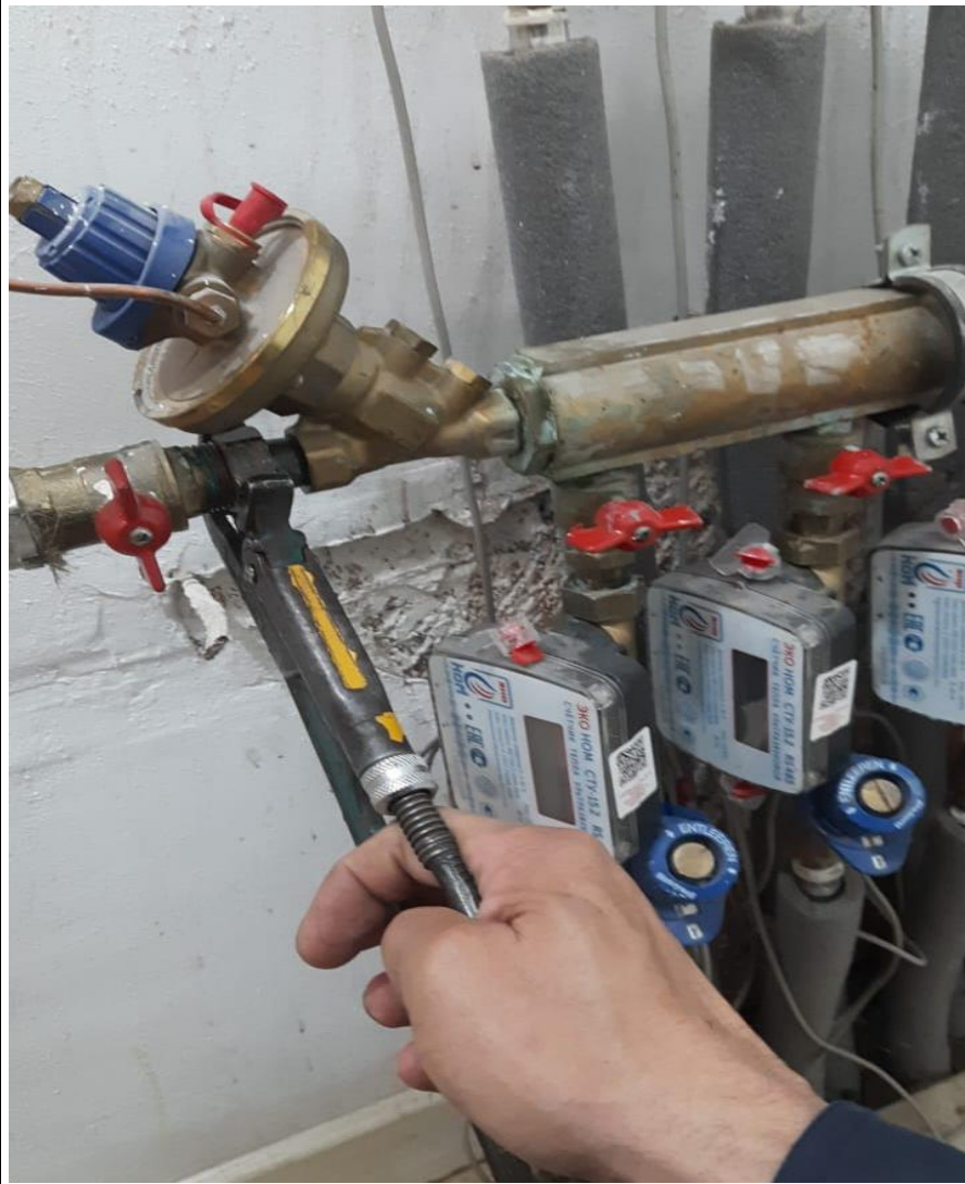
Замена крана в коллекторной
