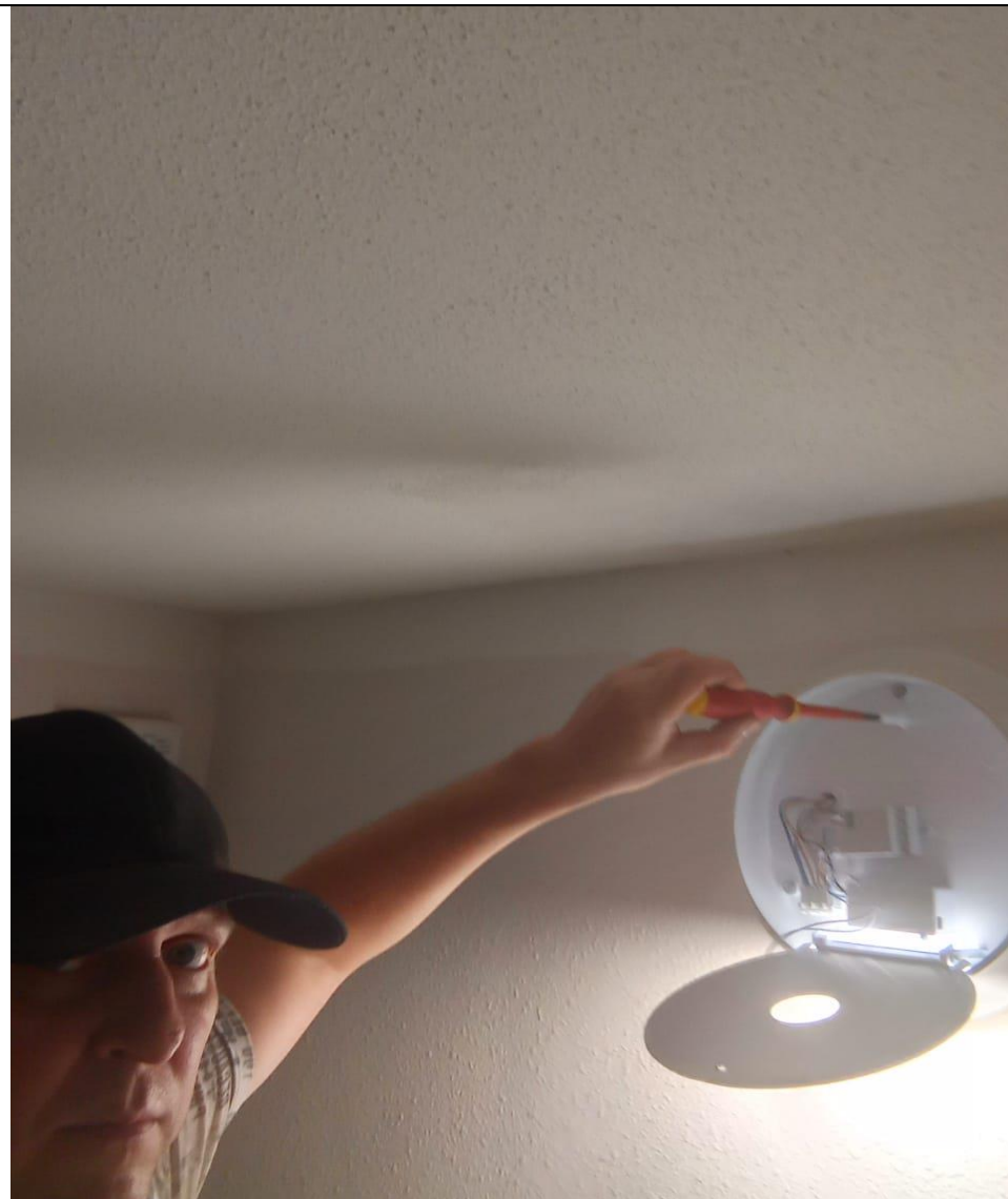
Ремонт светильника в МОП
