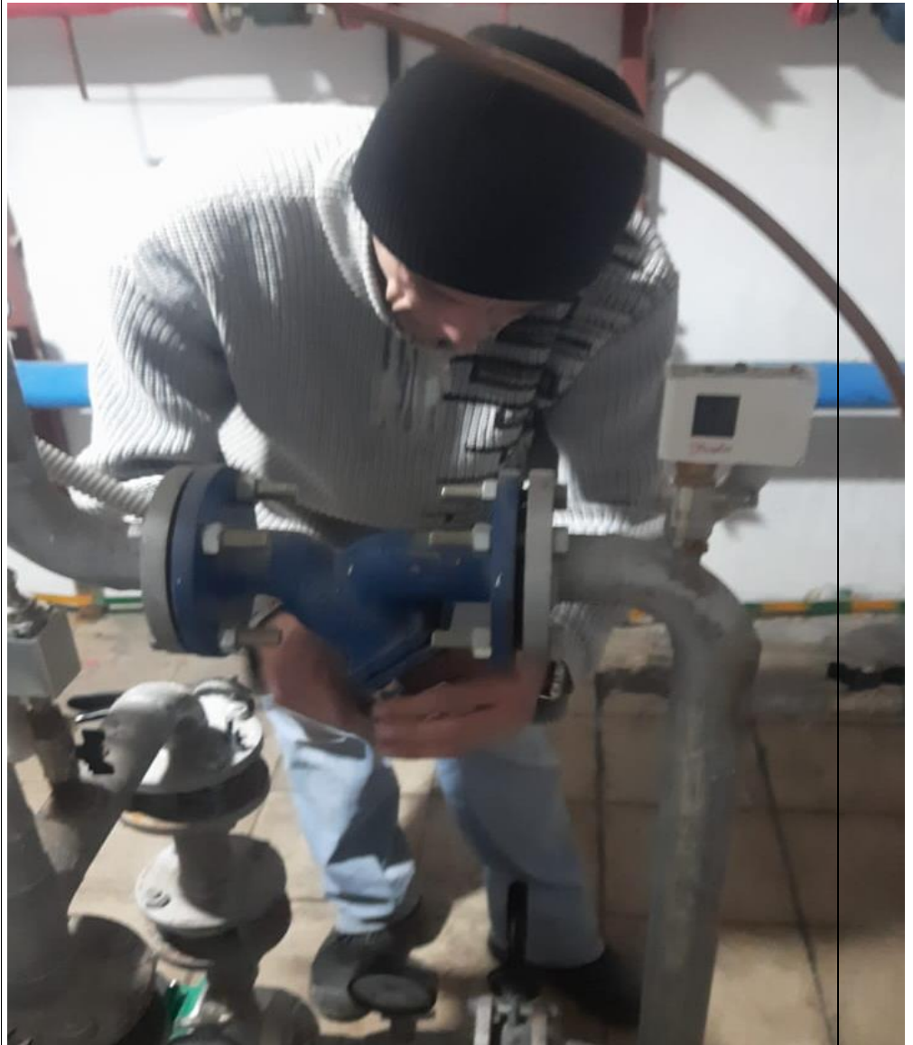
Прочистка фильтров ГВС
