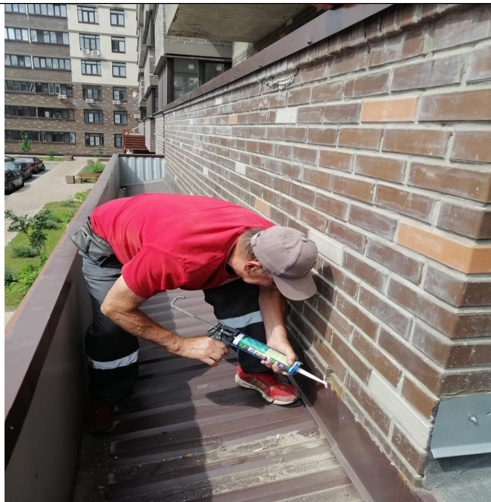
Ремонт козырька входной группы
