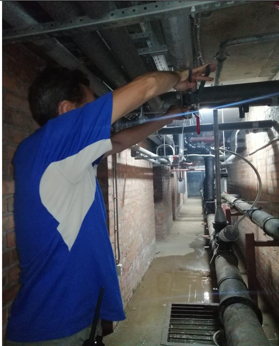
Ремонт труб водоснабжения в подвале
