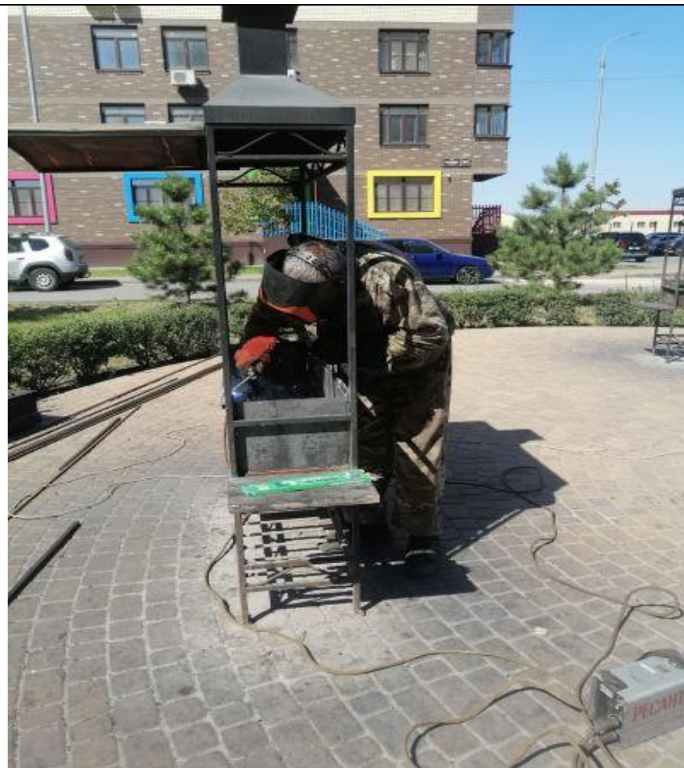
Ремонт мангальной зоны
