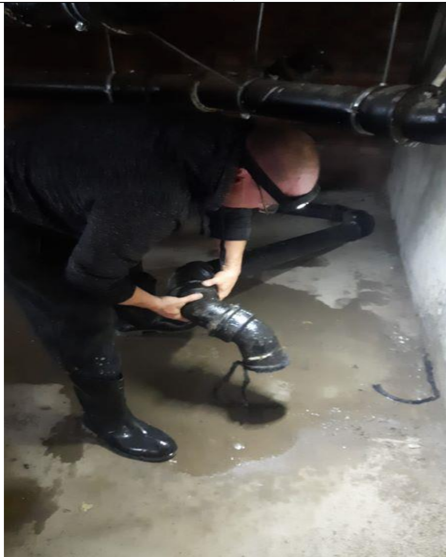
Замена канализационного лежака
