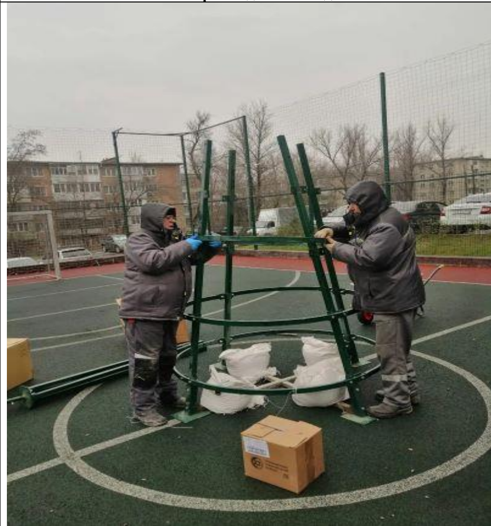
Установка каркаса для новогодней ёлки
