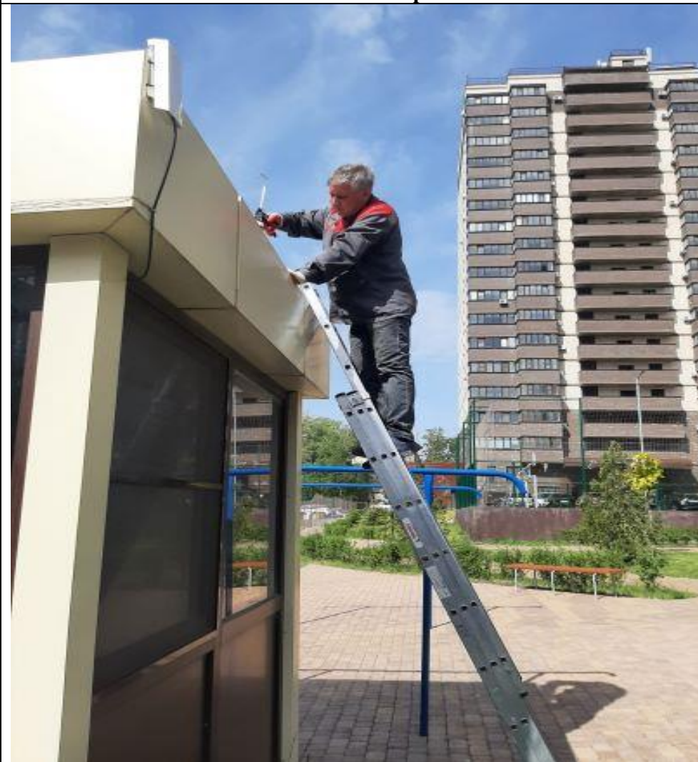
Ремонт поста охраны
