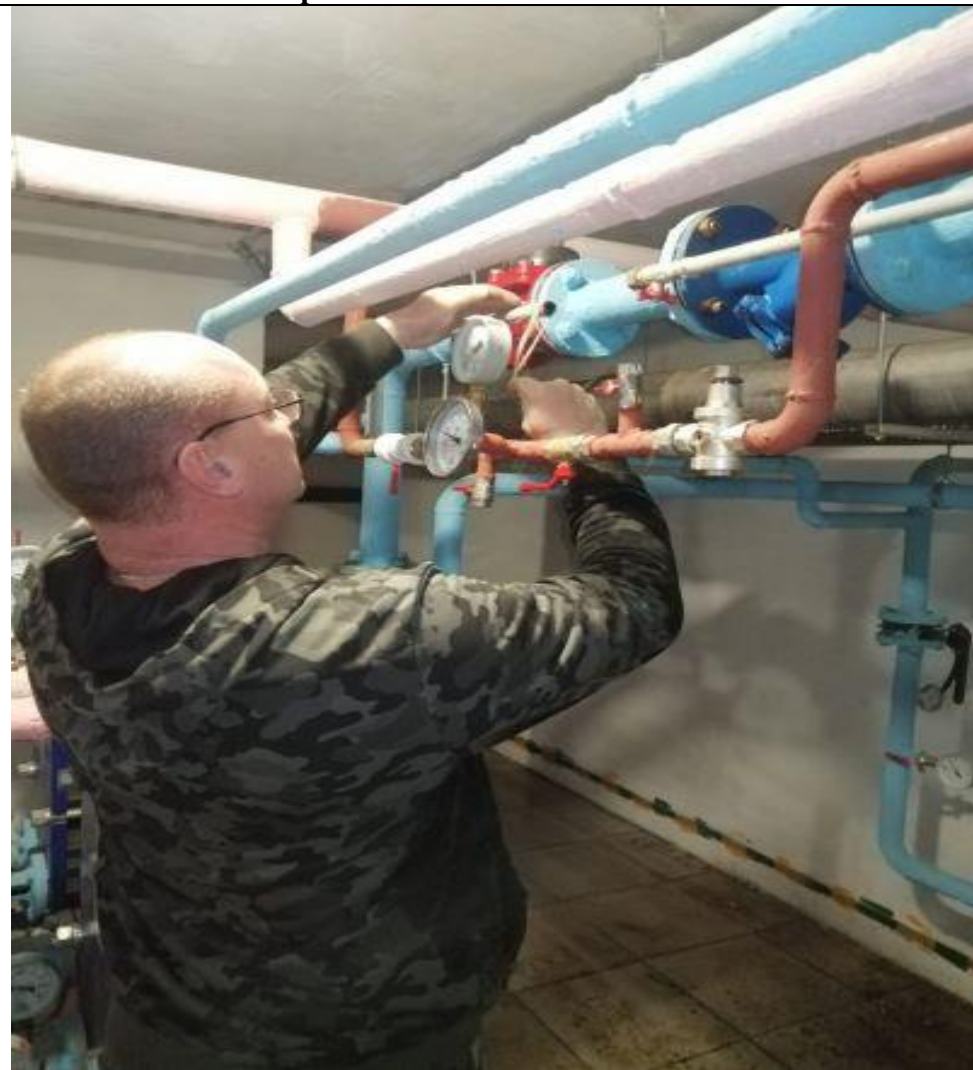
Ремонт обратного клапана системы отопления
