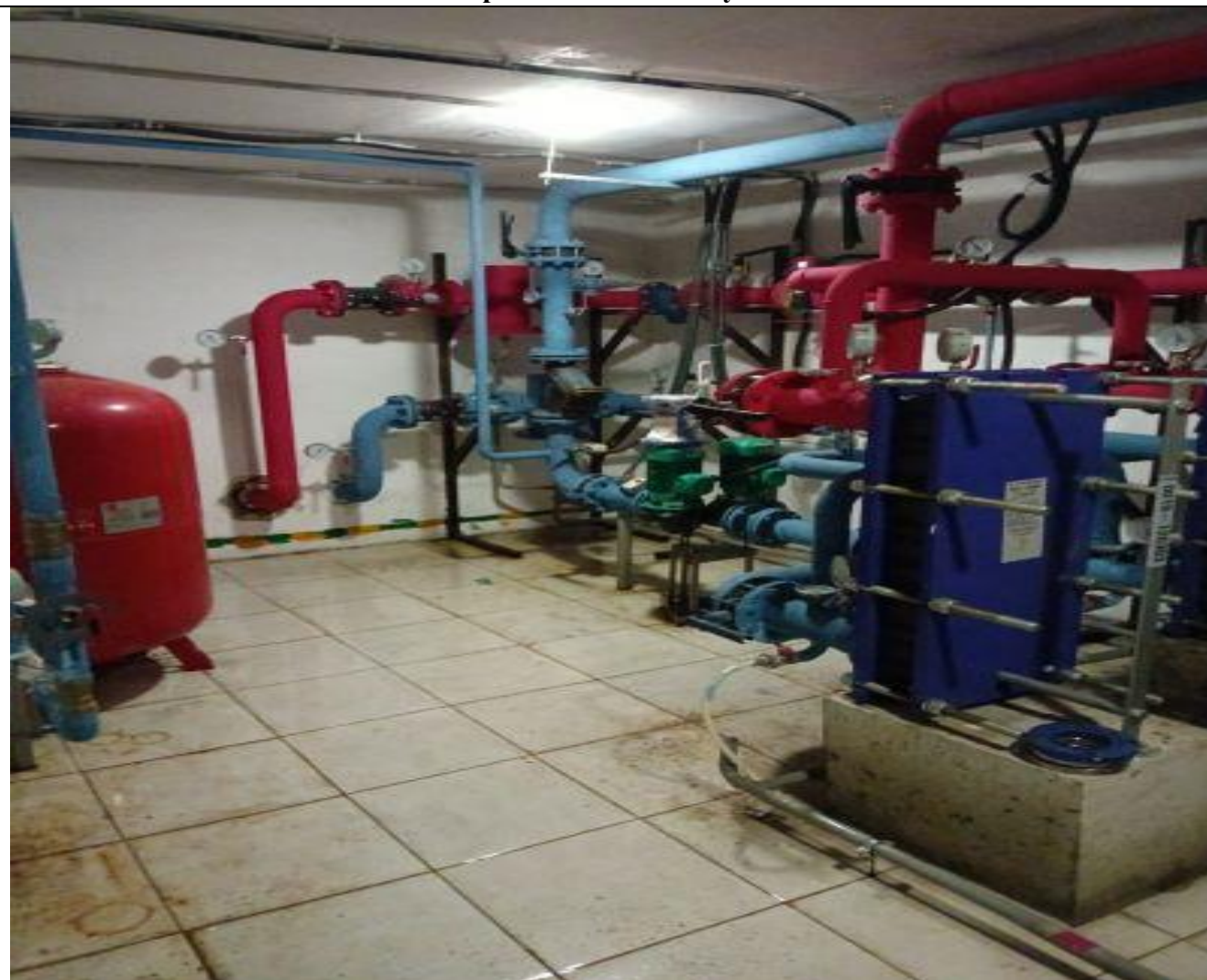
Покраска теплового пункта
