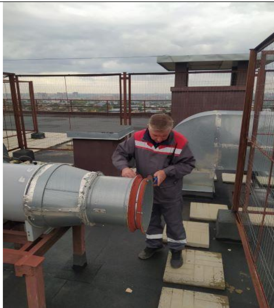
Крепление защитной решетки вентиляционного оборудования
