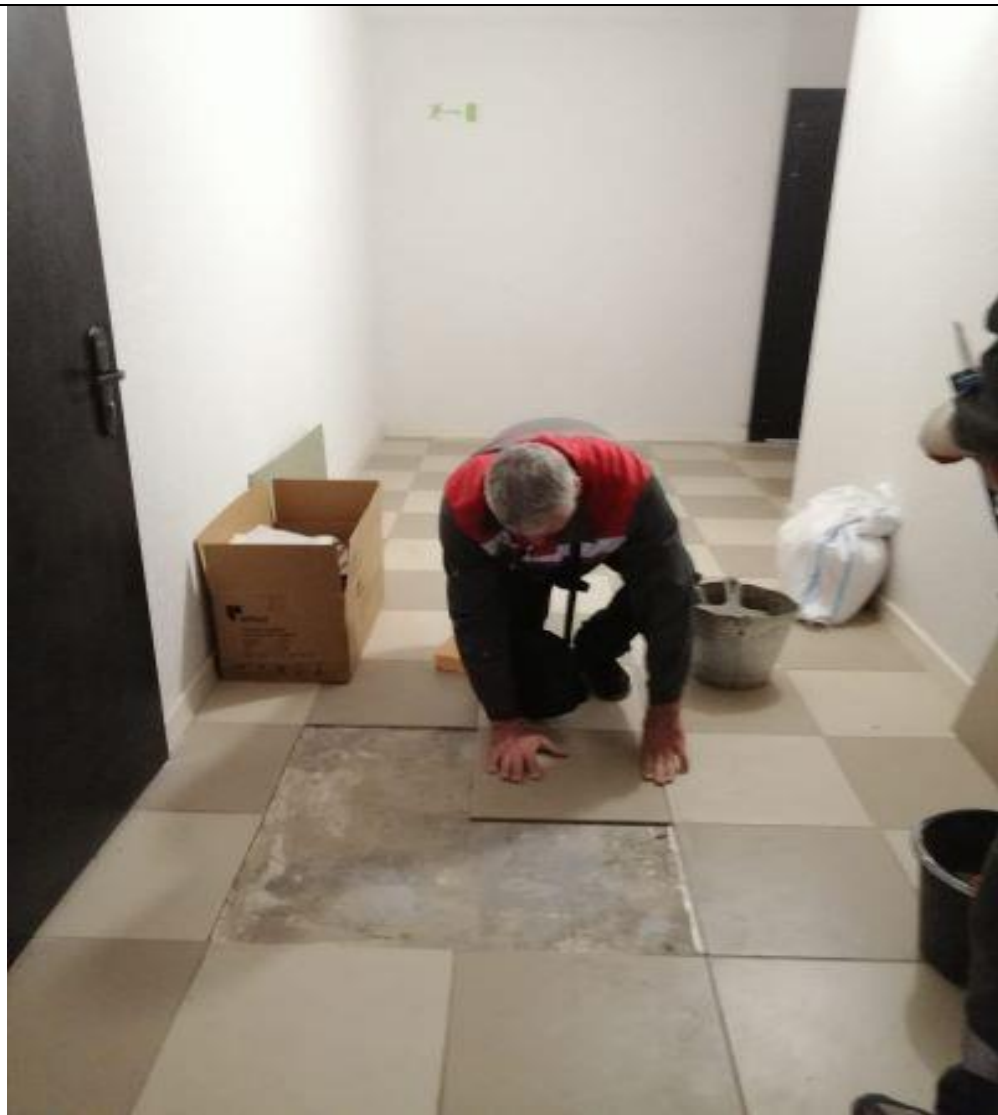
Замена плитки в МОП
