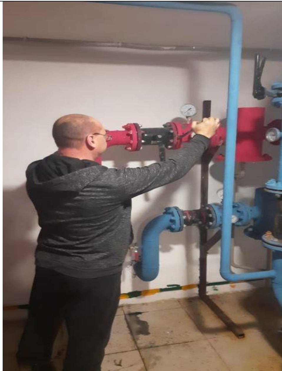
Замена вводной задвижки
