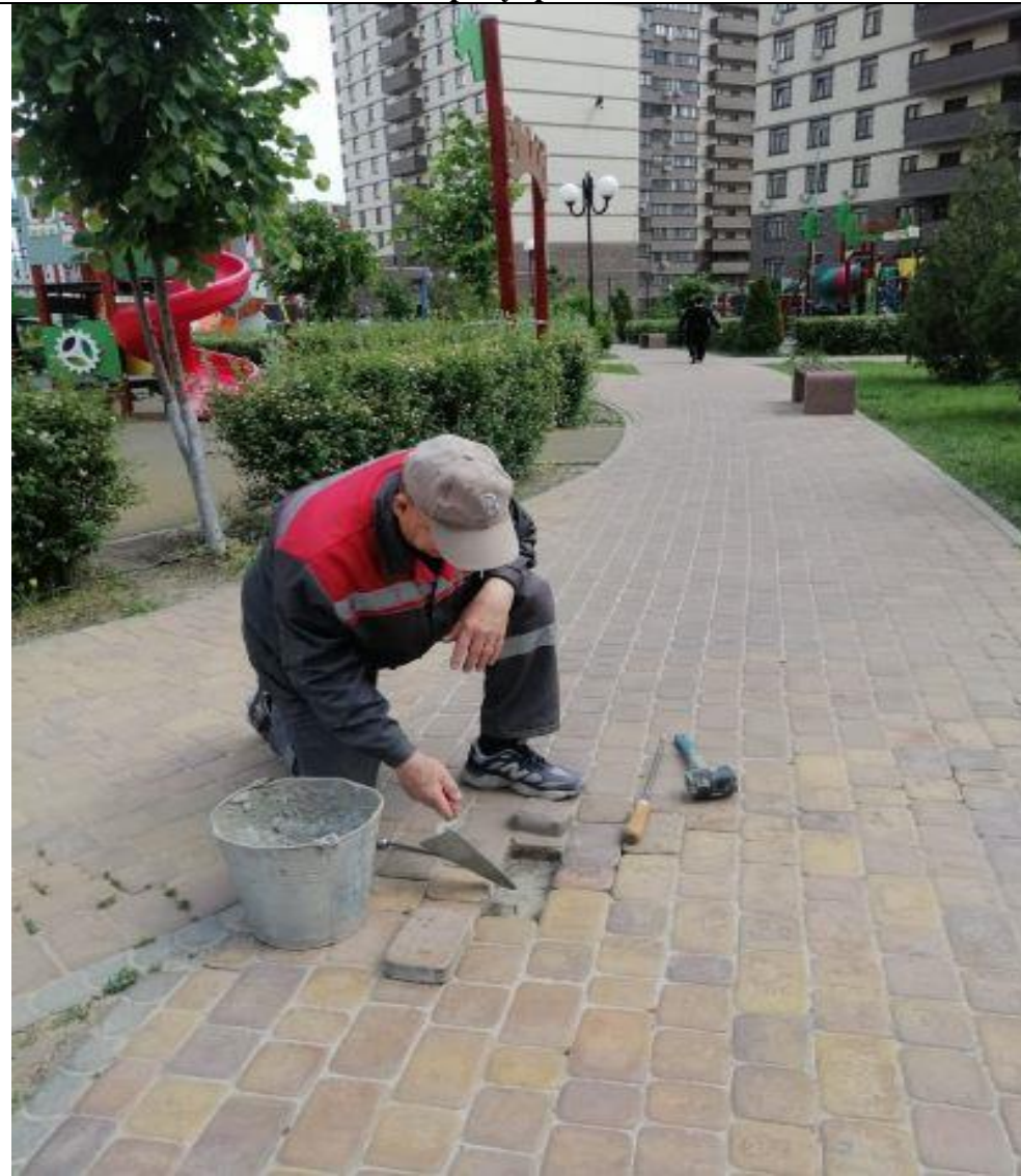
Ремонт тротуарной плитки
