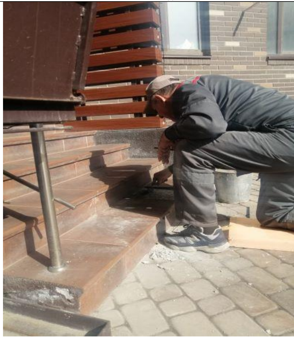
Замена плитки входной зоны
