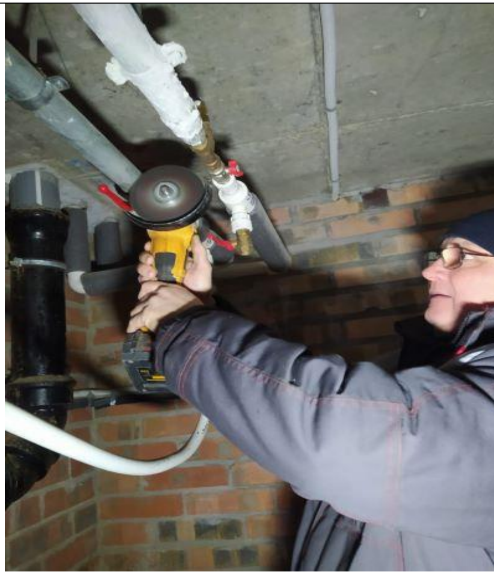
Установка Геббо на стояке ГВС
