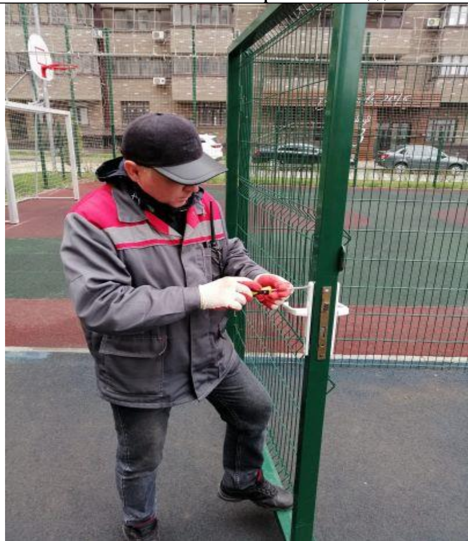
Ремонт замка калитки спортивной площадки
