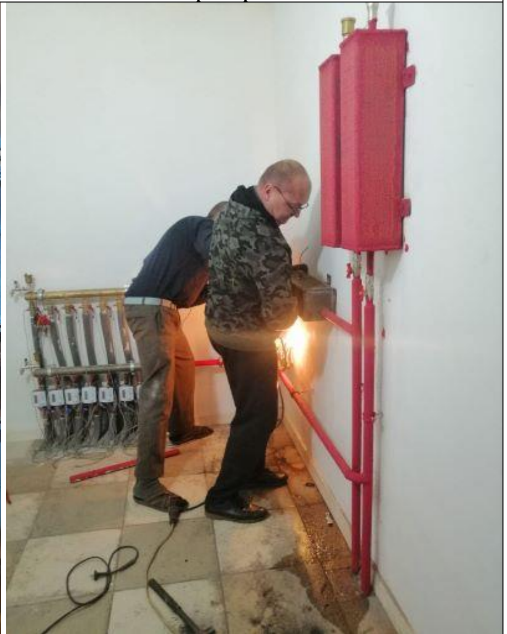
Монтаж расширительных баков
