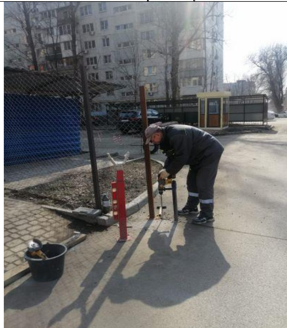
Установка опоры шлагбаума
