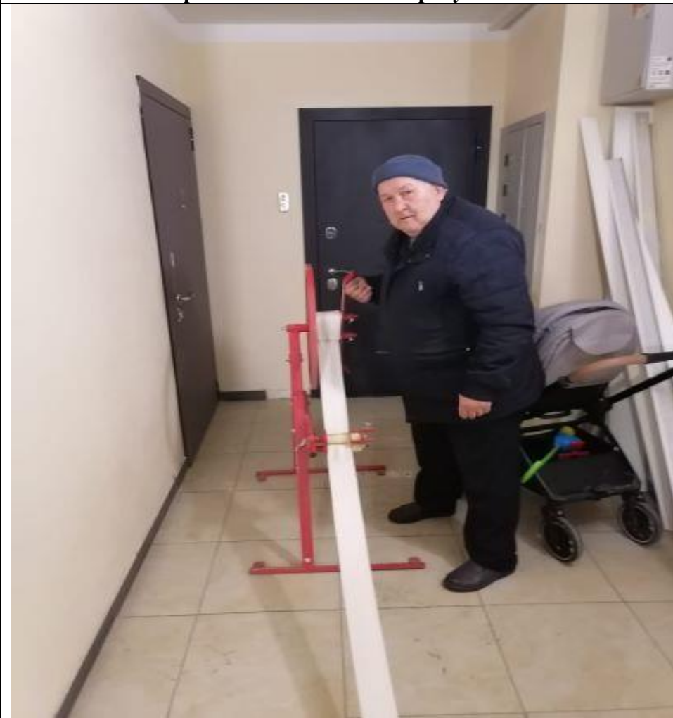
Перекатка шлангов пожаротушения
