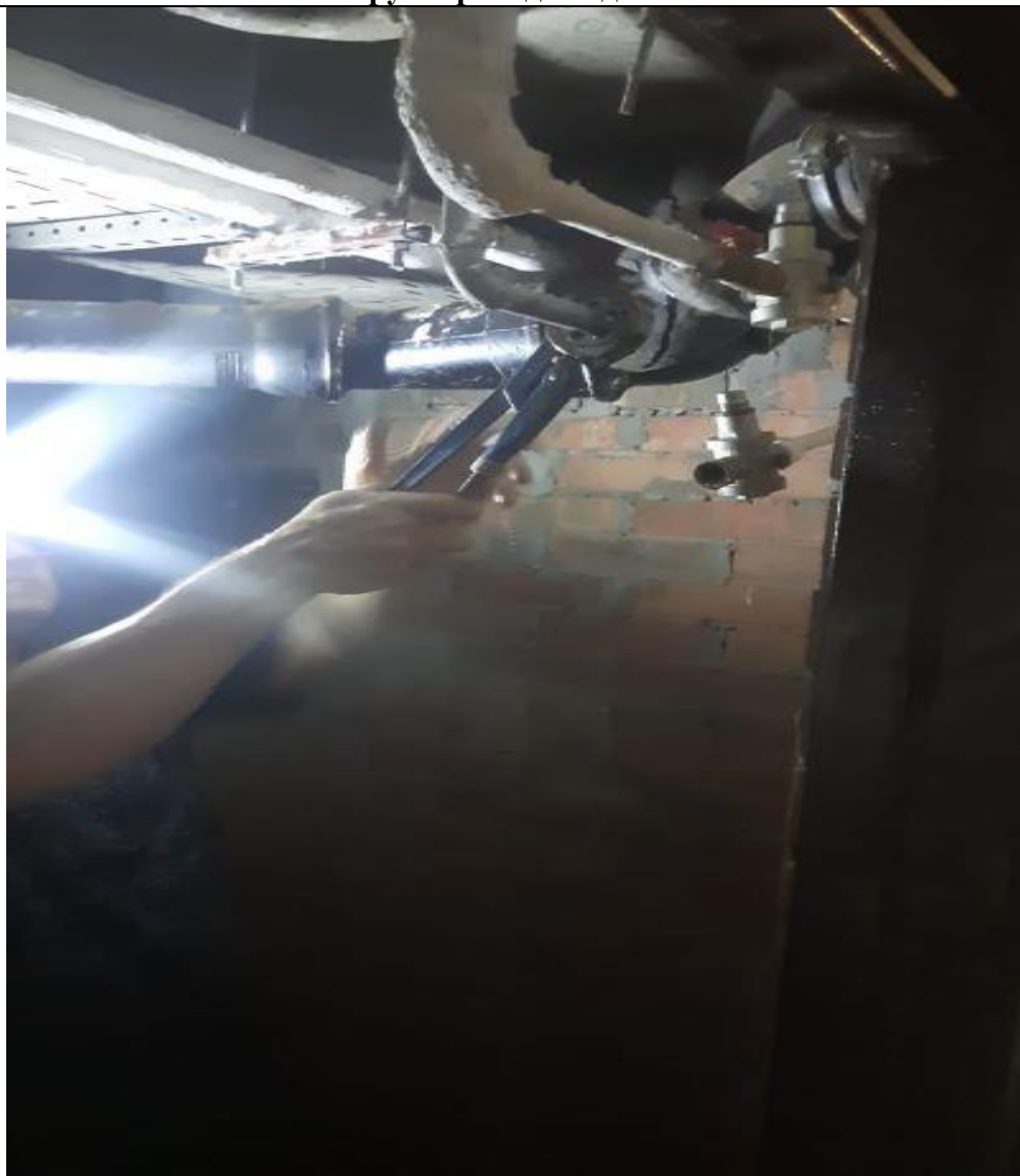
Ремонт трубопровода водоснабжения
