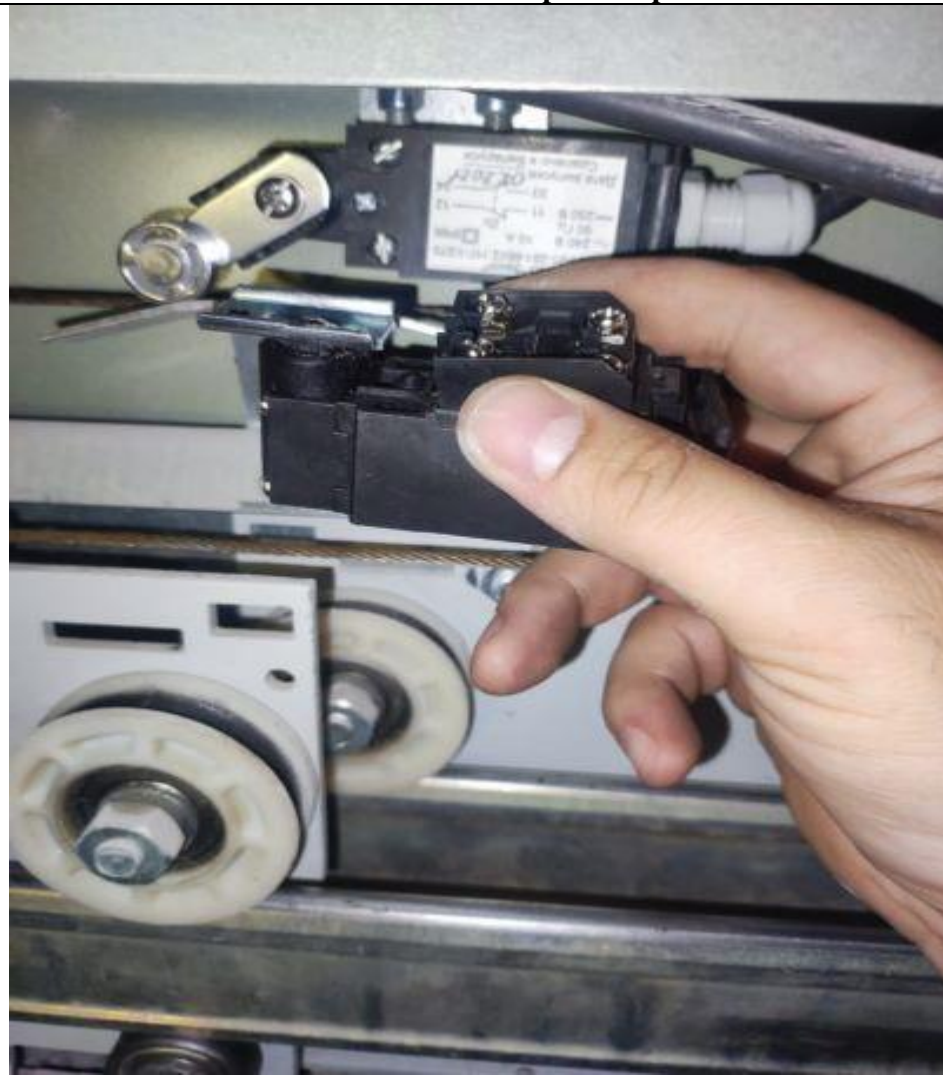
Замена концевого резистора
