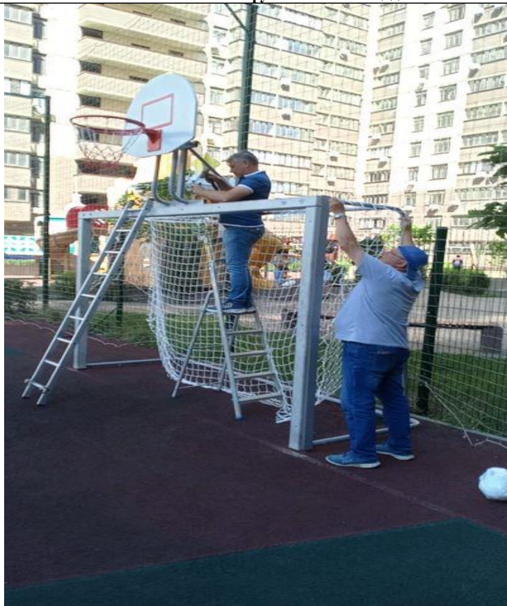
Установка сетки на футбольной площадке
