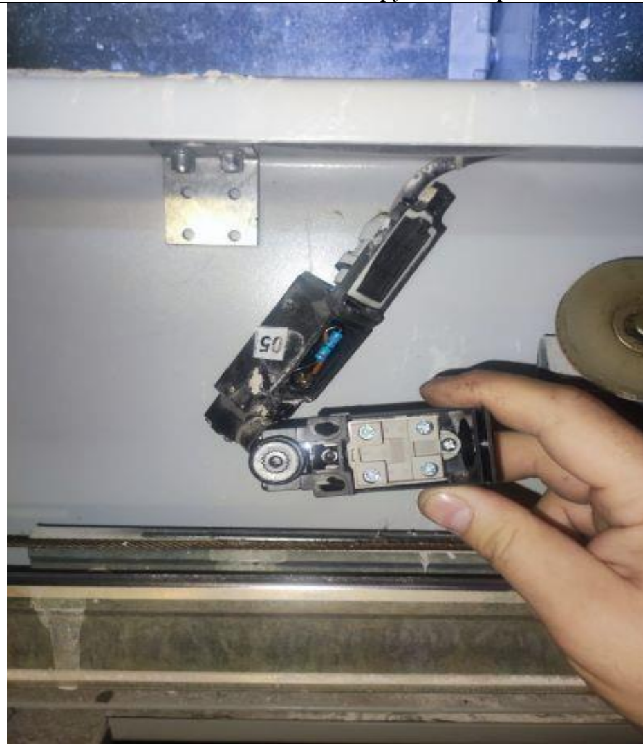
Замена выключателя в грузовом лифте
