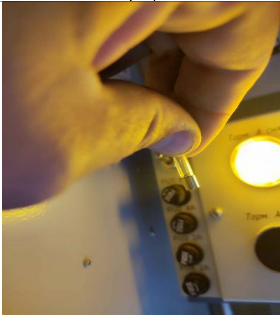
Замена предохранителя
