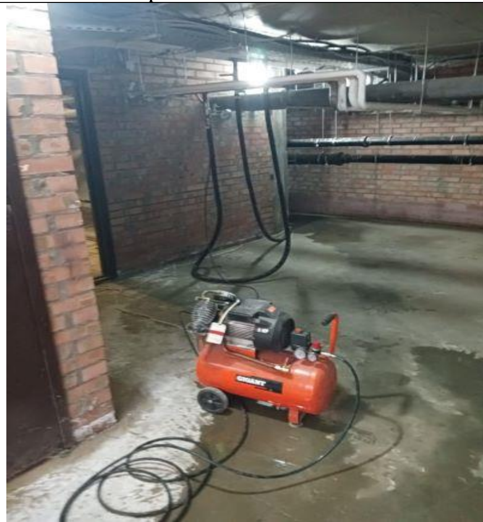
Промывка системы отопления
