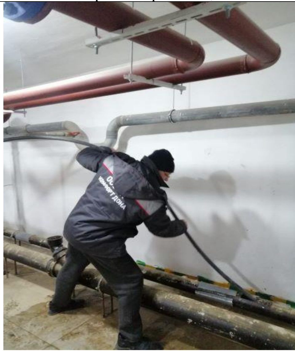
Устранение засора канализации
