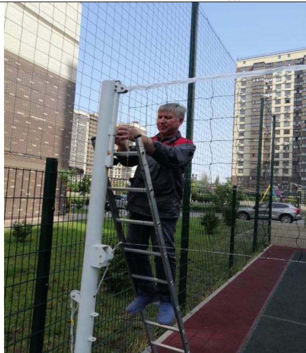
Замена сетки на волейбольной площадке
