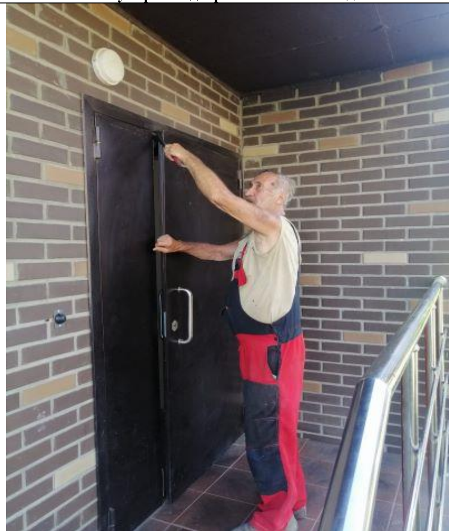
Регулировка двери запасного выхода
