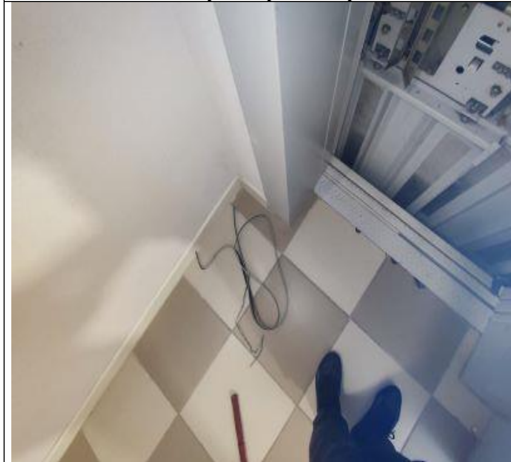
Замена ремня привода дверей
