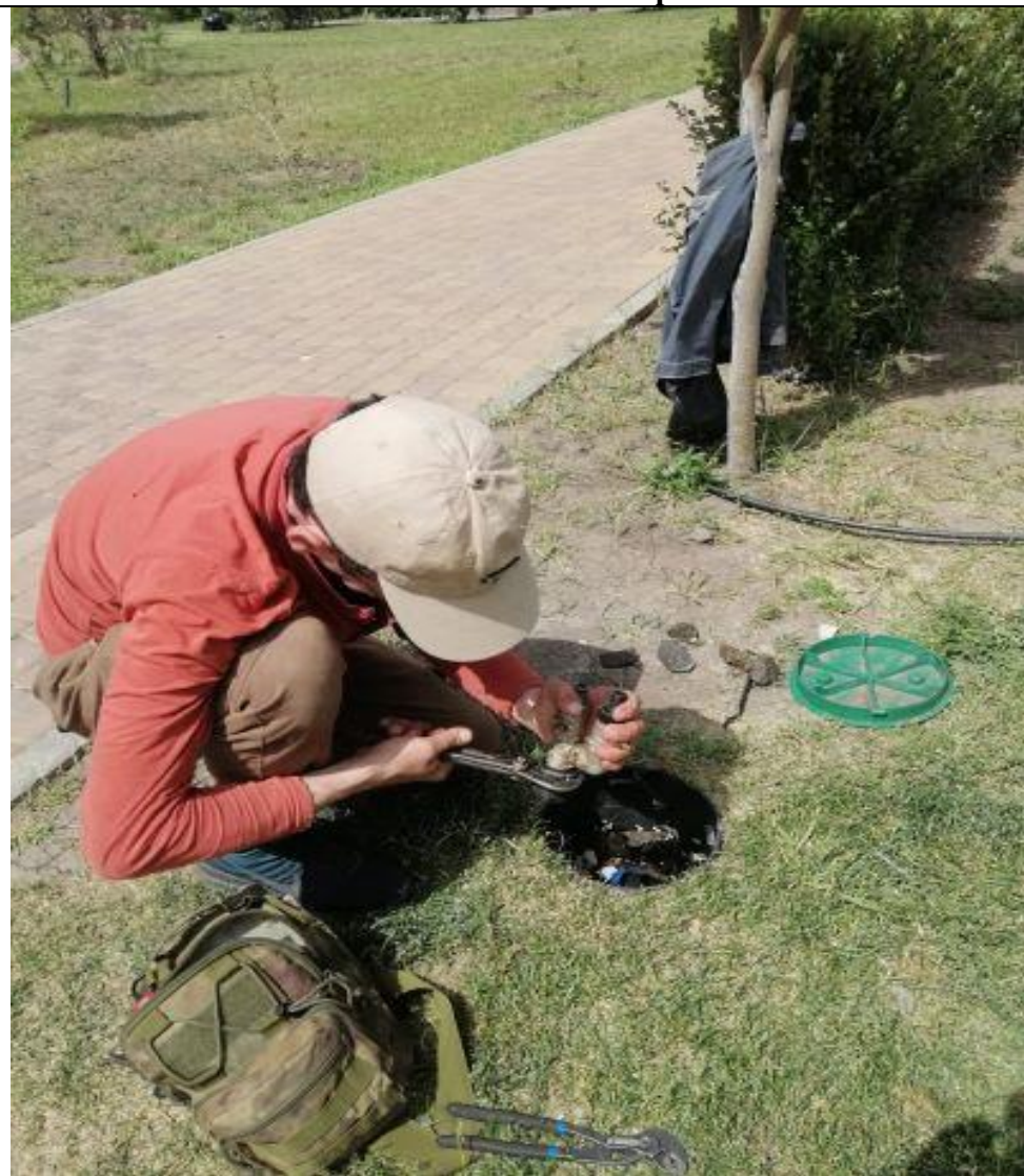
Замена поливочного крана
