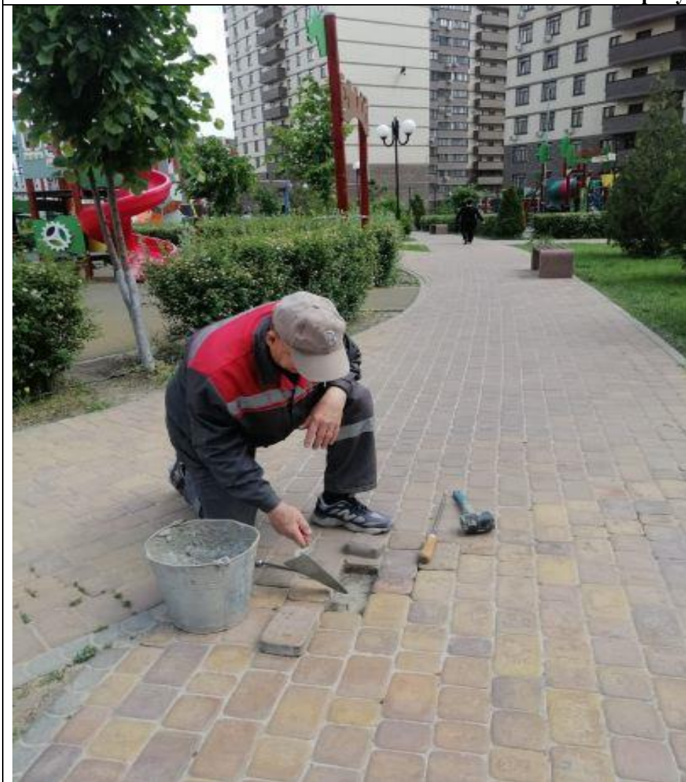
Ремонт тротуарной плитки
