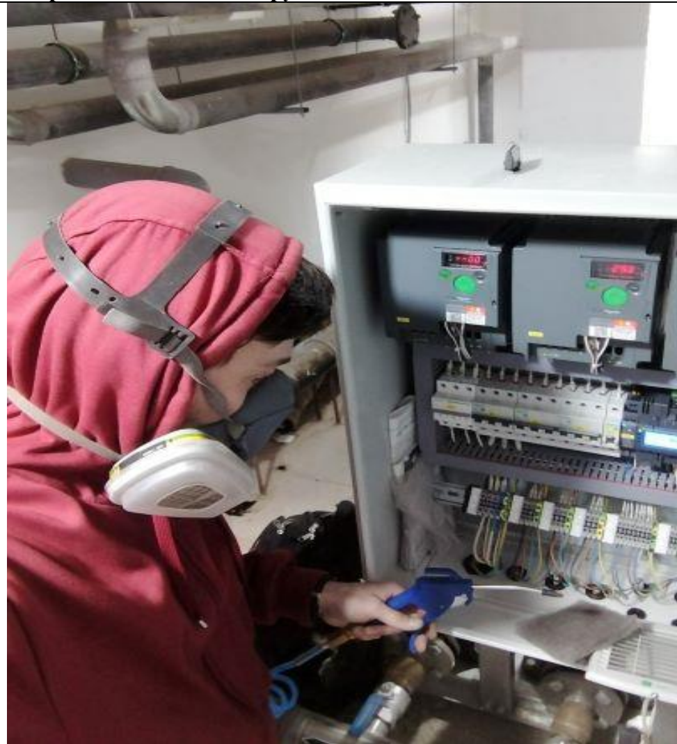
Прочистка от пыли оборудования водоснабжения в насосной
