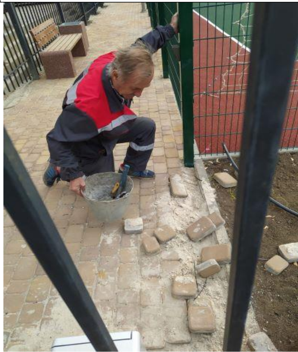
Ремонт тротуарной плитки
