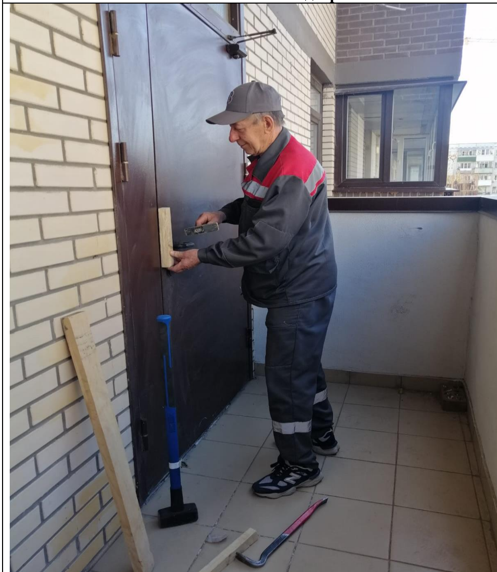
Ремонт балконной двери
