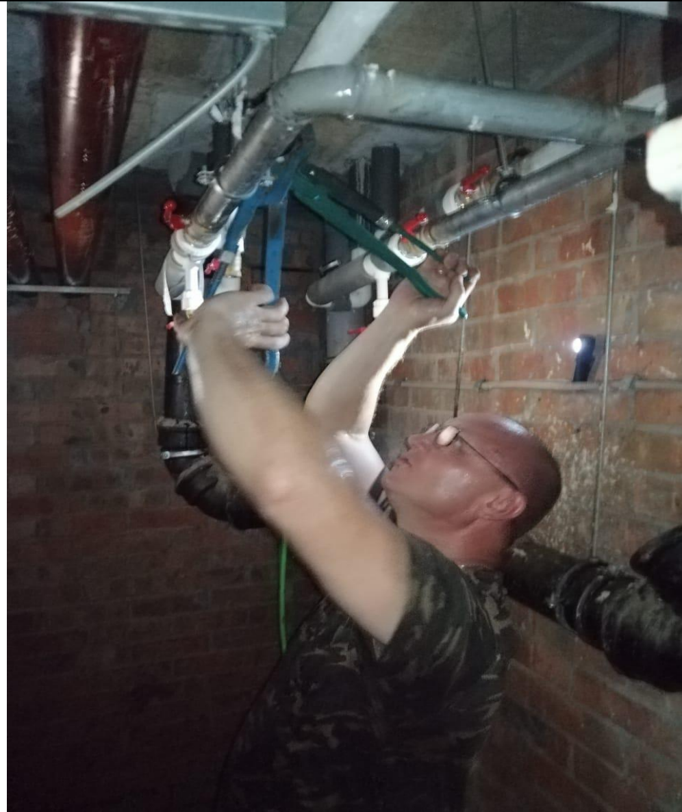
Ремонт стояка водоснабжения
