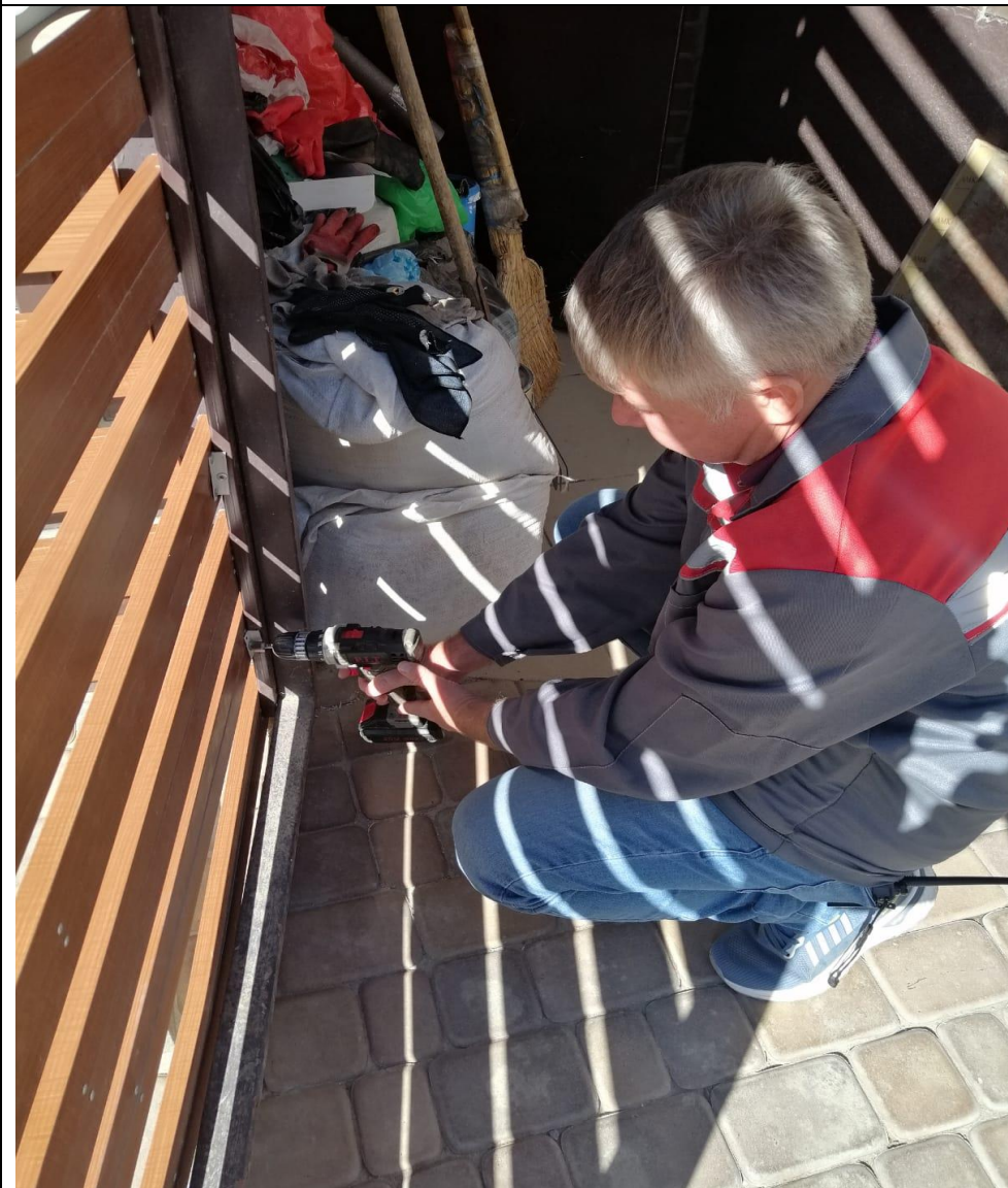
Ремонт декоративных панелей
