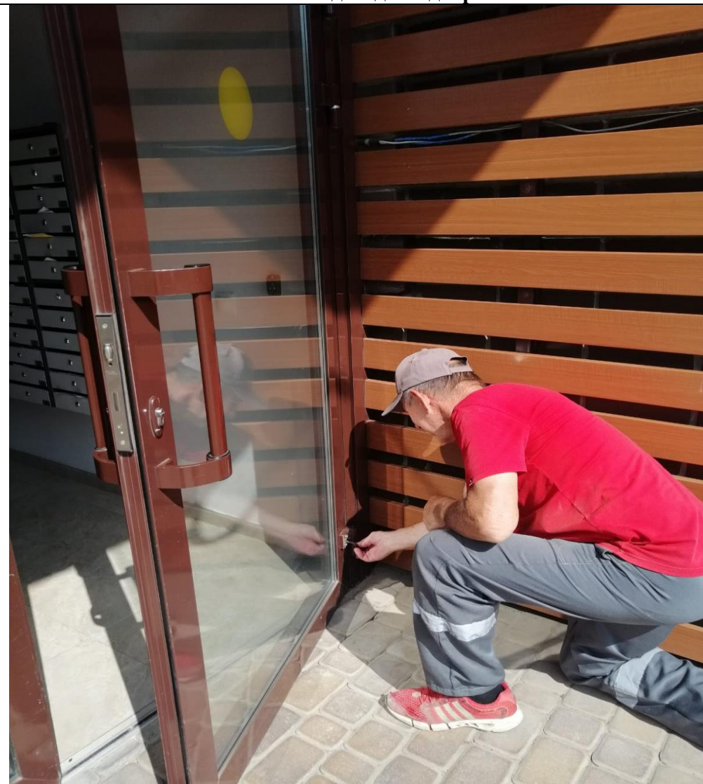
Ремонт подъездной двери
