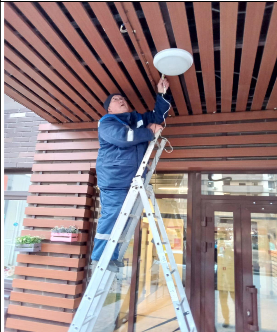
Замена светильника основного освещения МОП
