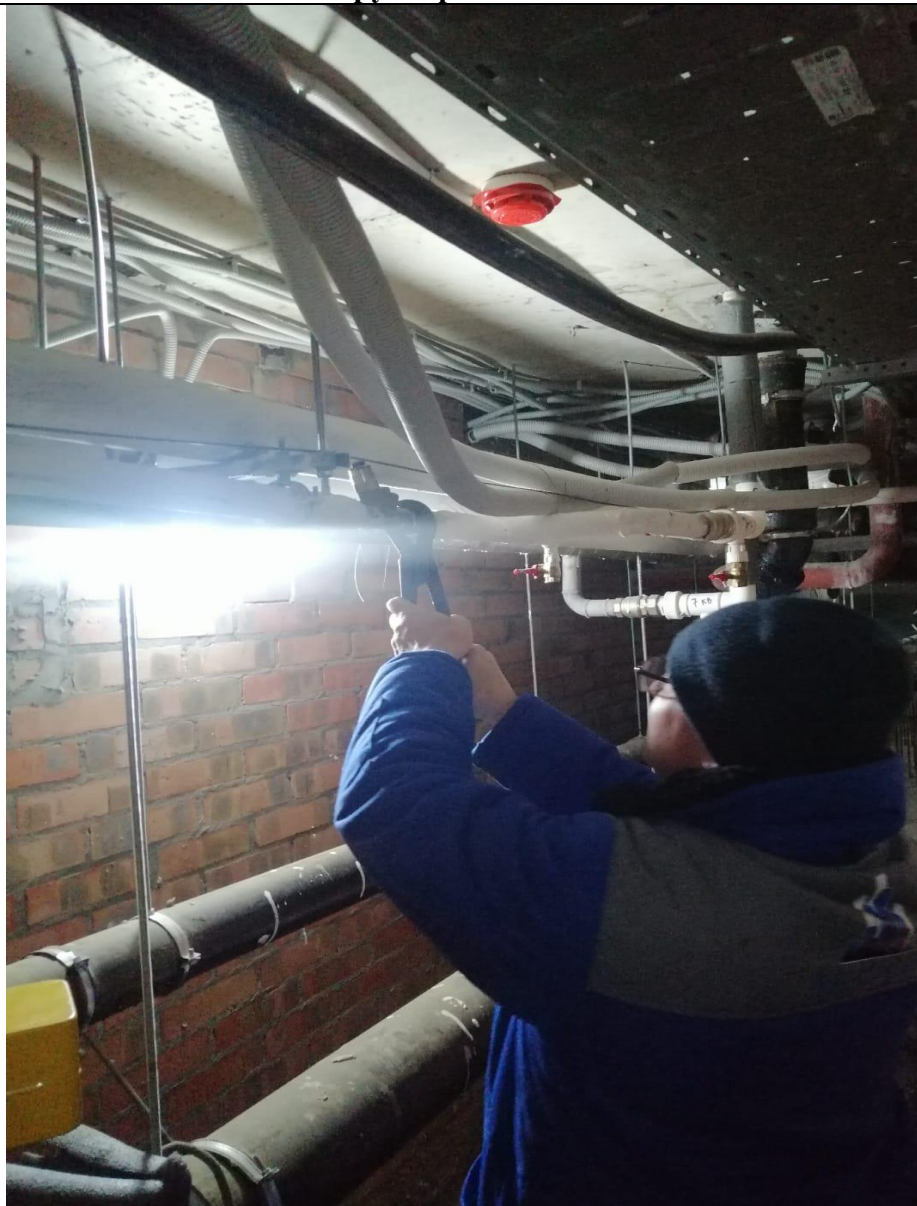
Ревизия трубопровода отопления
