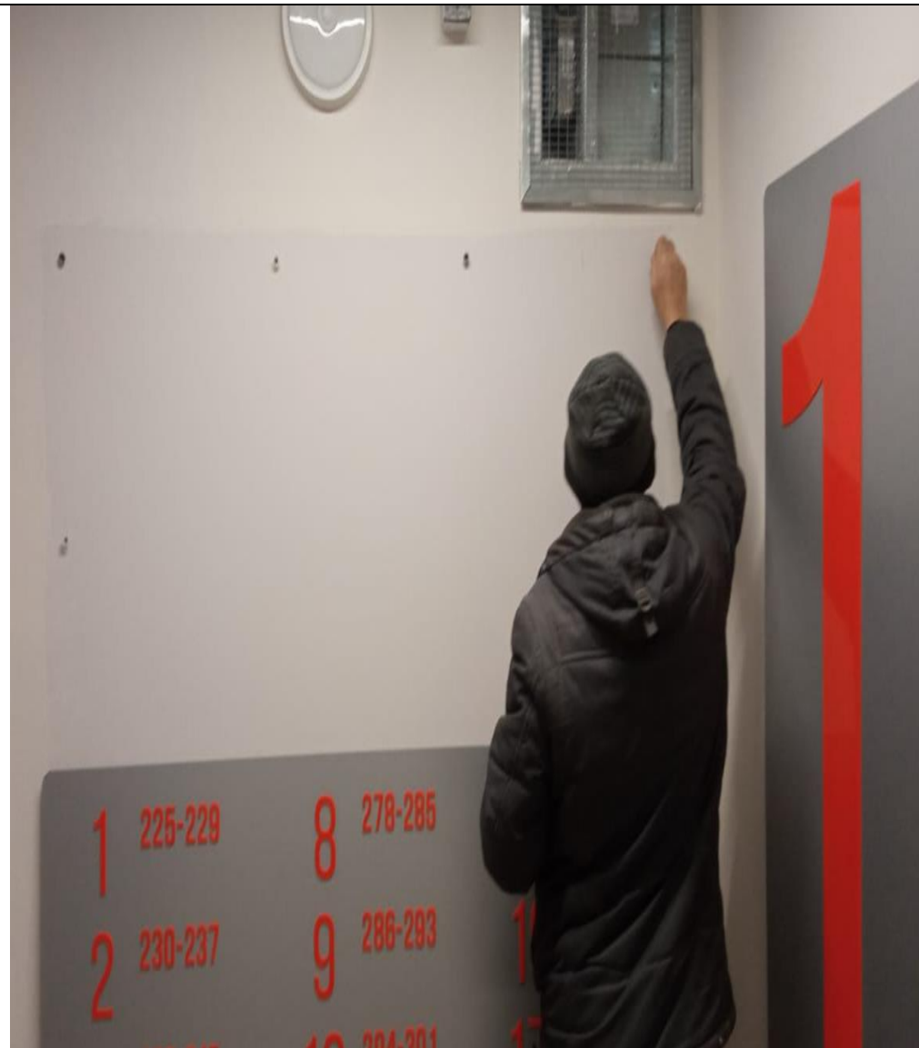
Ремонт поэтажного стенда
