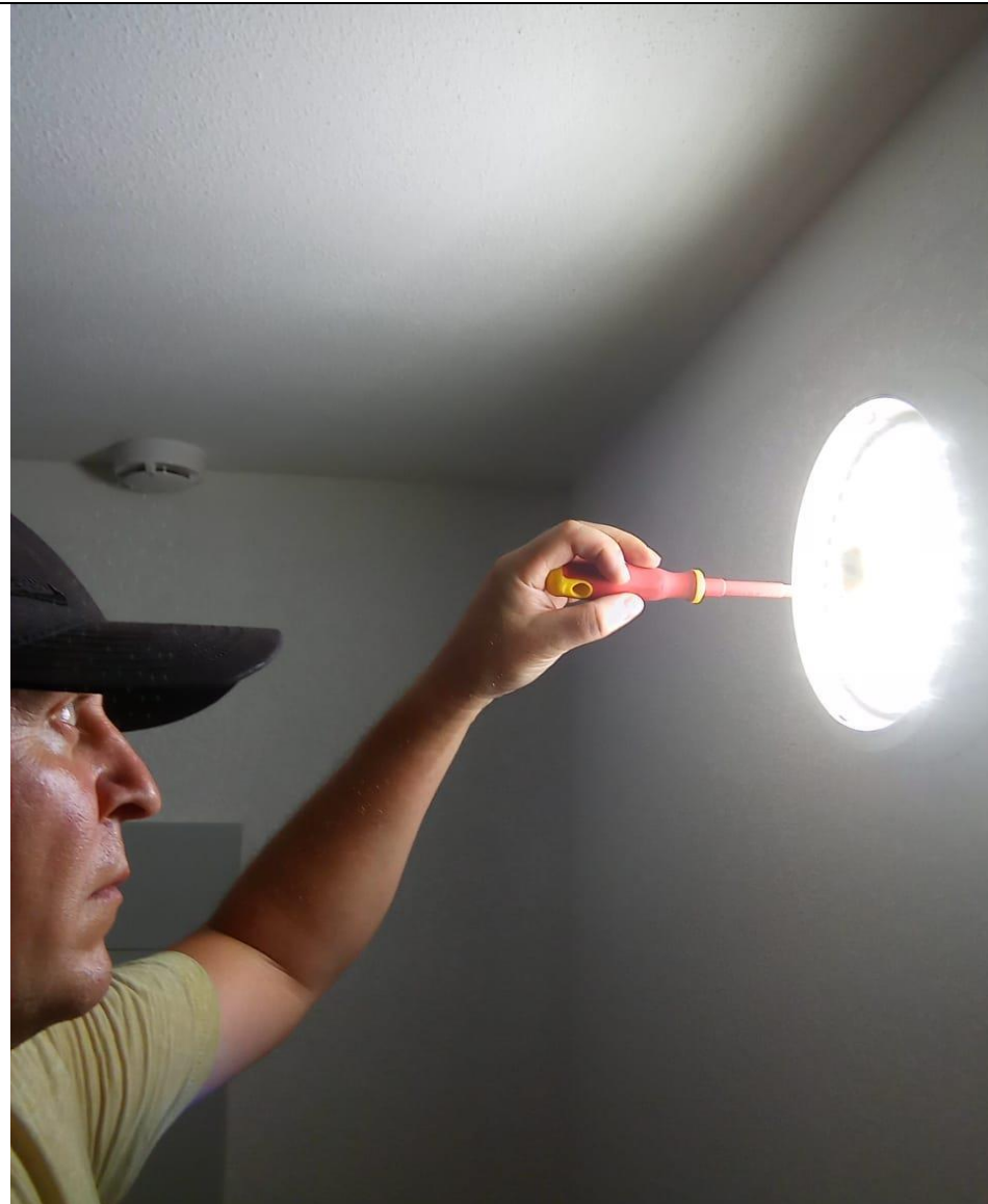
Замена светильника в местах общего пользования
