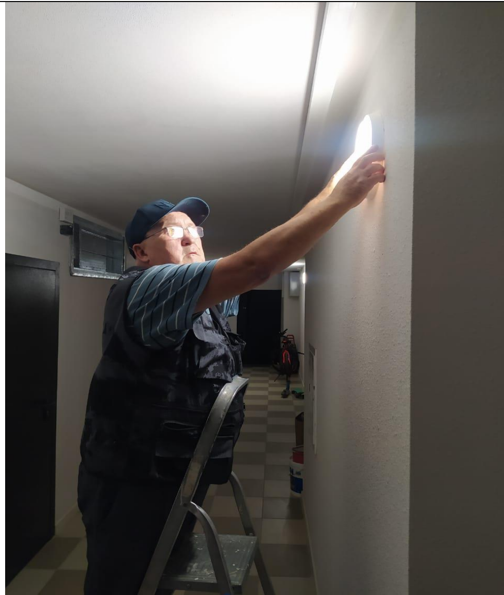
Ремонт светильника в местах общего пользования
