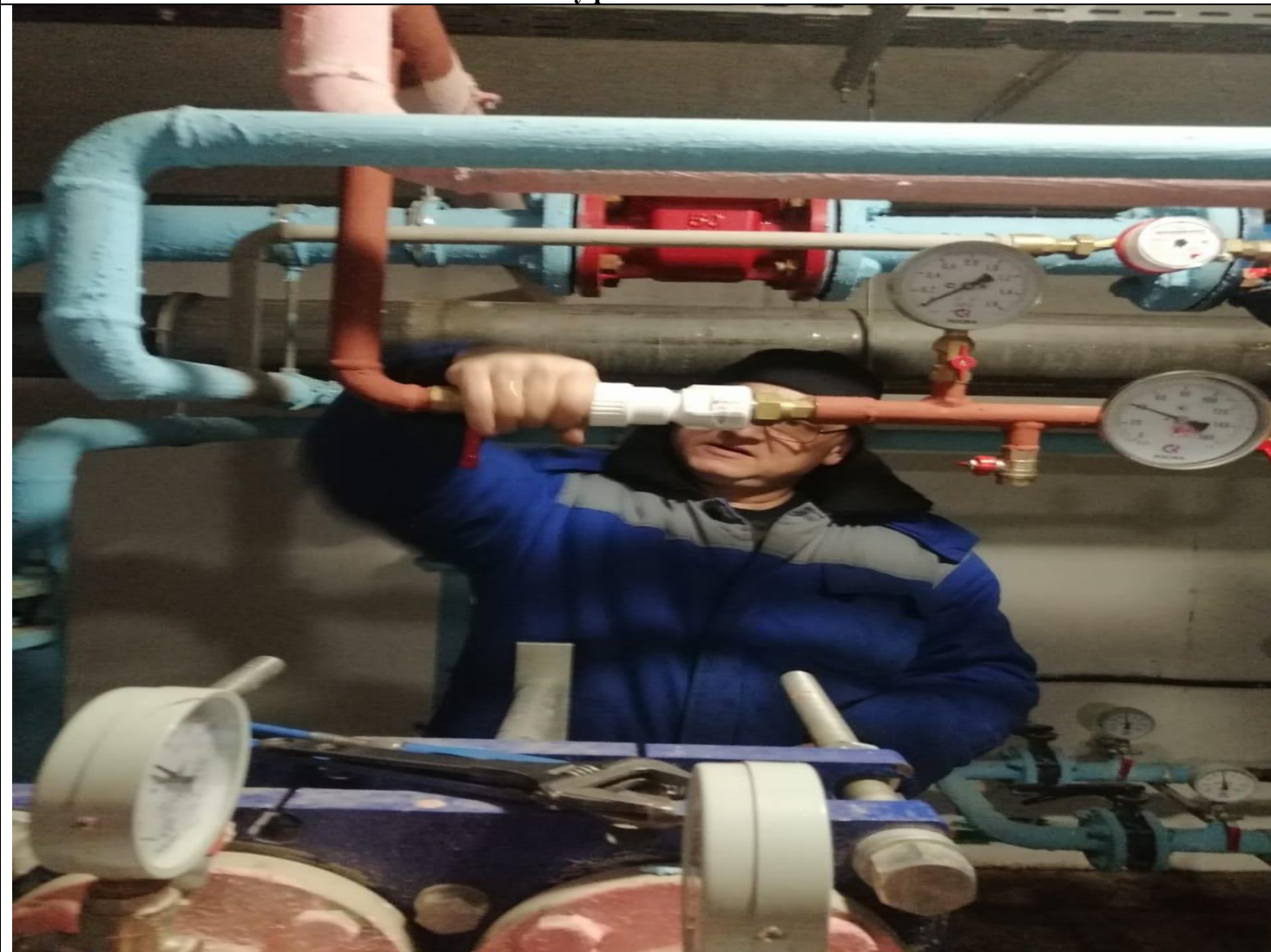
Замена муфты на стояке ГВС
