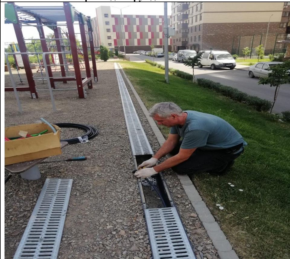
Прокладка труб для автополива
