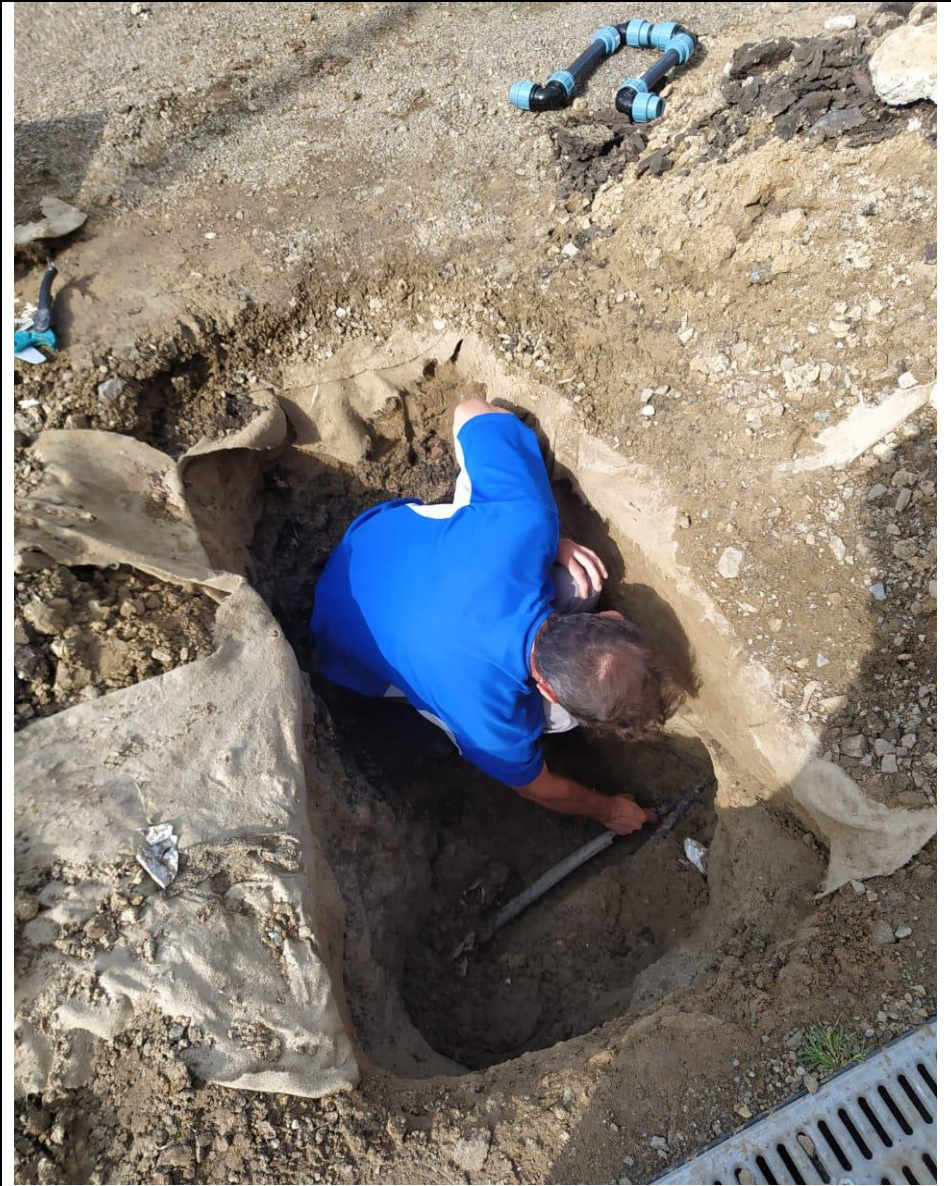
Ремонт трубы автополива
