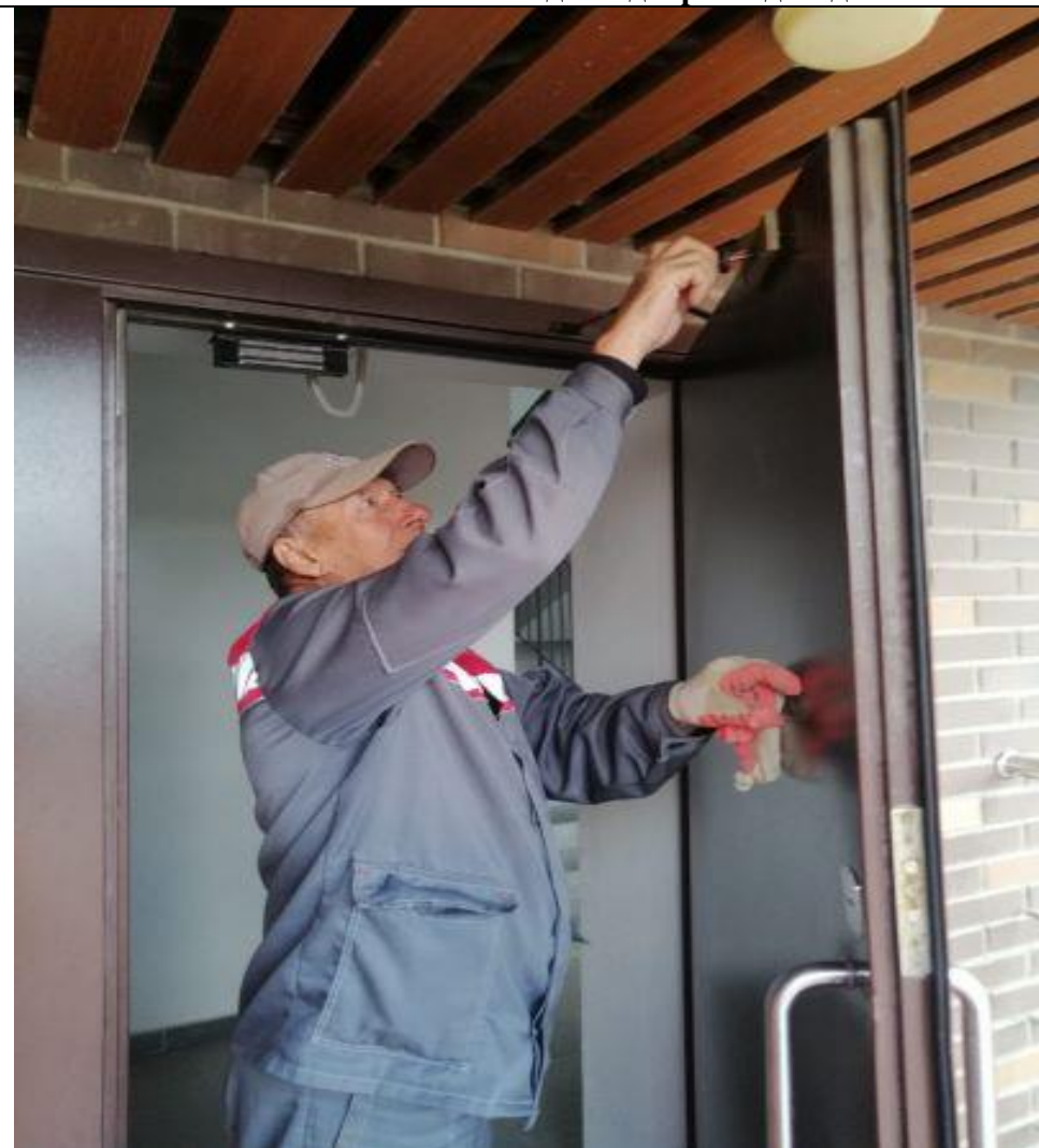
Ремонт магнита на входной двери подъезда
