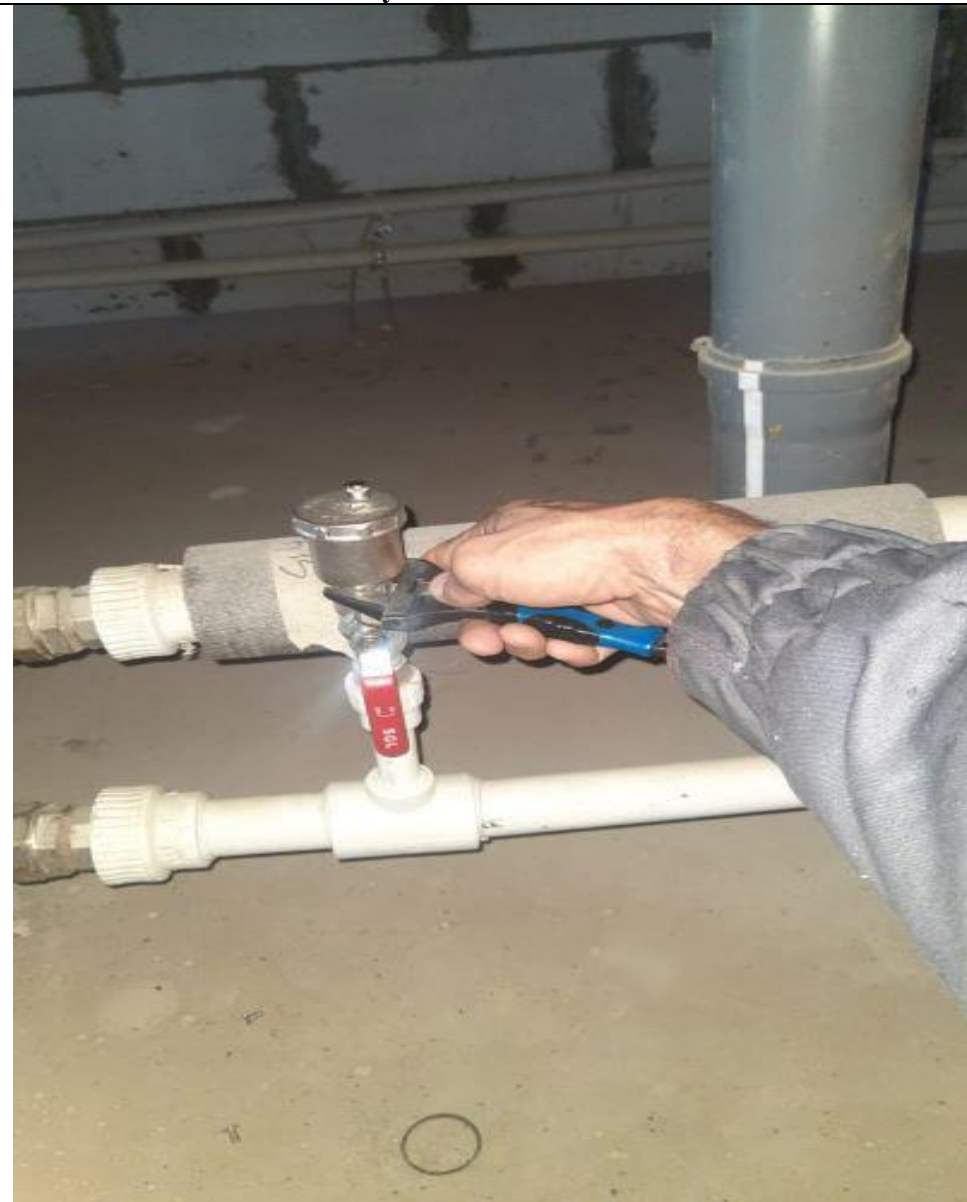
Замена воздухоотводчика на тех. этаже
