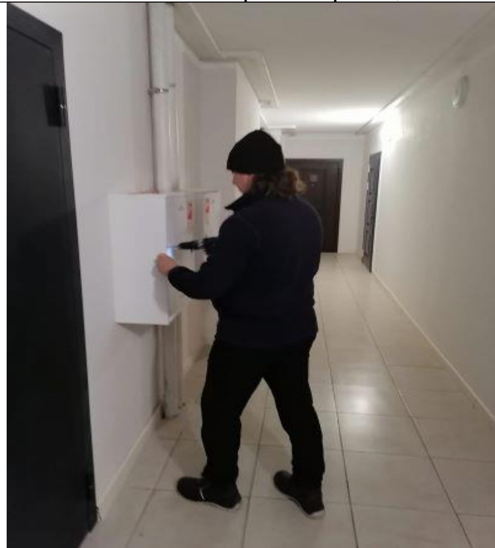
Установка пломб на противопожарные ящики
