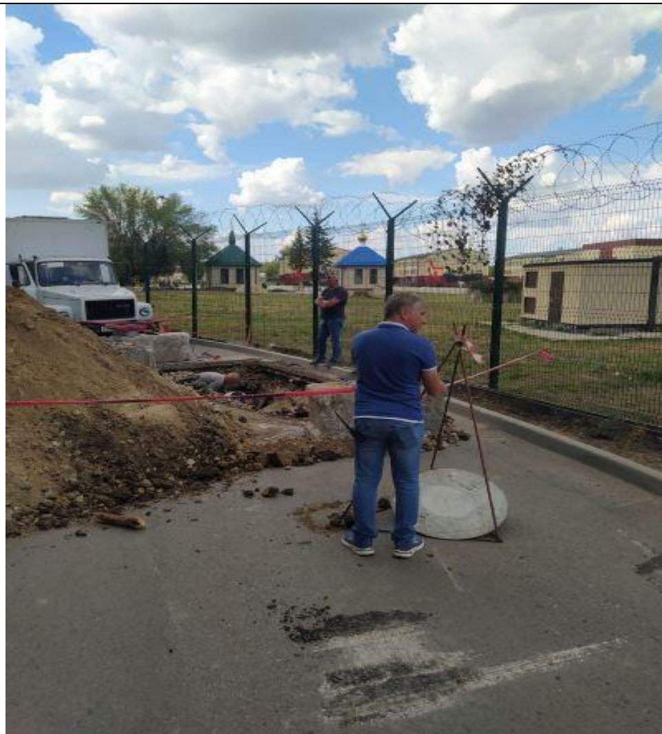
Ремонт силового кабеля
