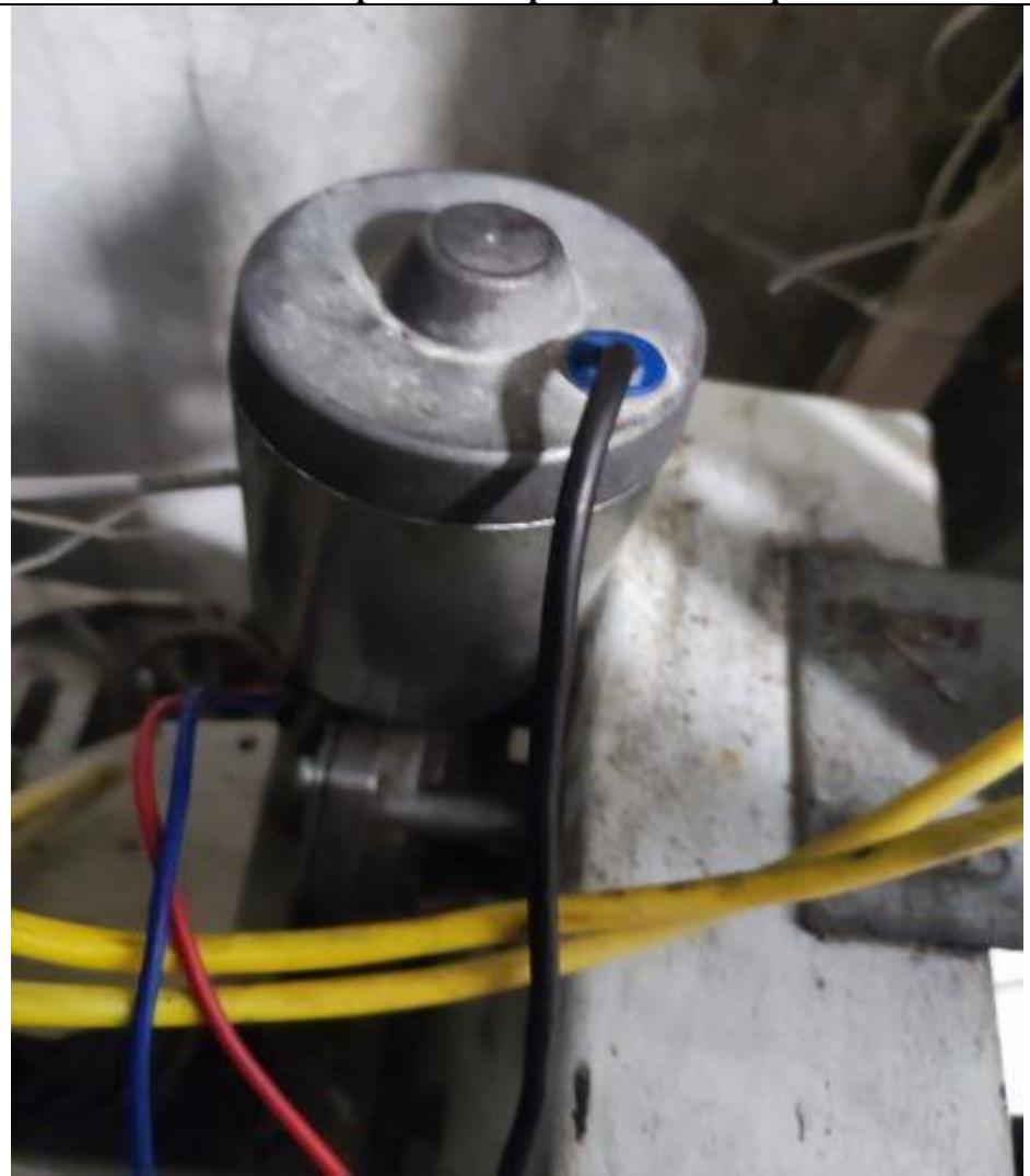
Ремонт привода дверей кабины лифта
