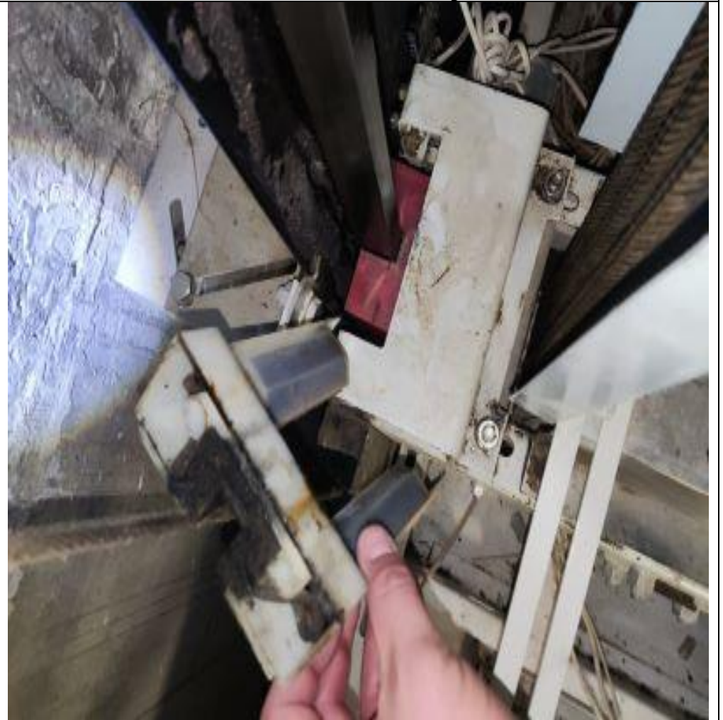
Замена масленок. Смазка направляющих
