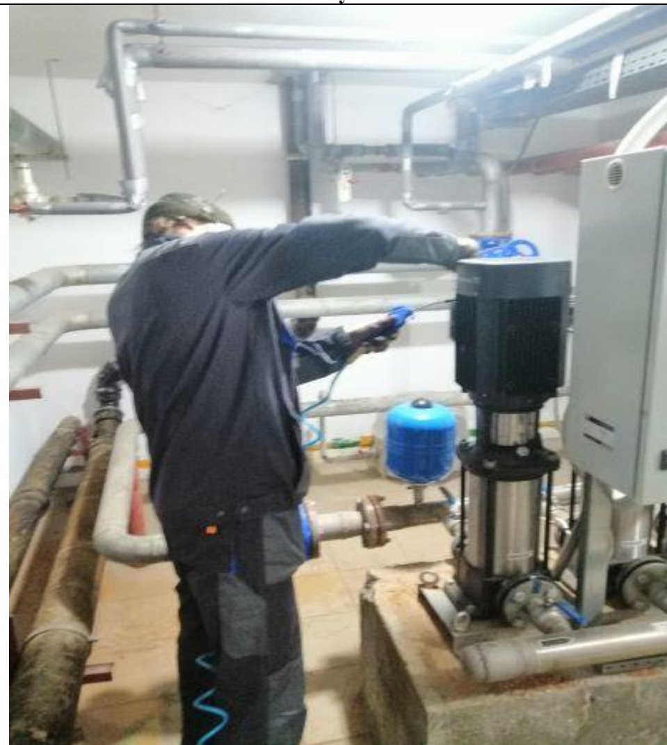
Техническое обслуживание насосов
