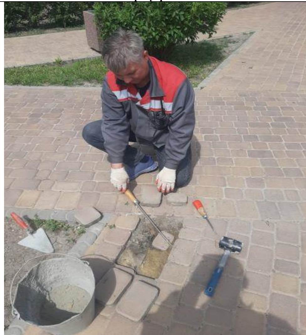
Ремонт тротуарной плитки
