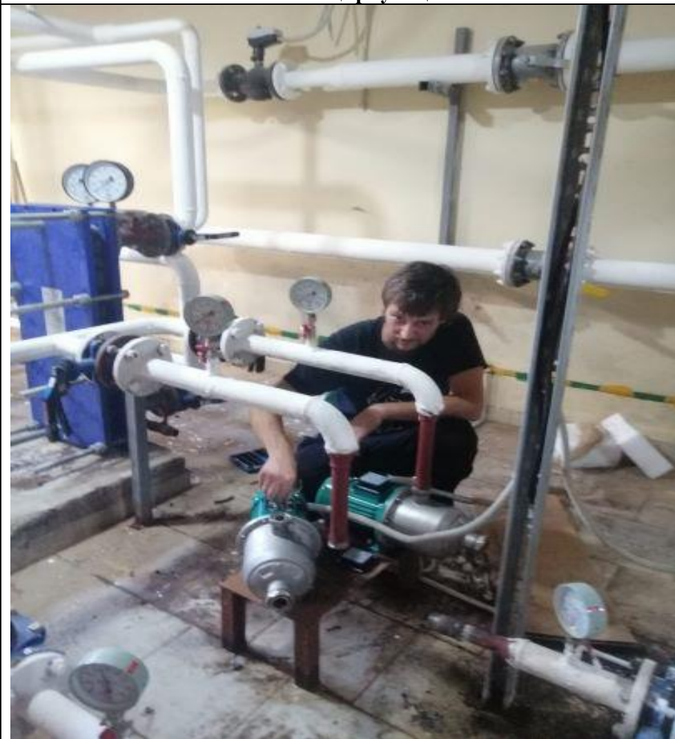
Замена насоса циркуляции ГВС
