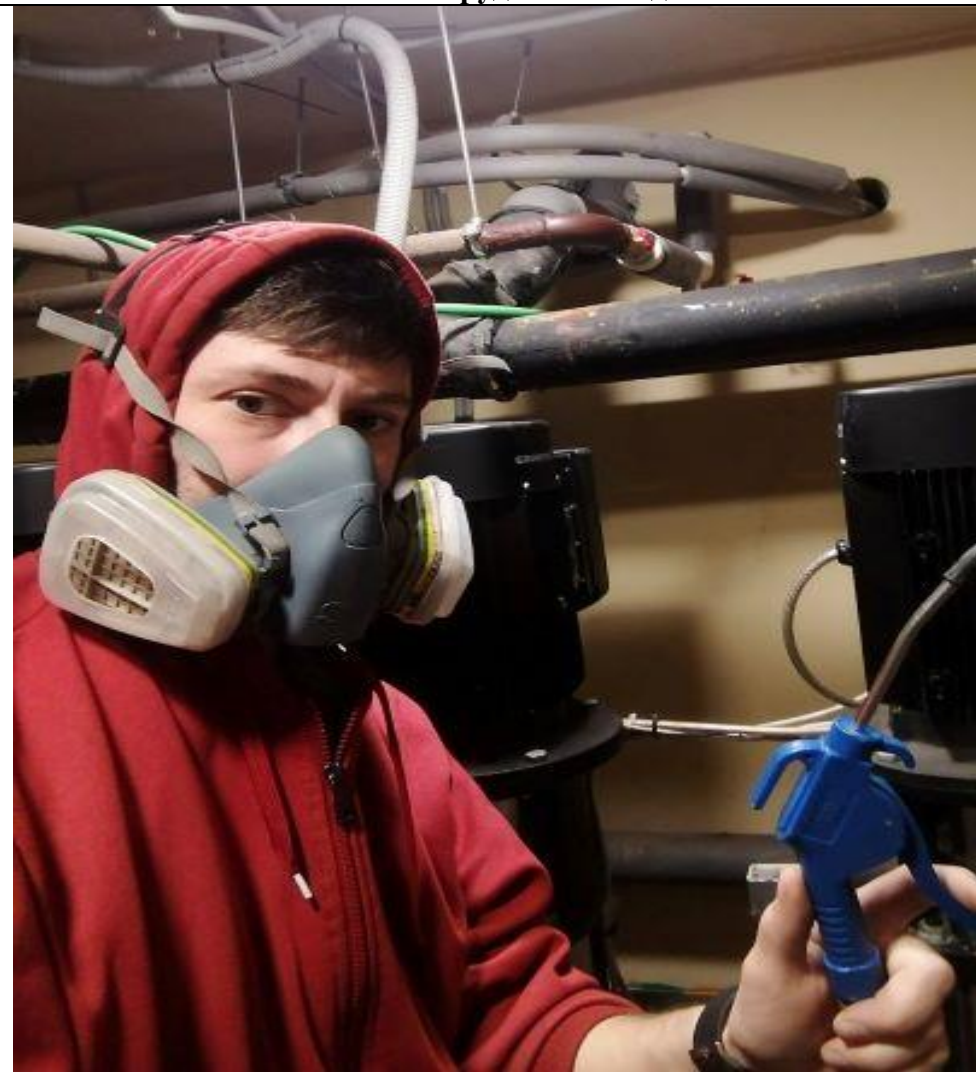
Очистка от пыли оборудование водоснабжения
