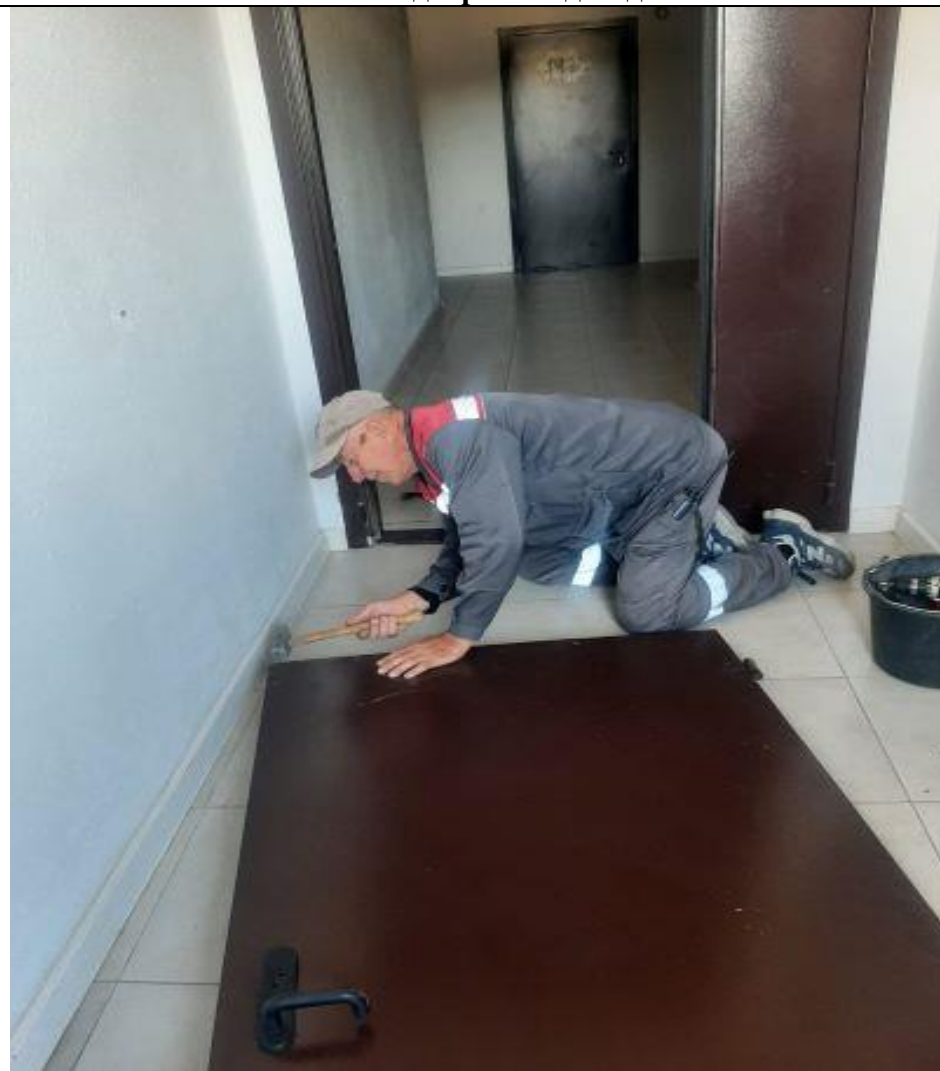
Ремонт двери в подъезде
