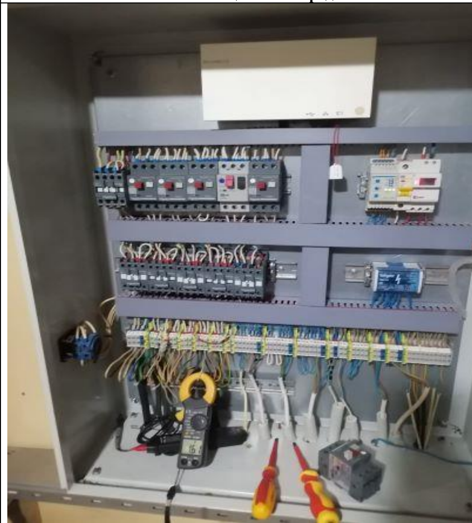
Замена автомата защиты электродвигателя
