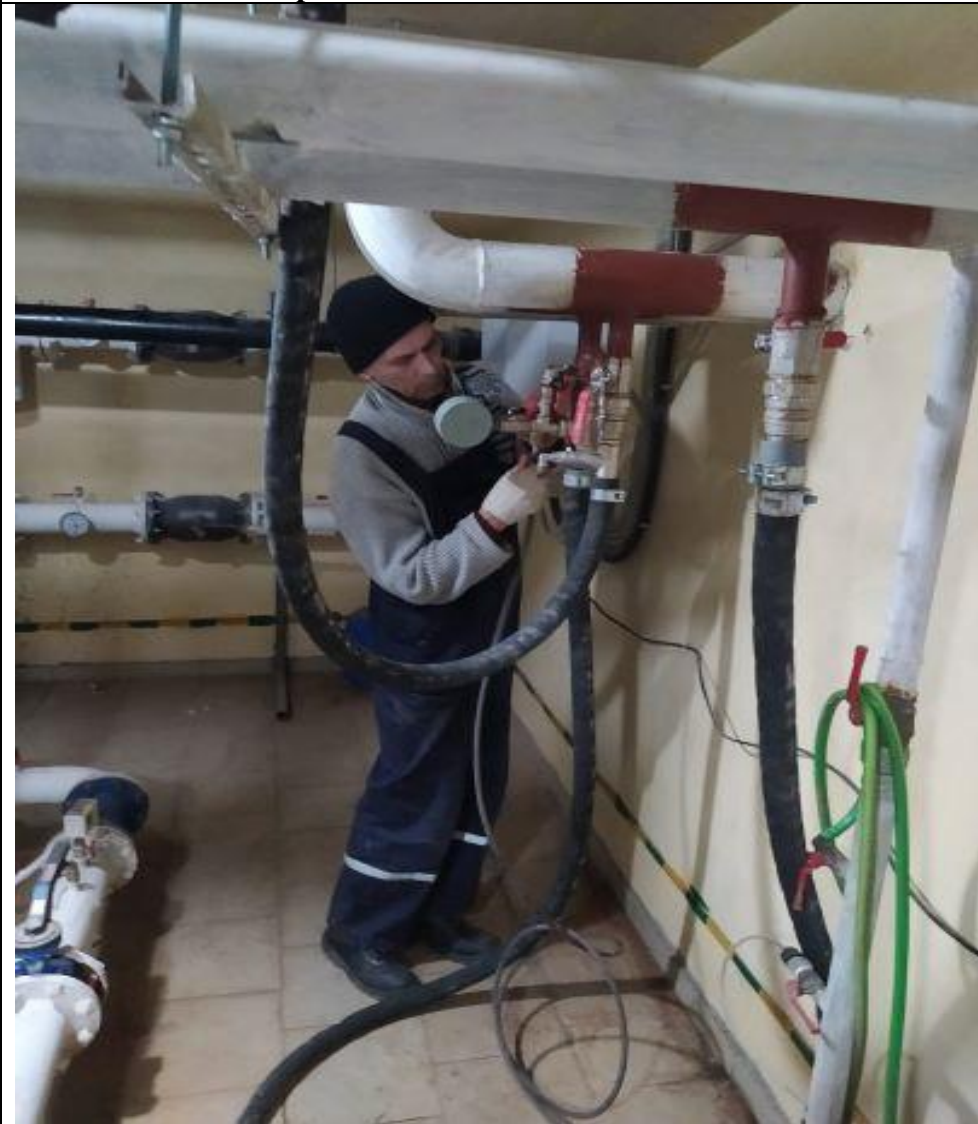
Промывка системы отопления
