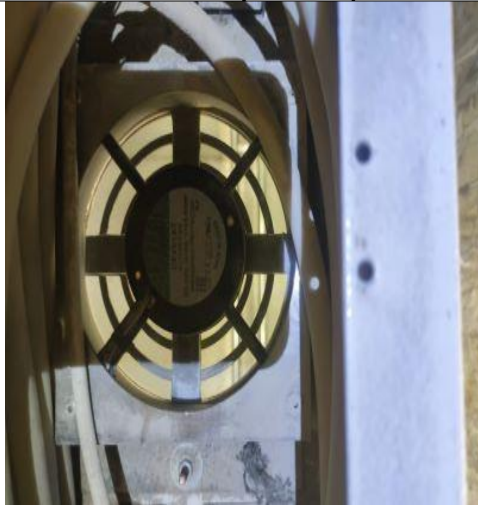
Замена вентилятора в кабине лифта
