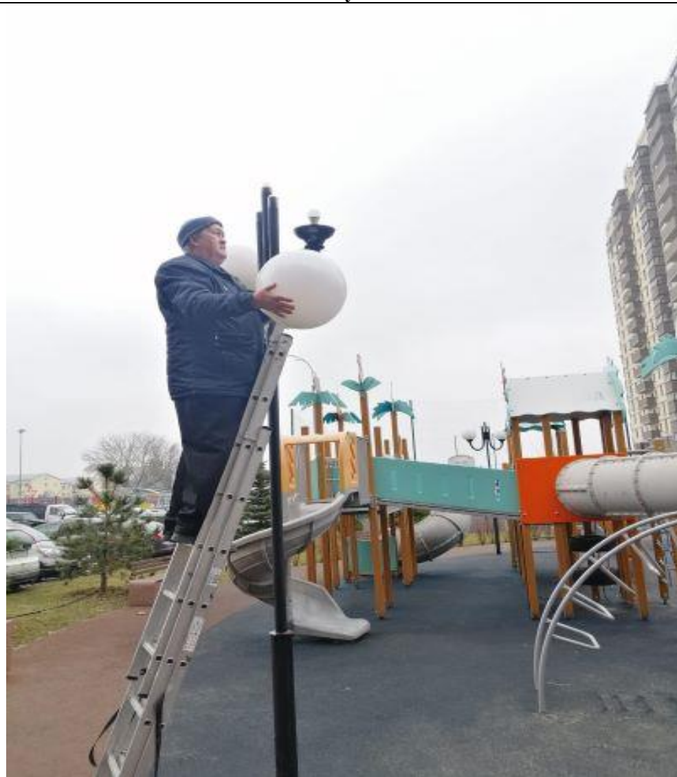
Замена светильника уличного освещения
