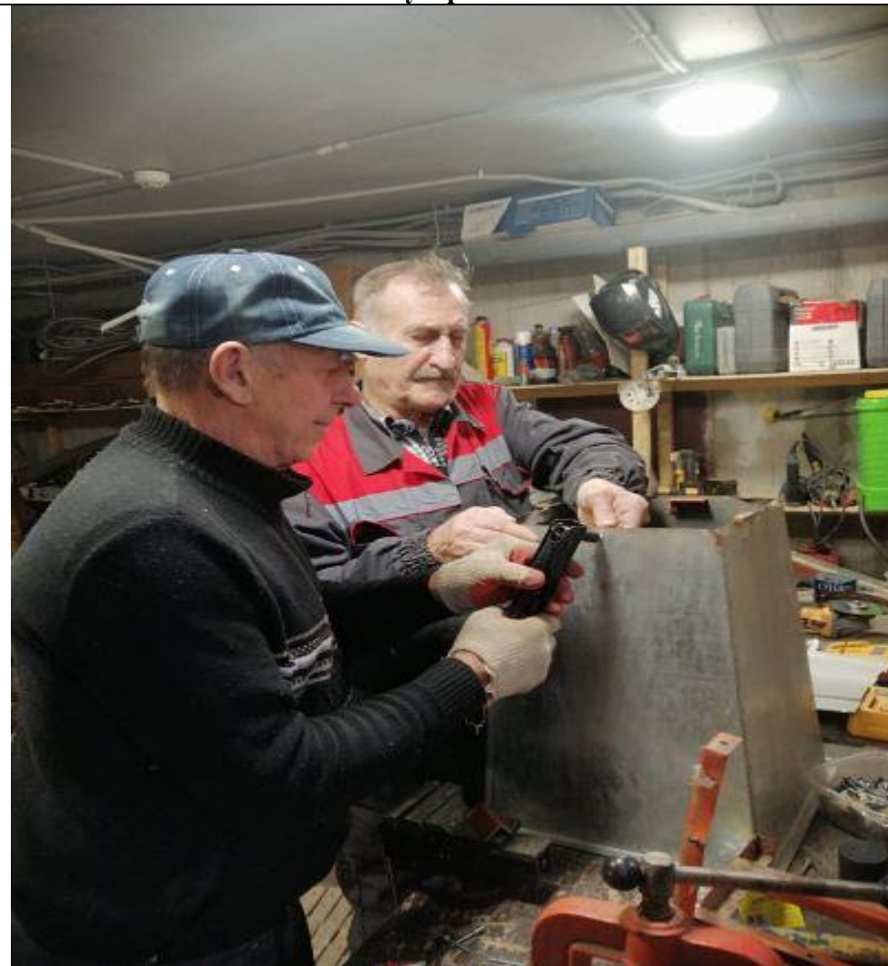
Ремонт мусорных жбанов
