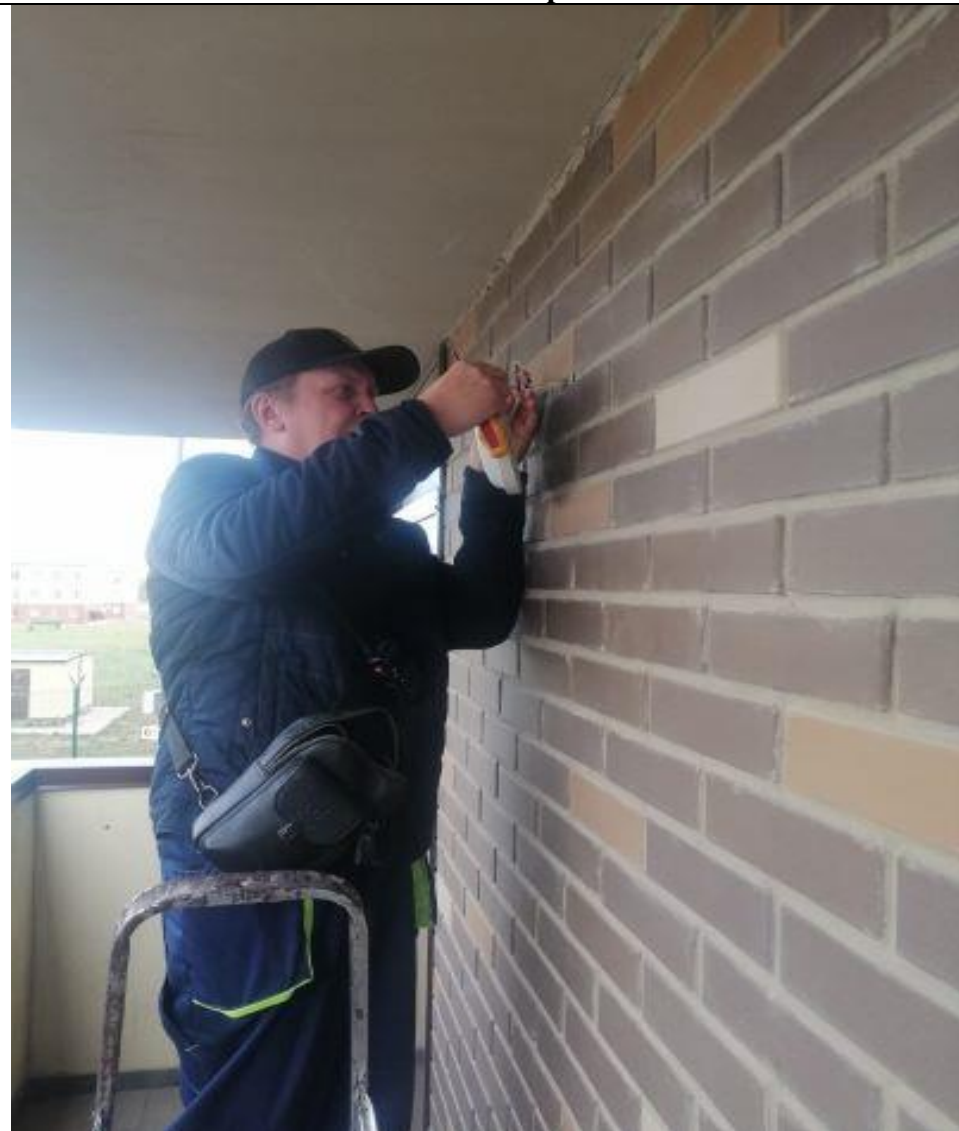
Замена светильника на переходном балконе
