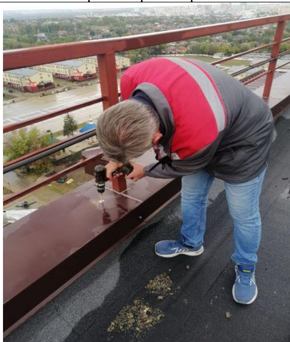
Крепление парапета на крыше
