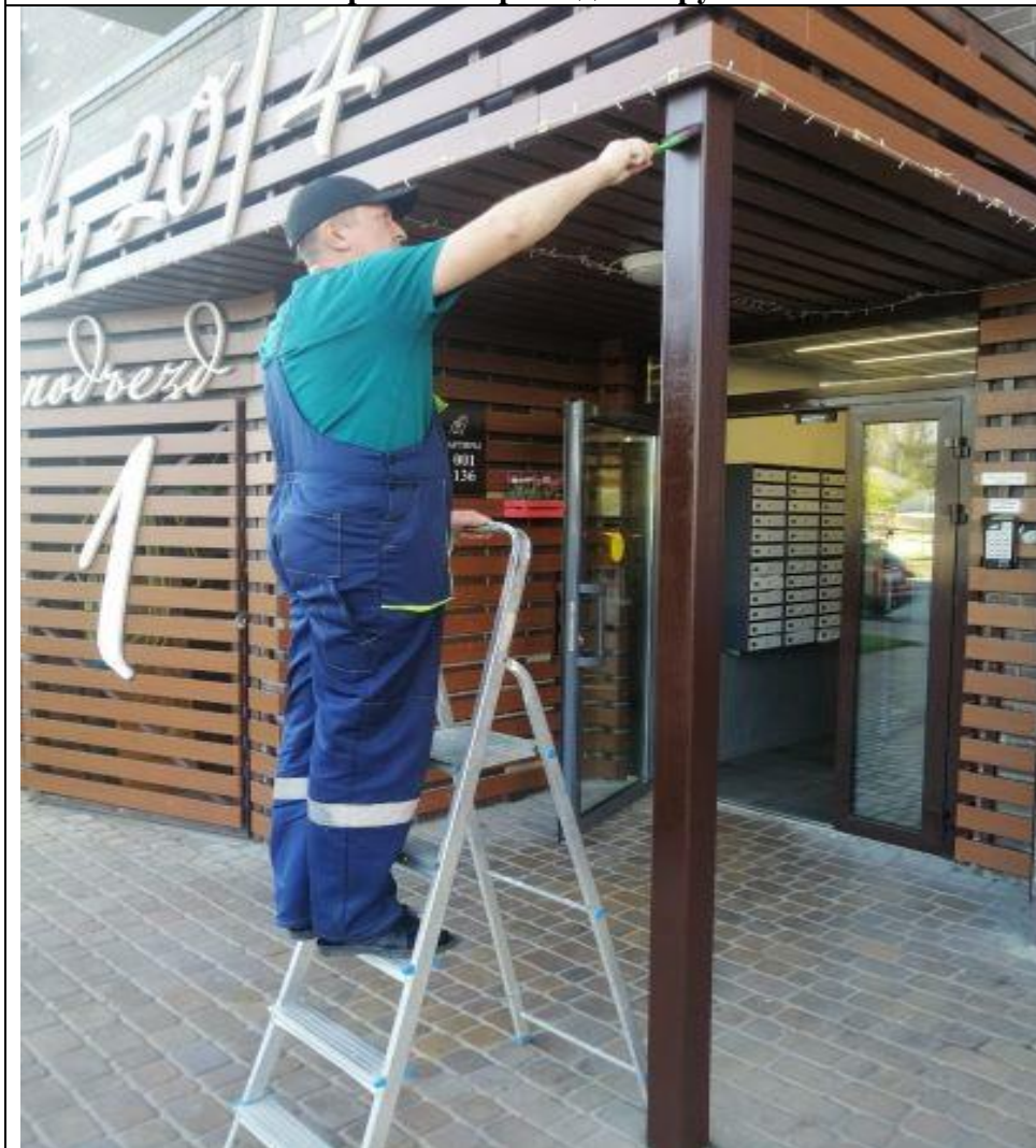
Покраска опор входной группы
