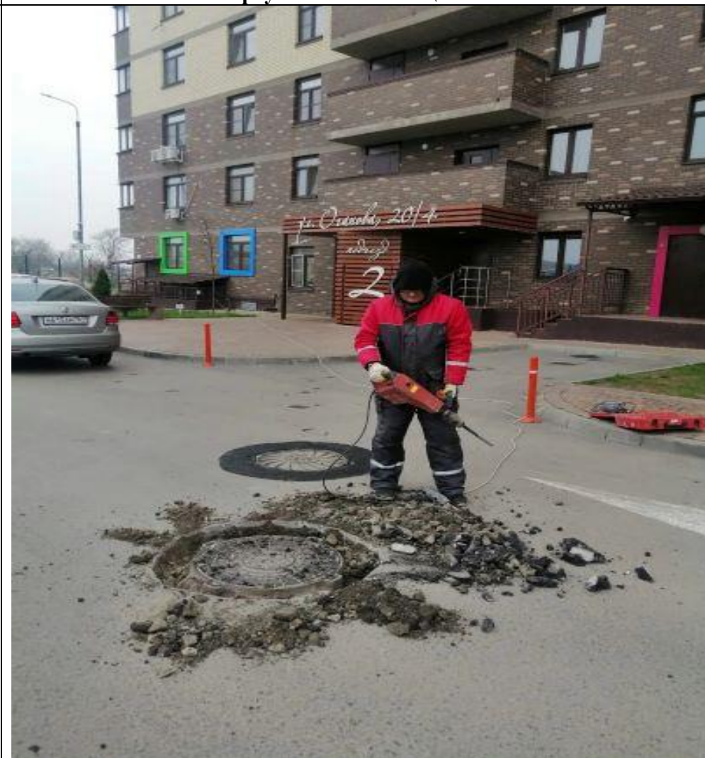
Переустановка кольца люка
