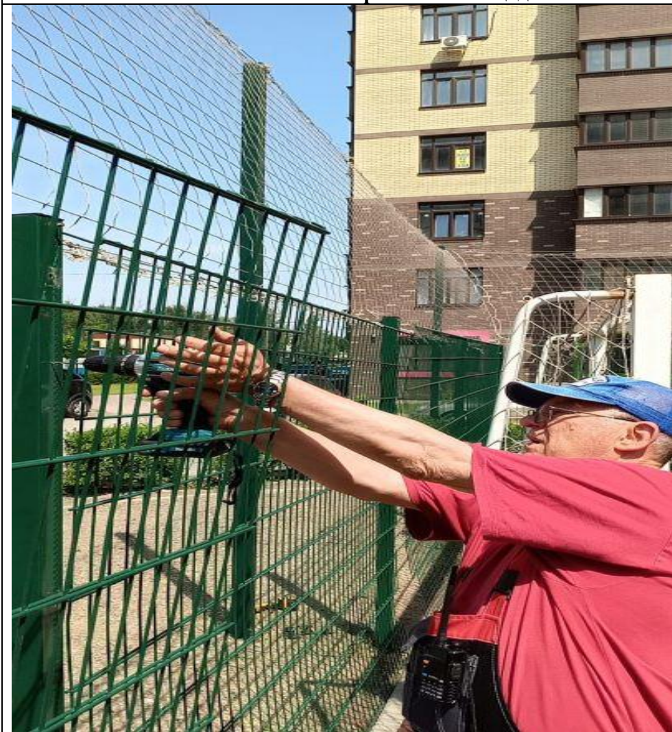
Ремонт калитки на спортивной площадке
