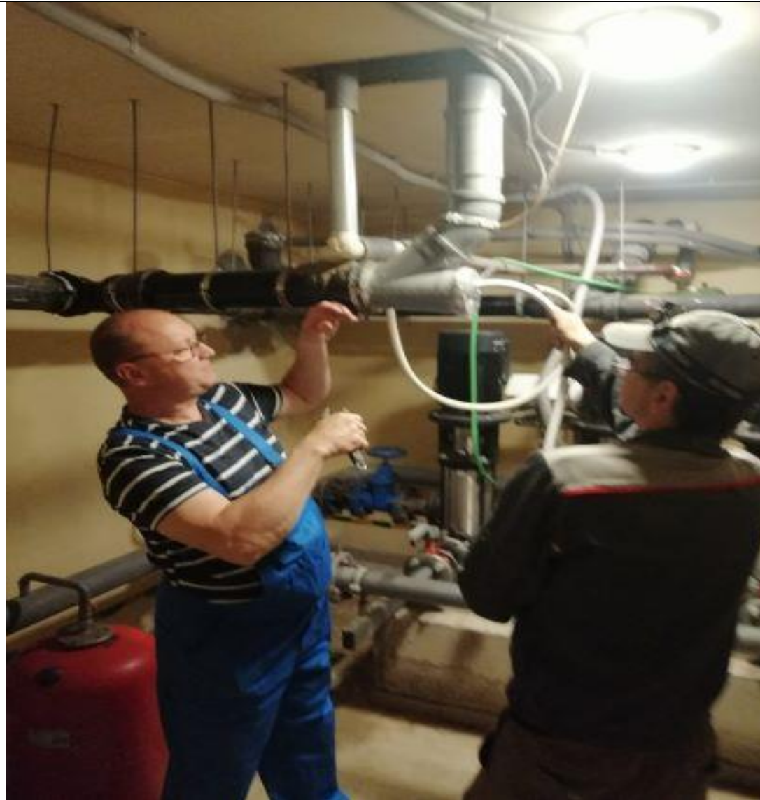
Монтаж системы промывки стояков
