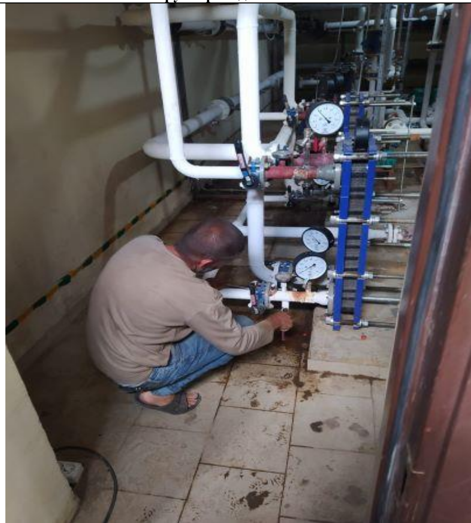
Ремонт трубопровода теплообменника
