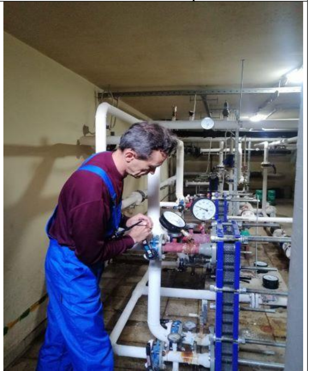
Установка манометра
