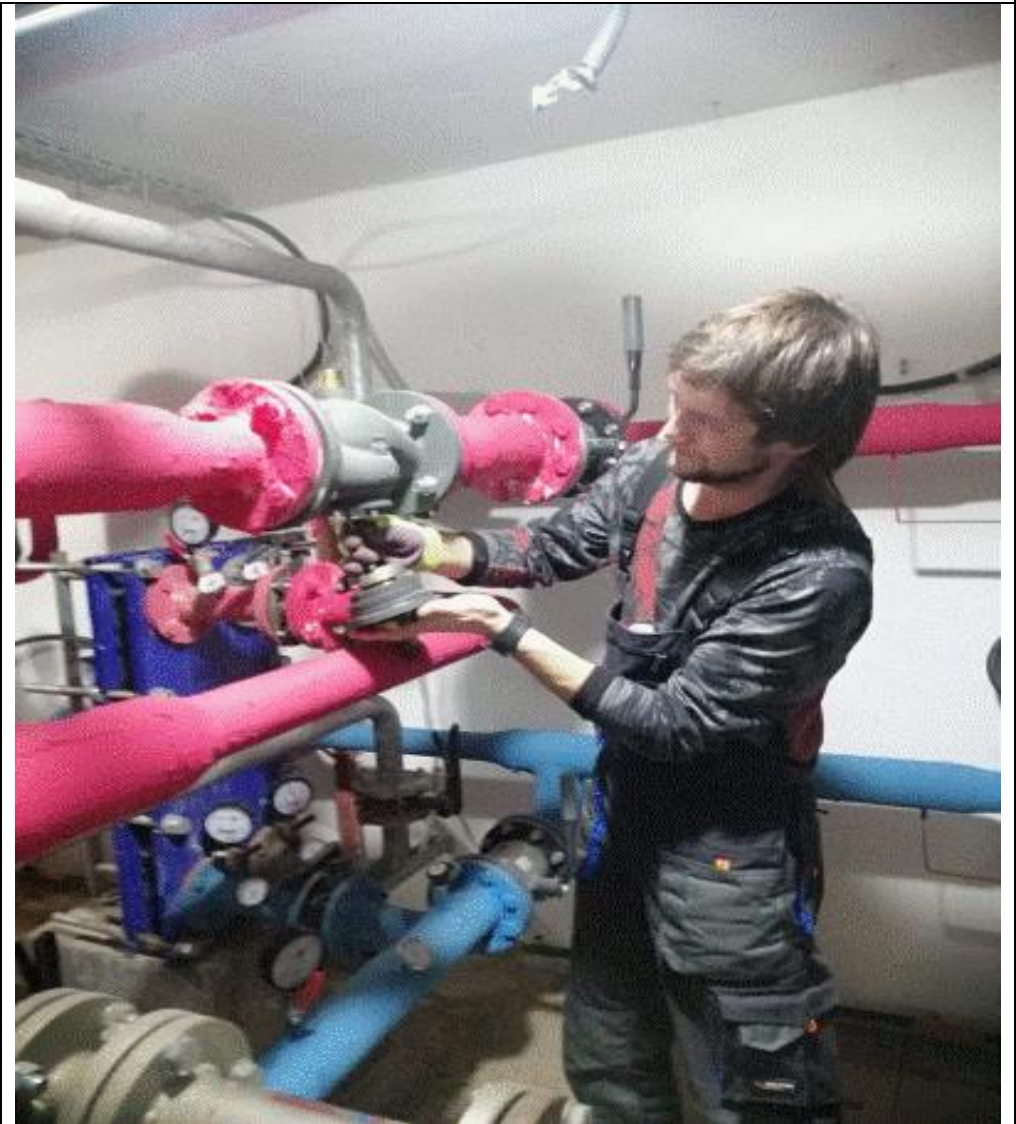
Ремонт клапана ГВС
