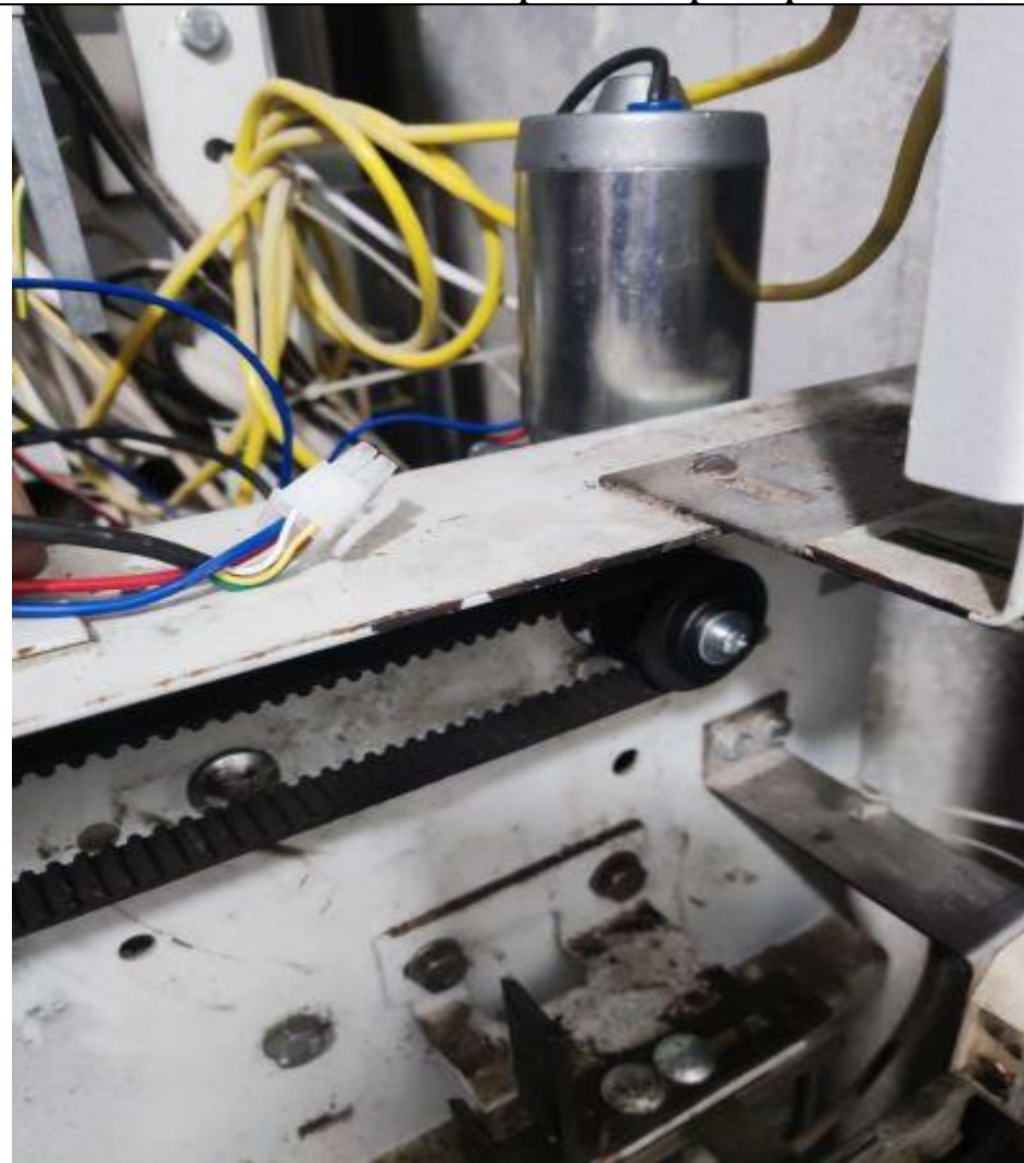
Замена двигателя привода двери лифта
