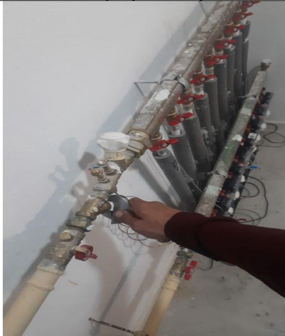
Чистка фильтров в коллекторной
