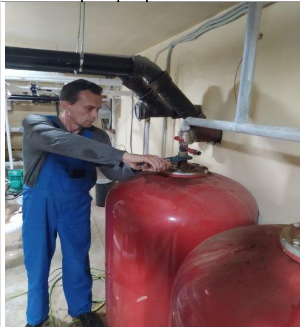
Замена крана на расширительном баке отопления
