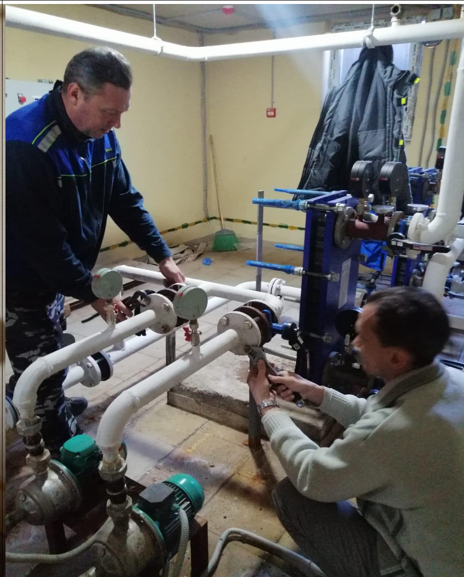
Замена клапанов и задвижек на системе циркуляции ГВС
