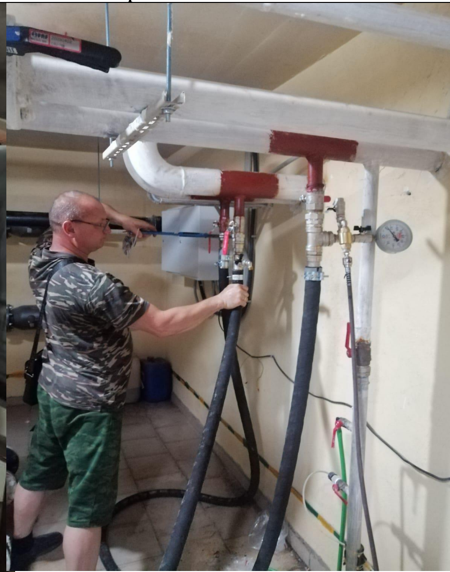
Промывка системы отопления
