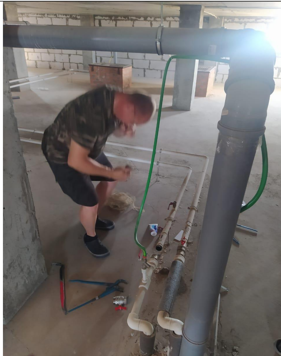
Ремонт стояка ГВС
