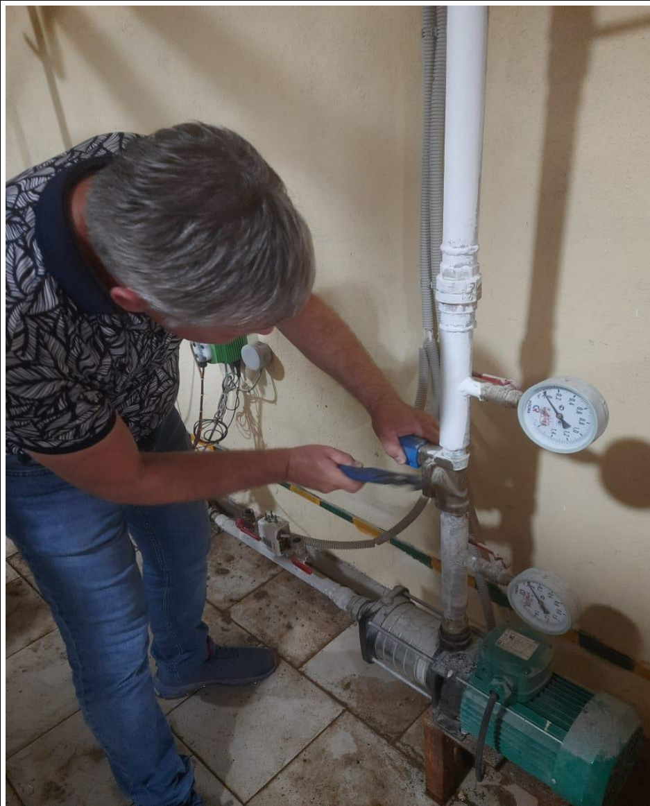
Ремонт клапана в ИТП
