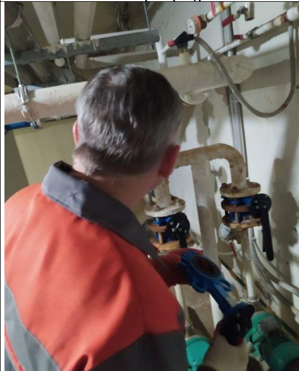
Замена запорной арматуры
