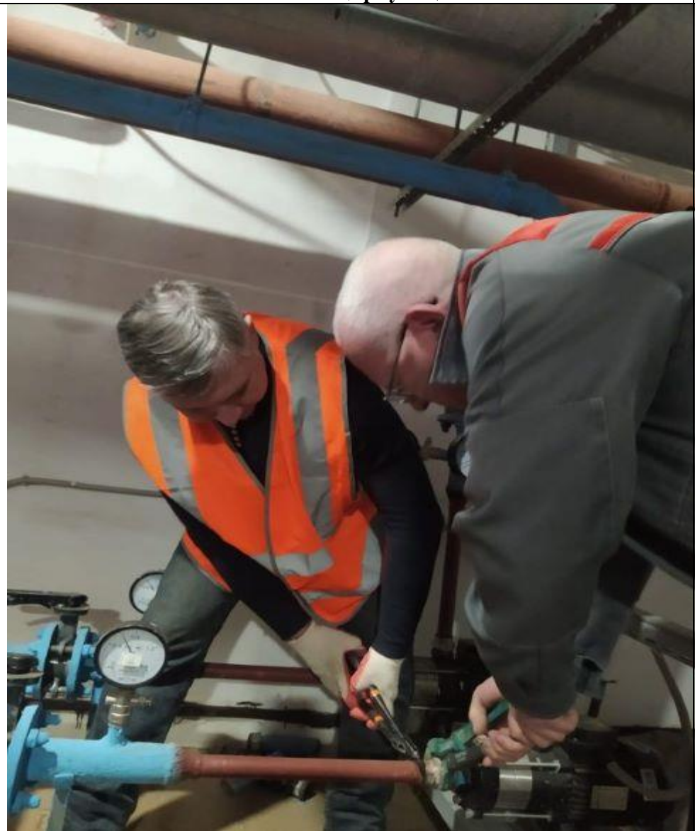
Монтаж насоса циркуляции ГВС
