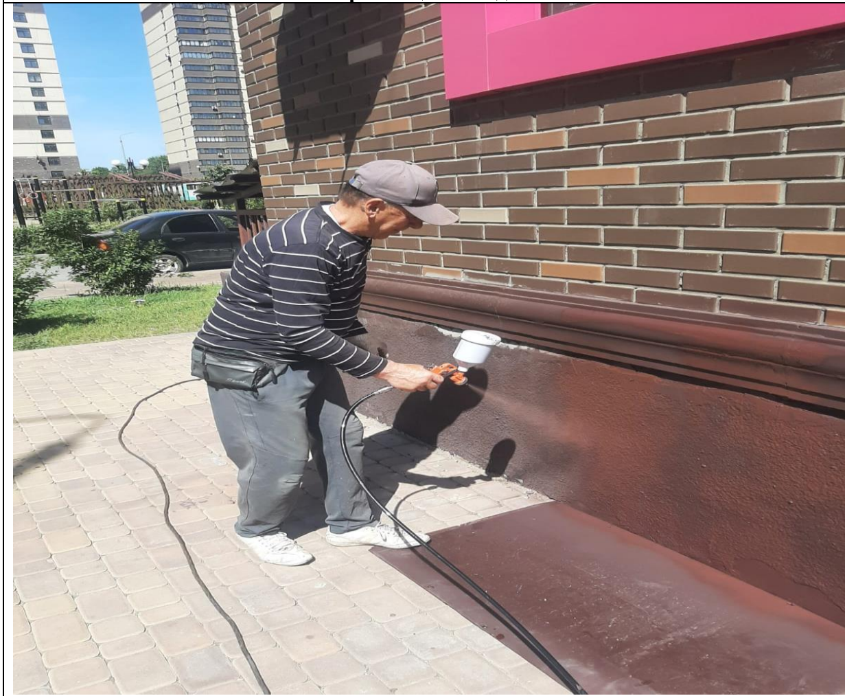
Покраска цоколя здания
