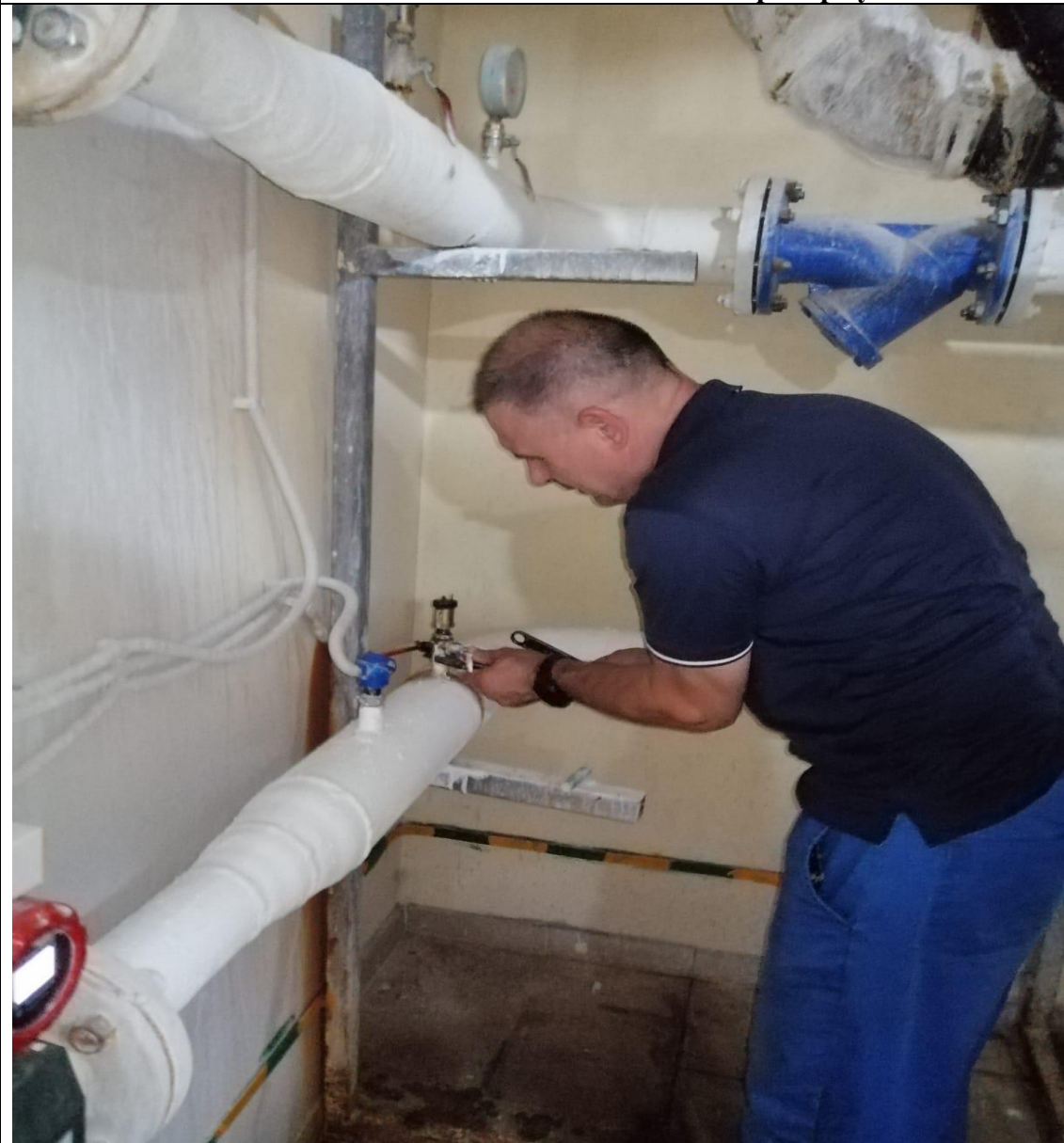
Замена датчика давления на общедомовом приборе учета
