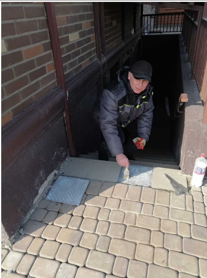
Ремонт плитки при спуске в подвал
