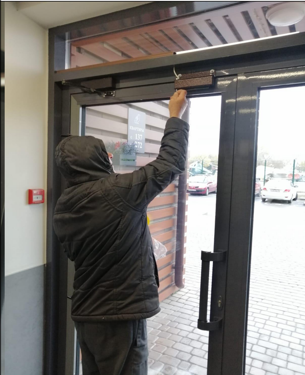
Ремонт магнитного замка
