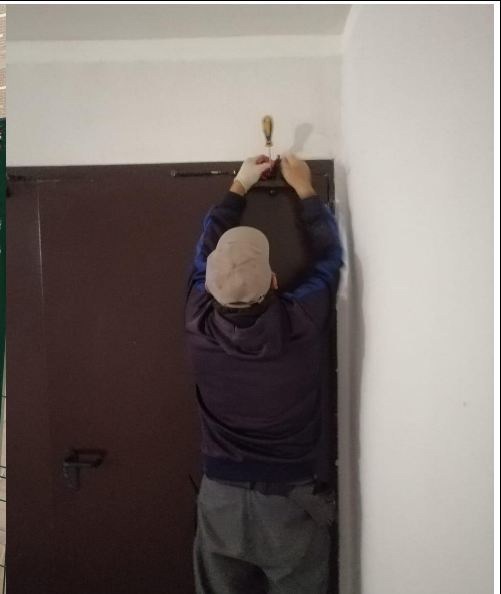
Ремонт двери лифтового холла
