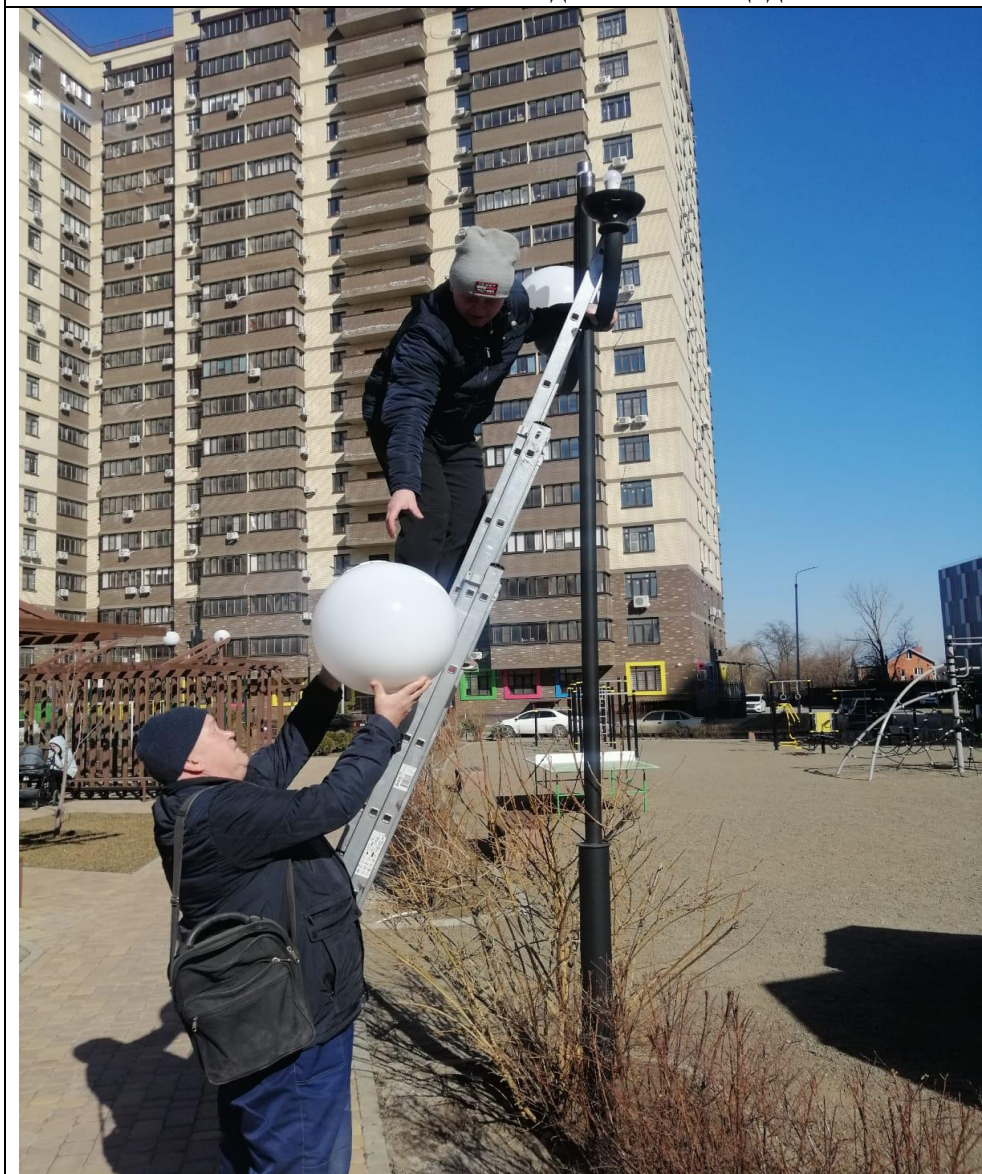
Замена светильников на детской площадке
