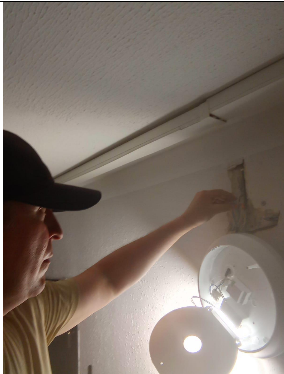
Замена светильника в местах общего пользования
