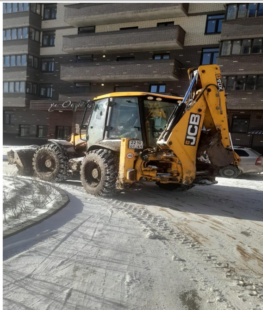
Уборка снега с дорог придомовой территории
