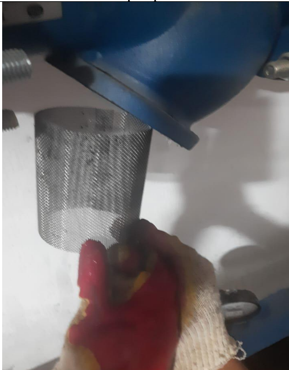
Чистка фильтров в ИТП
