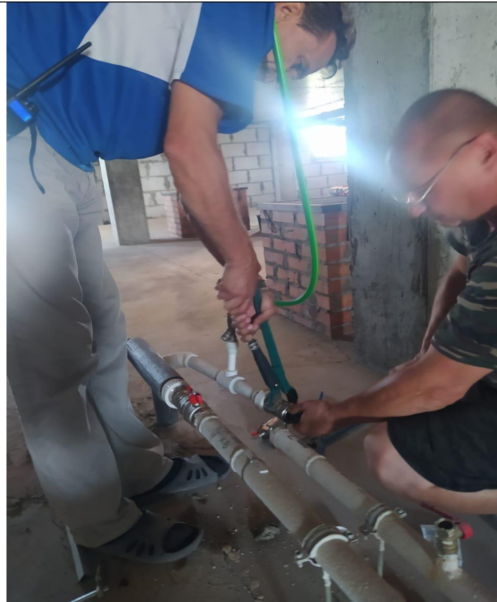
Ремонт стояка ХВС
