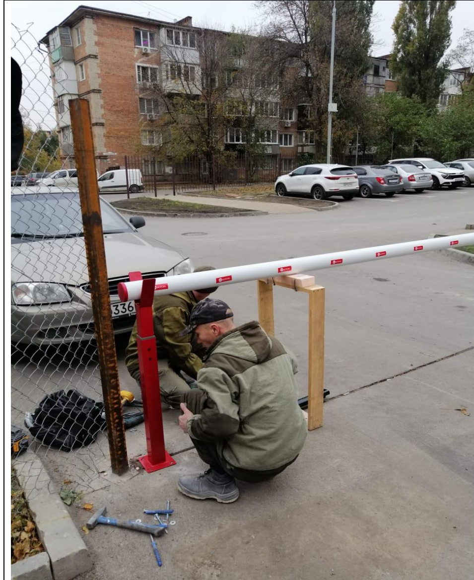
Установка стрелы шлагбаума
