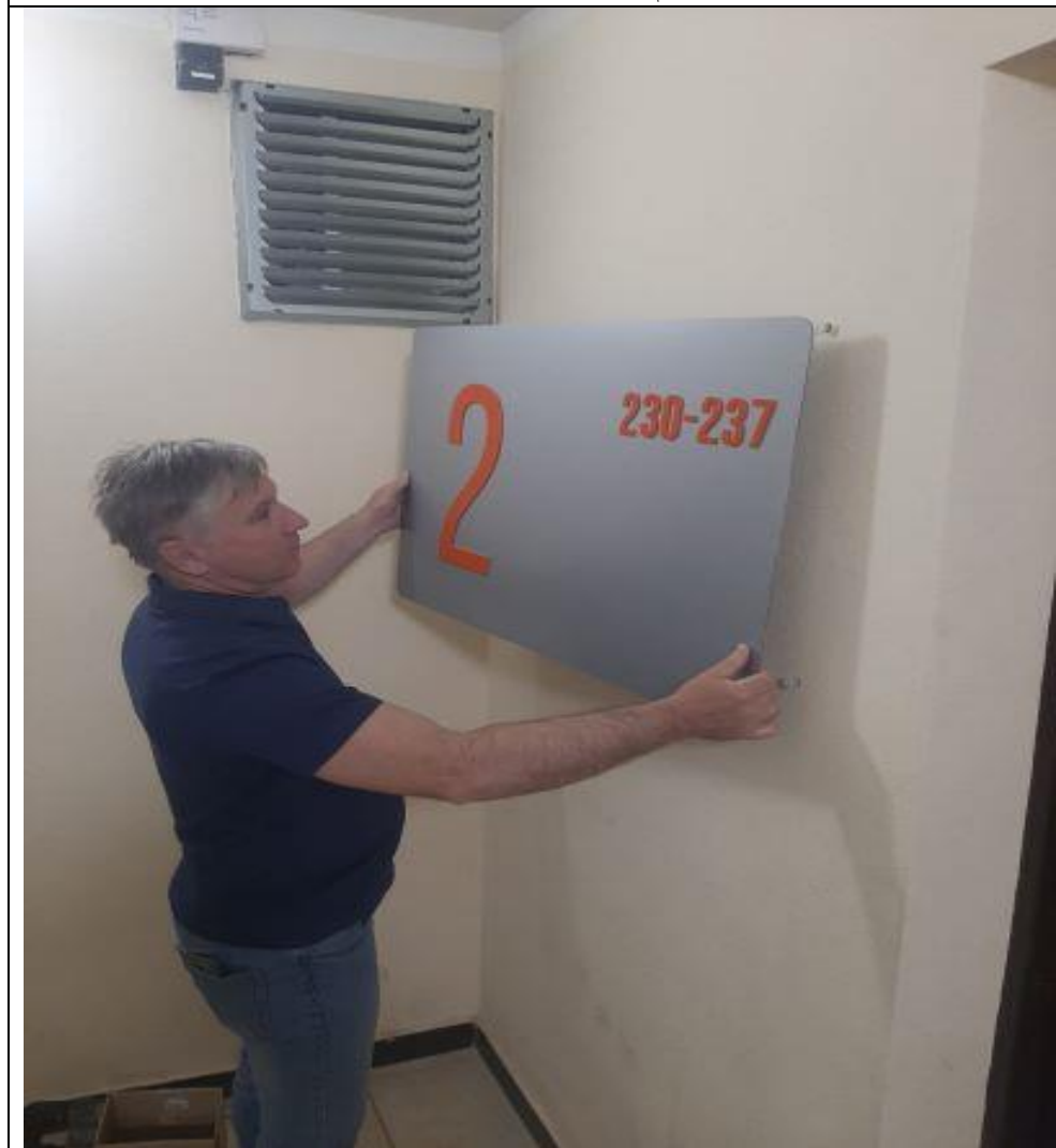
Ремонт поэтажных щитков
