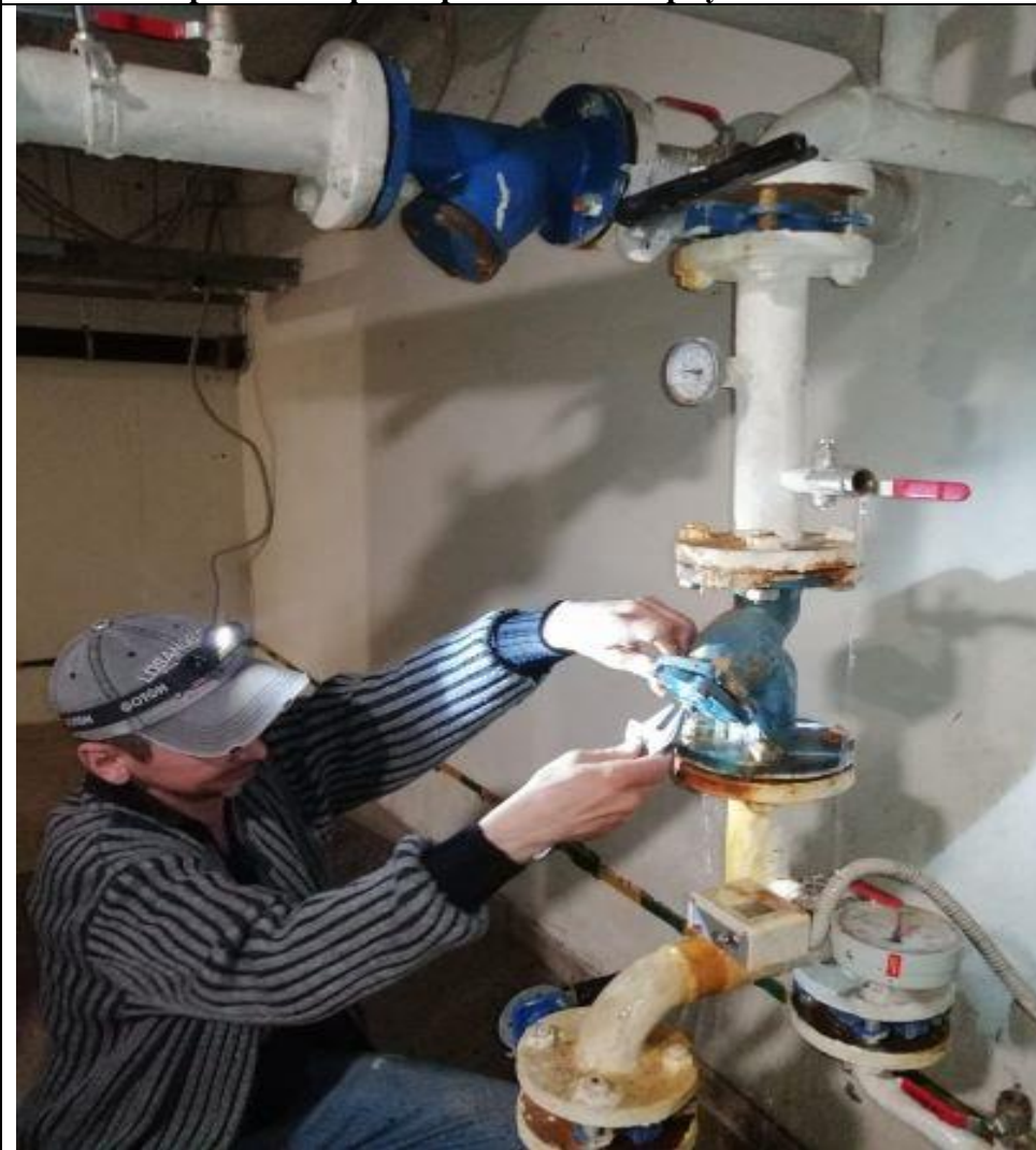
Прочистка фильтра системы циркуляции ГВС
