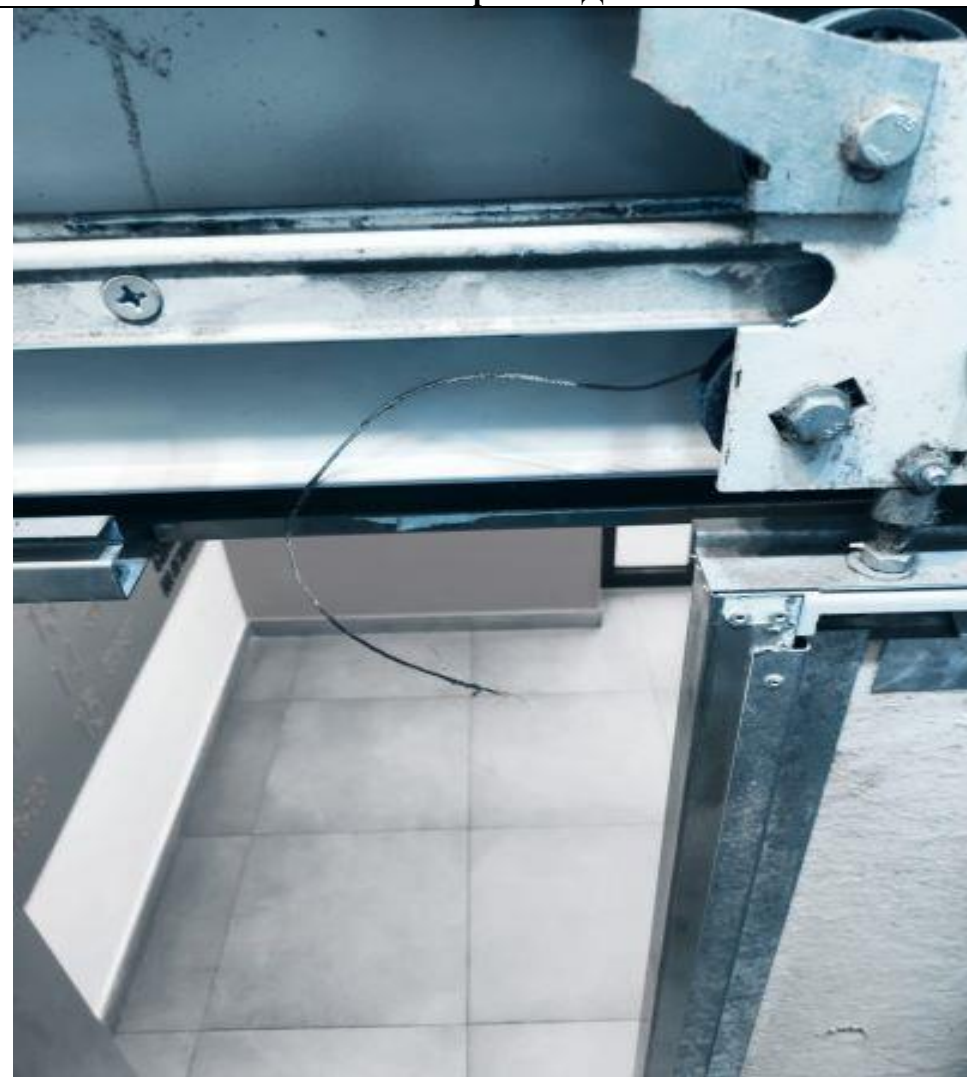
Замена тросика ДШ
