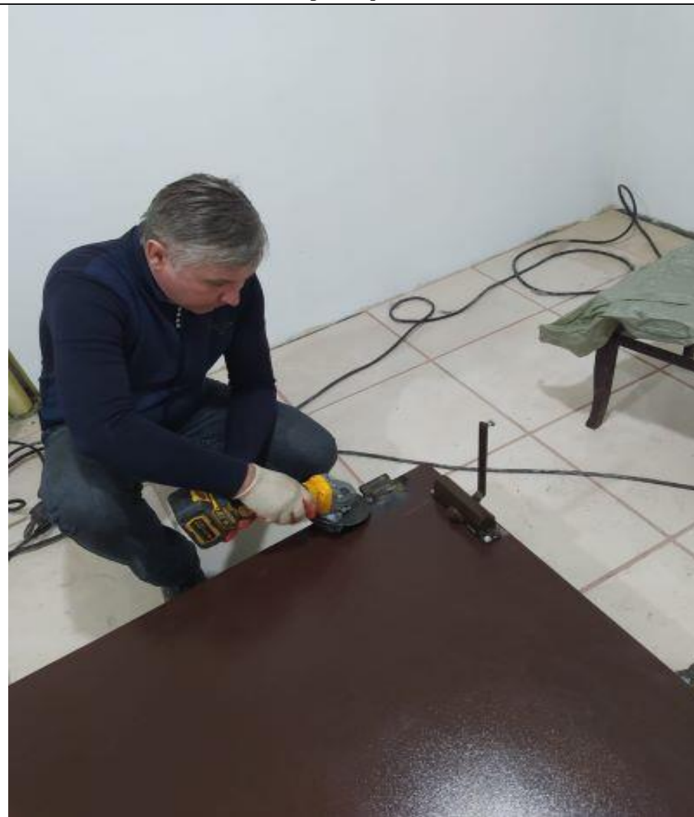
Ремонт двери лифтового холла
