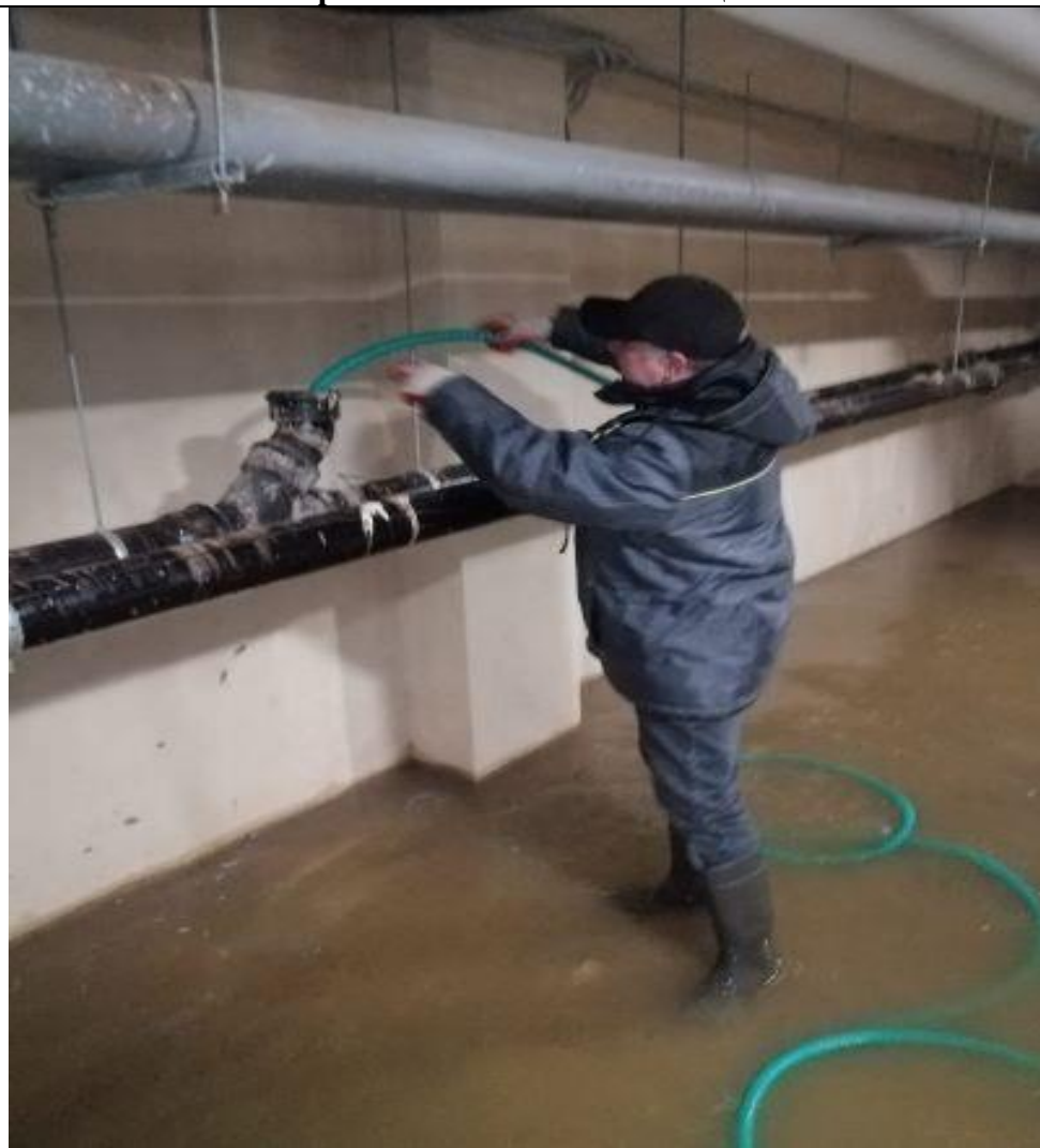
Прочистка забоя канализации
