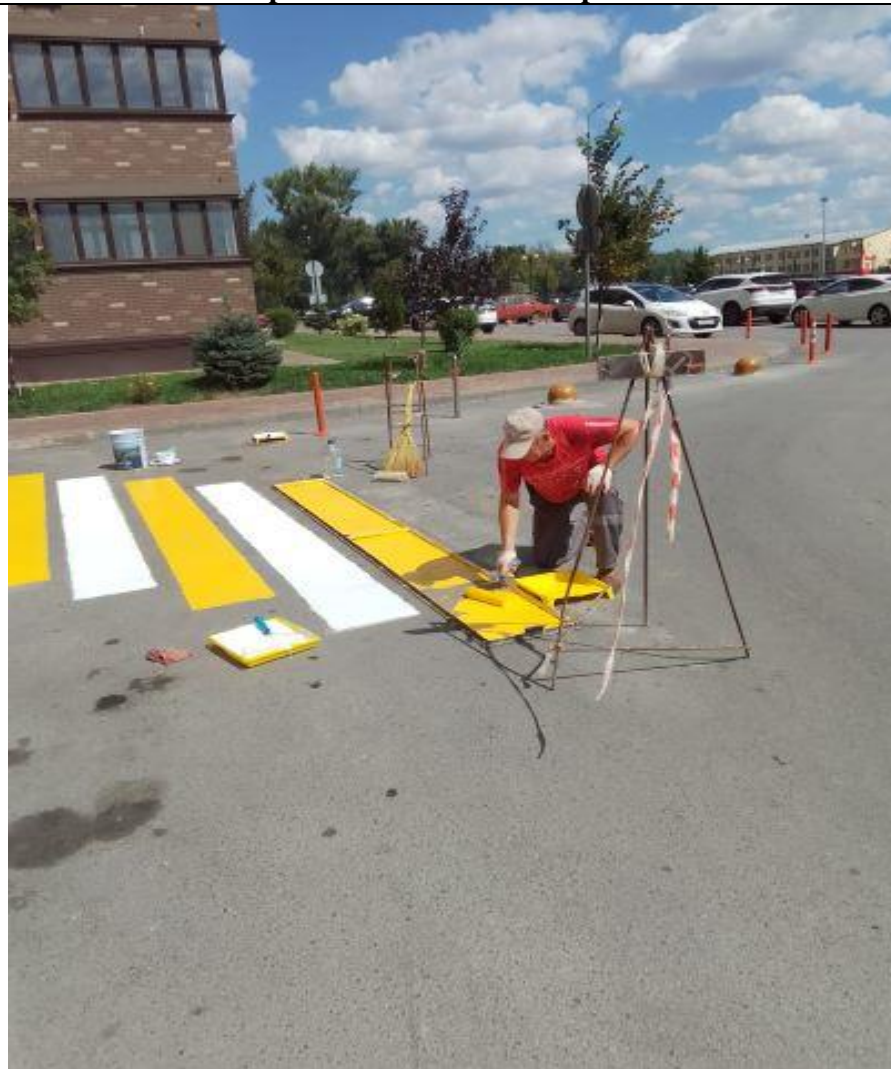
Покраска пешеходных переходов
