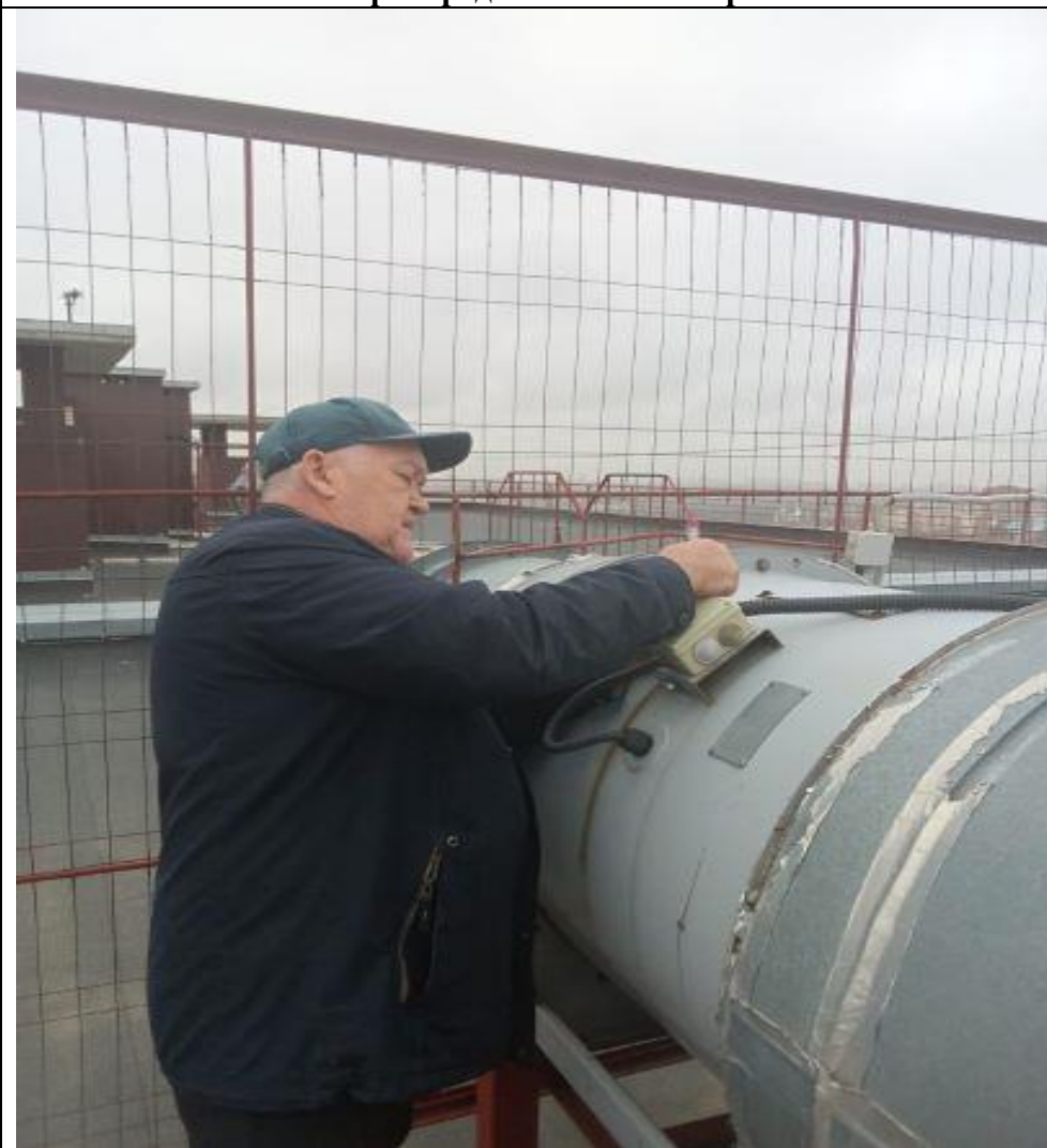
Ремонт распределительных коробок
