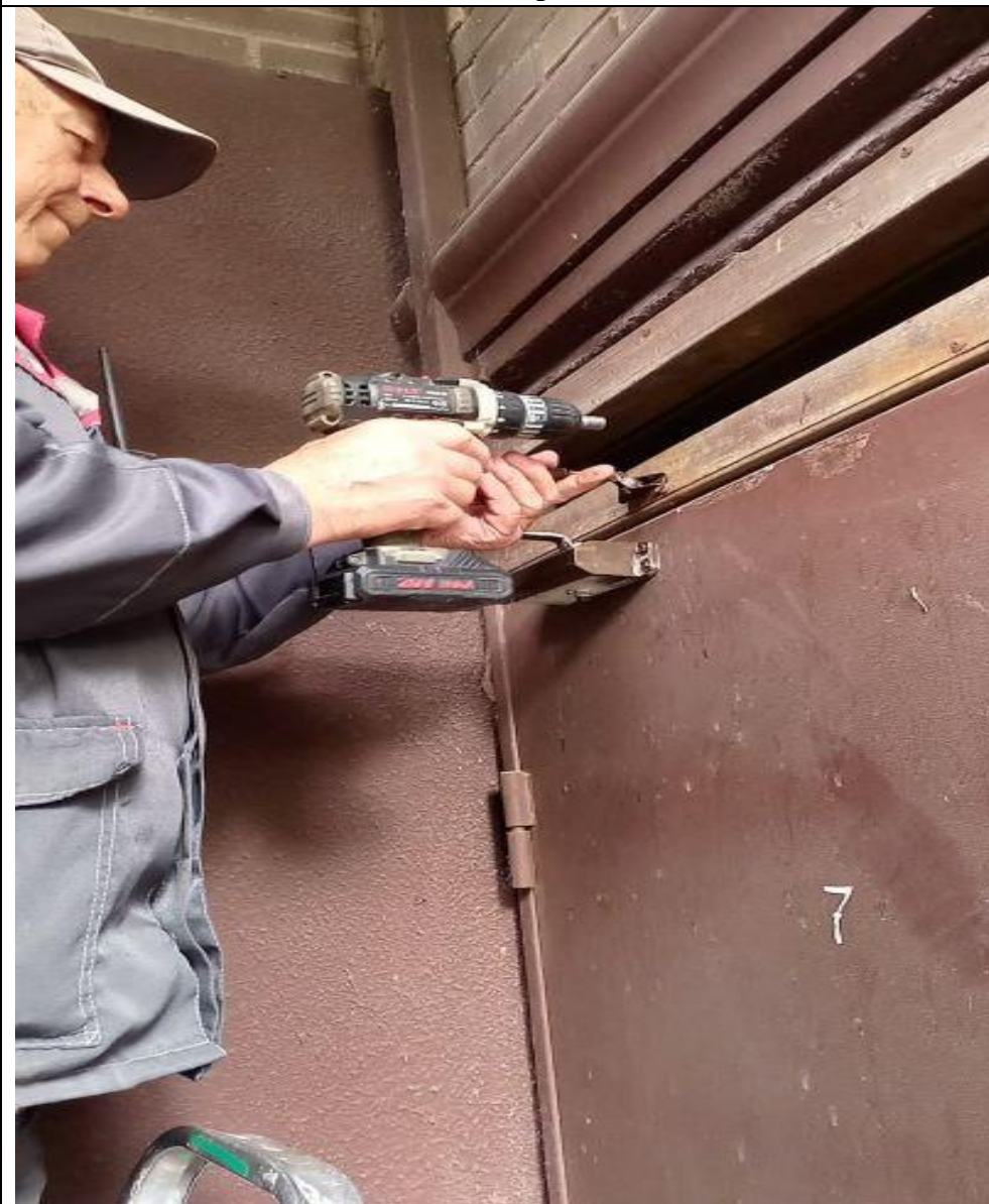
Замена доводчика входной двери в кладовые помещения
