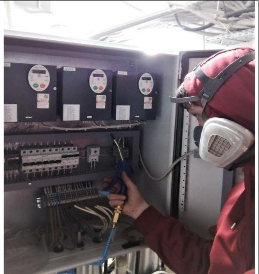
Прочистка от пыли оборудования водоснабжения в насосной
