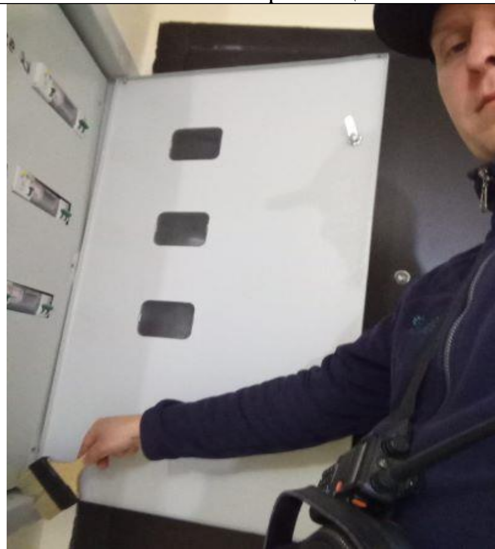
Обеспыливание электрических щитков
