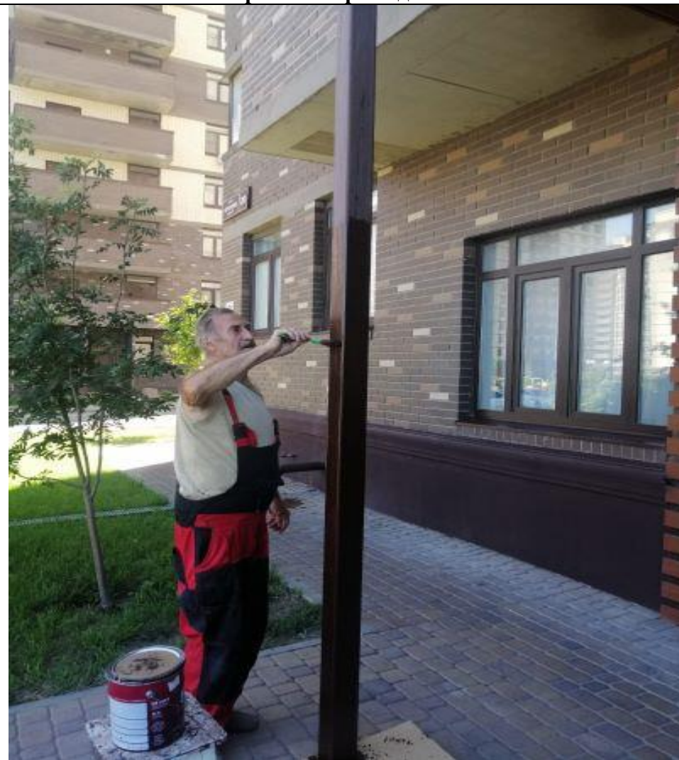
Покраска опор входных зон
