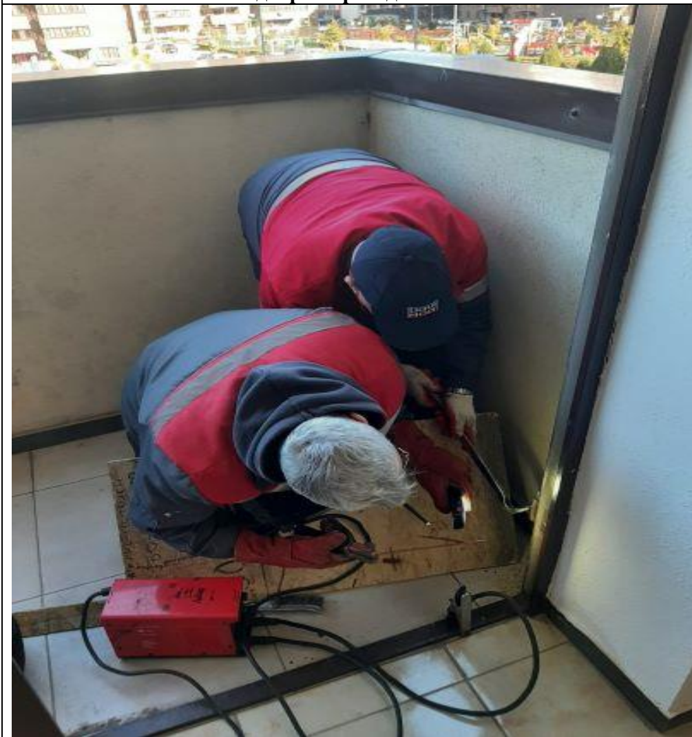
Ремонт двери переходного балкона
