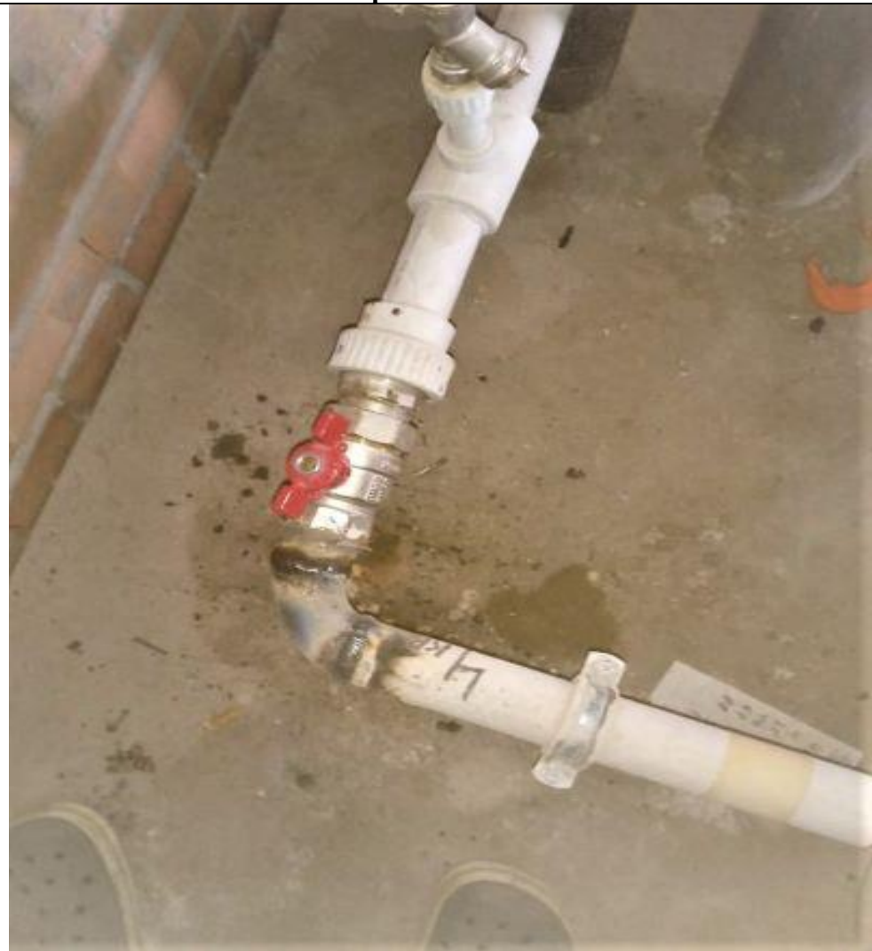
Замена крана на стояке ГВС
