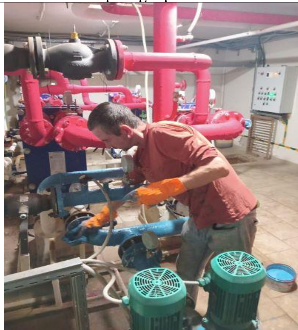
Покраска труб в рамке ИТП
