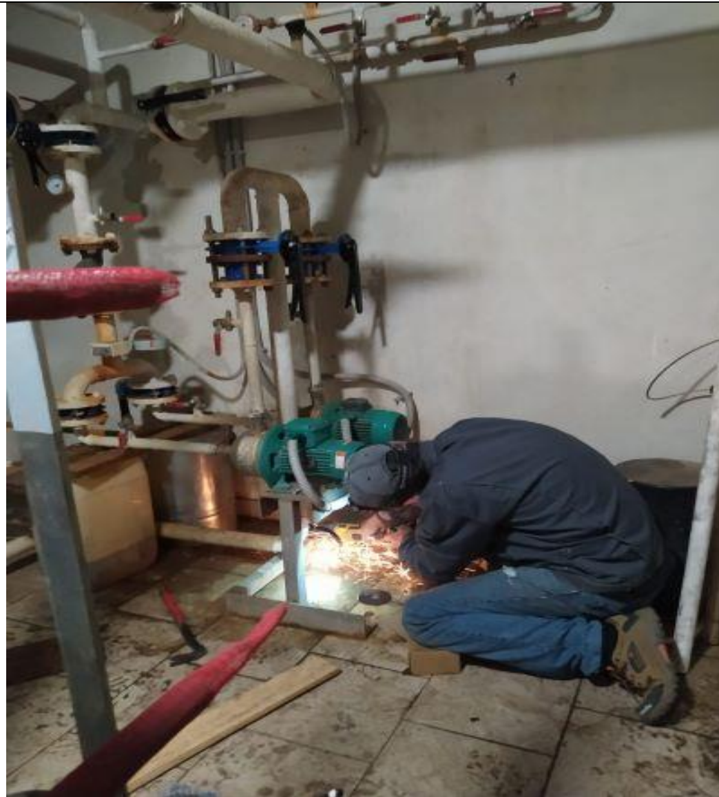
Ремонт стояка ГВС
