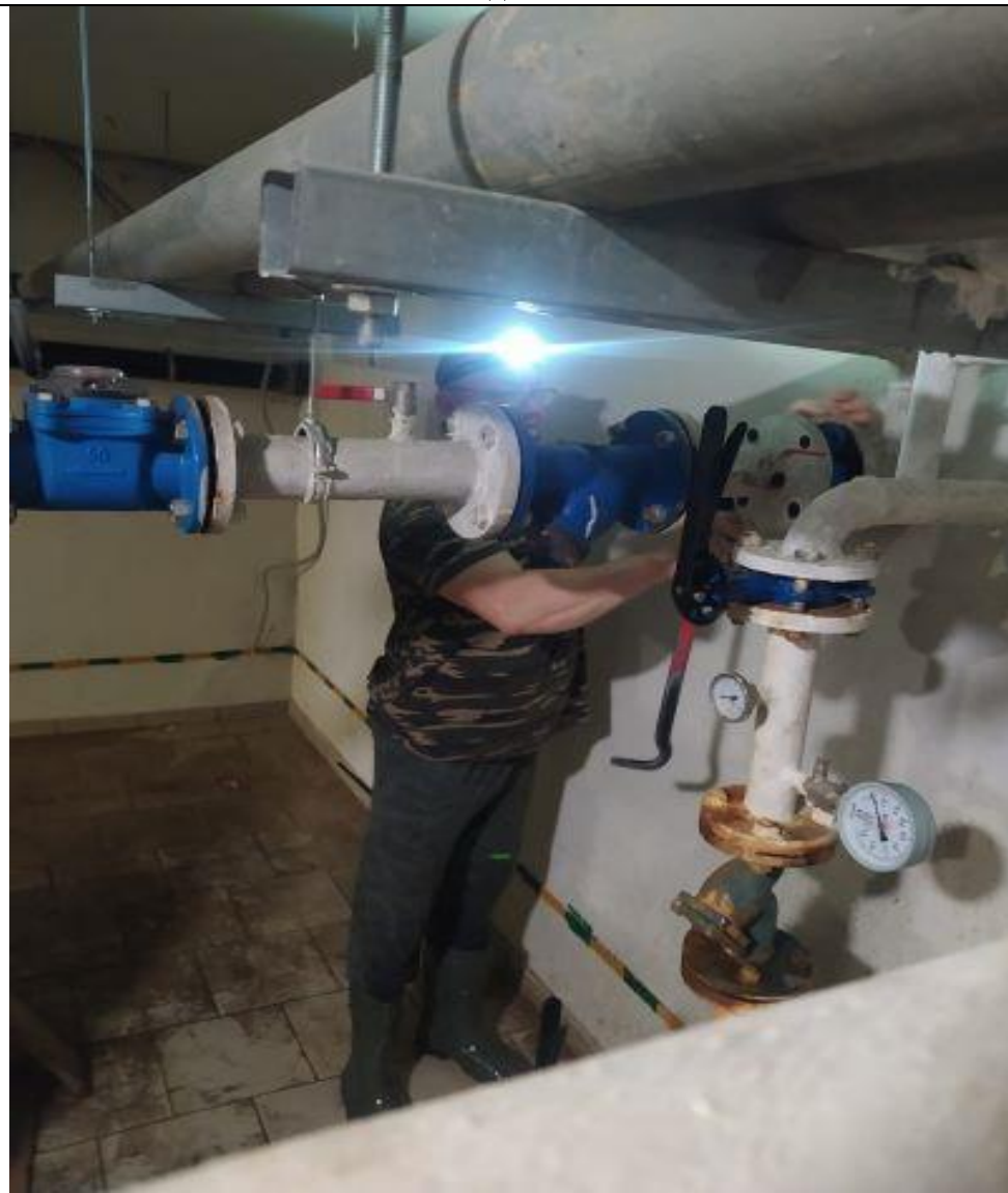
Замена задвижки ГВС
