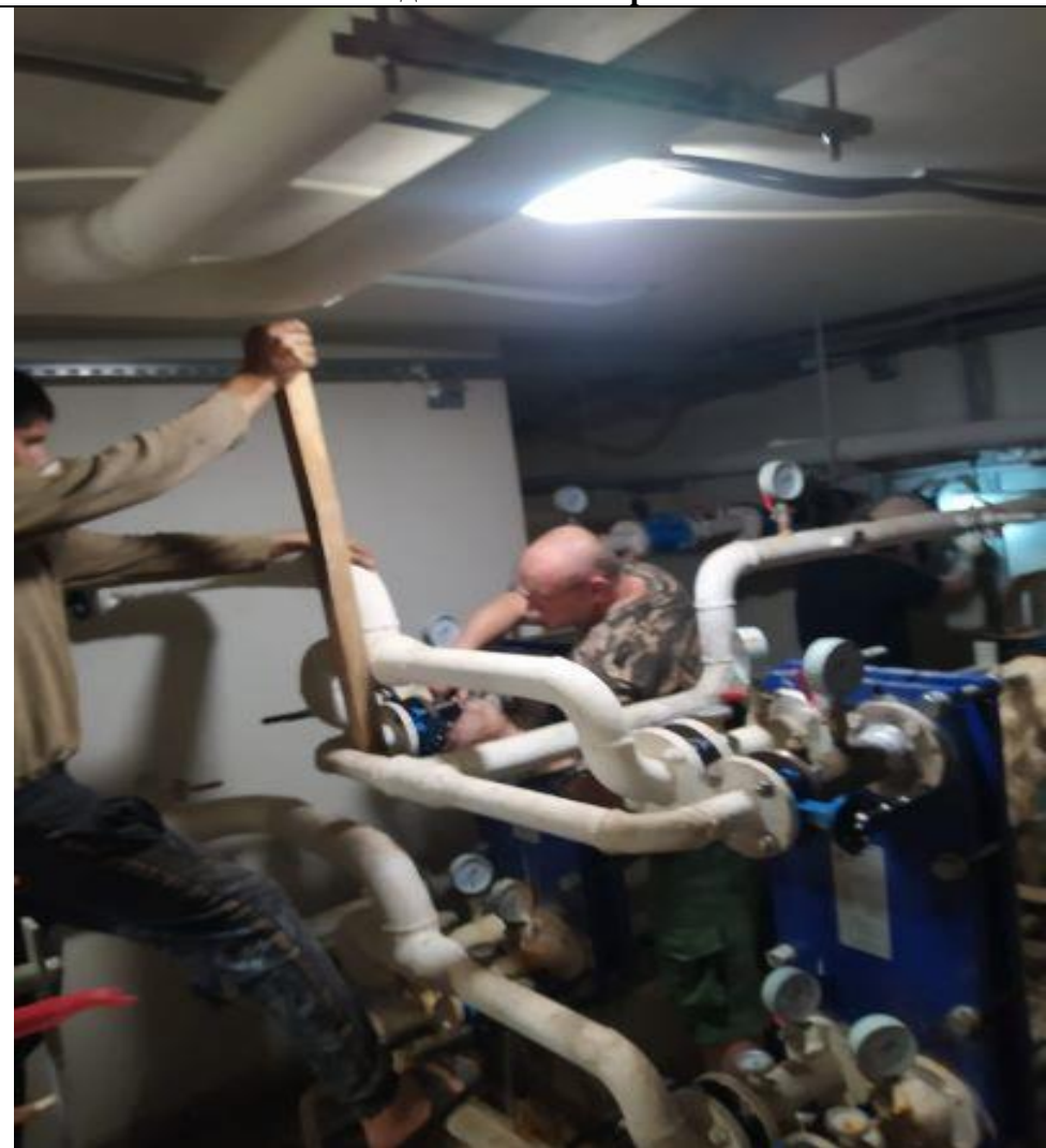
Замена задвижек ГВС в рамке ИТП
