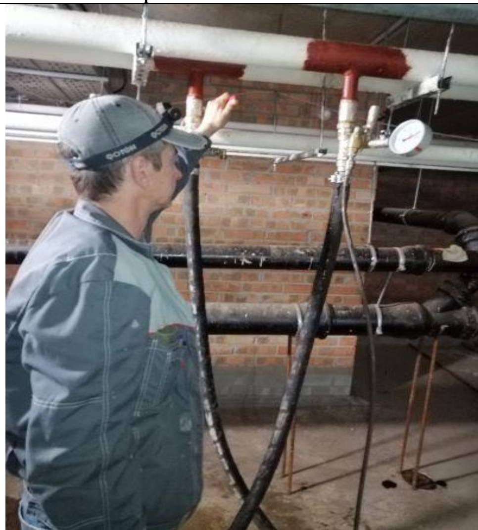
Промывка системы отопления
