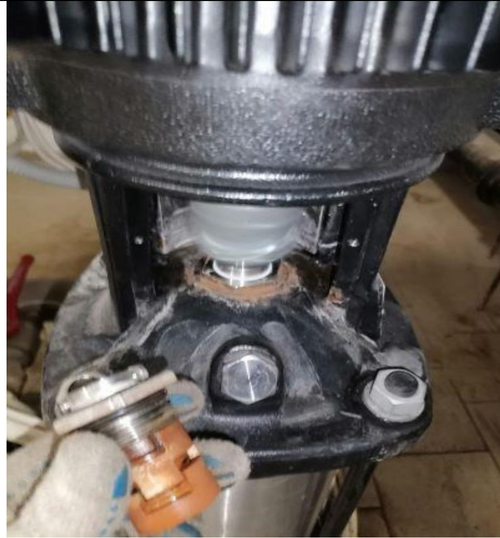
Замена торцевого уплотнения насоса 1 станции повышения давления ХВС
