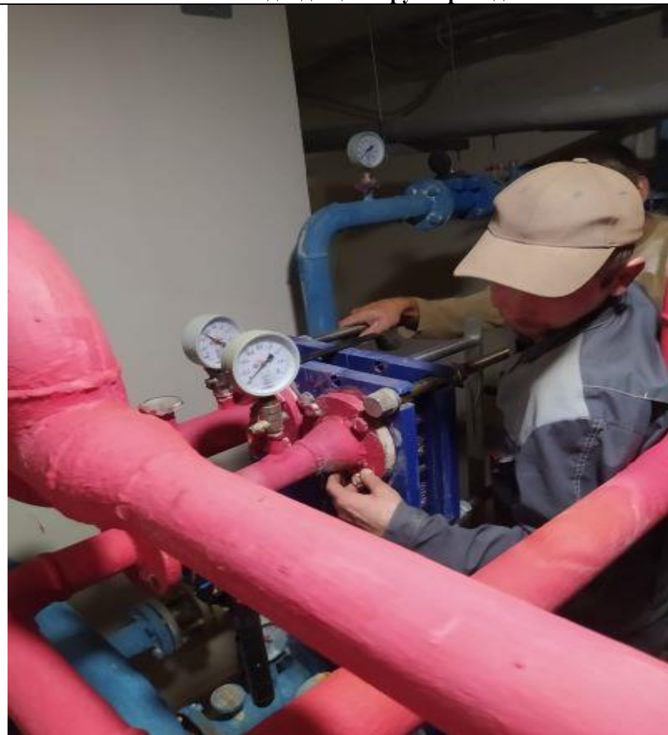
Ремонт подводящего трубопровода
