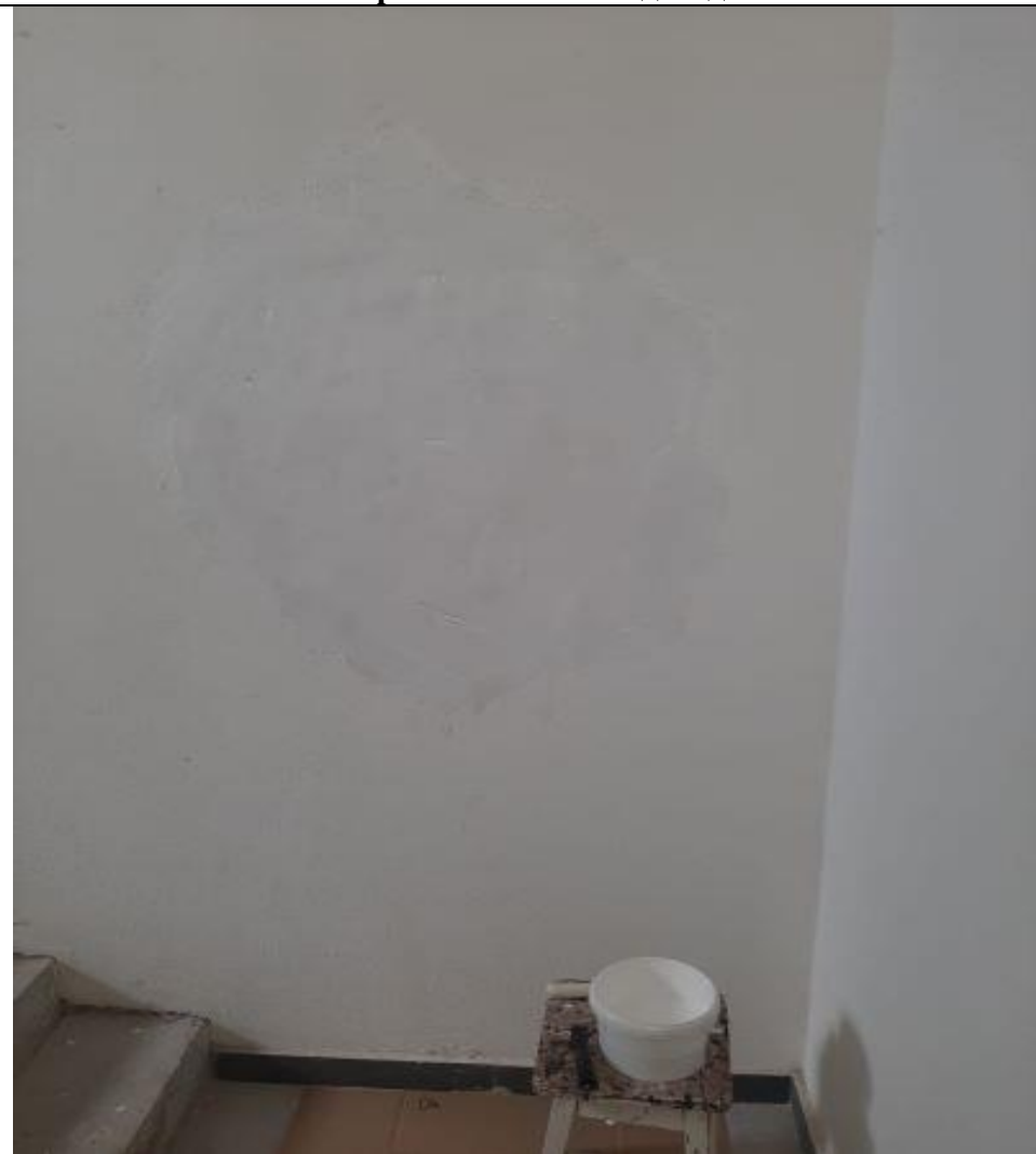
Покраска стены в подъезде
