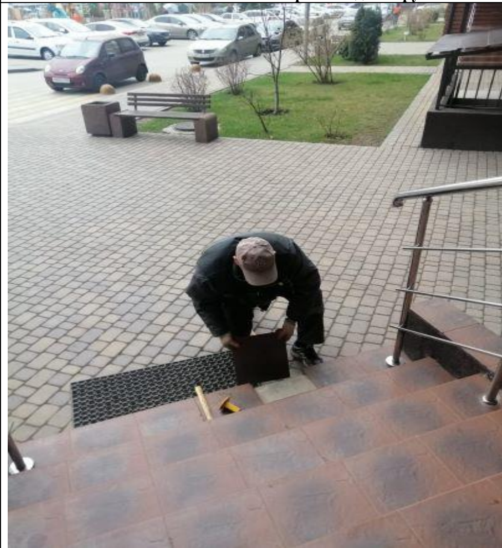
Ремонт плитки лестничного марша входной группы
