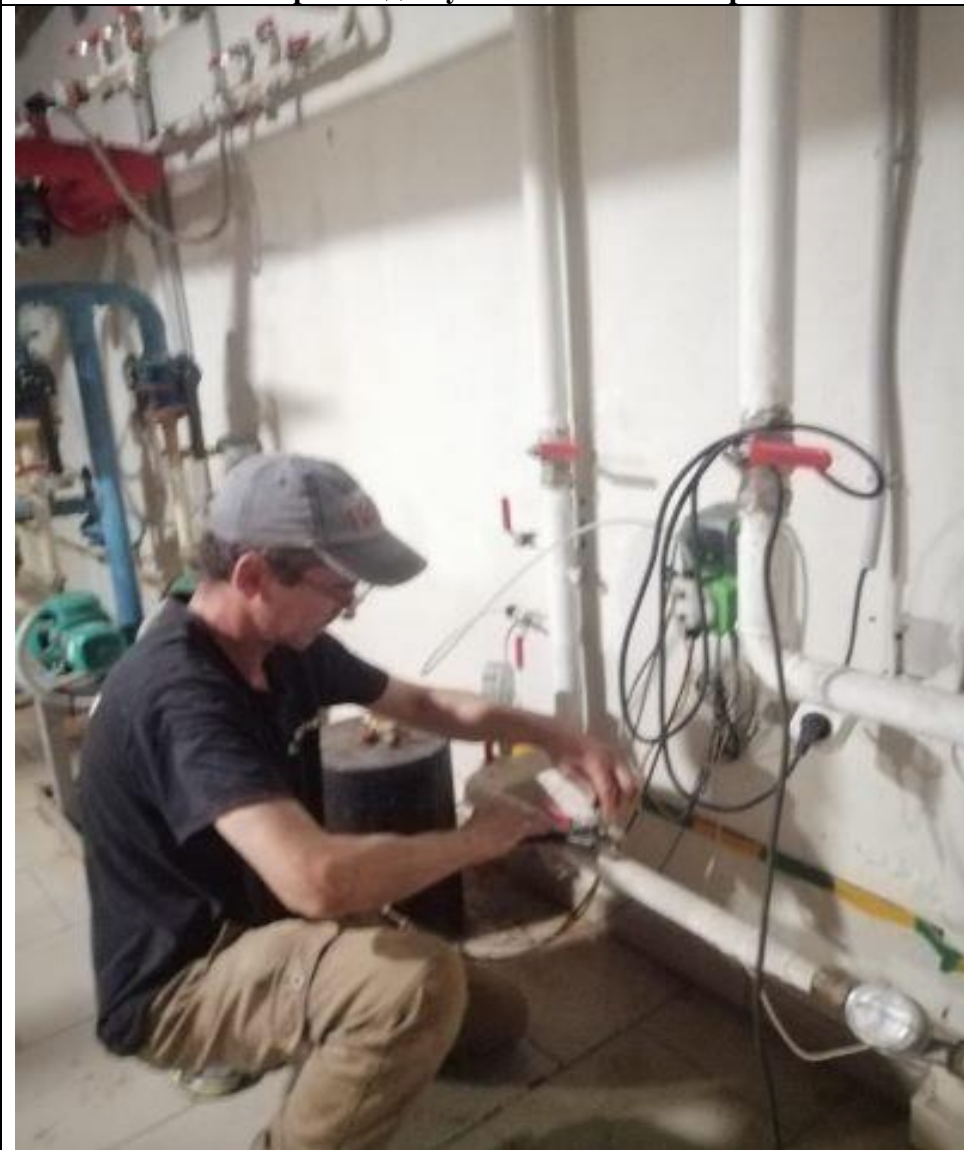
Замена кранов для установки манометров ГВС
