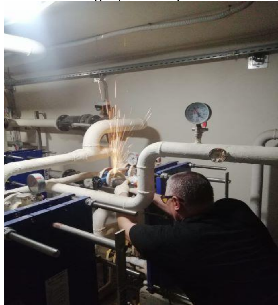
Ремонт трубопровода ГВС в рамке ИТП
