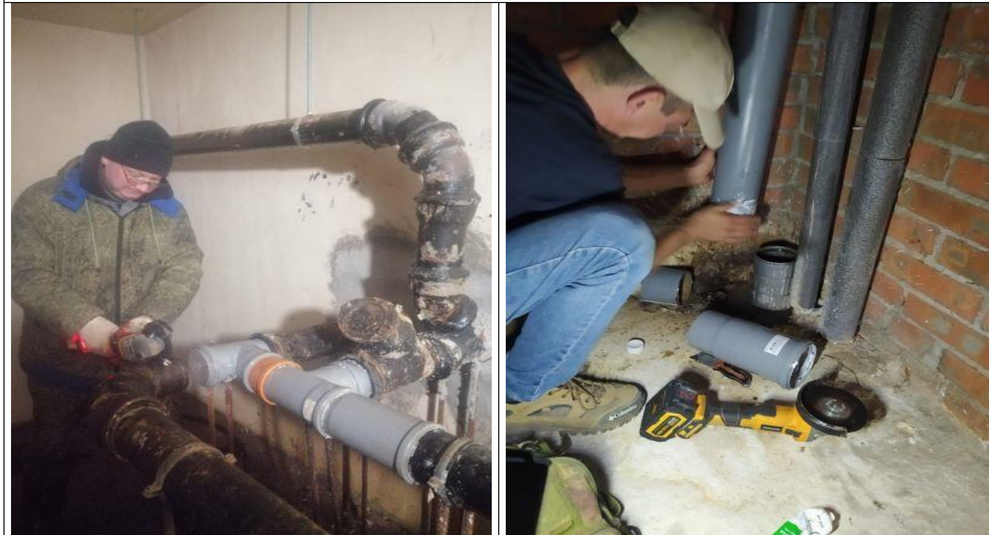
Ремонт канализационного стояка
