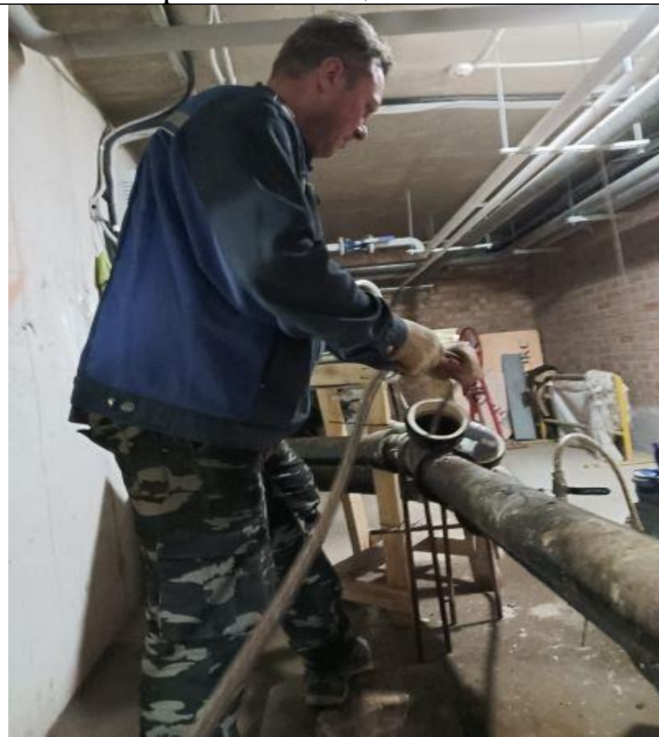
Прочистка канализационного лежака
