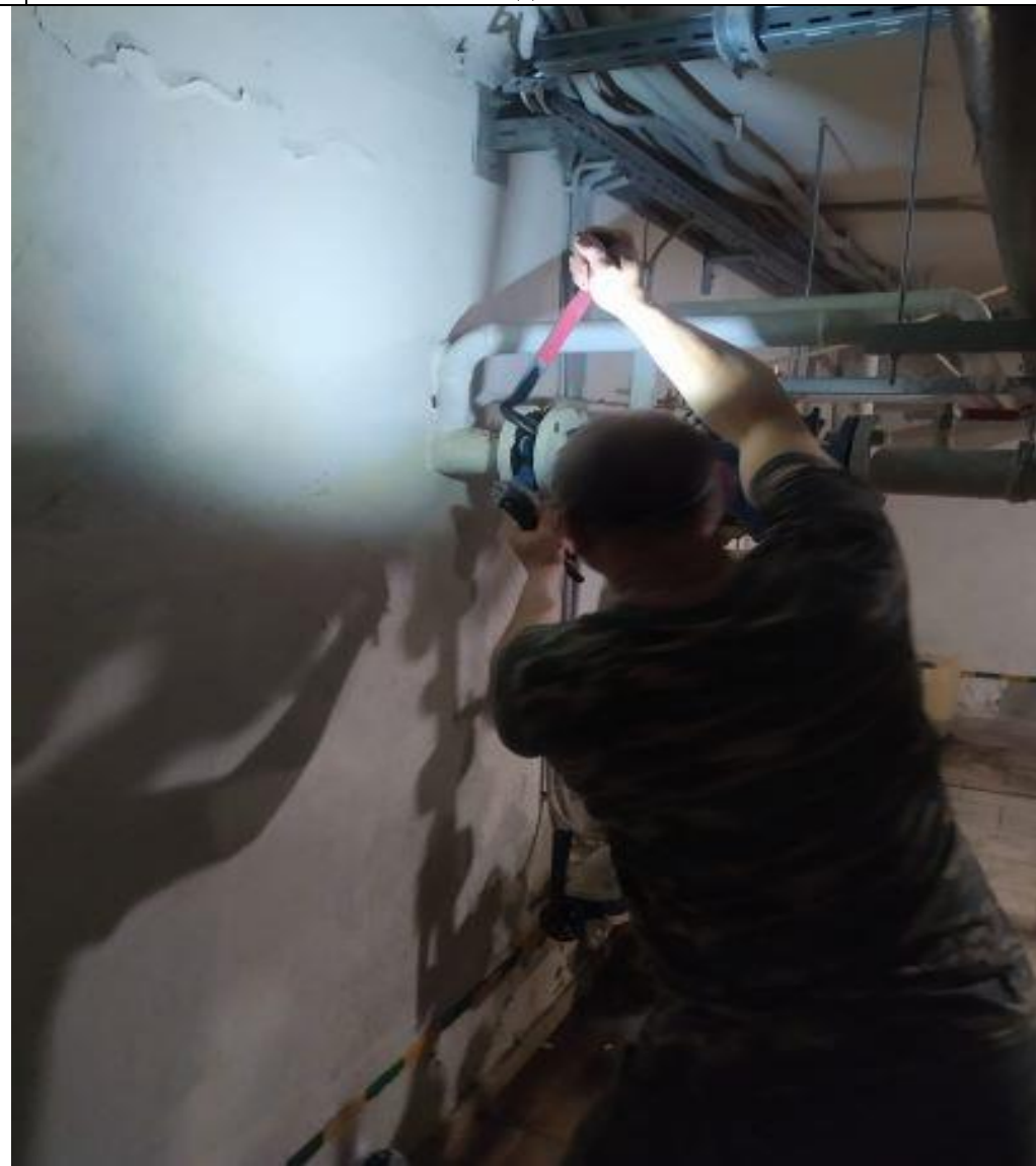
Замена задвижки ГВС
