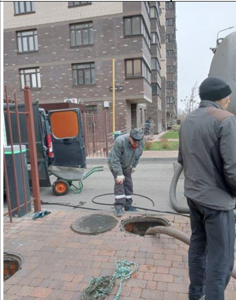
Чистка вводных теплокамер
