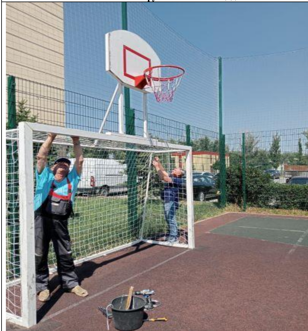
Замена сетки на футбольной площадке
