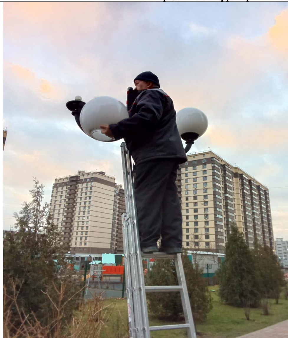
Замена ламп светильника на придомовой территории
