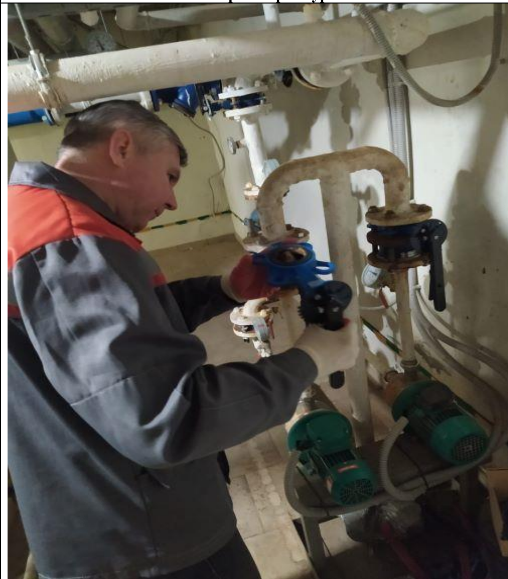
Замена запорной арматуры ГВС
