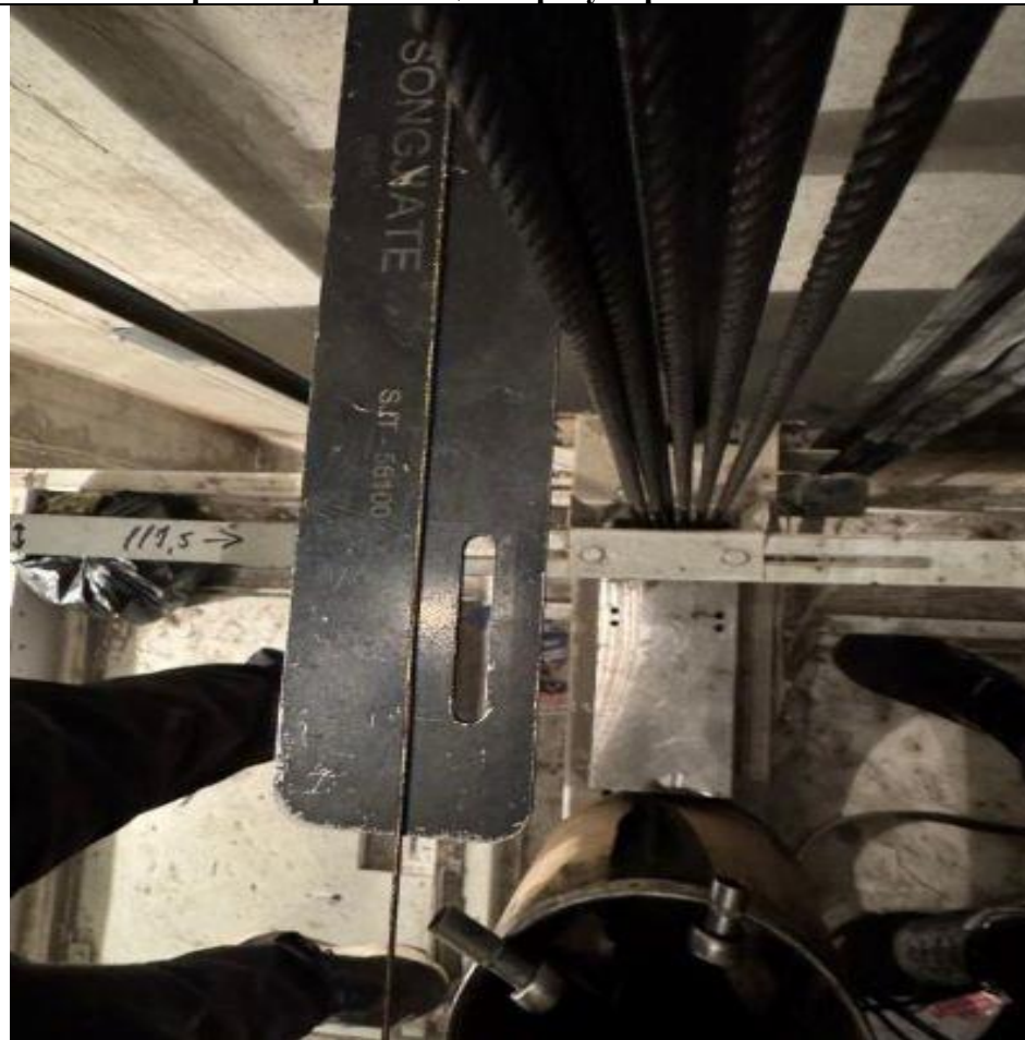
Выворот направляющих и регулировка штихмоста.
