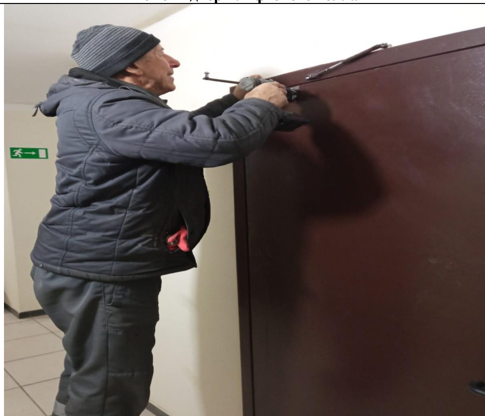
Ремонт двери лифтового холла
