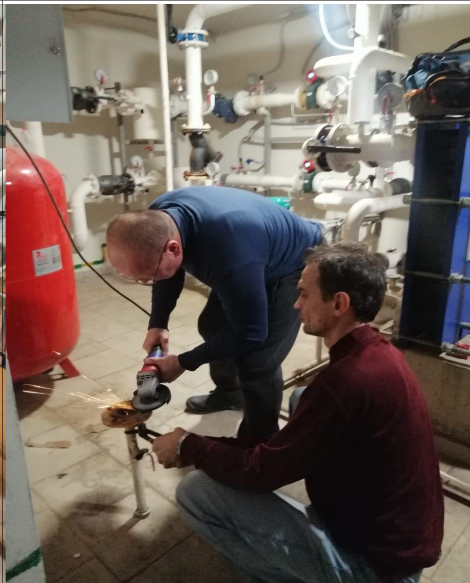
Замена задвижек и обратного клапана системы ГВС
