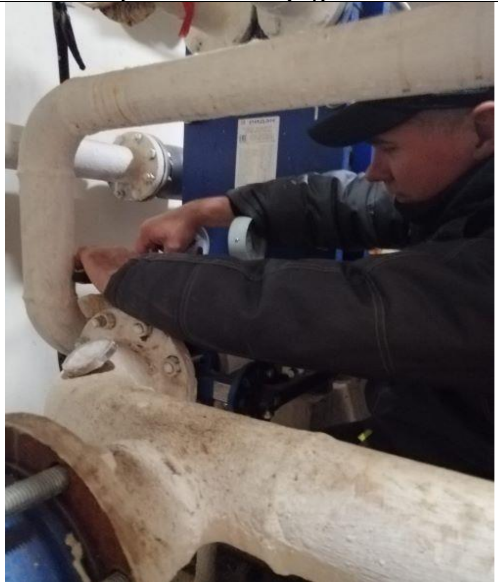
Устранение течи на температурном датчике
