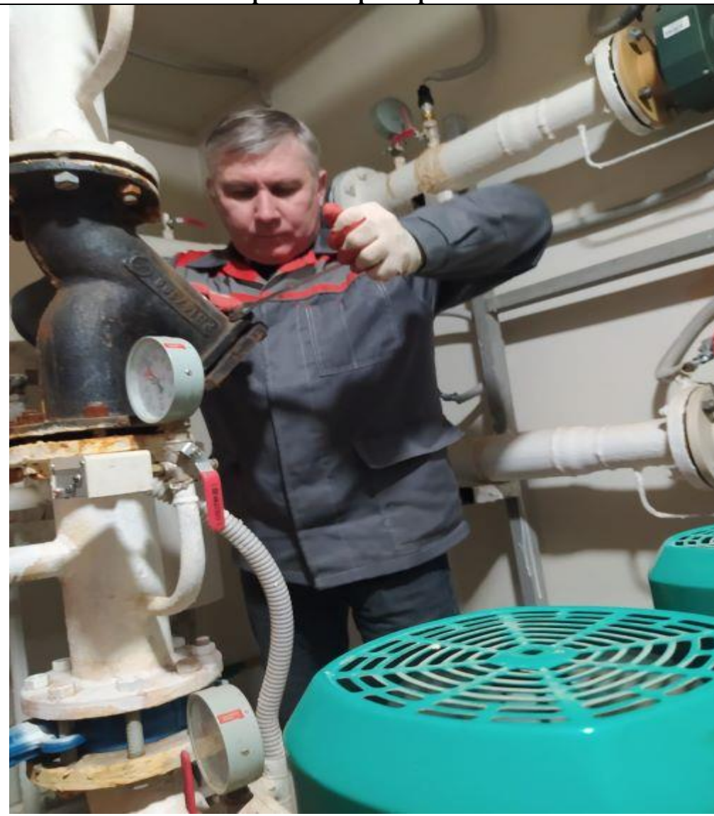
Прочистка фильтра ГВС
