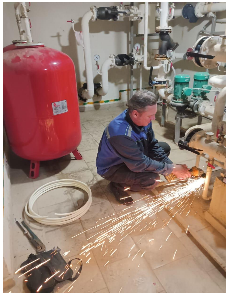
Монтаж трубы для сбросника .
