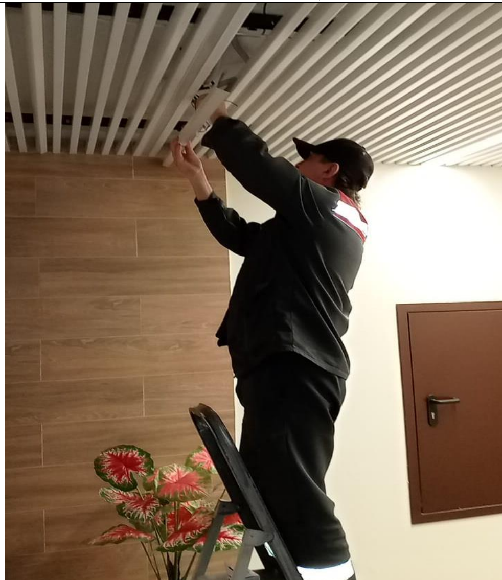
Замена светильника в местах общего пользования
