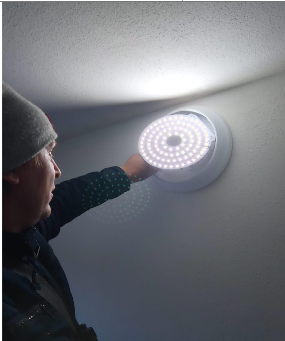
Замена светильника в местах общего пользования
