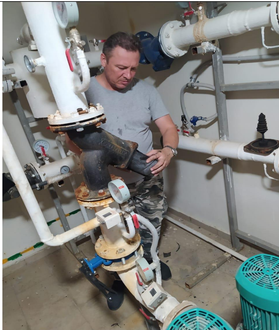
Чистка фильтров отопления
