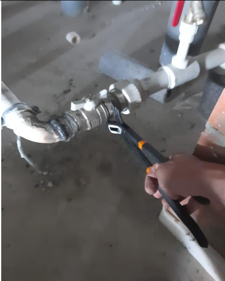
Замена крана на тех. этаже
