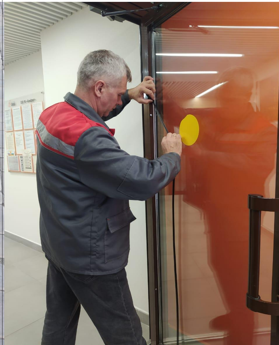
Ремонт подъездной двери
