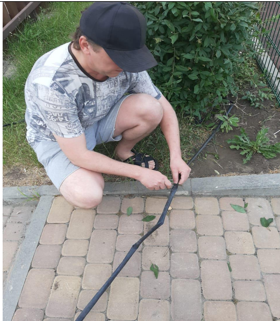
Монтаж капельного полива
