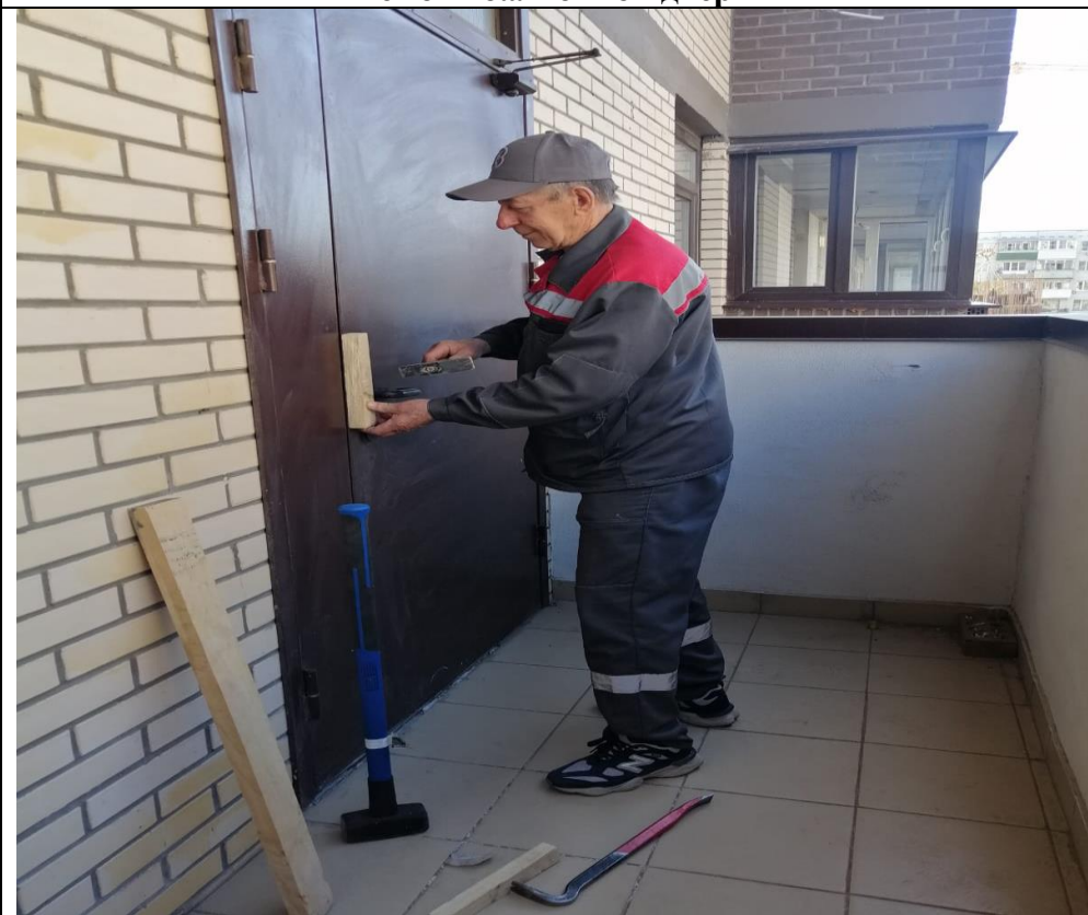
Ремонт балконной двери
