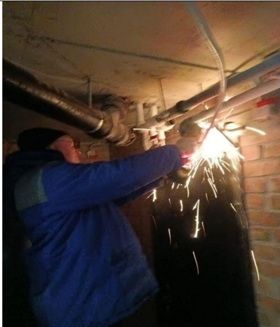
Ремонт стояка системы водоснабжения
