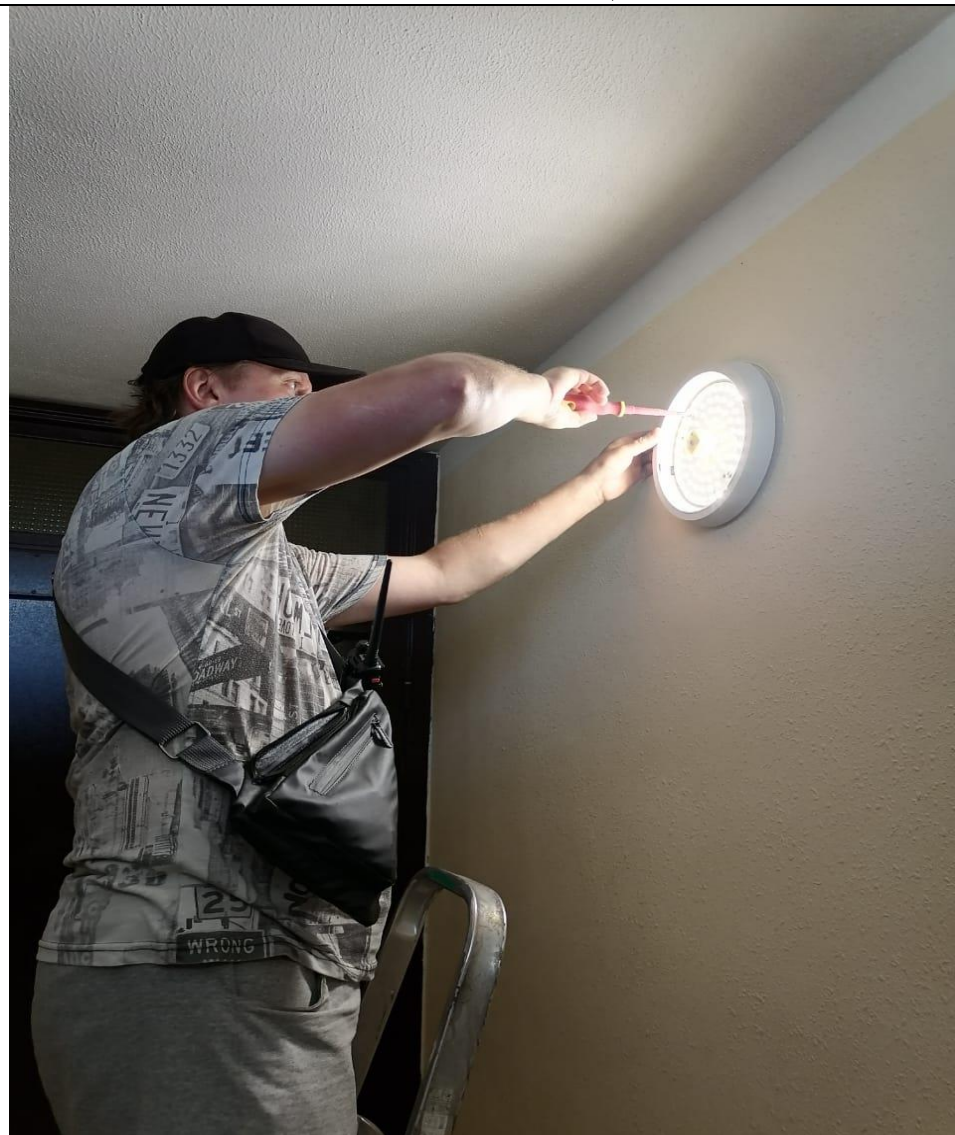
Замена светильника в местах общего пользования
