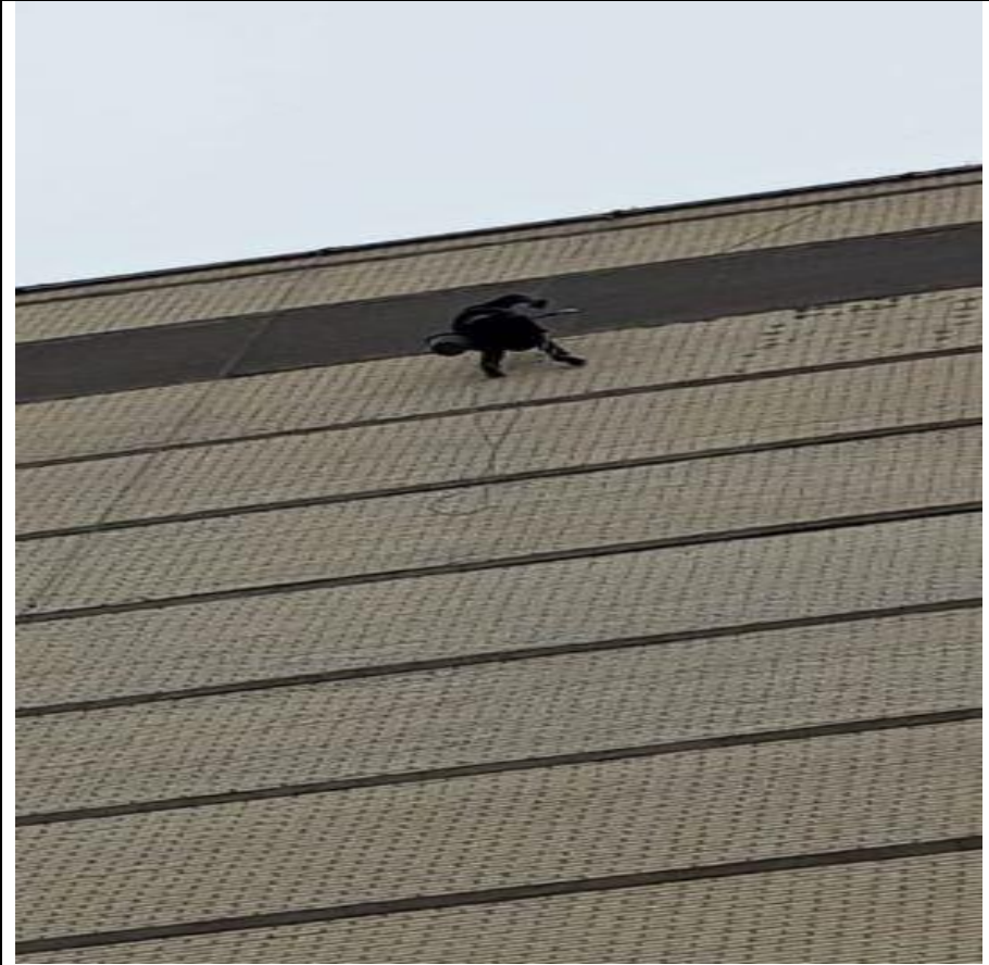
Восстановление теплоизоляционного слоя
