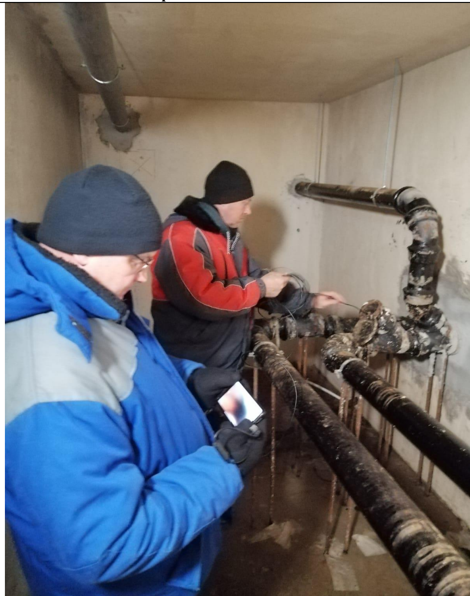
Осмотр канализационного лежака
