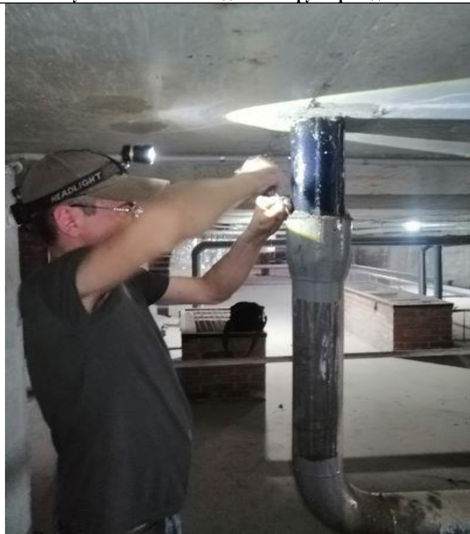
Ремонт уплотнительного соединения трубопровода ливневки
