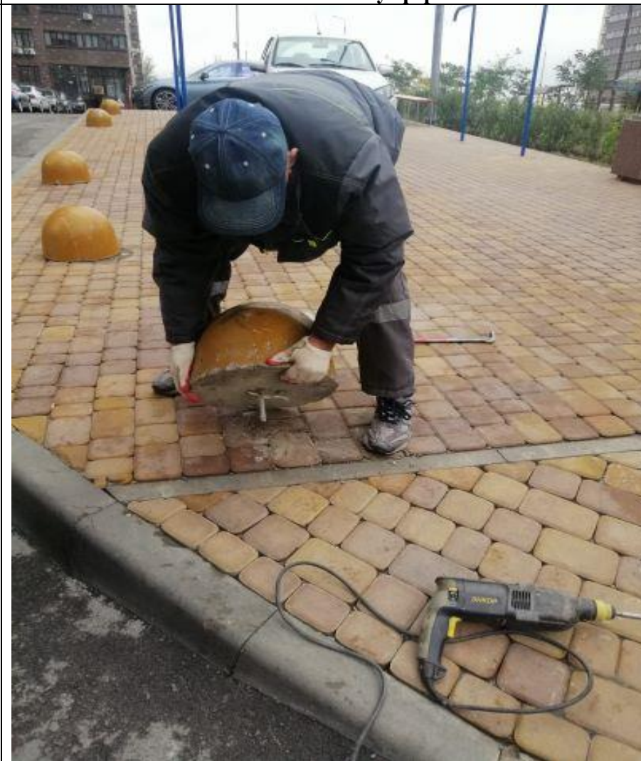
Установка полусфер
