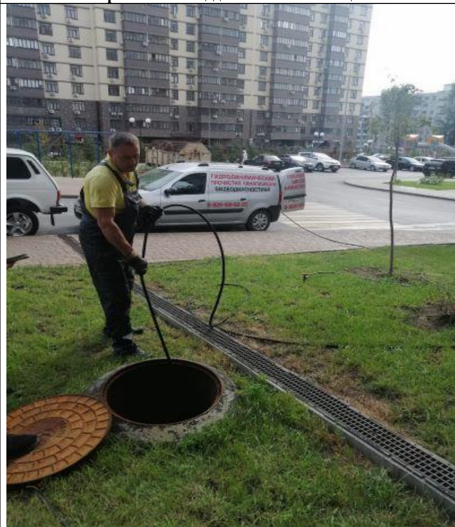
Прочистка общедомовой канализации
