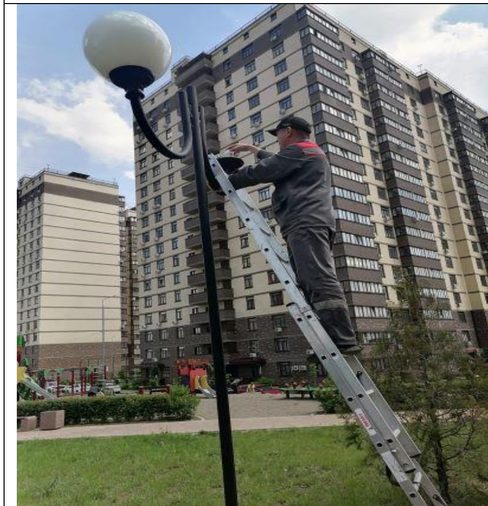
Замена светильников уличного освещения
