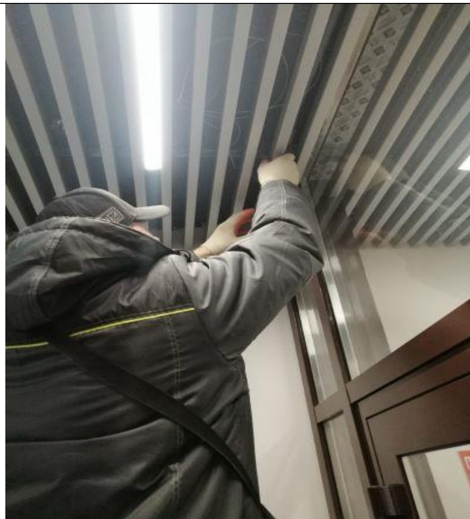
Ремонт потолочных панелей
