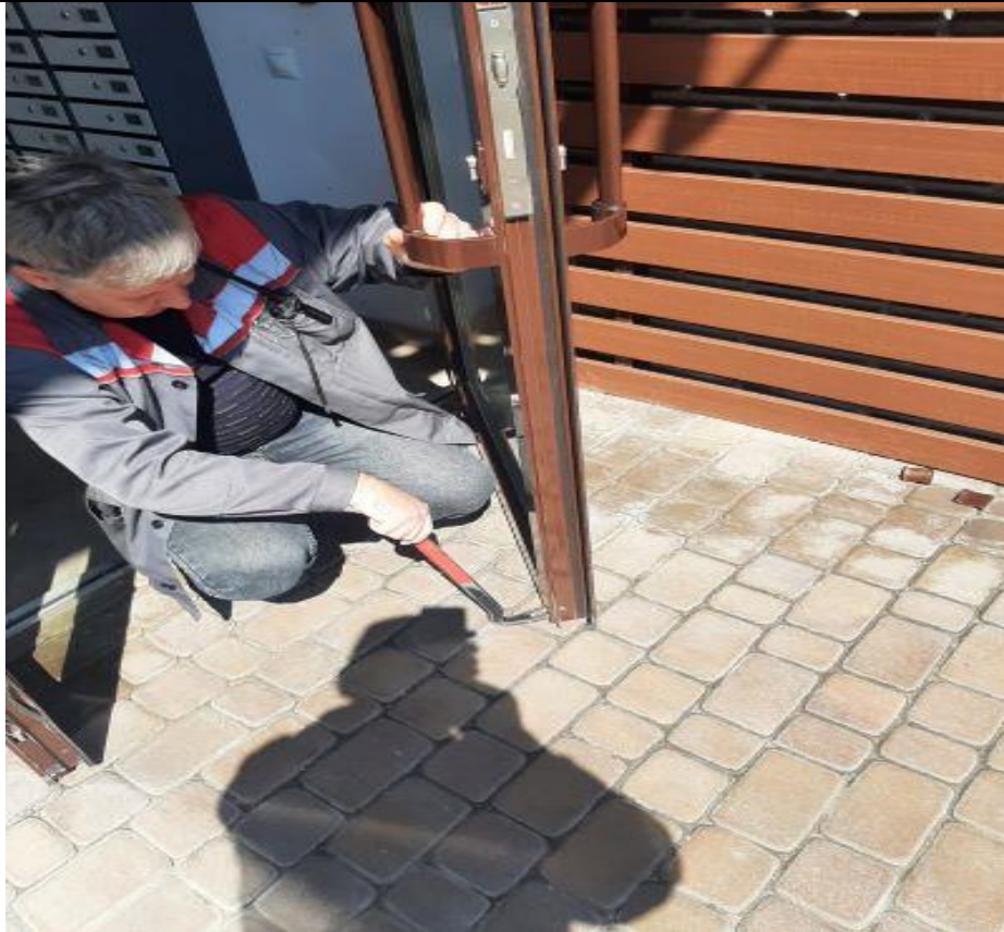
Регулировка двери
