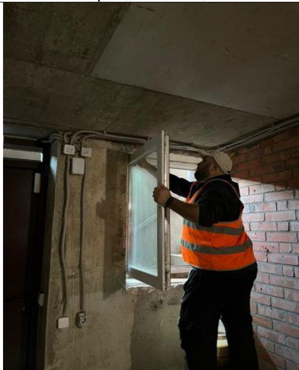
Уборка подвального помещения
