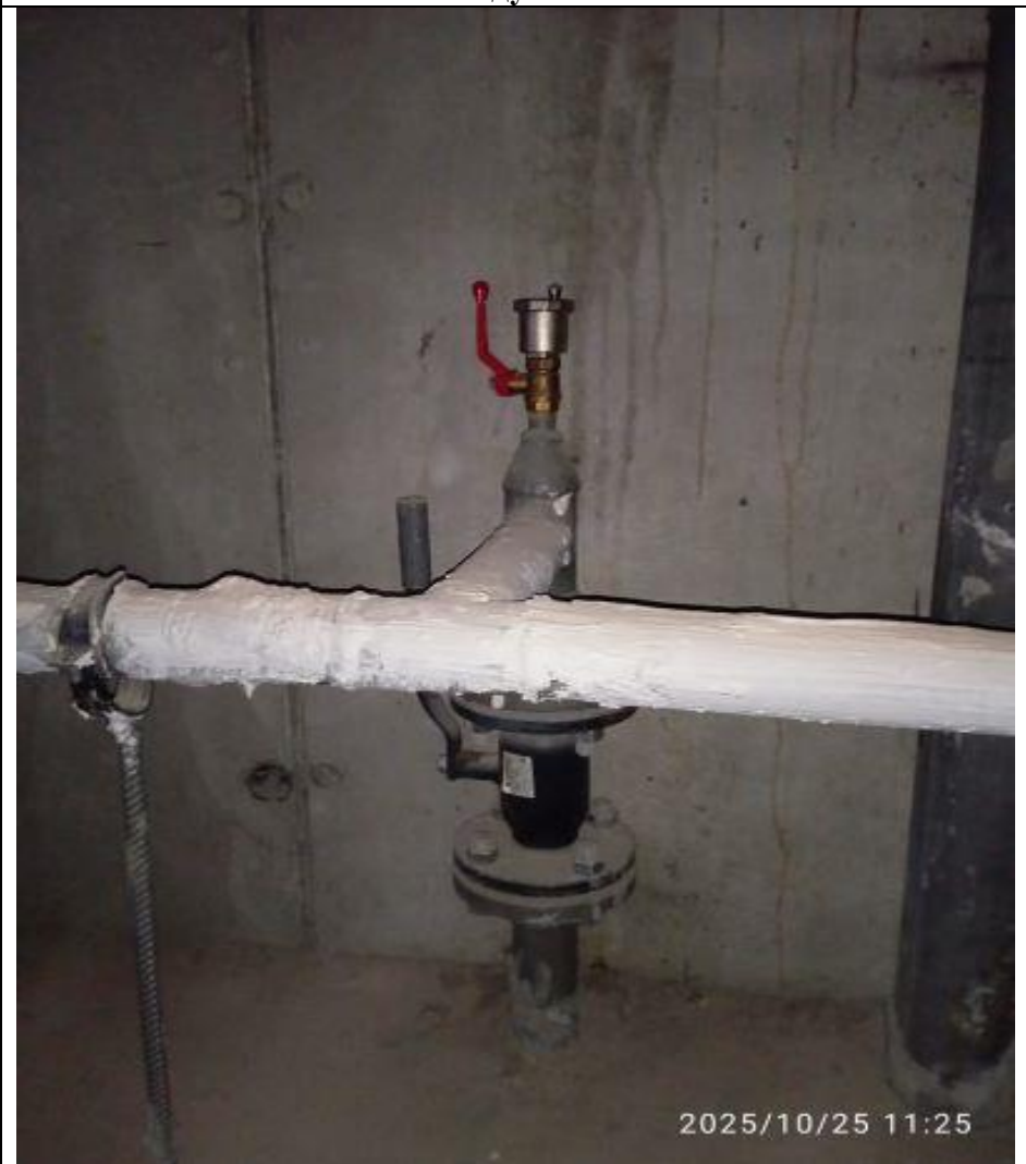
Установка автовоздушника на тех.этаже
