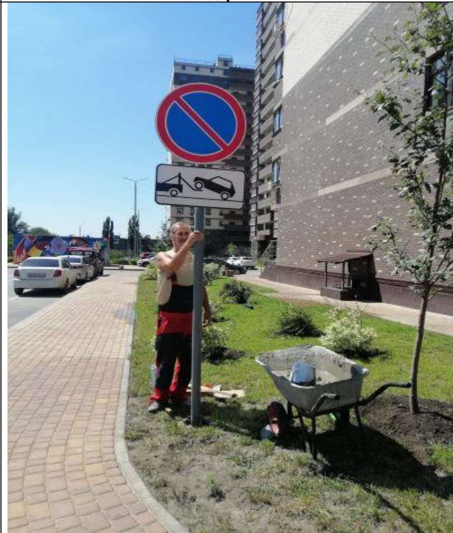
Установка дорожных знаков
