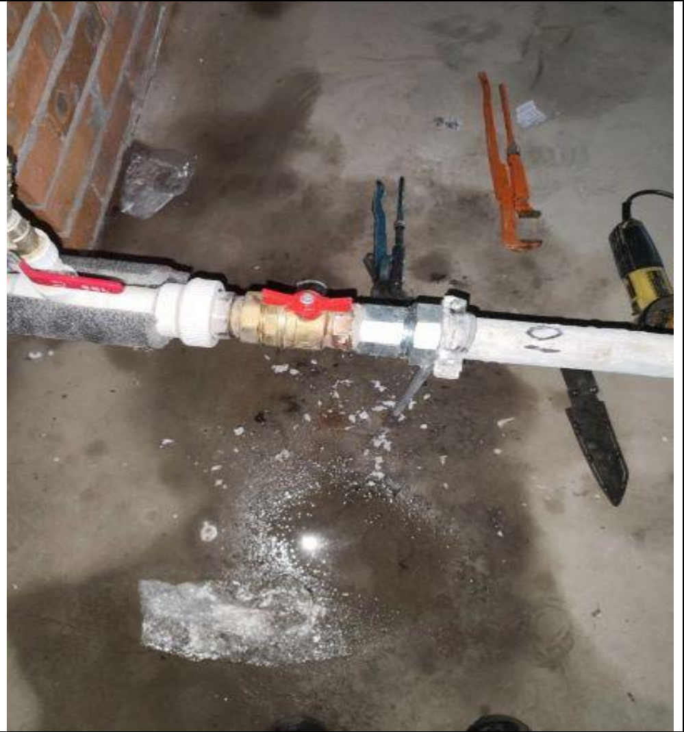
Замена резьбы на стояке
