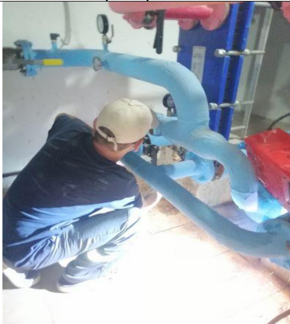
Установка сбросных кранов теплообменника
