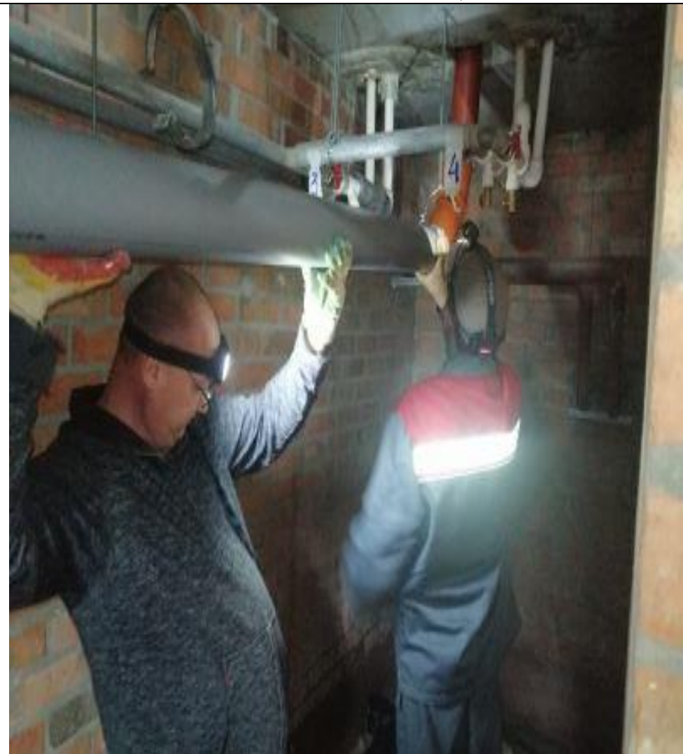
Замена стояка канализации
