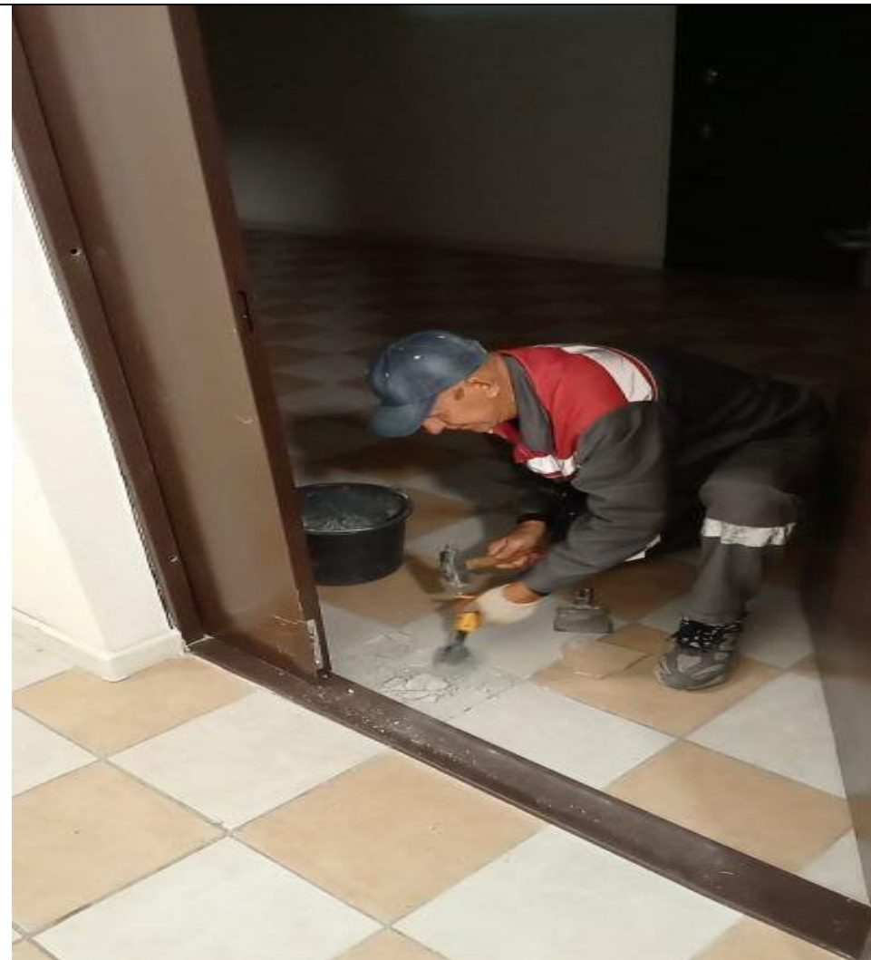
Замена плитки в МОП
