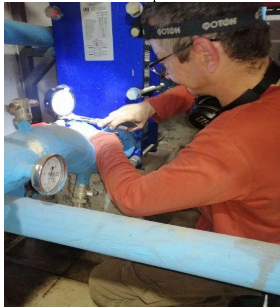
Замена манометров в ИТП
