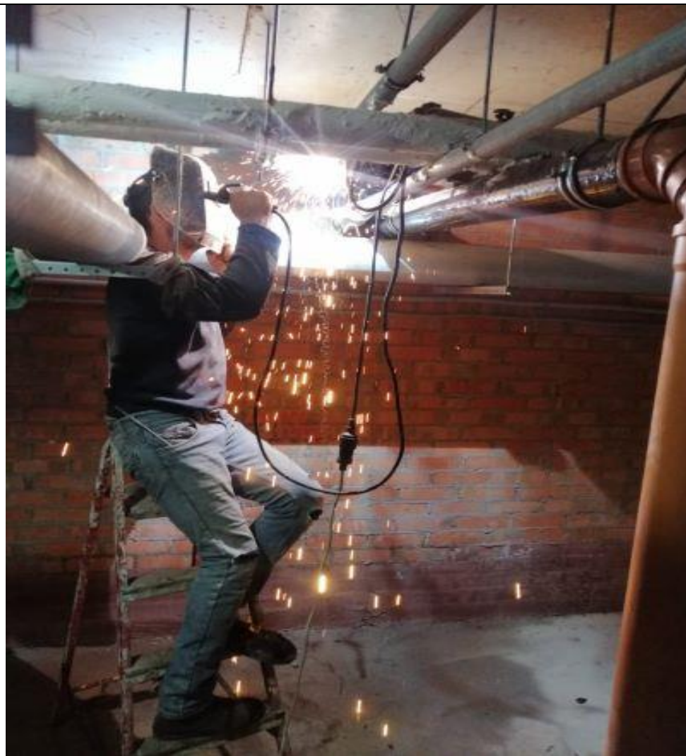
Ремонт стояка ГВС
