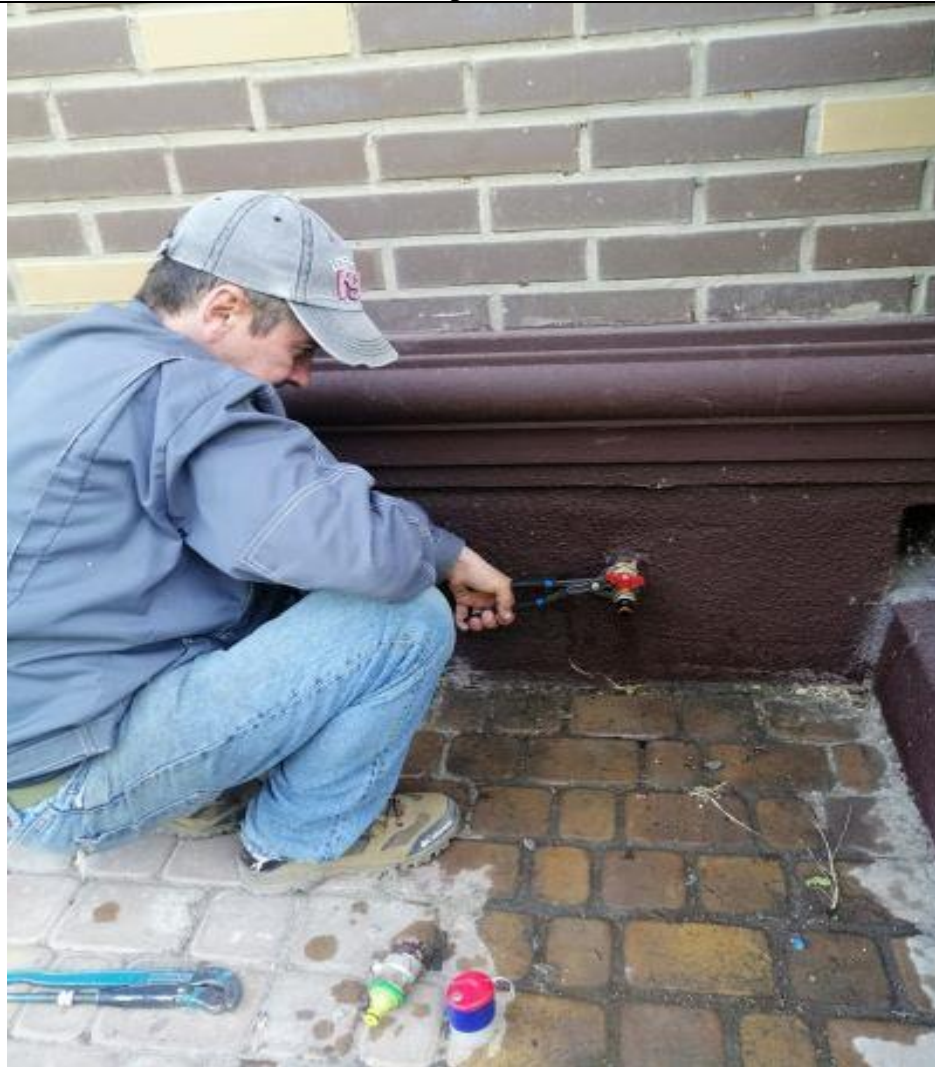
Замена крана полива
