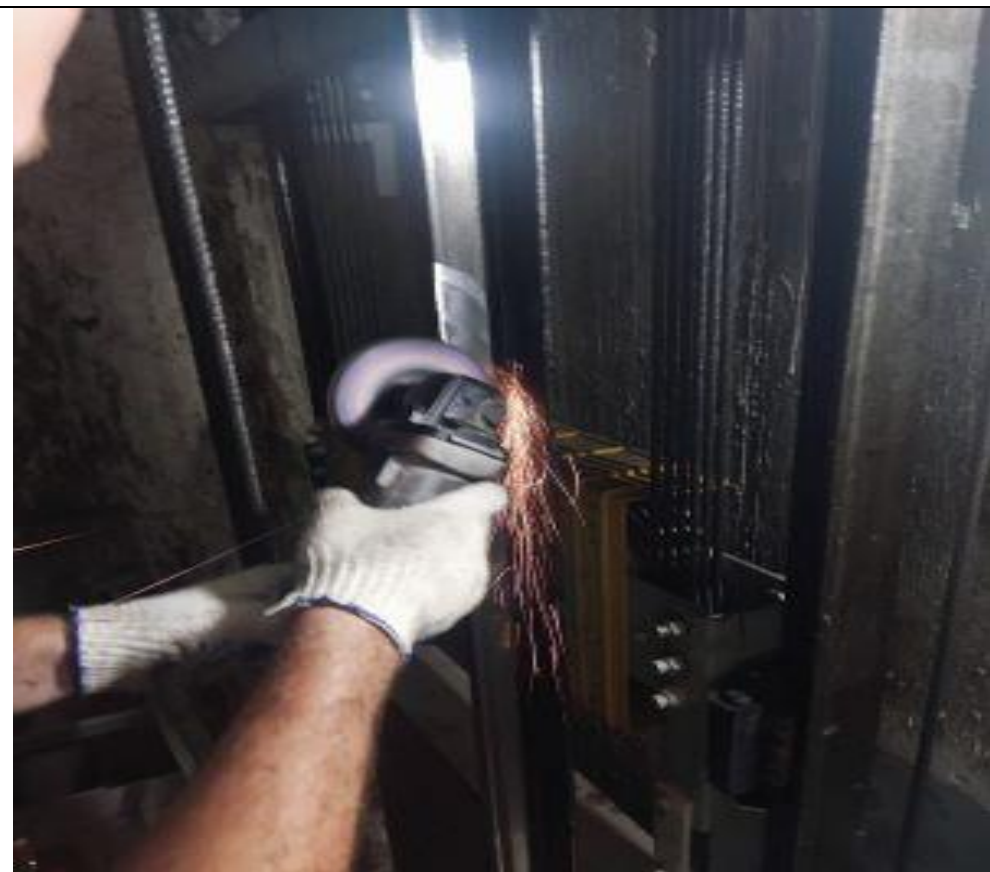
Шлифовка направляющих
