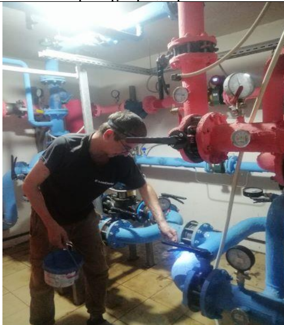
Покраска трубопровода в рамке ИТП
