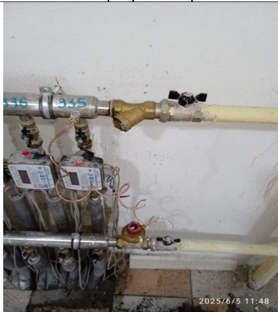
Замена фильтра в коллекторной
