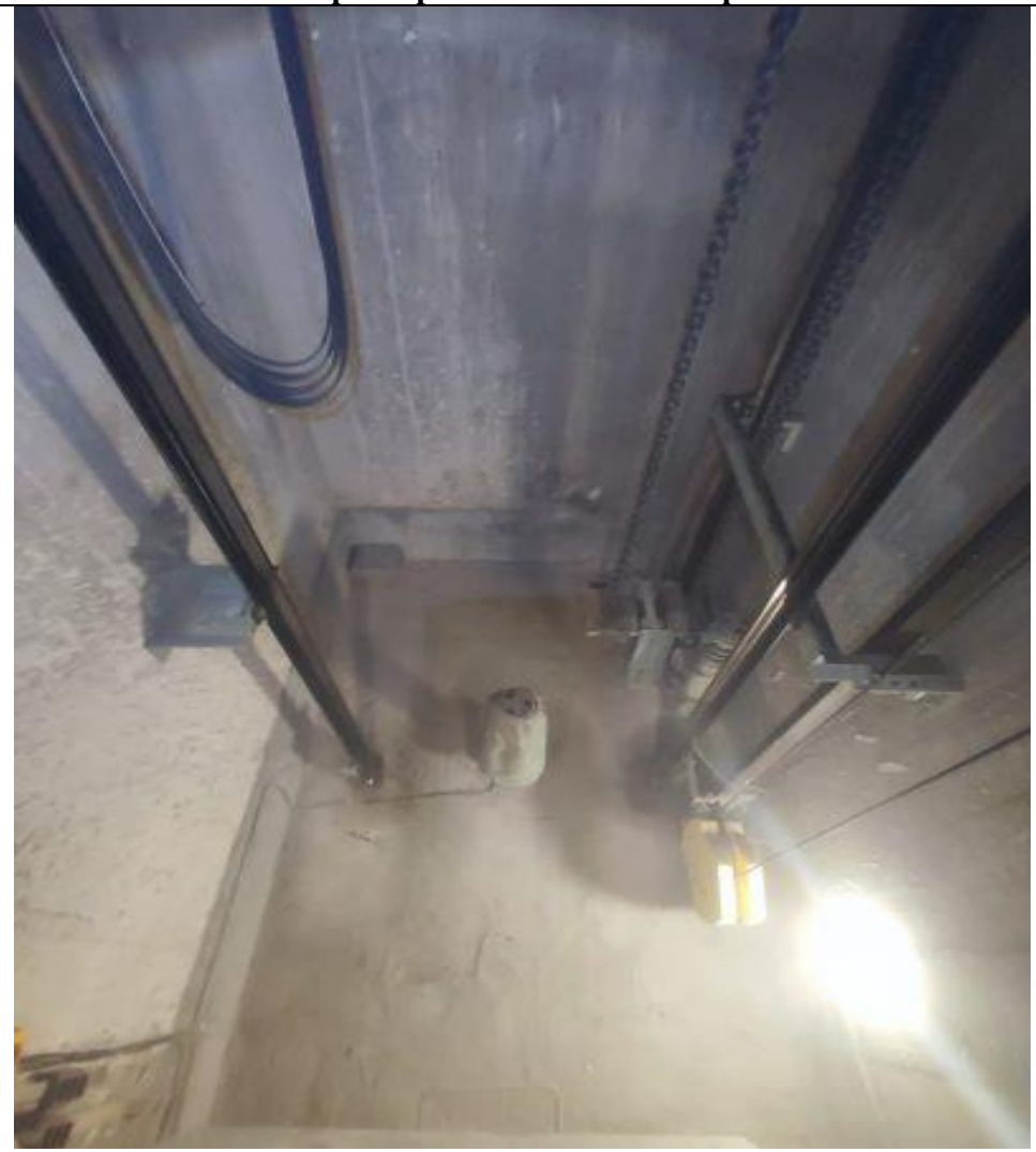
Уборка приямков шахты лифта
