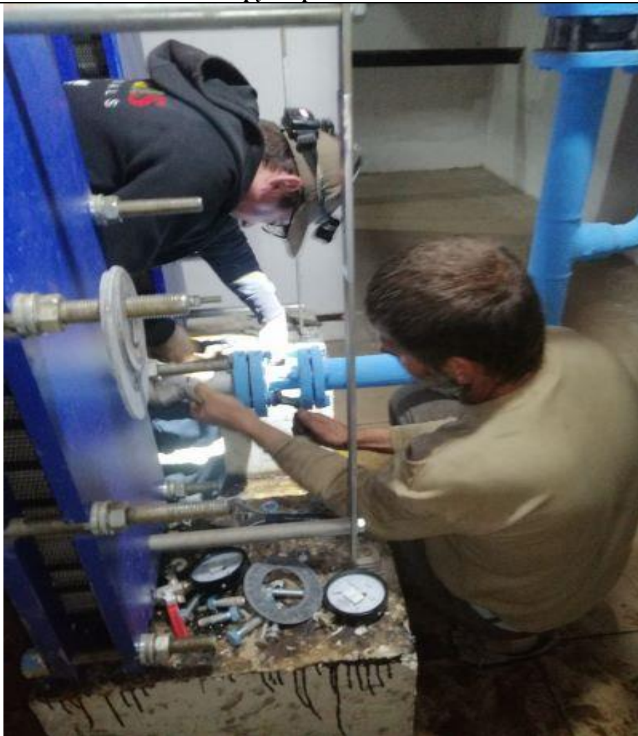
Ремонт трубопровода ГВС в ИТП
