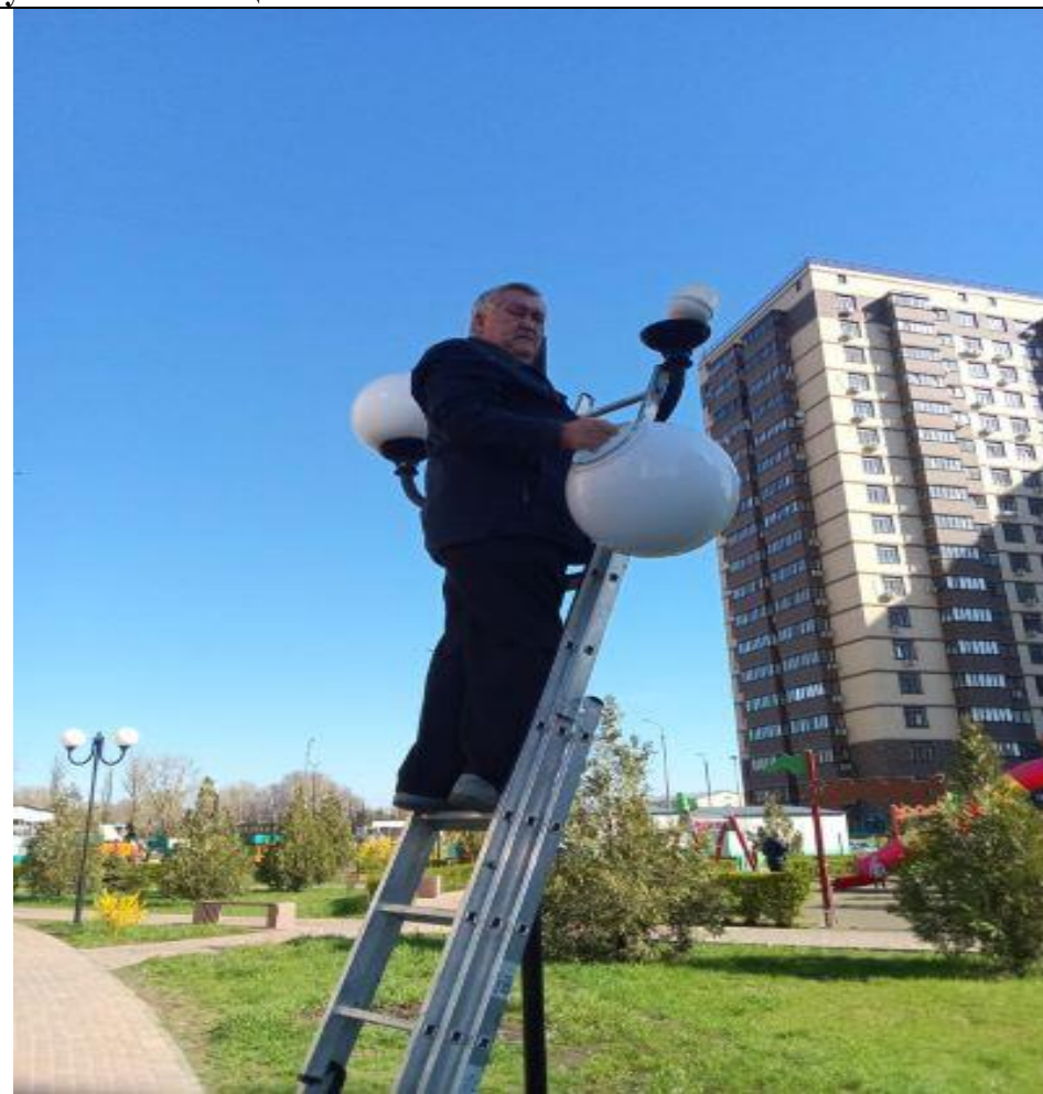
Замена светильников уличного освещения
