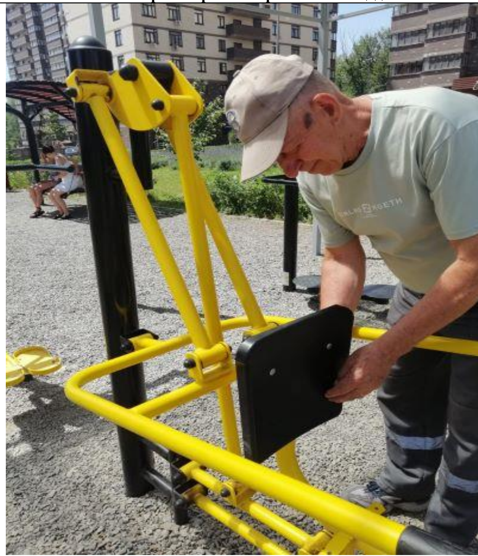
Ремонт тренажера на спортивной площадке
