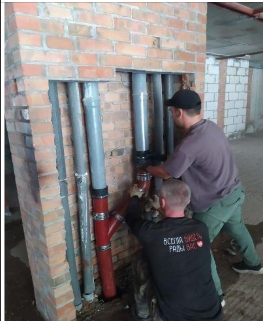
Ремонт канализационного стояка
