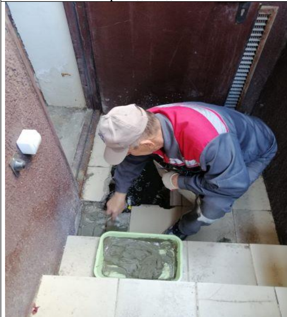
Замена плитки при входе в подвальное помещение
