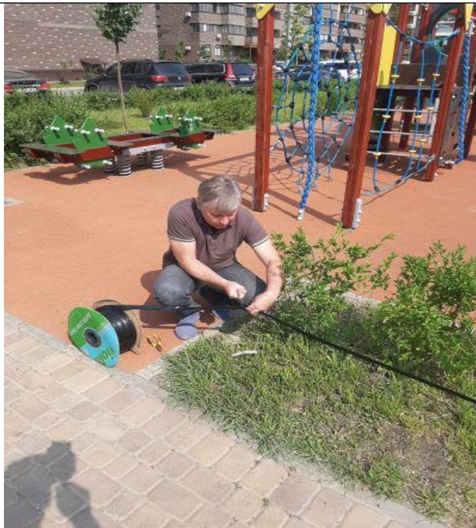
Ремонт капельного полива
