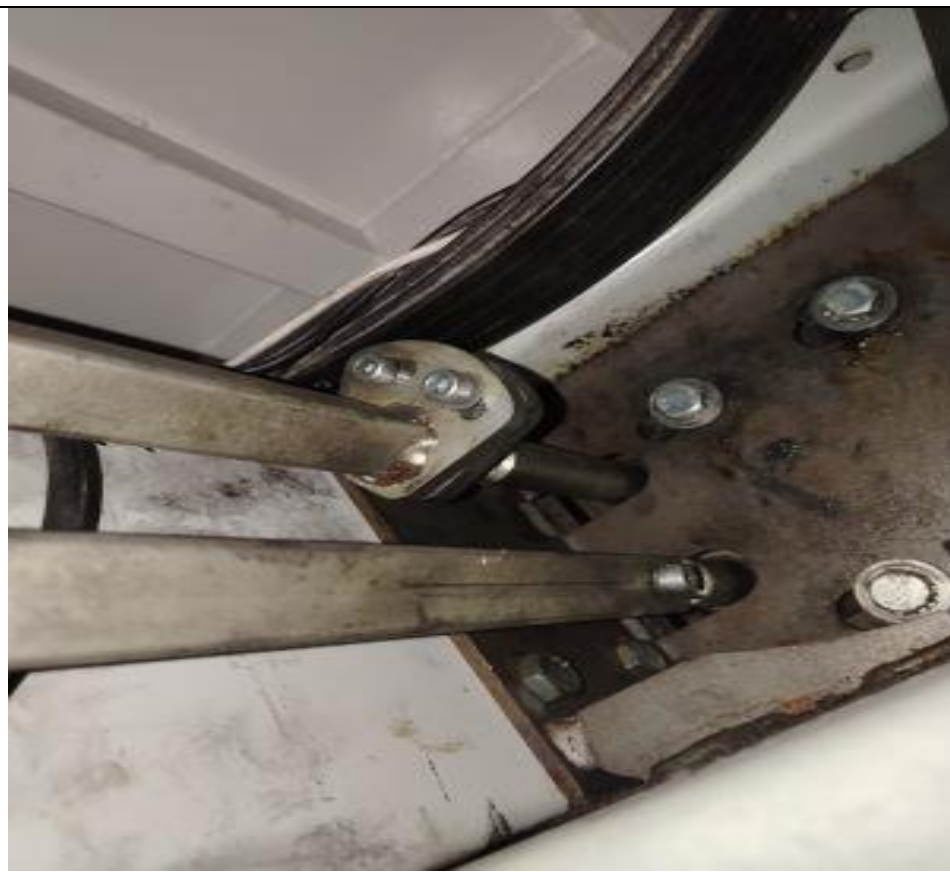
Замена блоков ловителей
