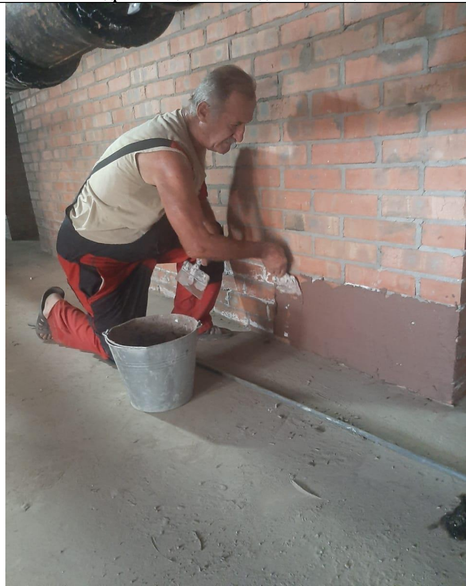
Гидроизоляция стен кладовых помещений
