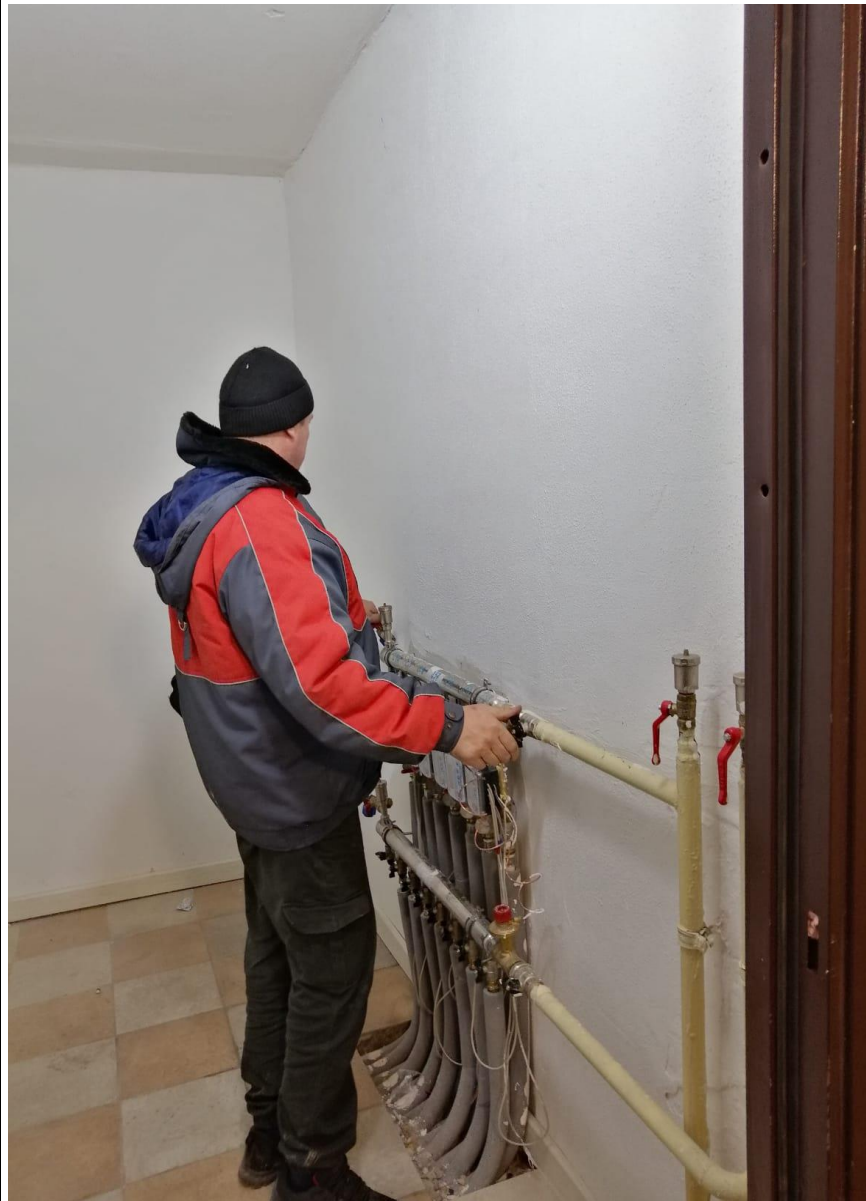
Ревизия и осмотр поэтажных коллекторных отоплений.
