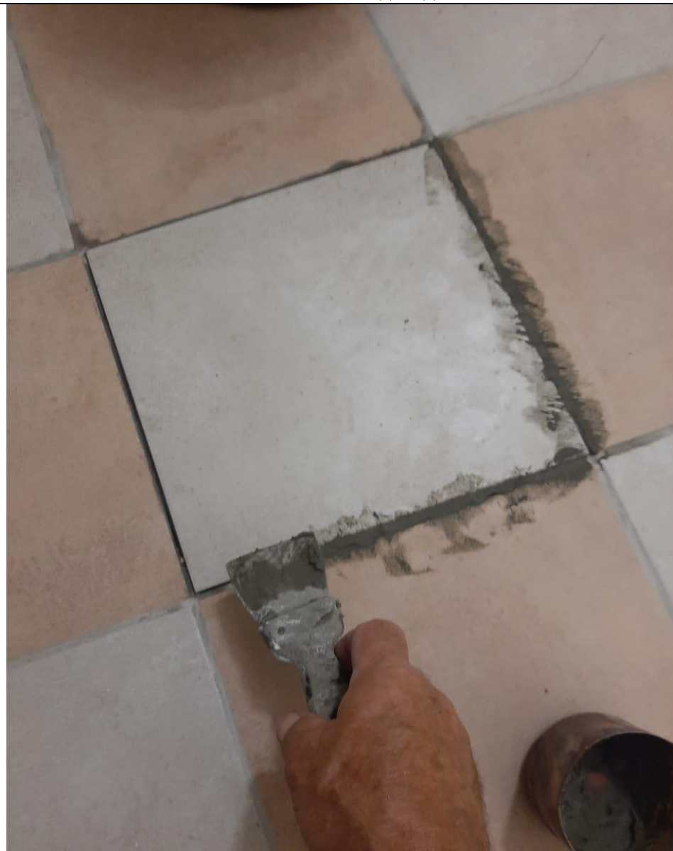
Замена плитки 3 подъезд 2 этаж
