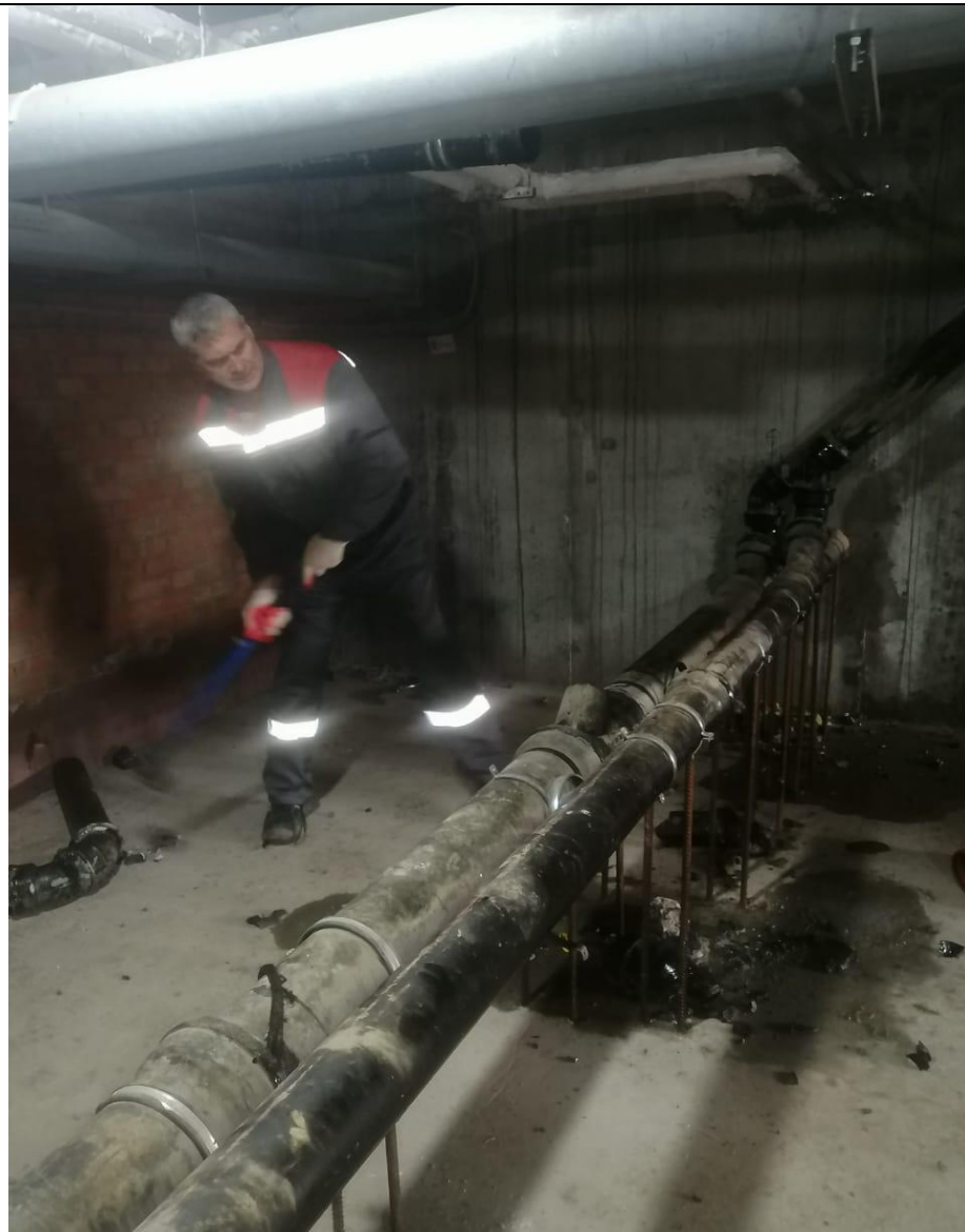
Замена канализационных труб
