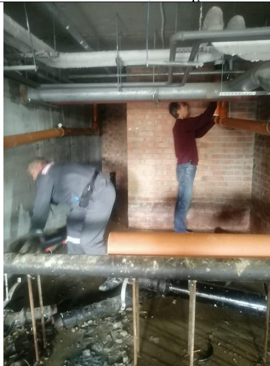
Замена канализационных труб
