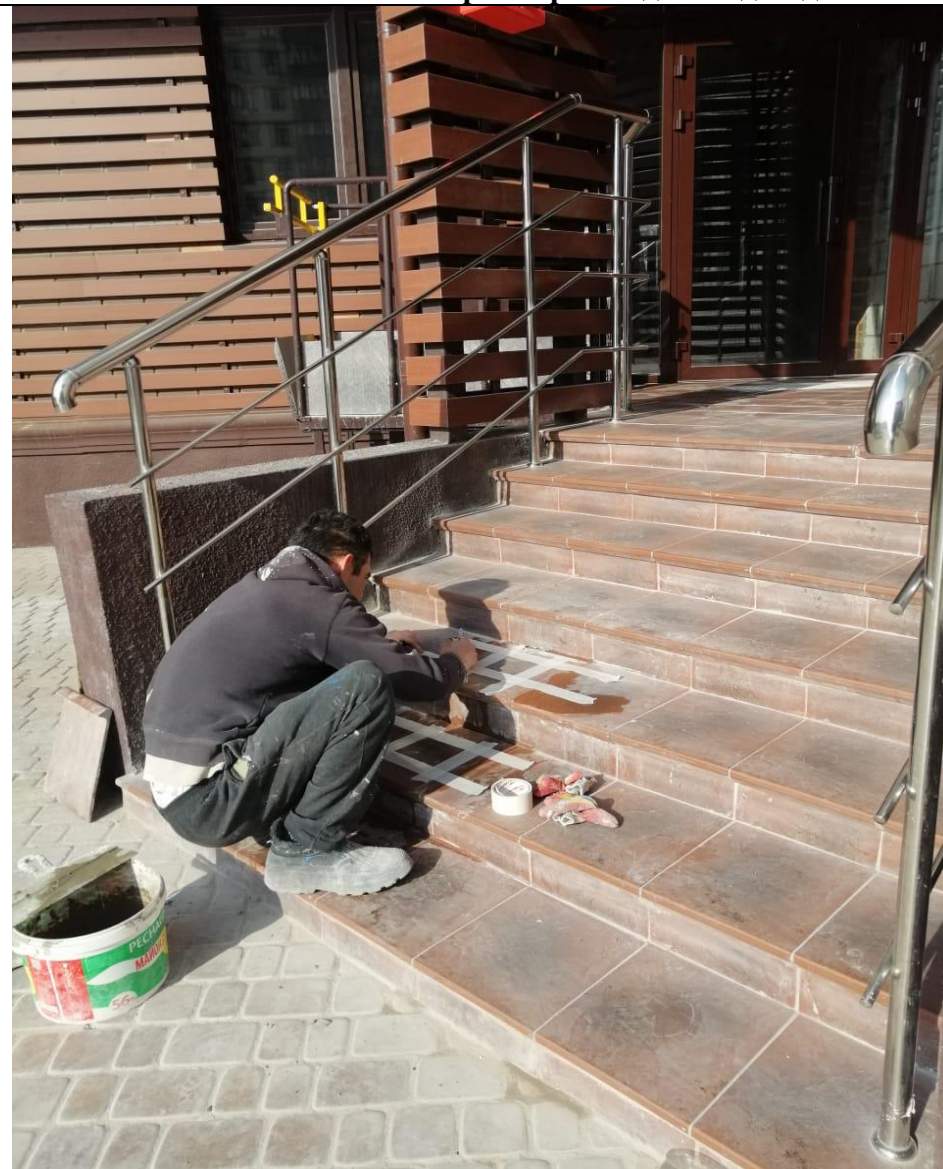
Ремонт лестничного марша при входе в подъезд 3
