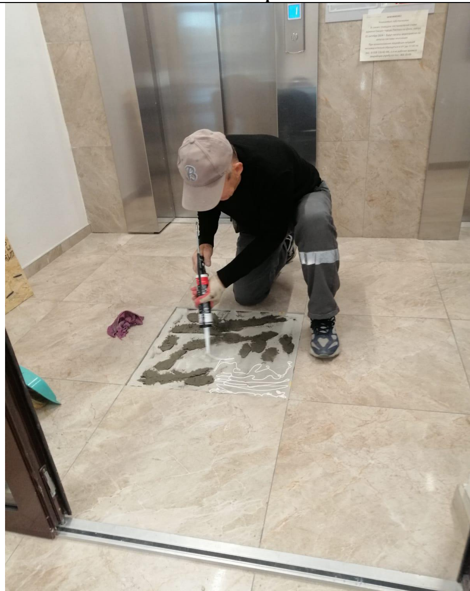
Замена плитки в лифтовом холле
