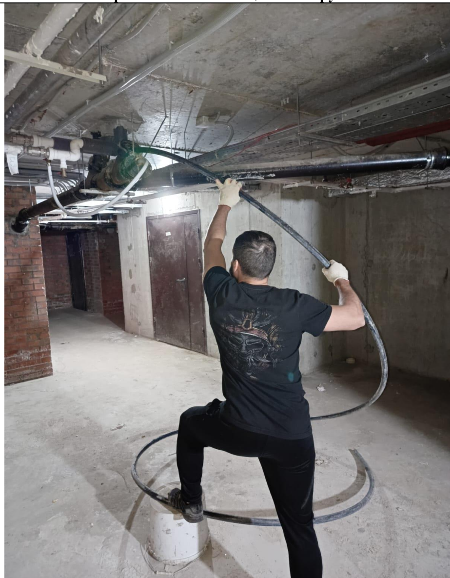
Промывка канализационной трубы
