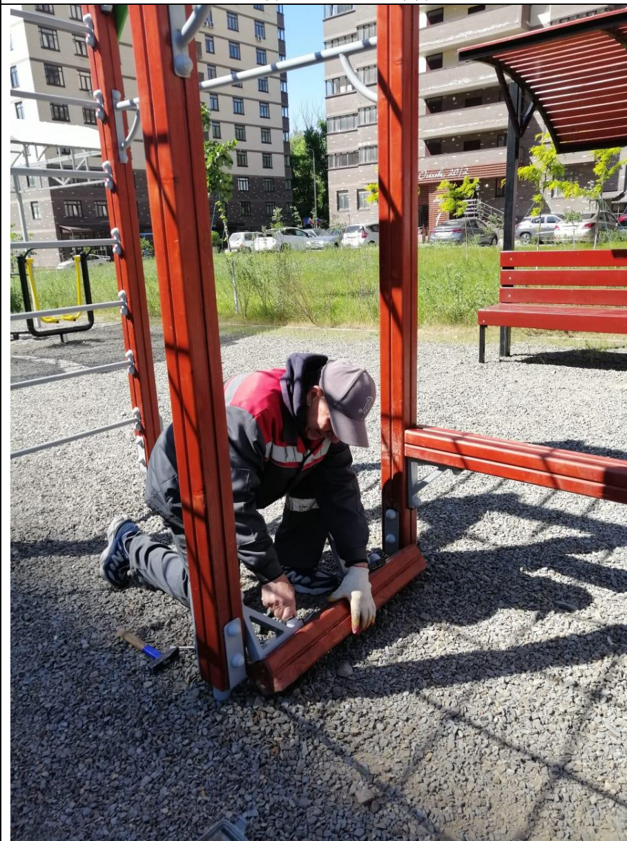
Ремонт детской площадки
