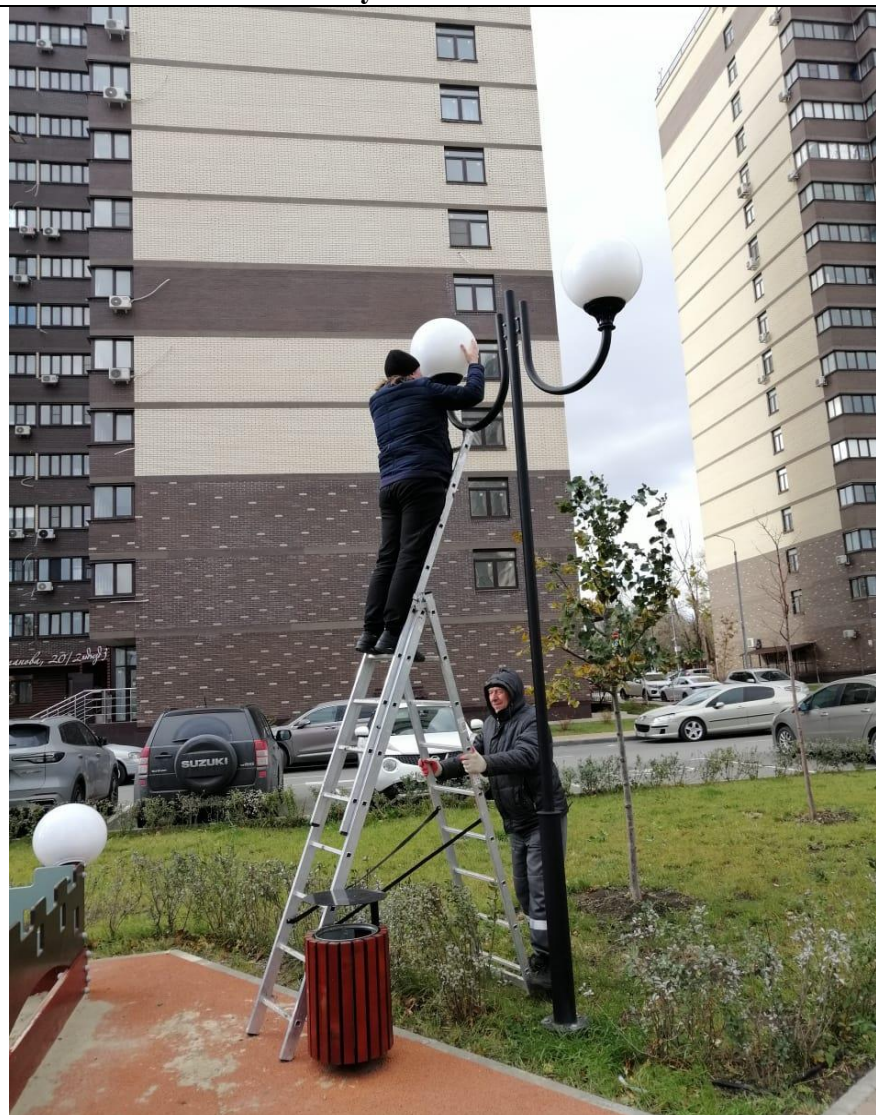
Установка уличных светильников
