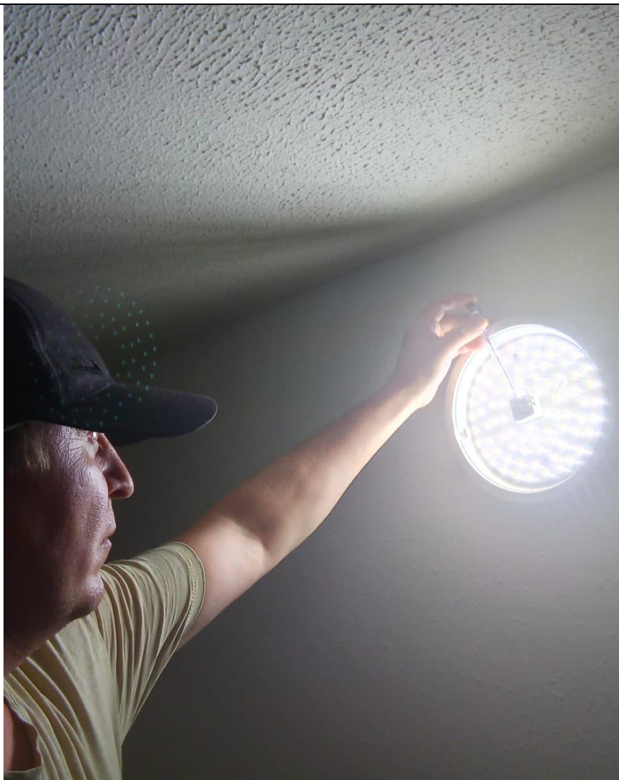
Ремонт светильников в МОП
