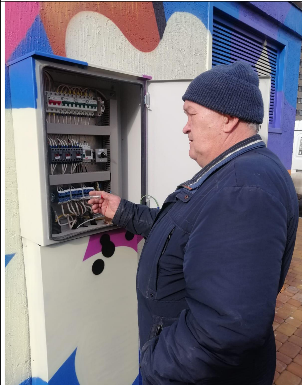
Проверка фаз уличного освещения.
