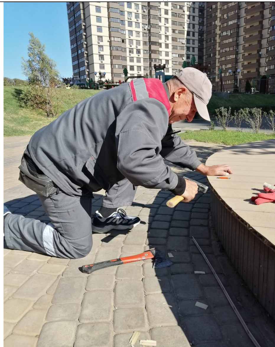
Ремонт зоны отдыха
