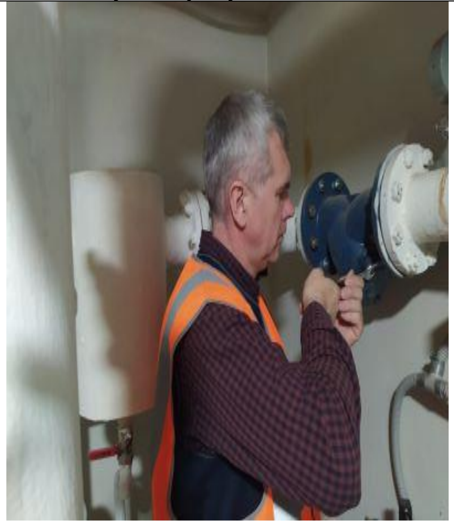
Прочистка фильтра теплоносителя
