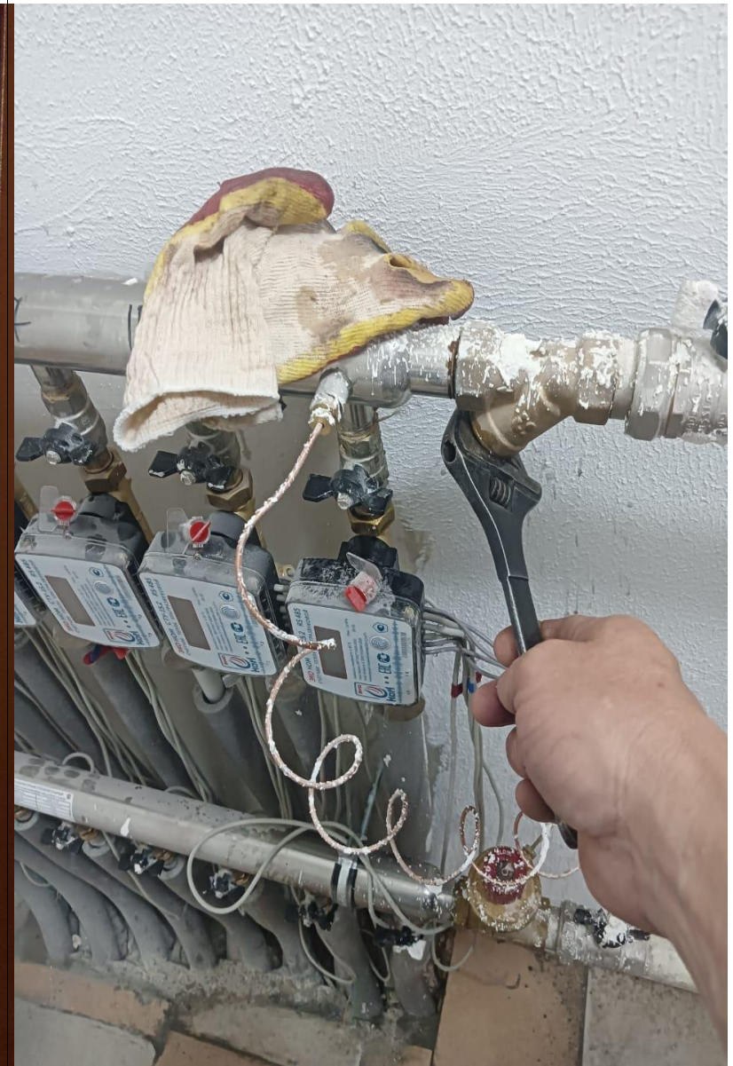
Ремонт труб в коллекторной отоплении
