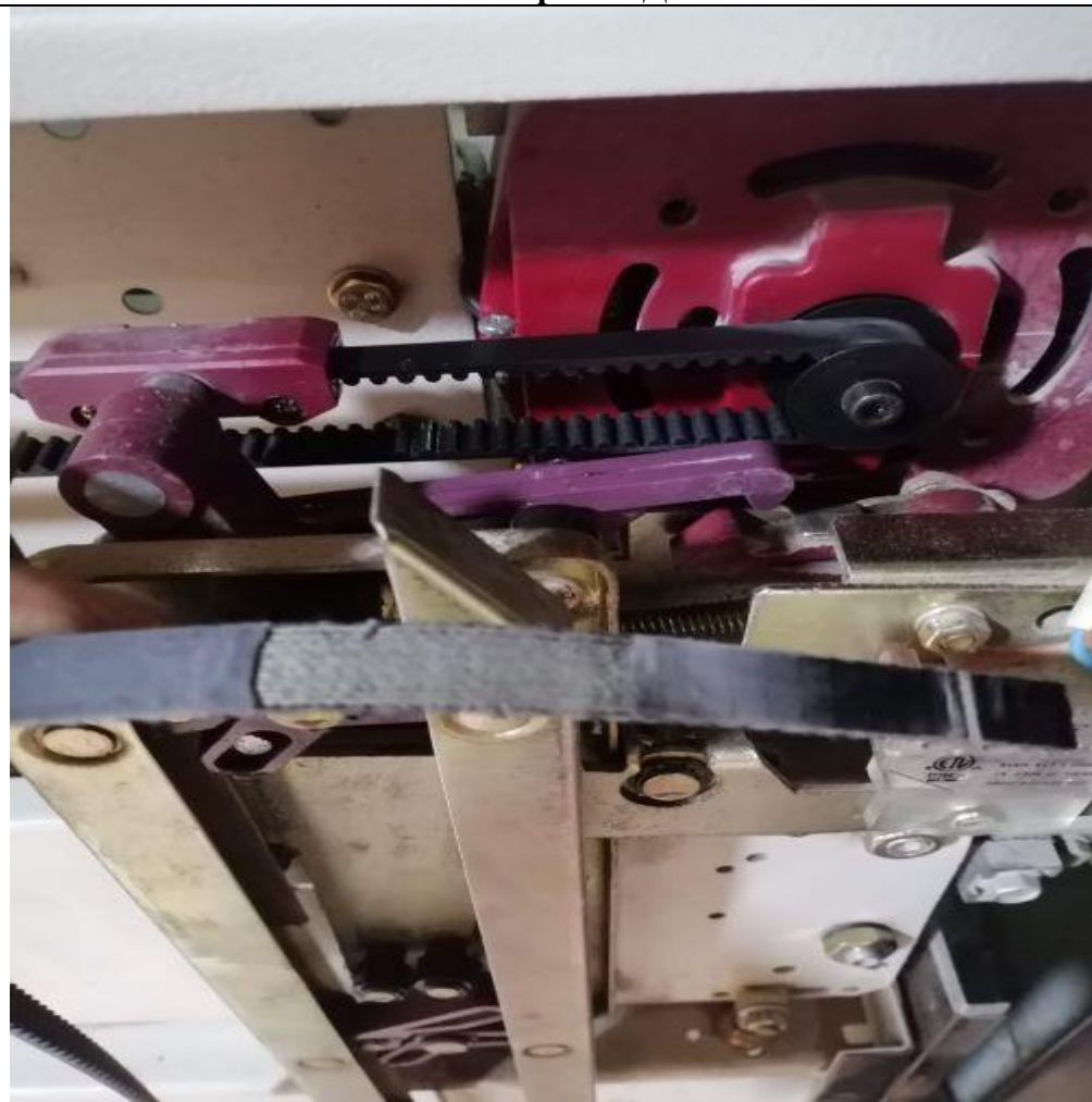
Замена ремня ДК
