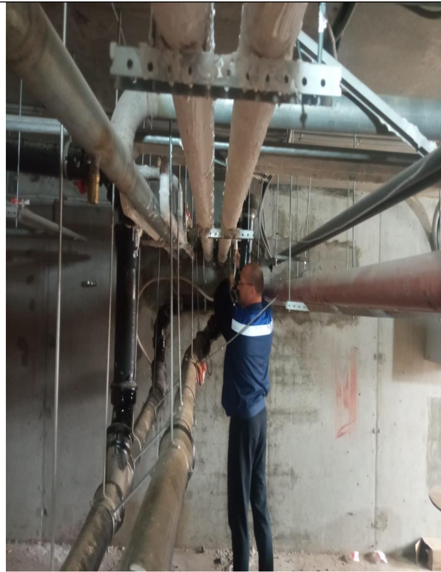
Промывка канализационных труб
