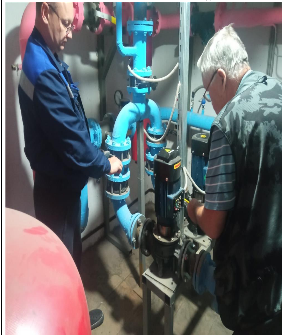
Работы по сезонной подготовке ТП к эксплуатации к отопительному периоду.
