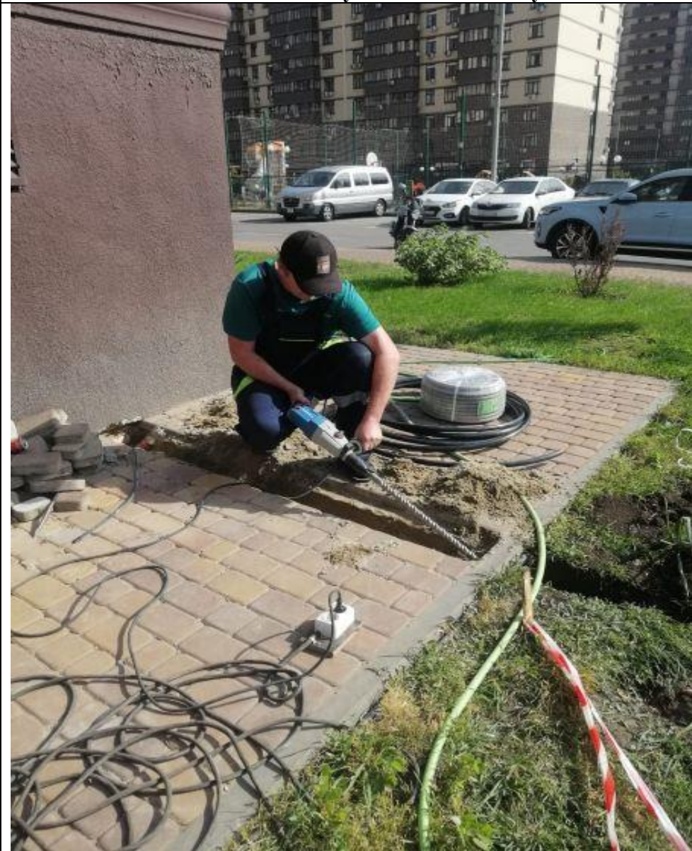
Монтаж кабеля для установки шлагбаума
