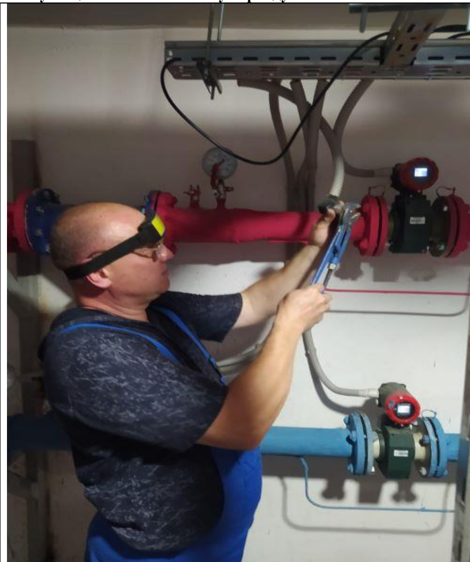
Работы по сезонной подготовке ТП к эксплуатации к отопительному периоду.
