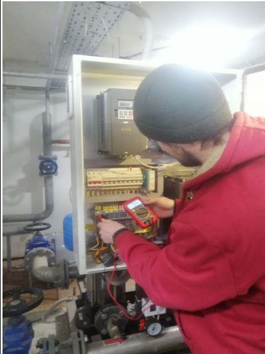
Проверка сети разводки шкафа управления насосами ХВС
