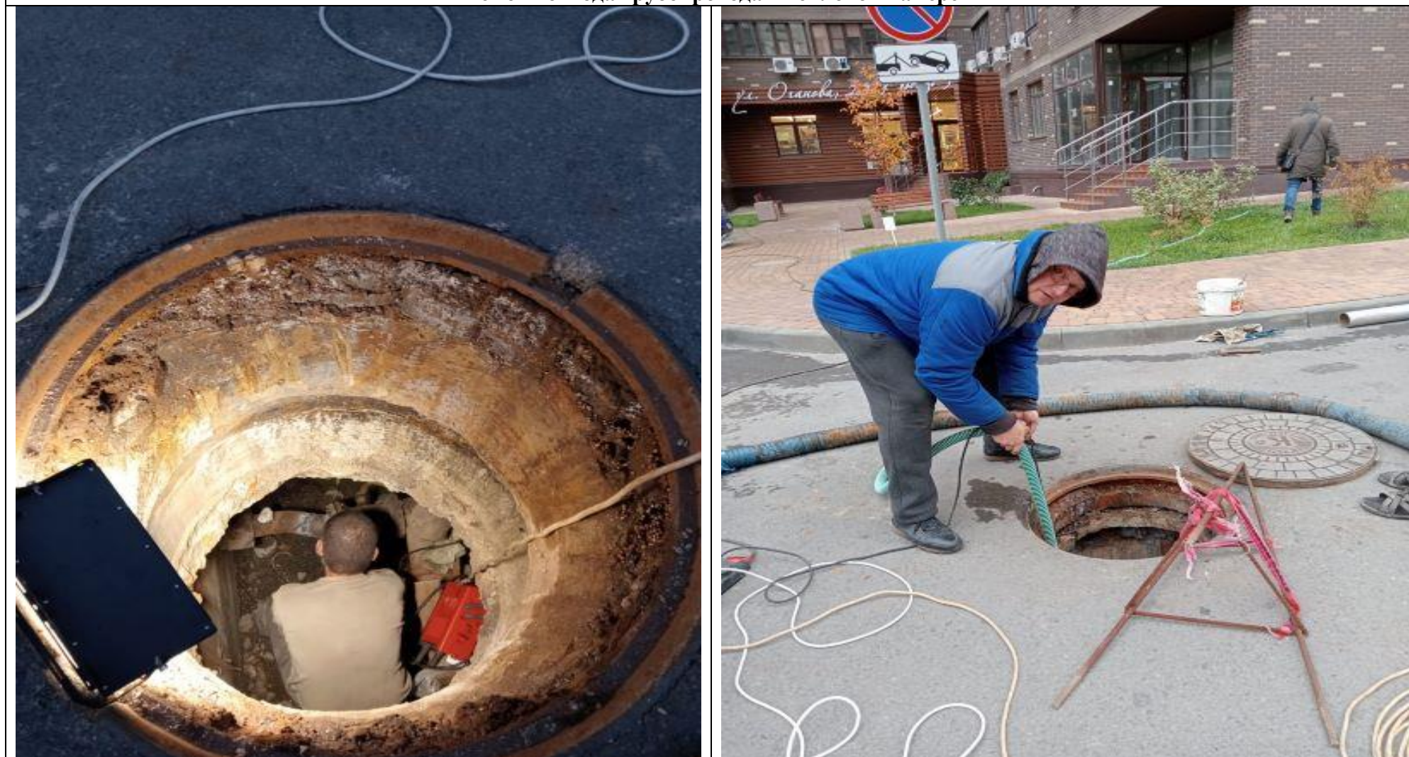
Ремонт отвода трубопровода в тепловой камере
