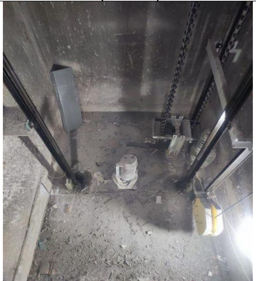
Уборка шахты лифта
