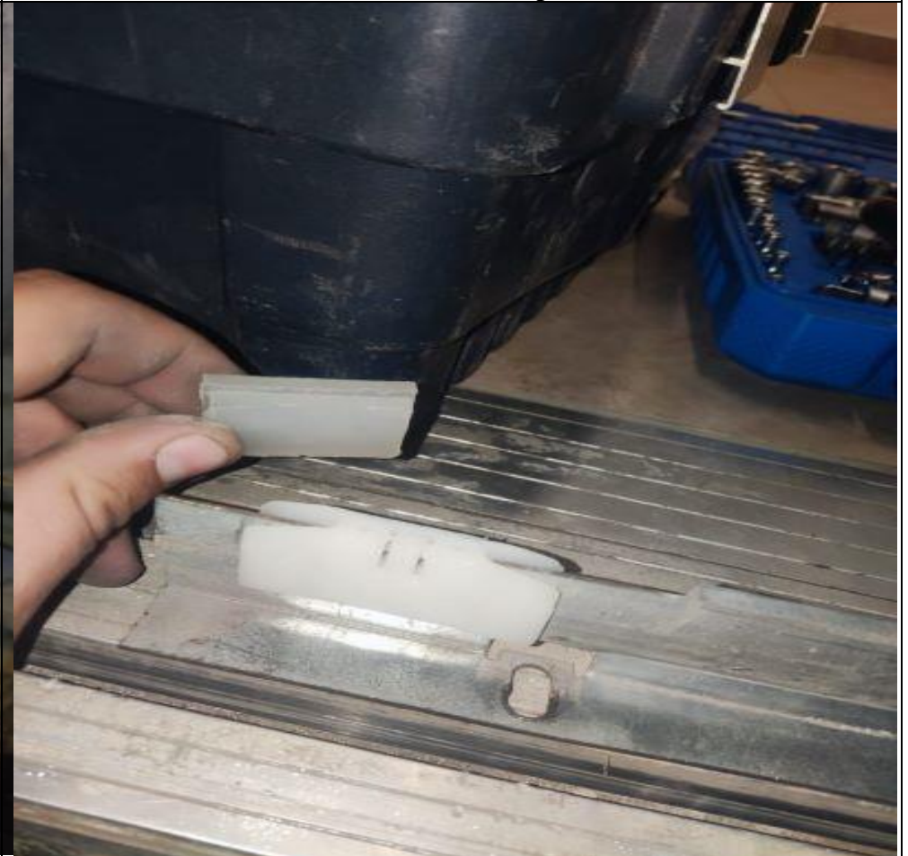
Замена башмачков двери шахты
