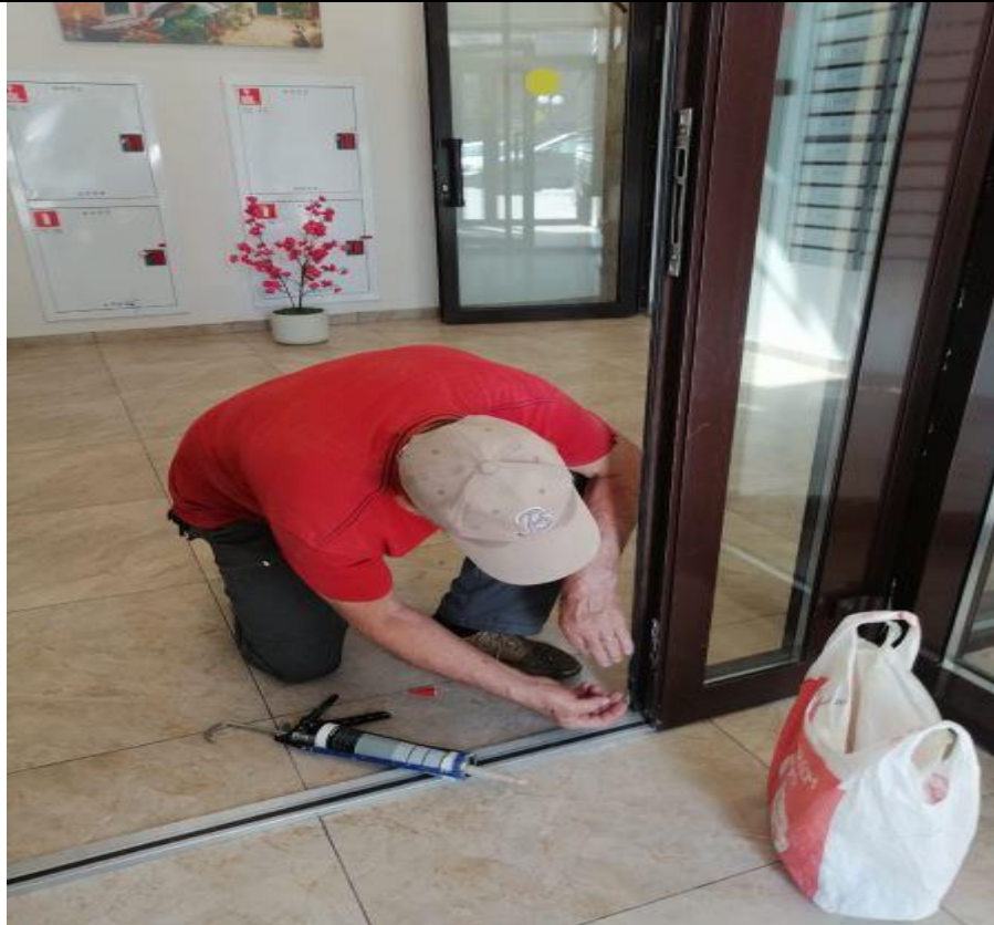
Крепление уплотнителя входной двери
