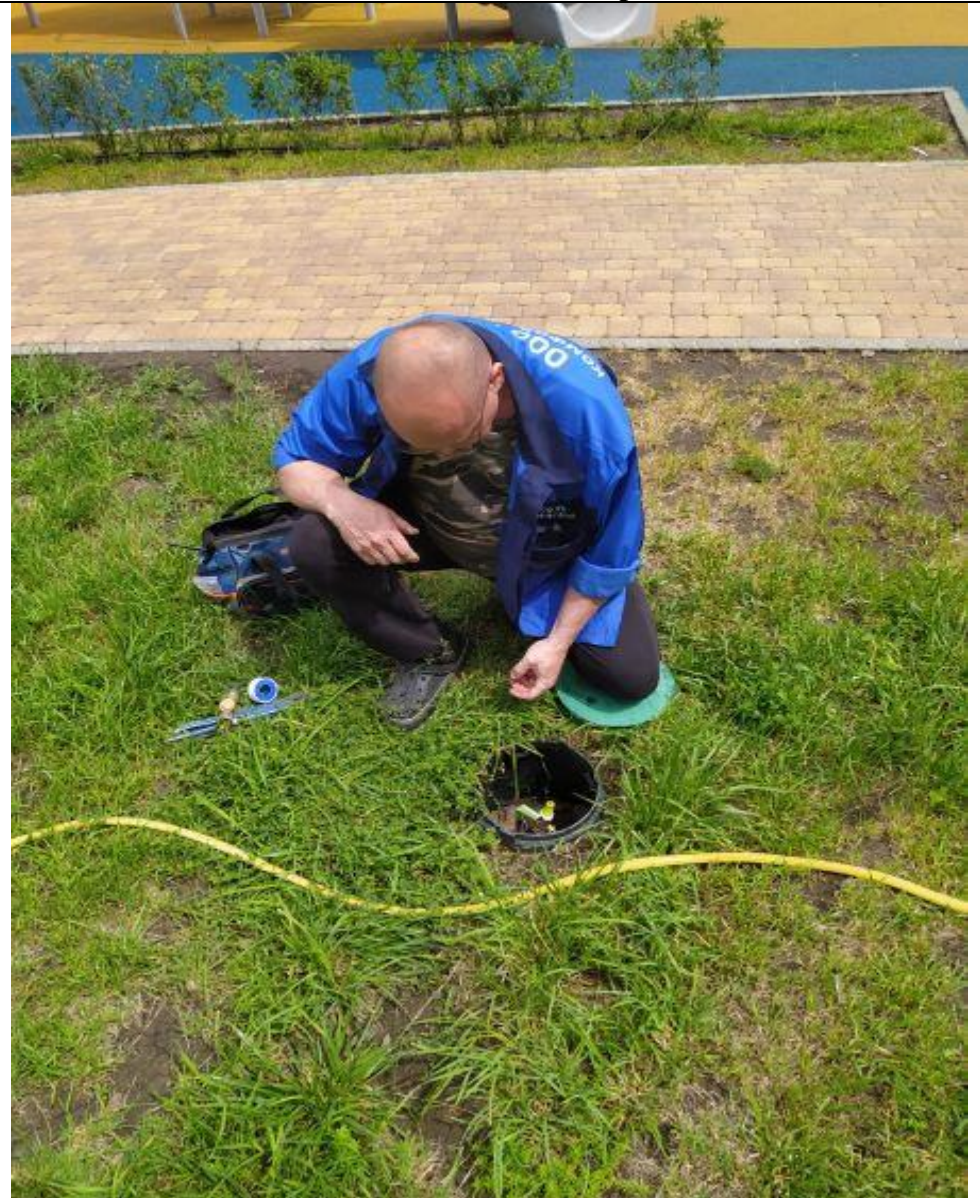
Ремонт поливочного крана
