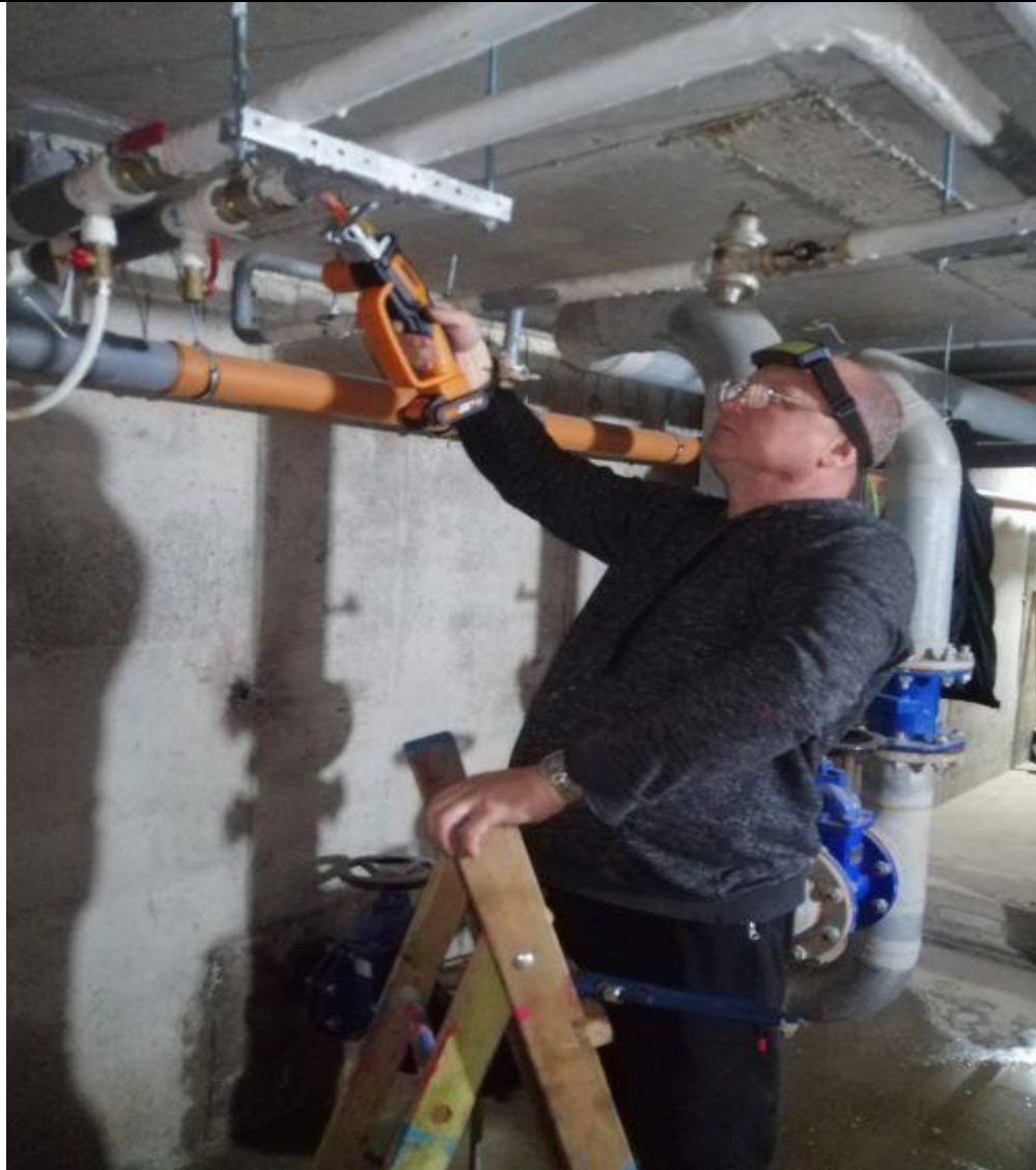
Ремонт стояка ХВС
