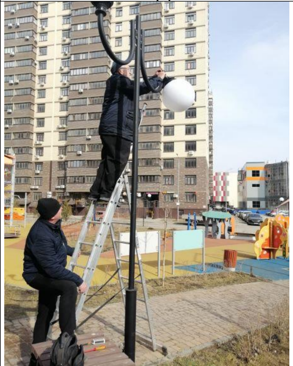
Замена светильника на опоре уличного освещения
