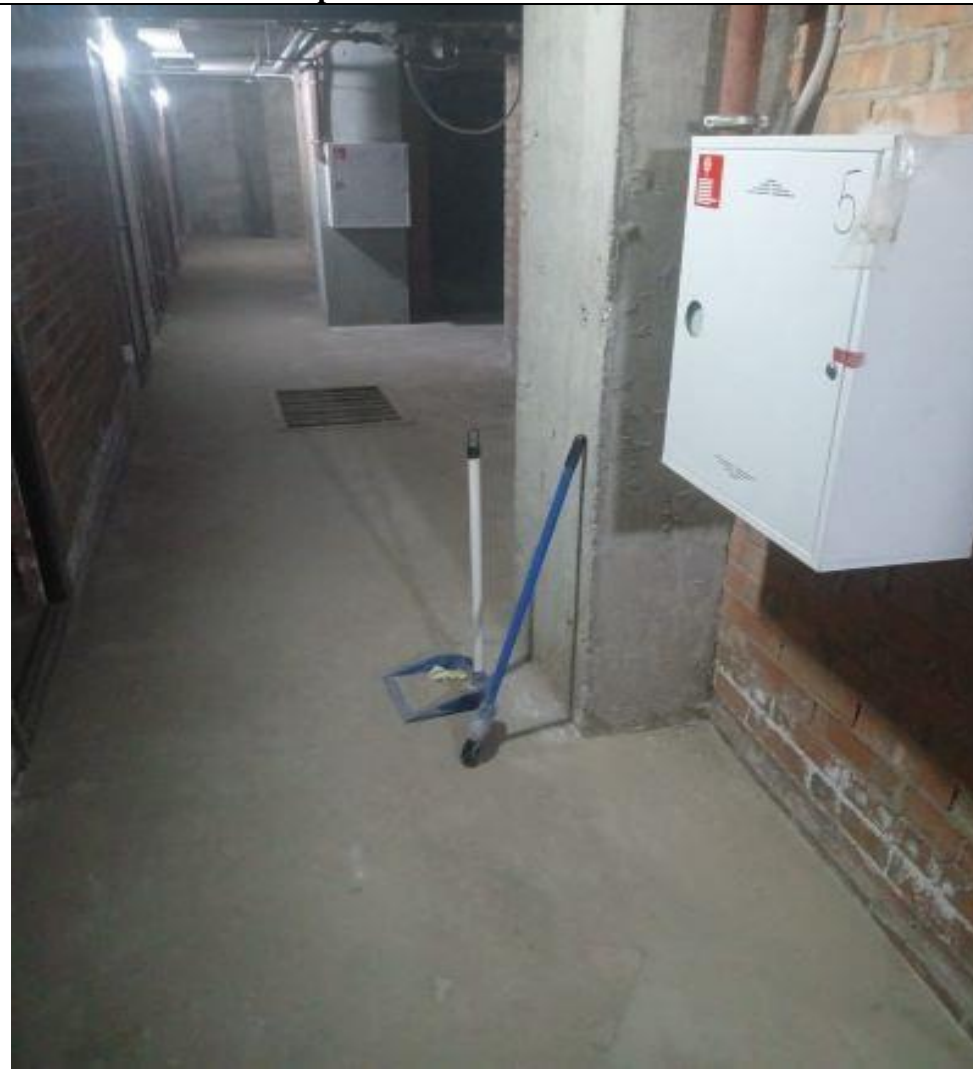
Уборка подвального помещения
