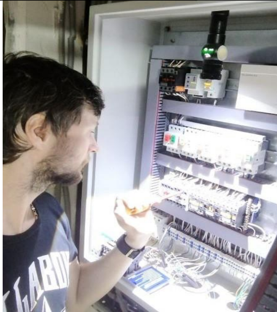
Обтяжка клемных соединений в шкафу управления теплоснабжения
