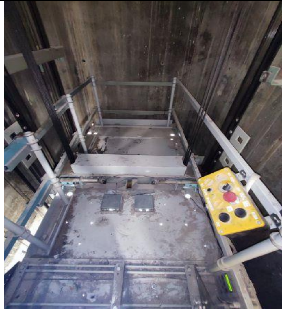
Прочистка шахты лифта
