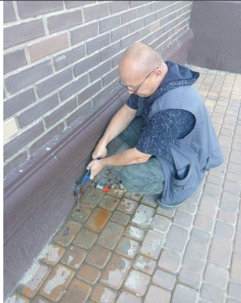
Замена поливочного крана
