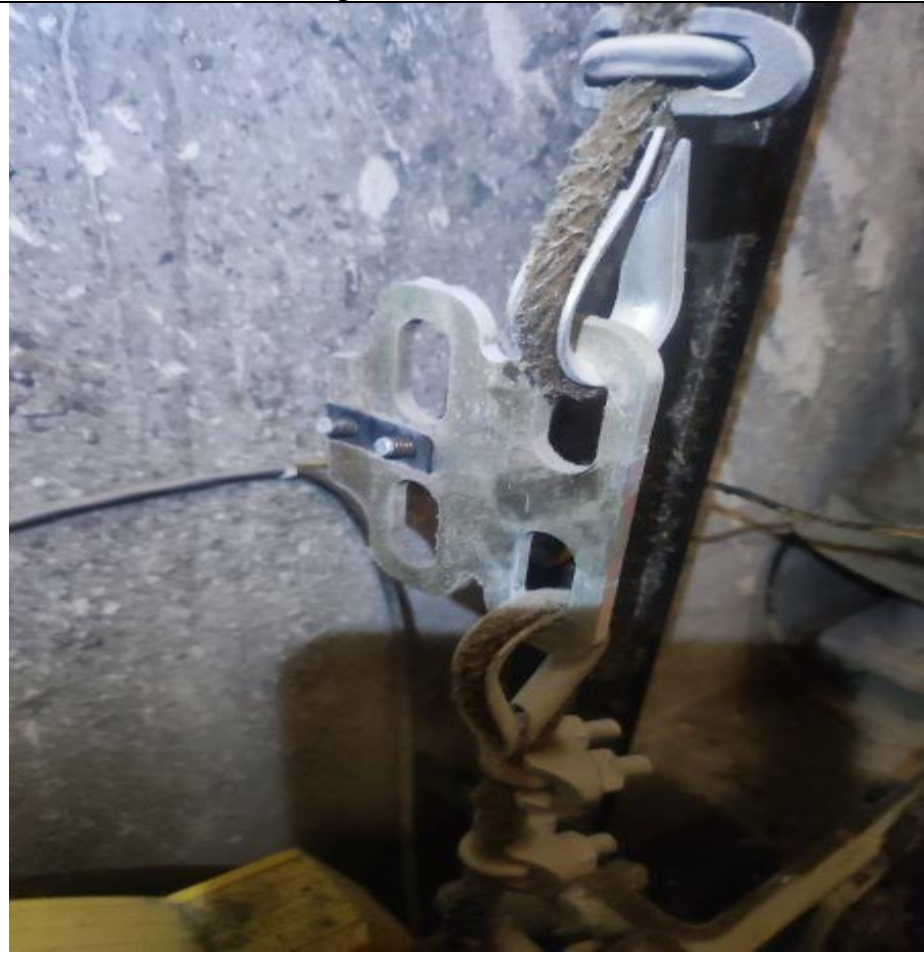
Подтяжка крепления клиновой системы
