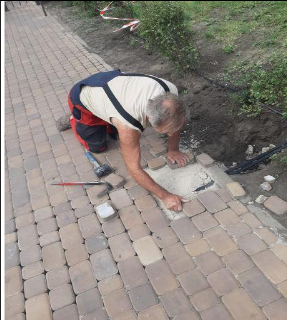
Восстановление тротуарной плитки
