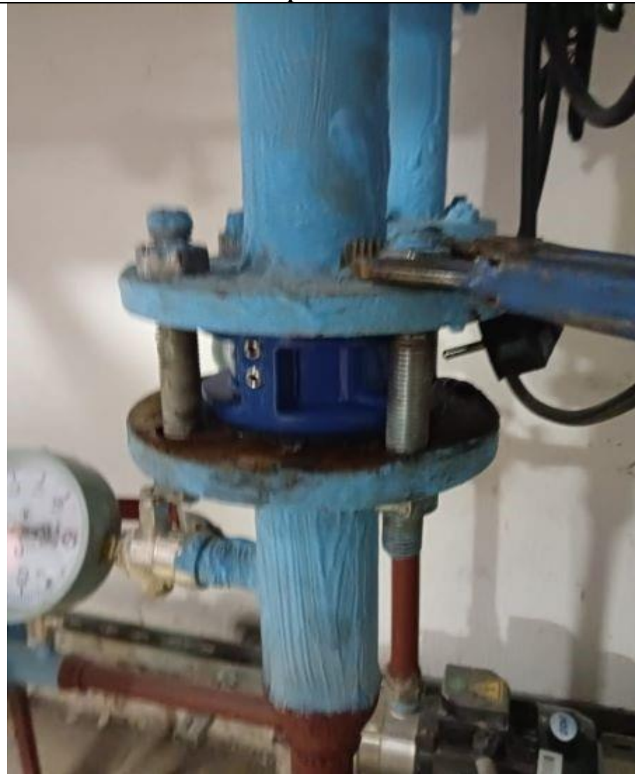
Замена обратного клапана
