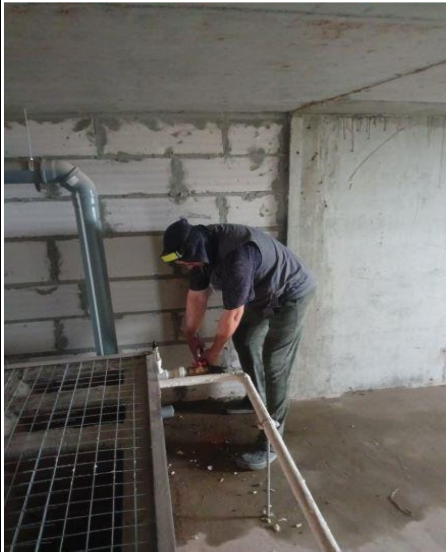
Ремонт стояка ГВС на тех. этаже
