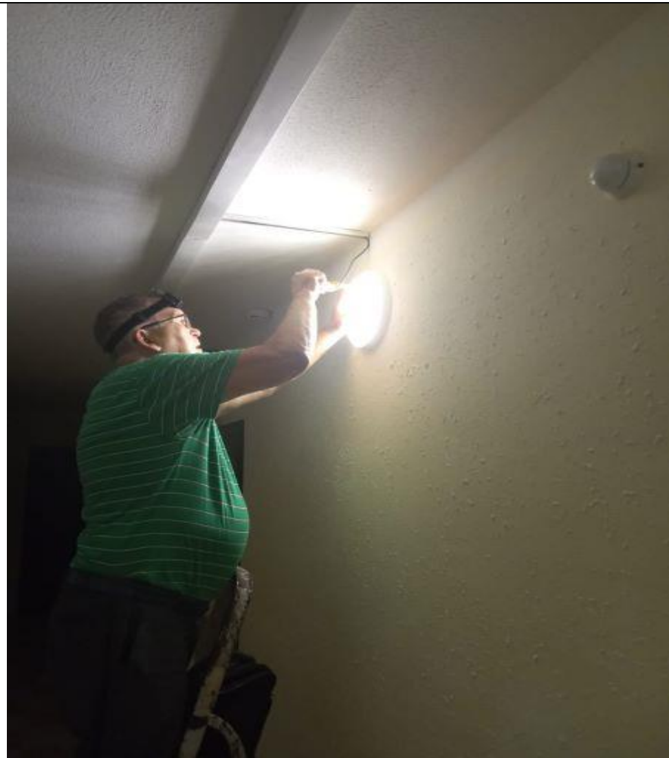
Установка дополнительного светильника в МОП
