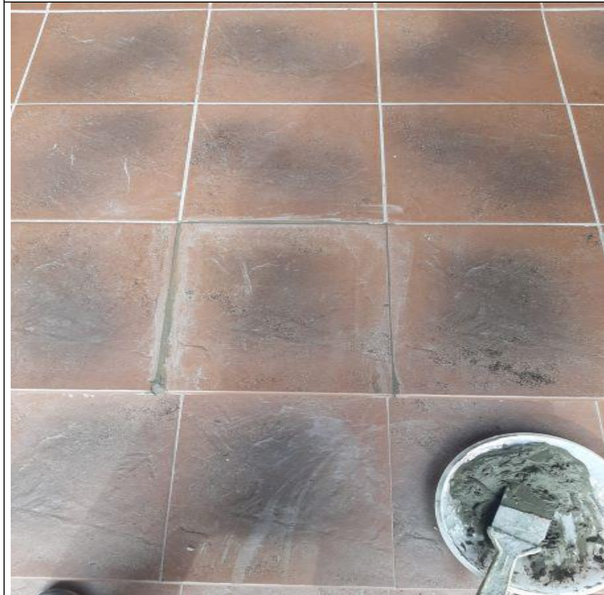
Замена плитки в входной зоне.
