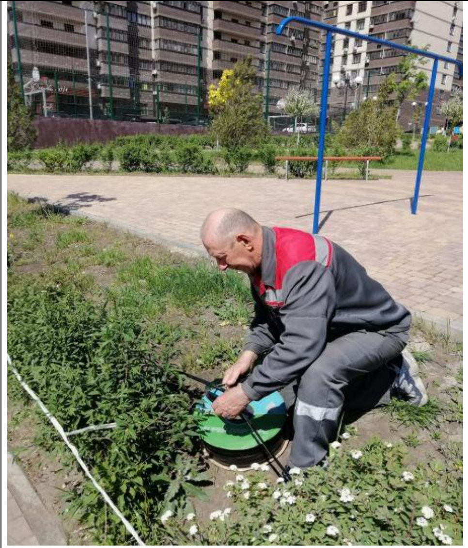
Ремонт капельного полива
