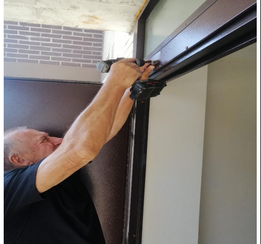
Ремонт доводчика двери
