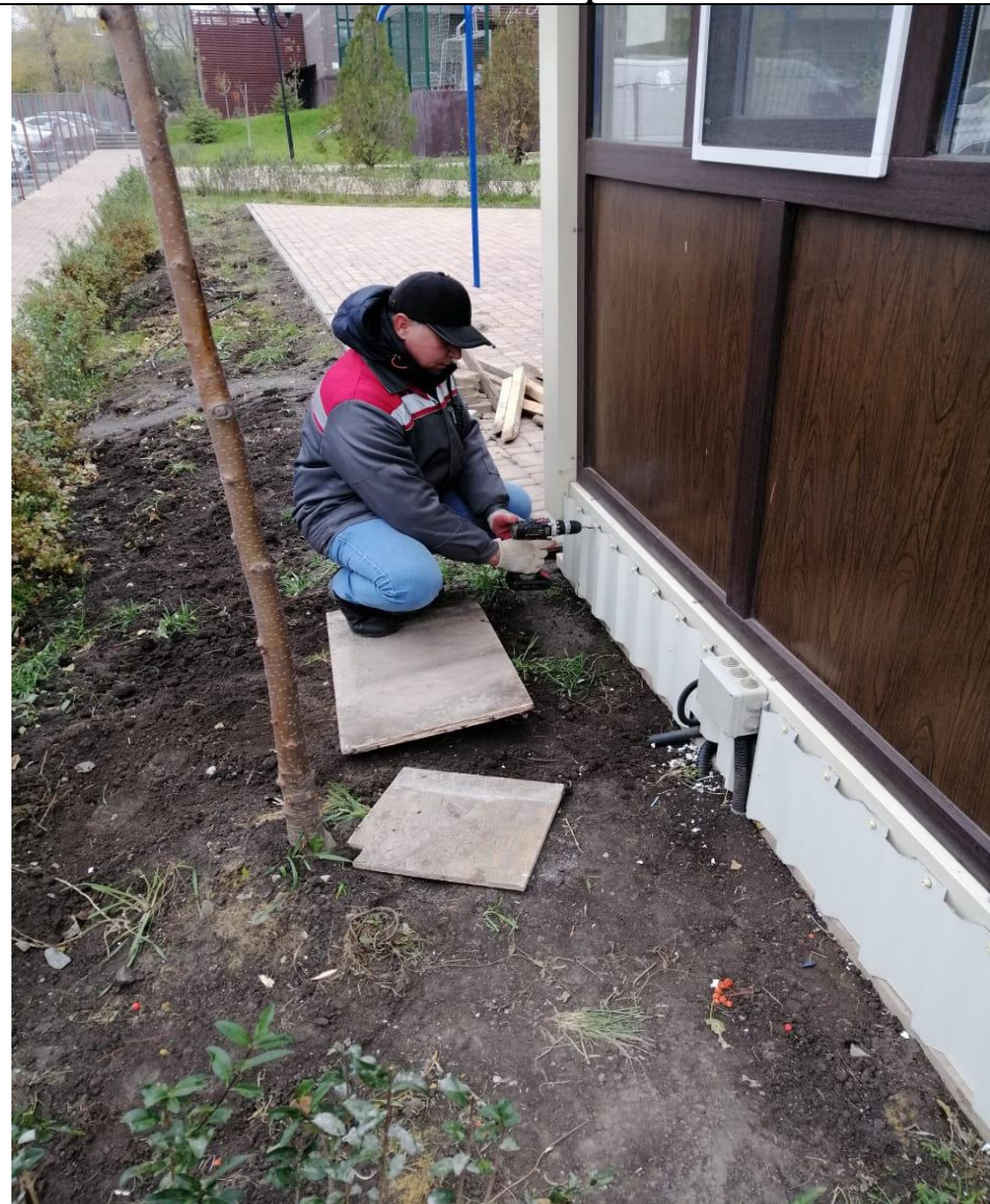
Ремонт поста охраны
