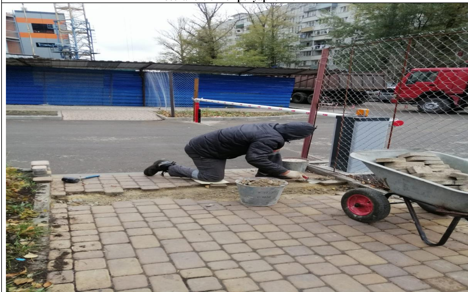
Восстановление тротуарной плитки
