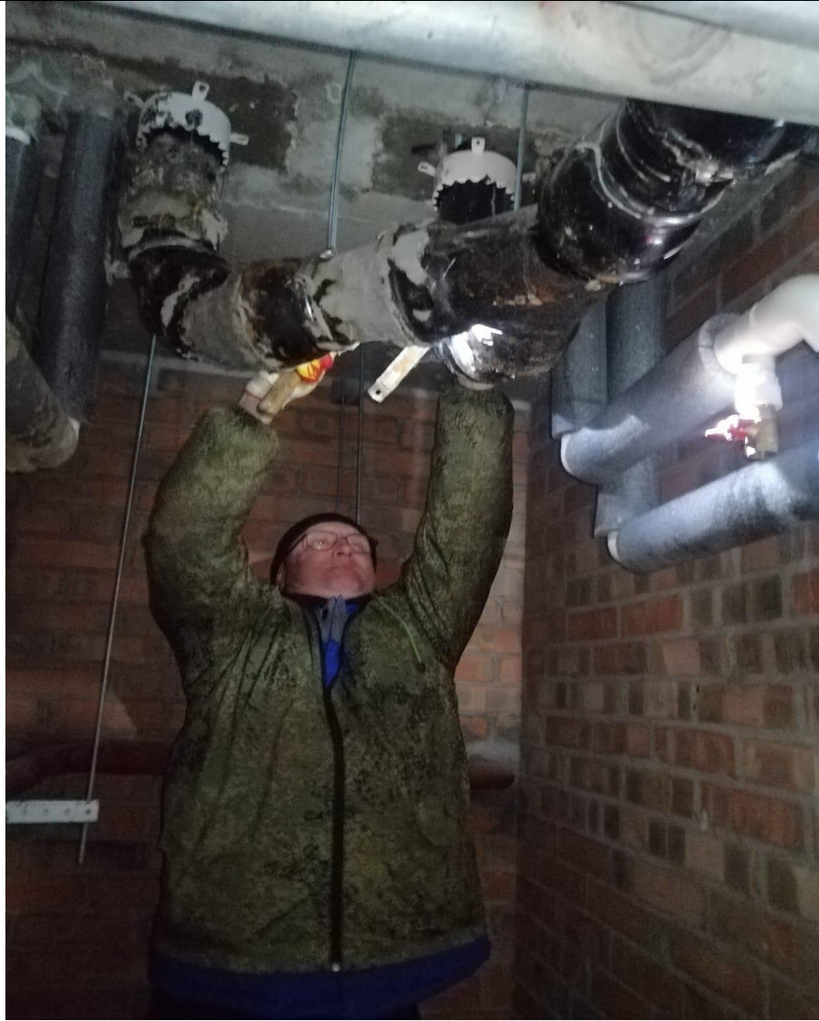
Прочистка внутридомовой канализации
