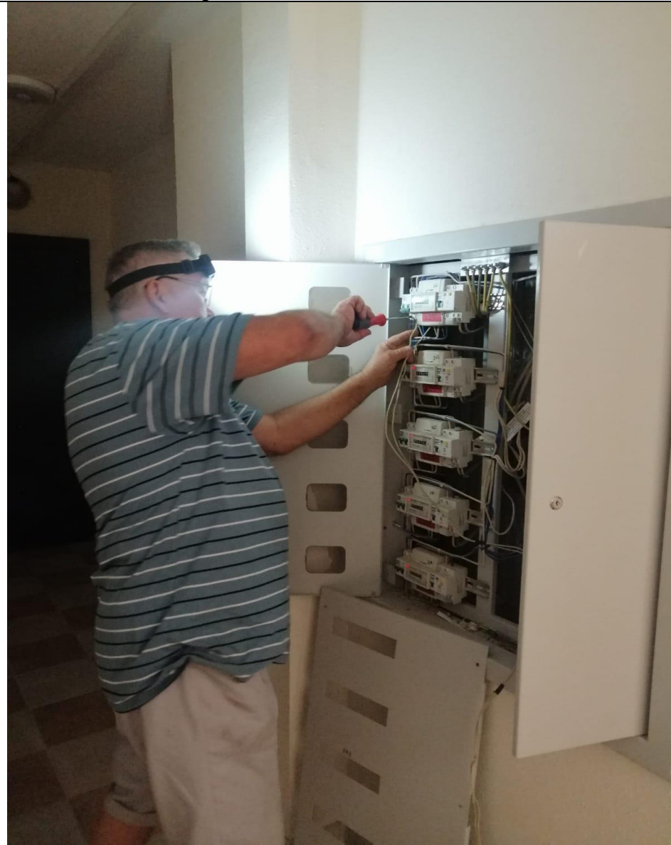
Протяжка контактов автомата
