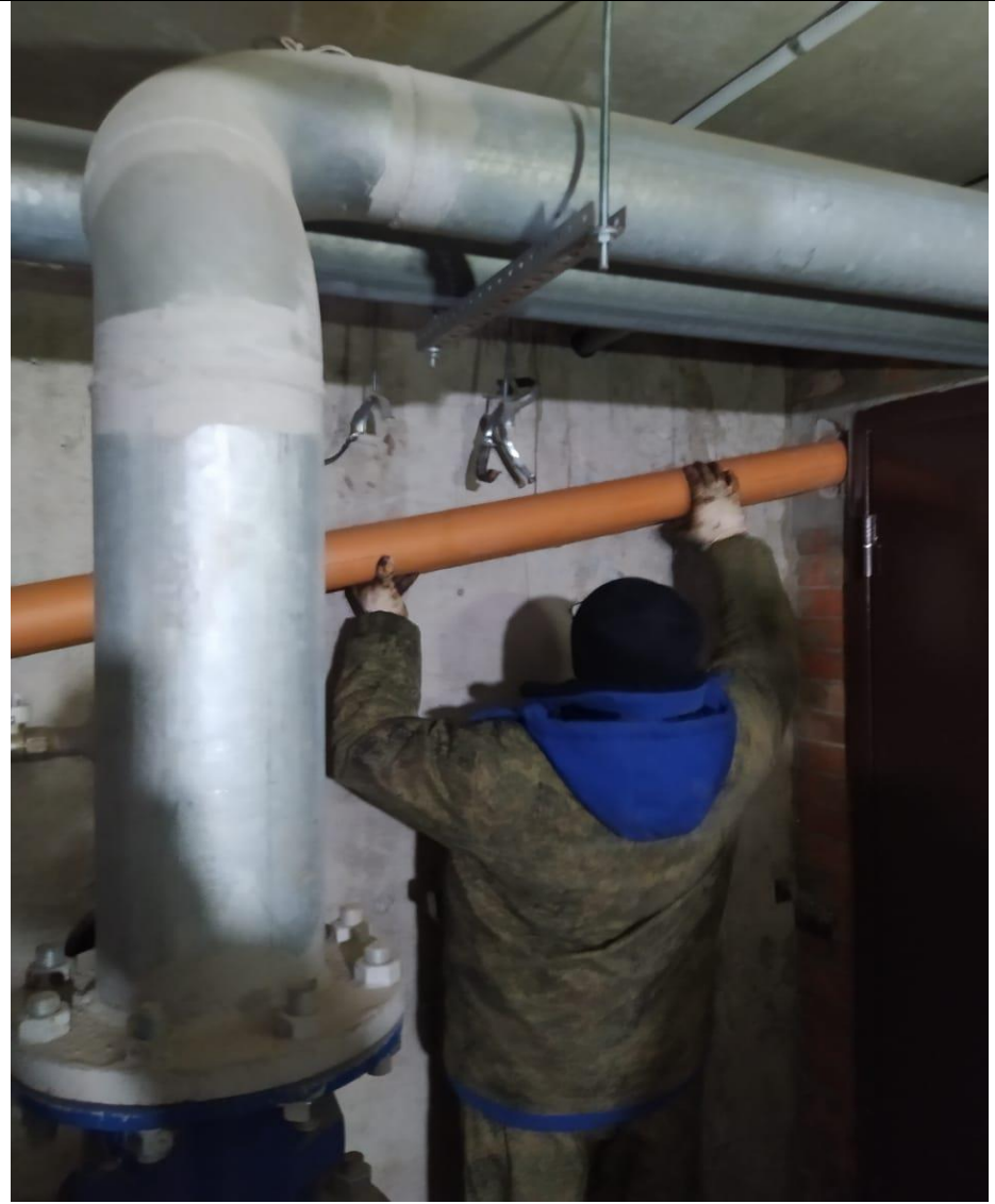
Замена канализационного стояка
