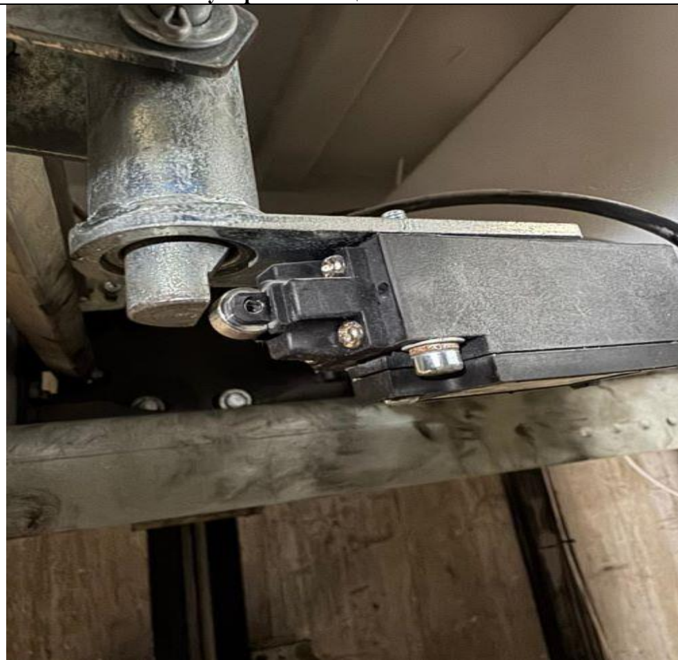
Регулировка концевого ловителя
