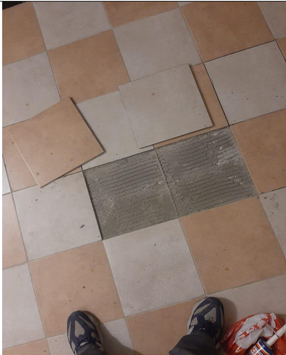
Ремонт и восстановление плитки в холле.
