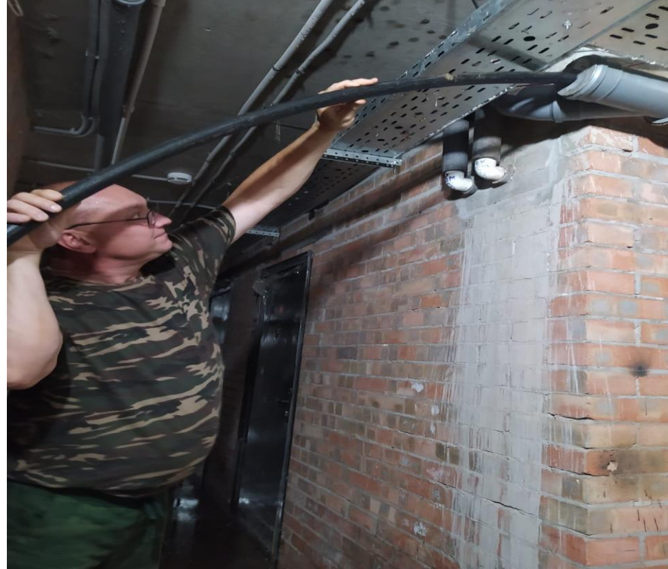
Прочистка внутридомовой канализации
