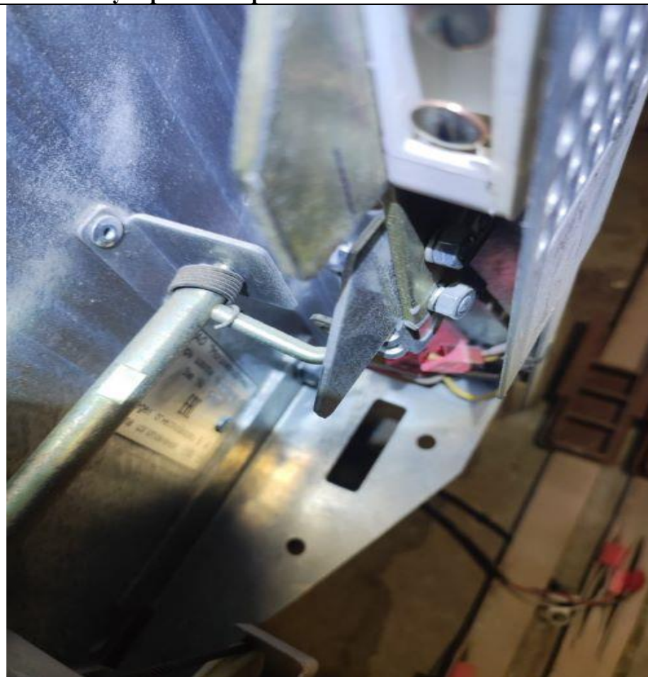
Регулировка аварийных замков всех контактов
