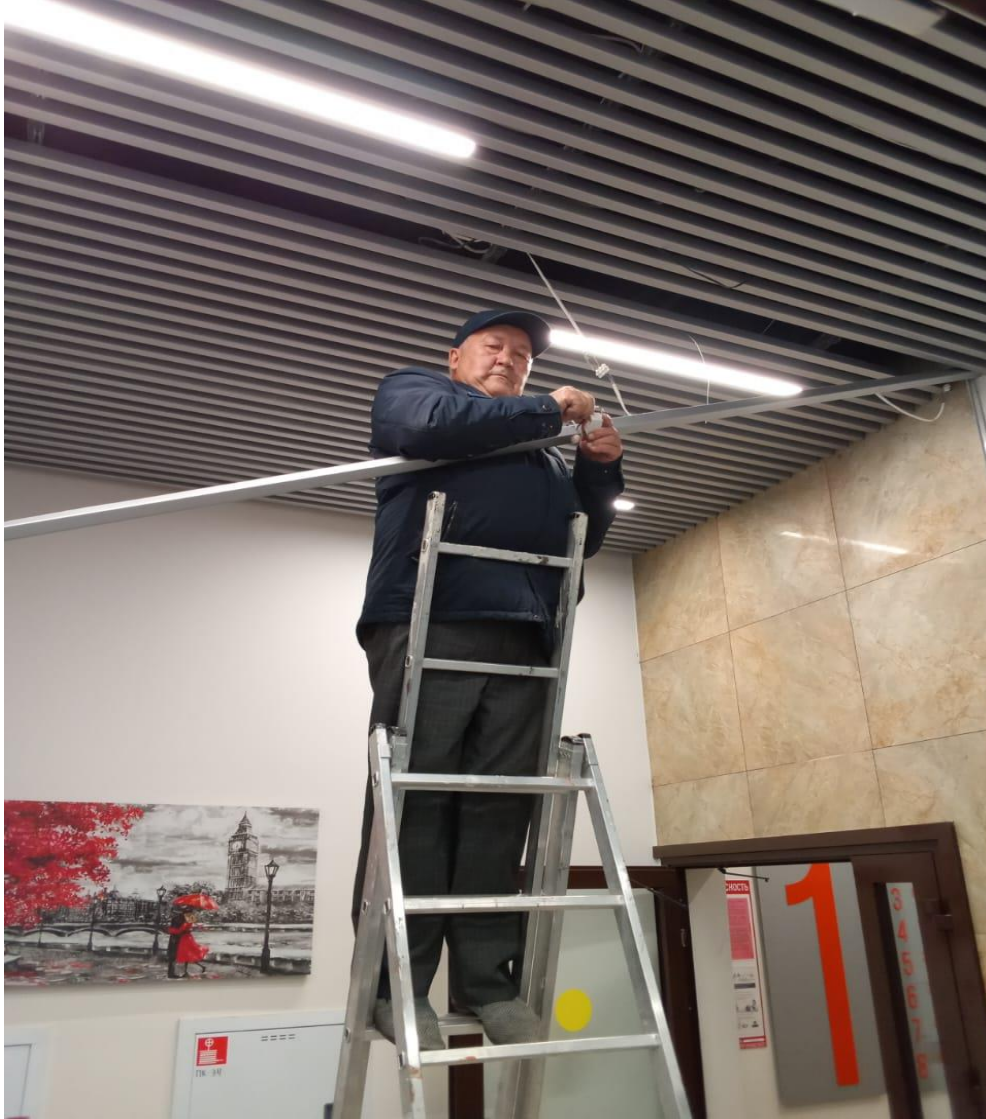
Замена датчика движения
