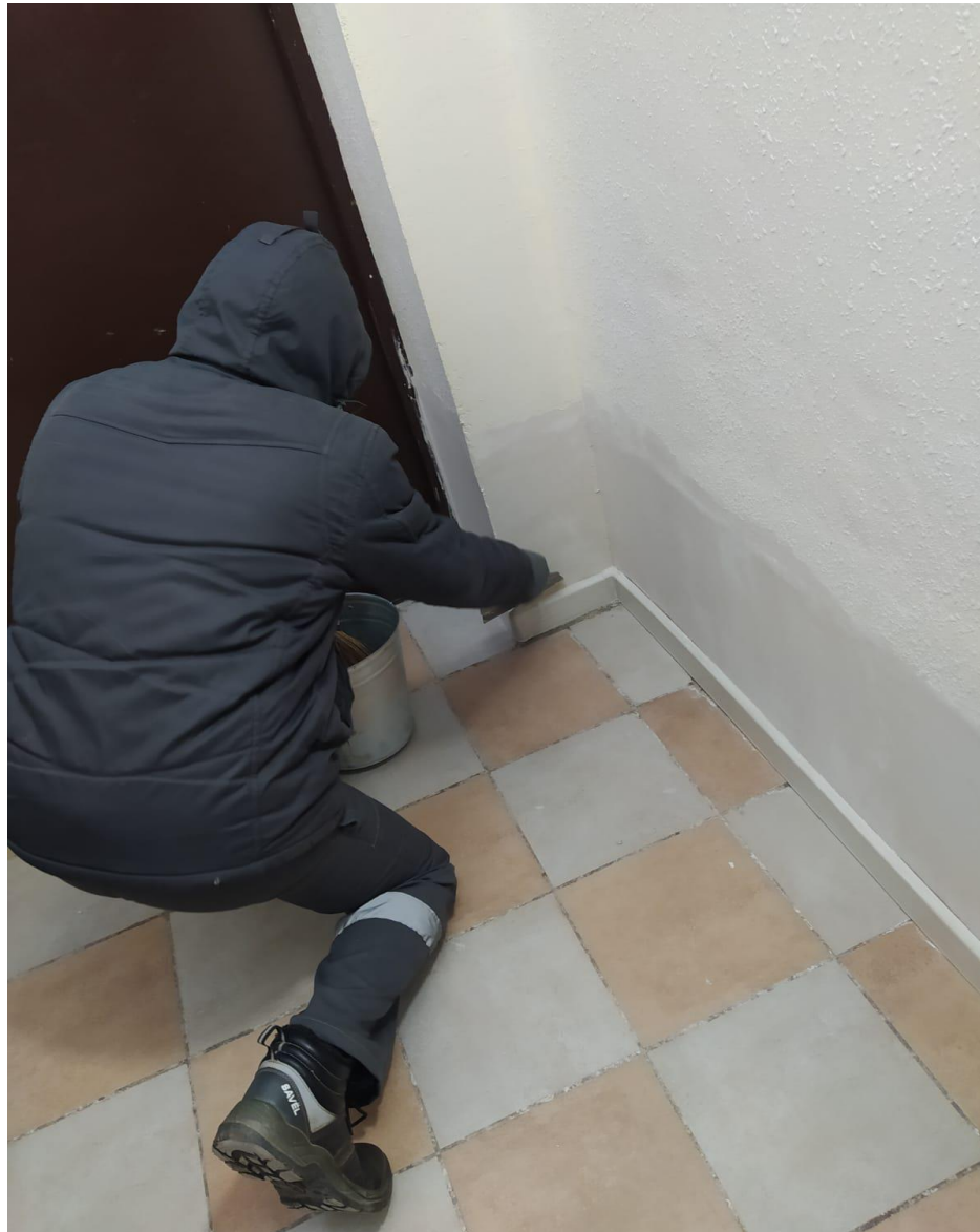
Ремонт стены МОП
