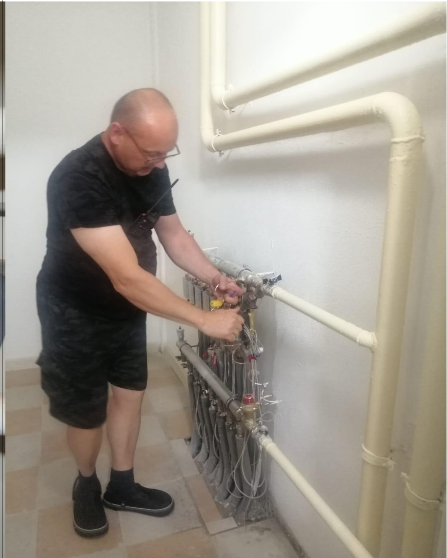
Ревизия и осмотр поэтажных коллекторных отопления.
