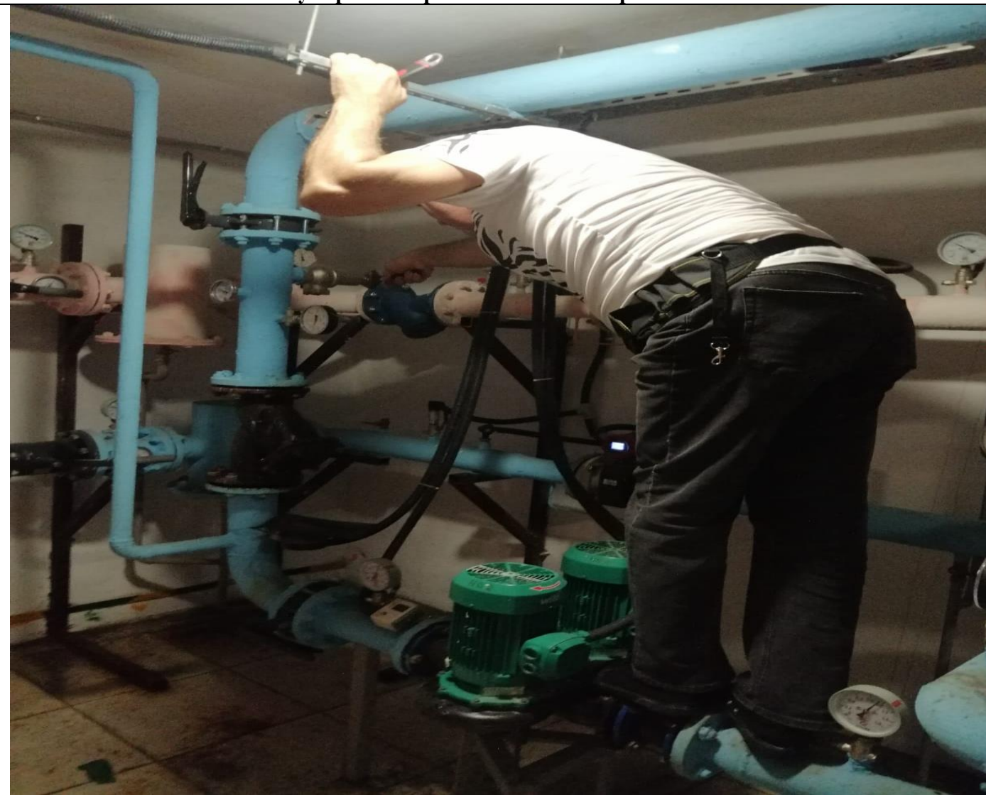
Регулировка сбросного клапана в рамке ИТП
