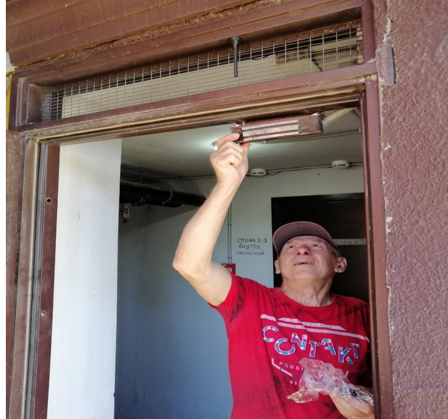
Ремонт магнитного замка двери
