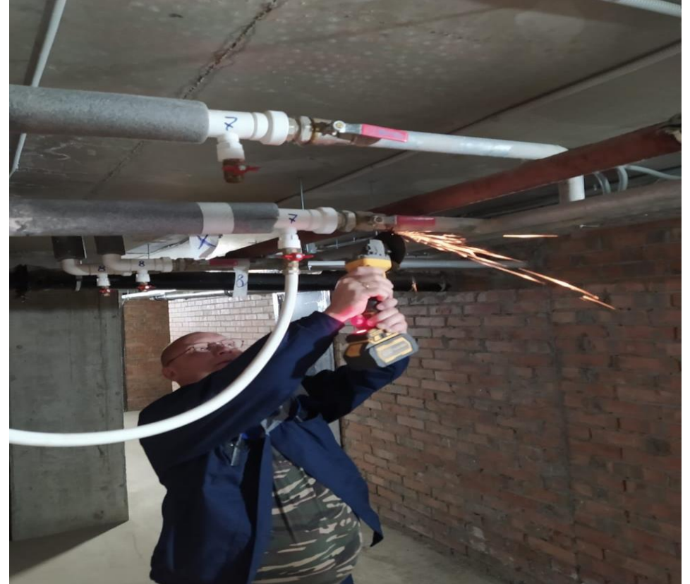
Ремонт канализационной системы
