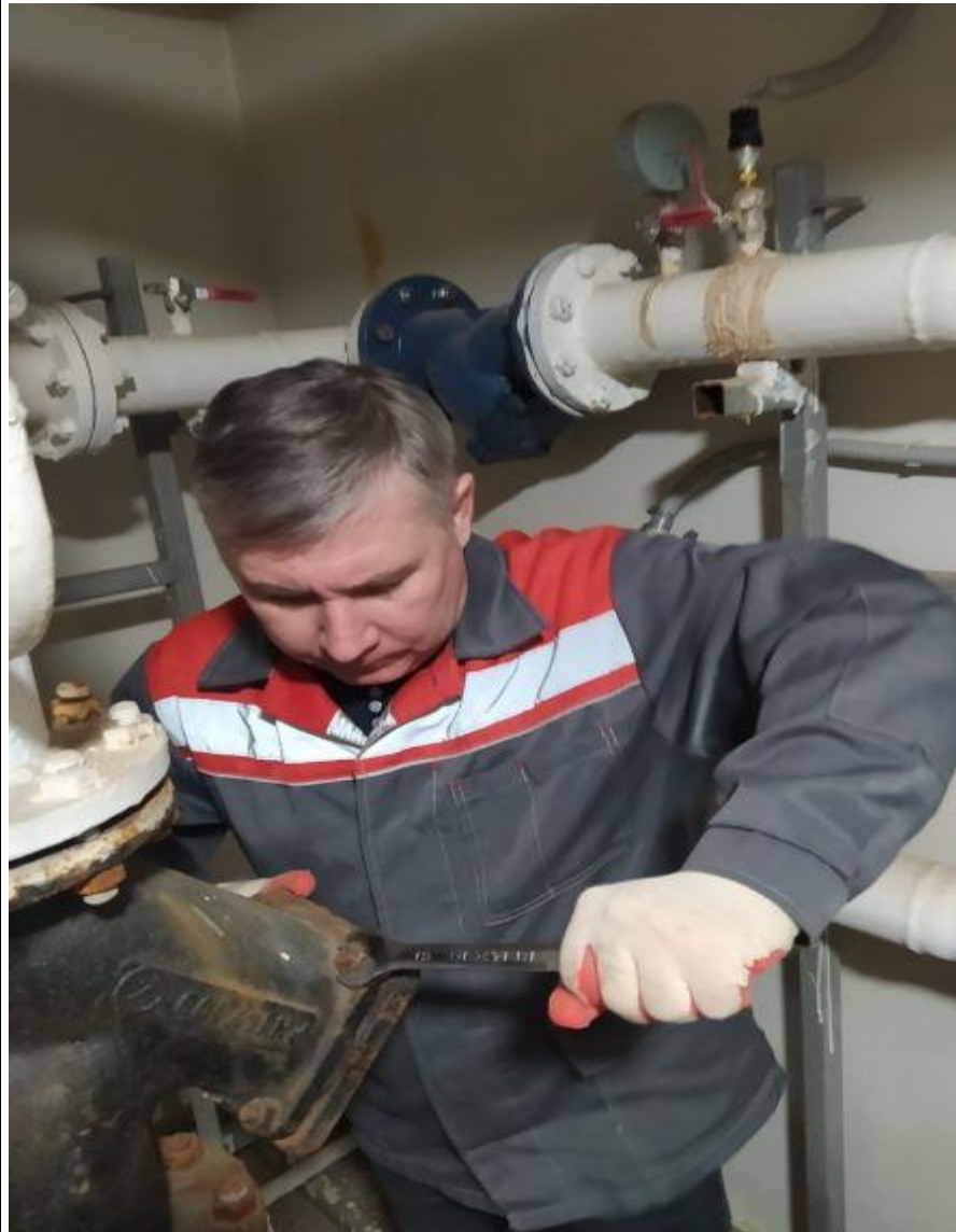
Прочистка фильтра отопления
