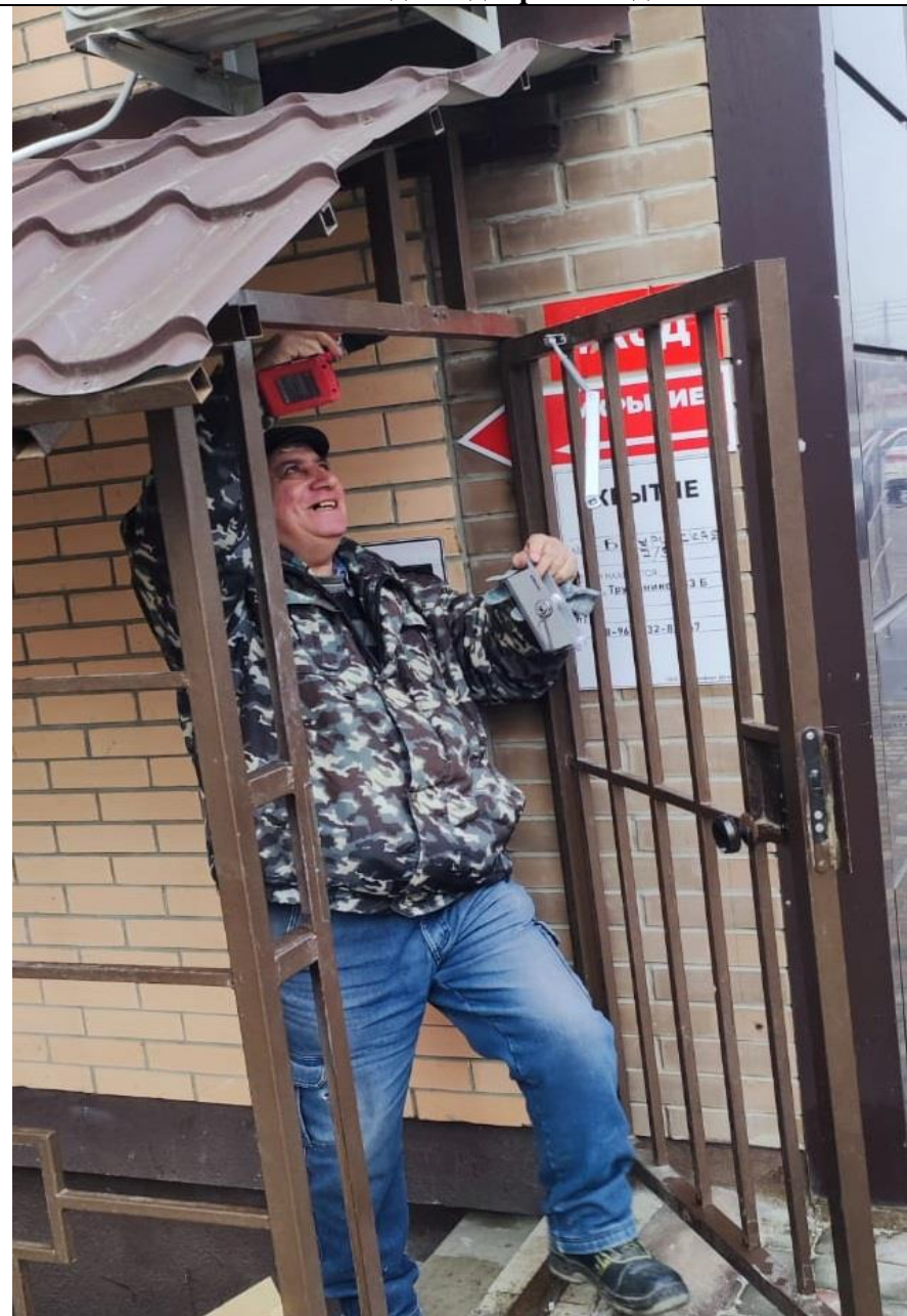
Ремонт входной двери в подвал
