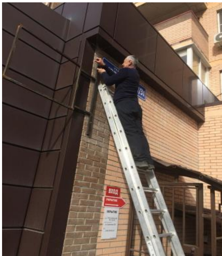
Замена элементов рекламной конструкции с фасада.
