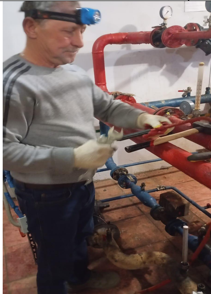
Работы по сезонной подготовке теплового пункта
