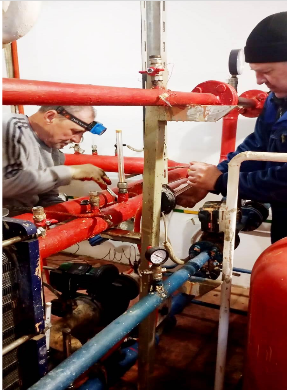
Проведены работы на системе отопления
