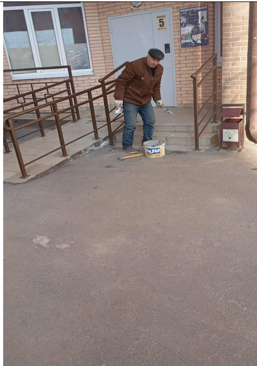
Восстановление плиточного покрытия входных групп.
