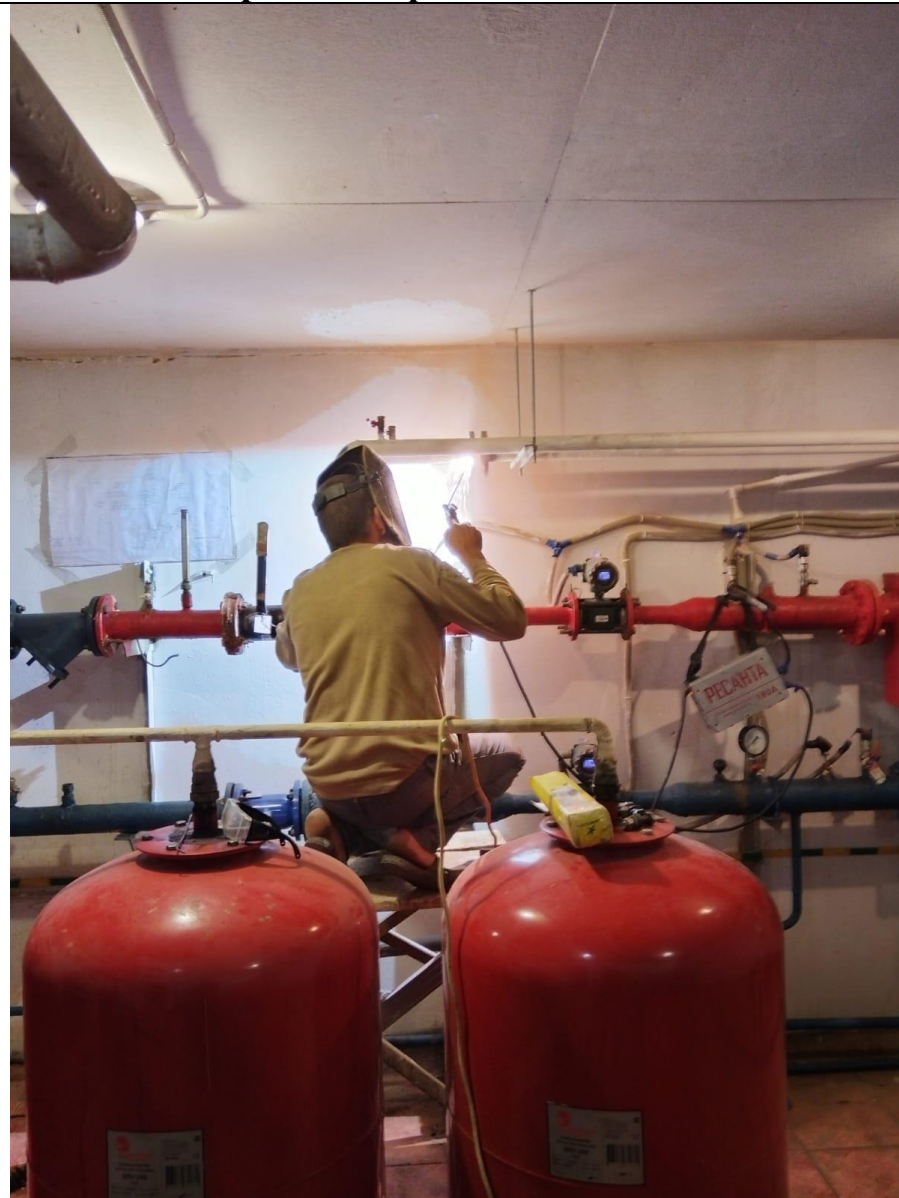
Вваривание фланцев под шайбы
