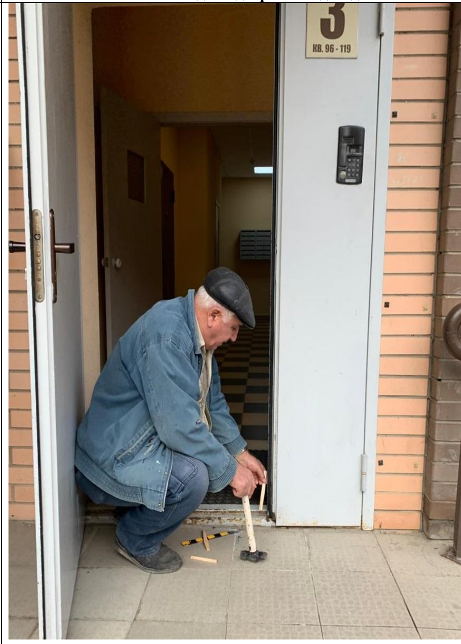
Ремонт входной двери 3й подъезд
