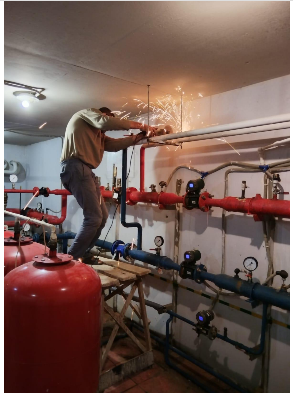
Вваривание фланцев под шайбы -теплоснабжение
