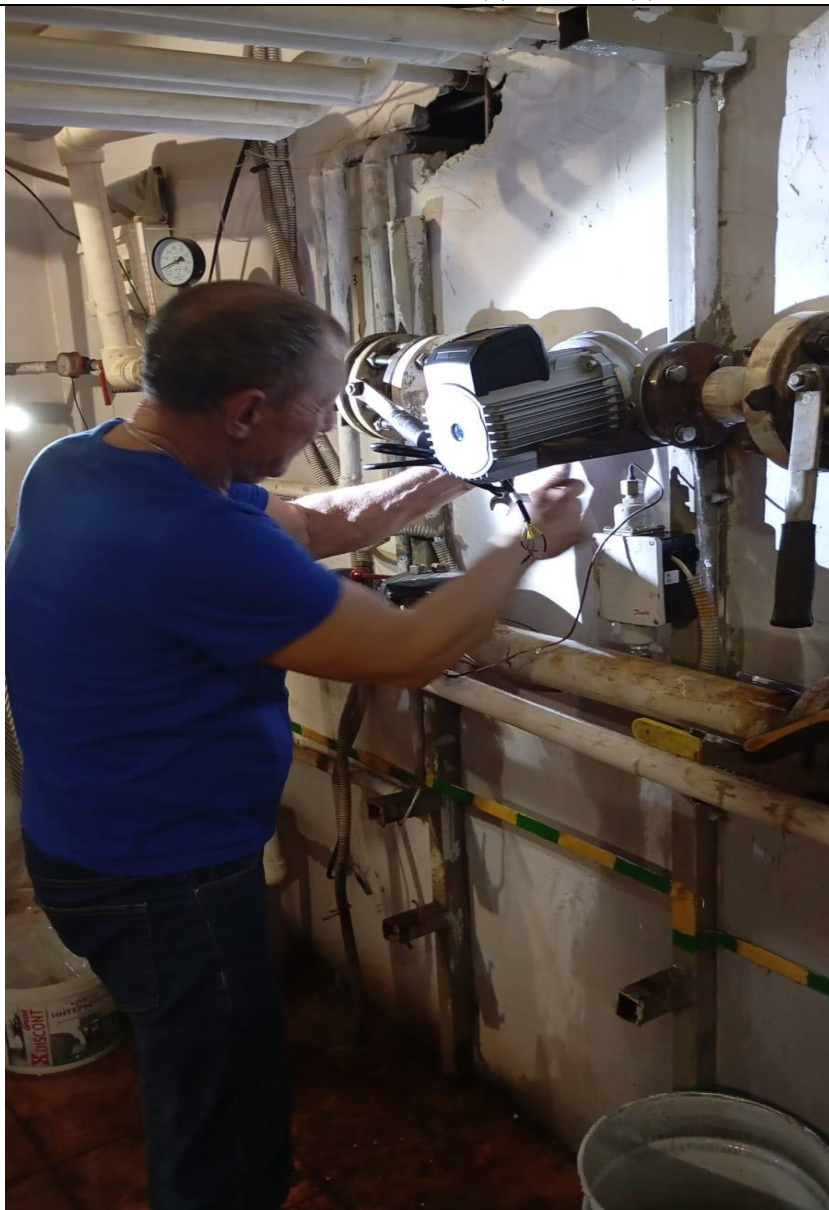
Замена насоса подачи воды
