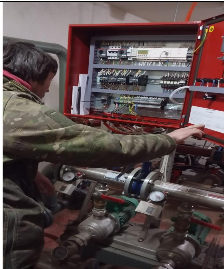
Проверка и настройка противопожарной насосной станции
