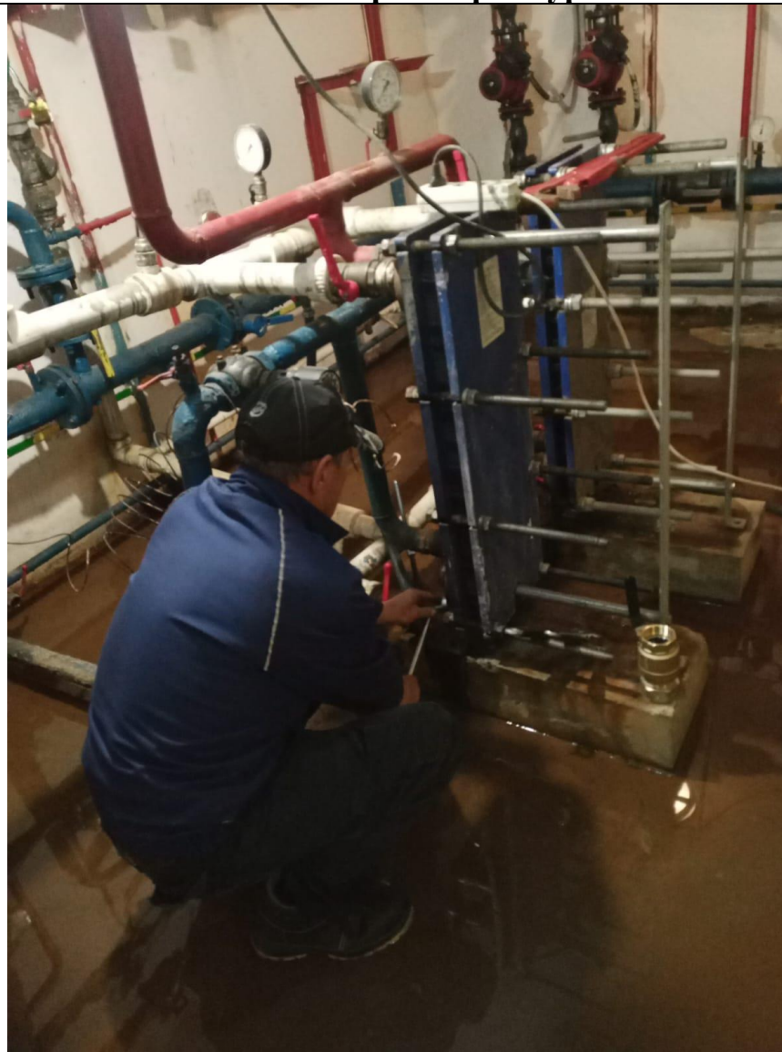
Замена запорной арматуры.
