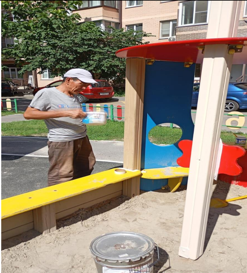
Ремонт элементов детской площадки.
