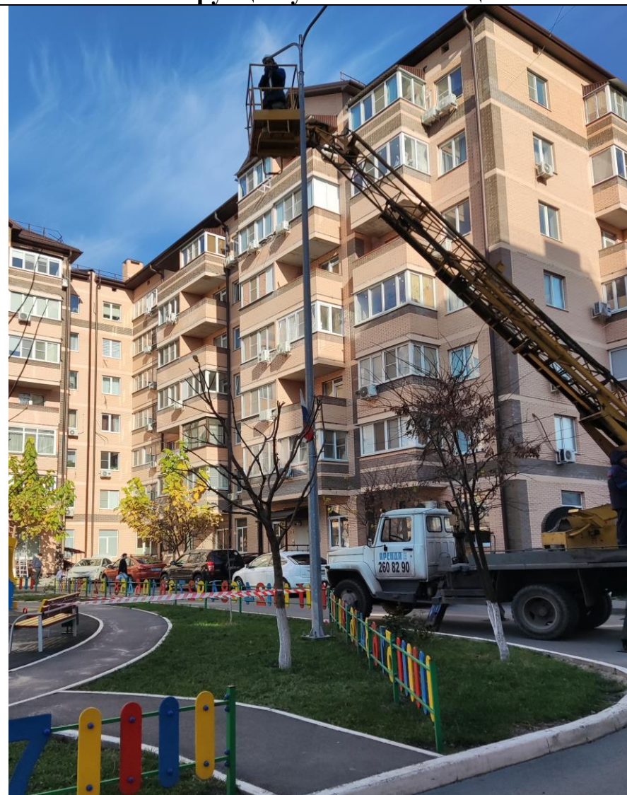
Реконструкция уличного освещения.
