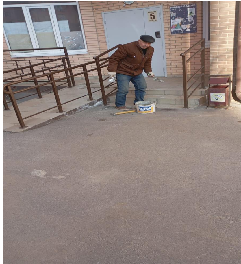
Демонтаж / монтаж тротуарной плитки
