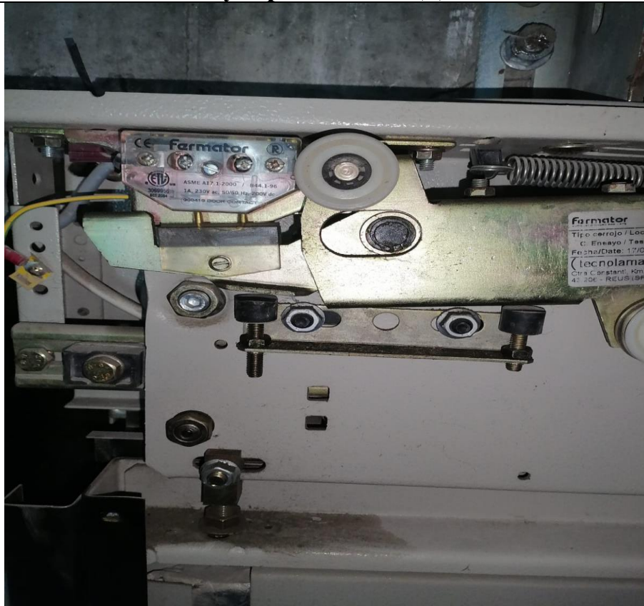
Регулировка замка ДШ
