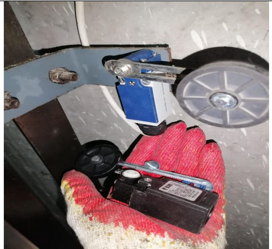
Замена концевого выключателя
