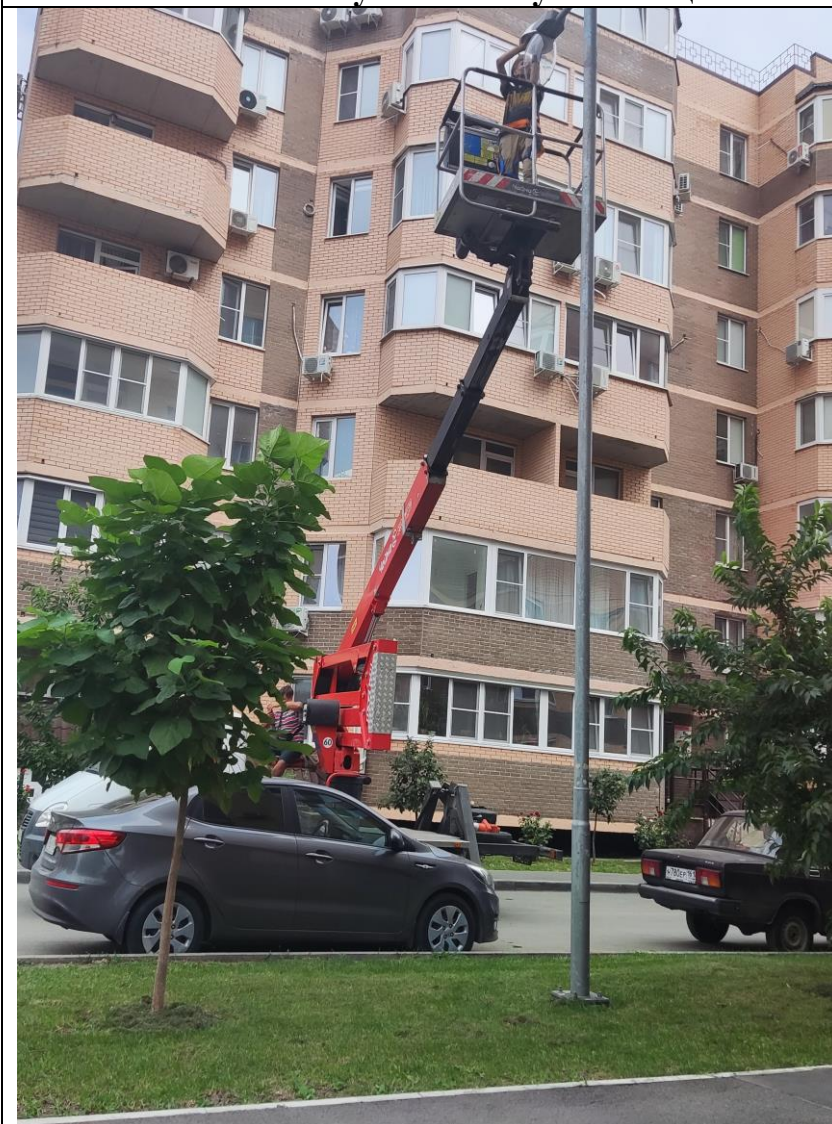
Замена ламп и пускателей ул. освещения.
