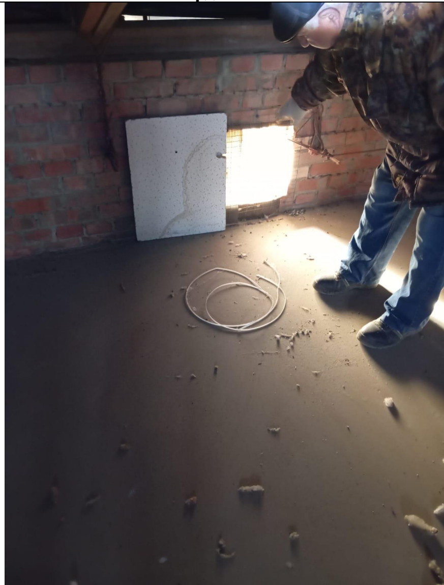
Утепление чердачных помещений
