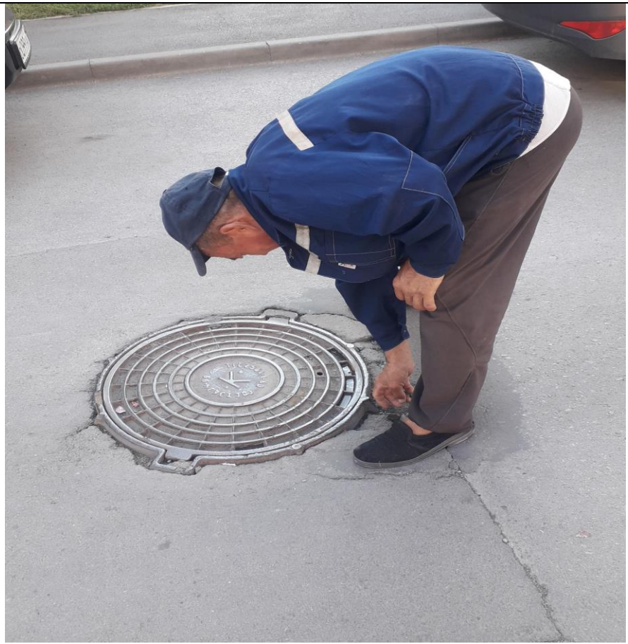
Восстановление провалов дорожного покрытия.
