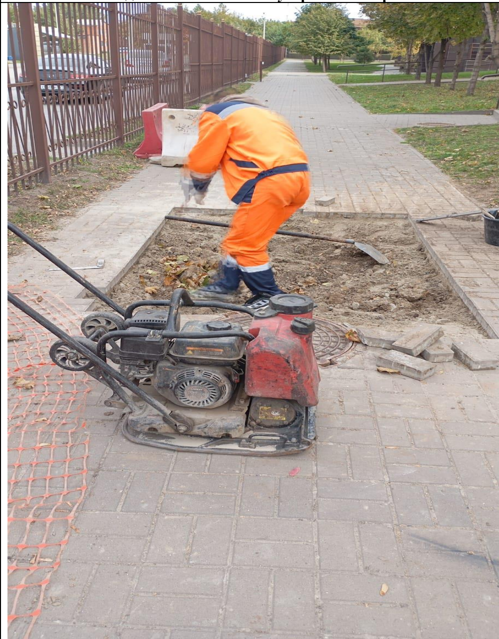
Укладка плитки на месте устранения порыва
