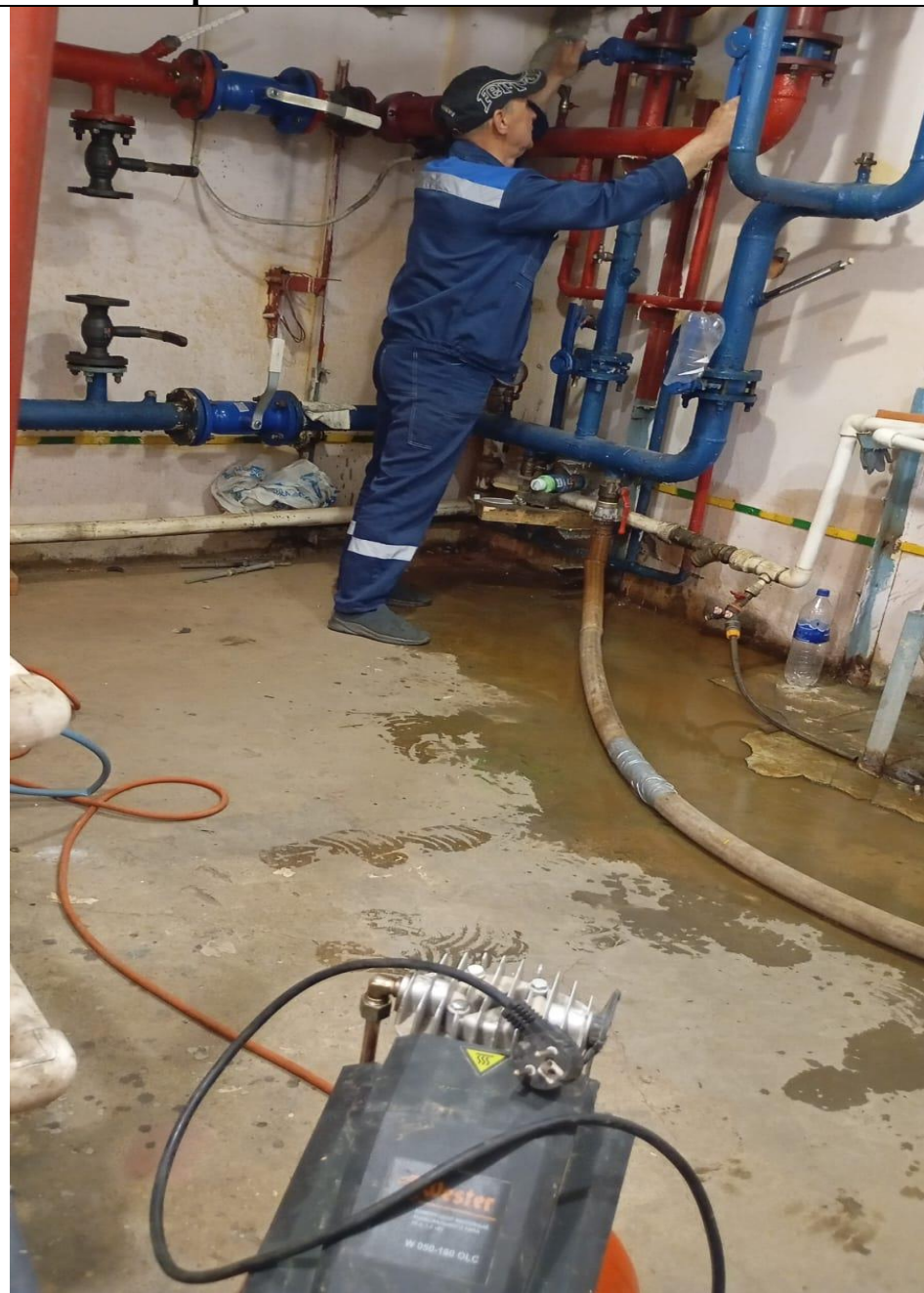
Промывка системы отопления Лит А
