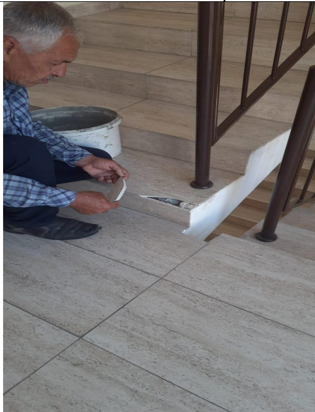
Ремонт плитки на лестничных маршах.
