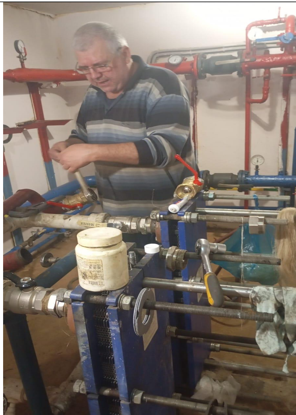
Ремонт теплообменника
