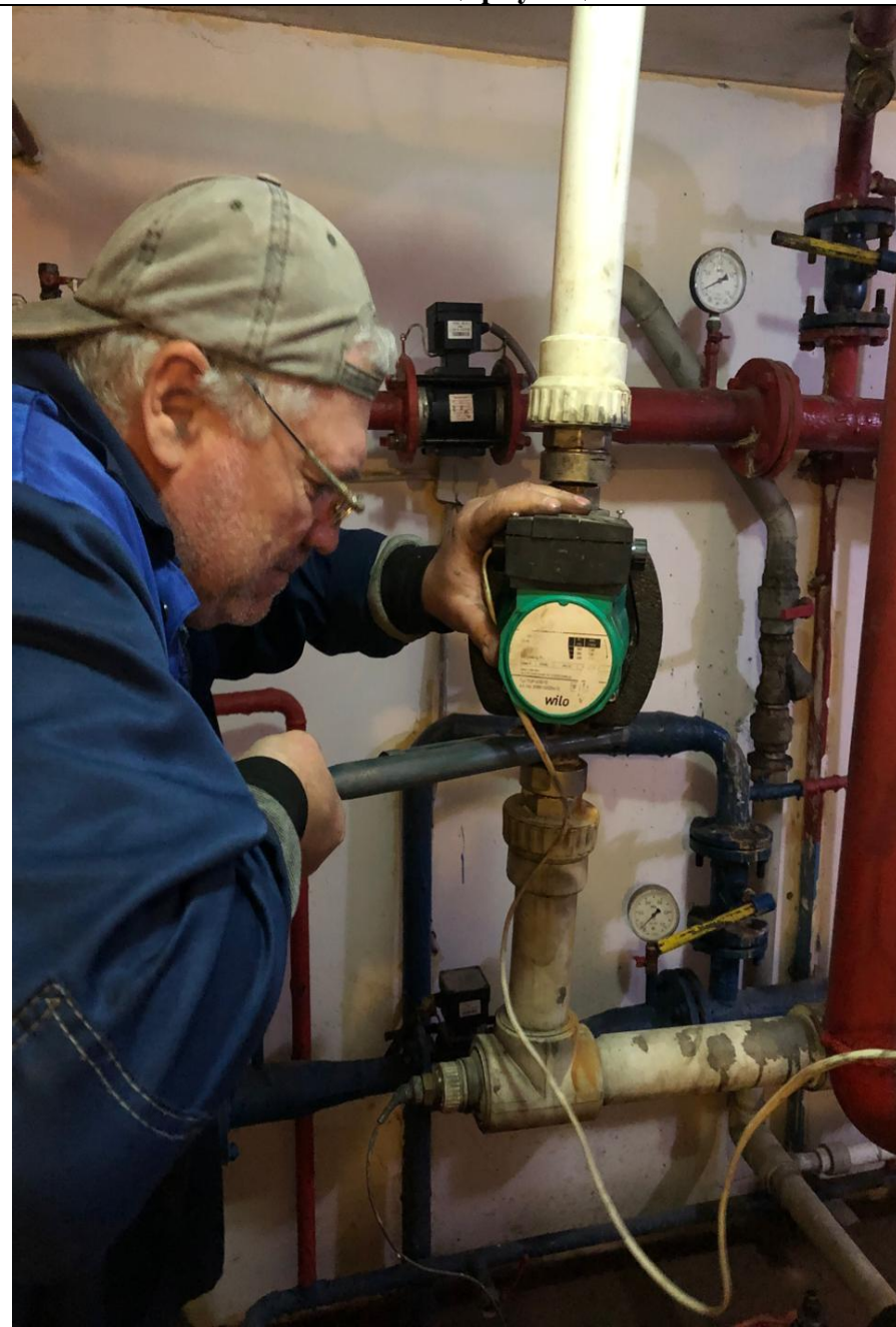
Установка циркуляционного насоса.
