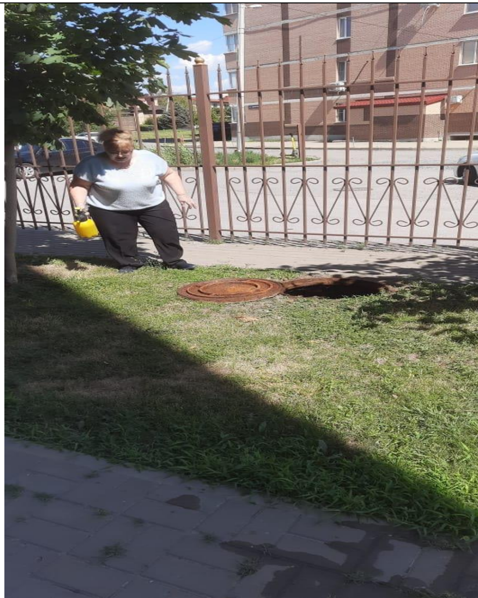
Дезинсекция системы канализации
