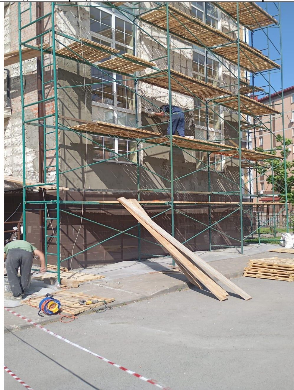
Подготовка фасада для восстановления плиточного покрытия
