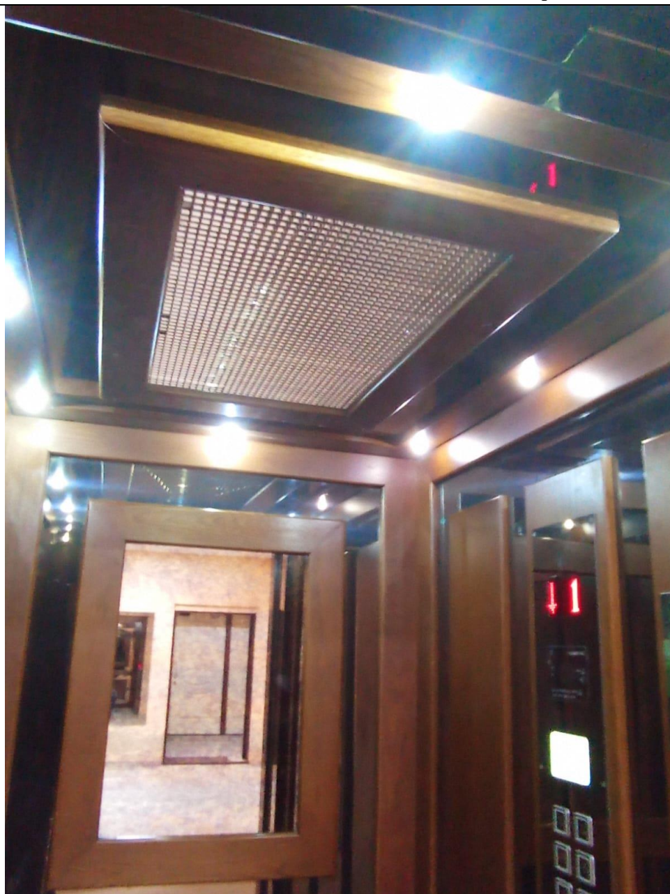
Замена всех лампочек на светодиодные в лифтах.
