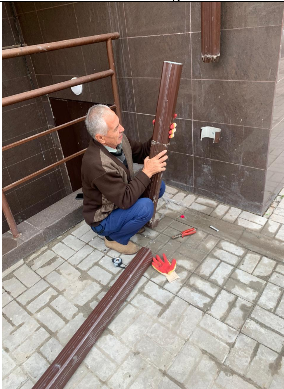
Монтажливневой трубы.
