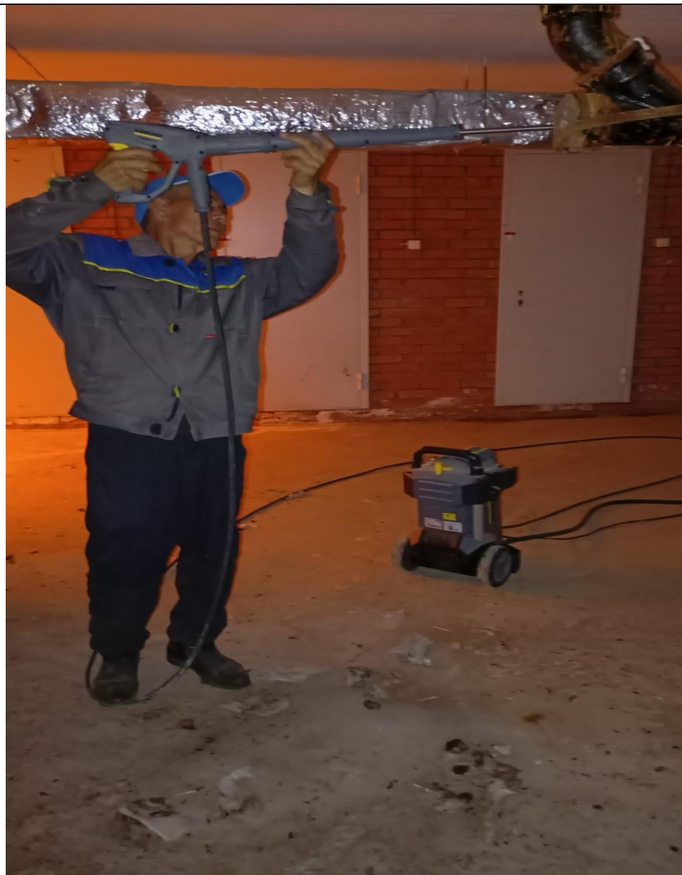
Промывка лежаков канализации
