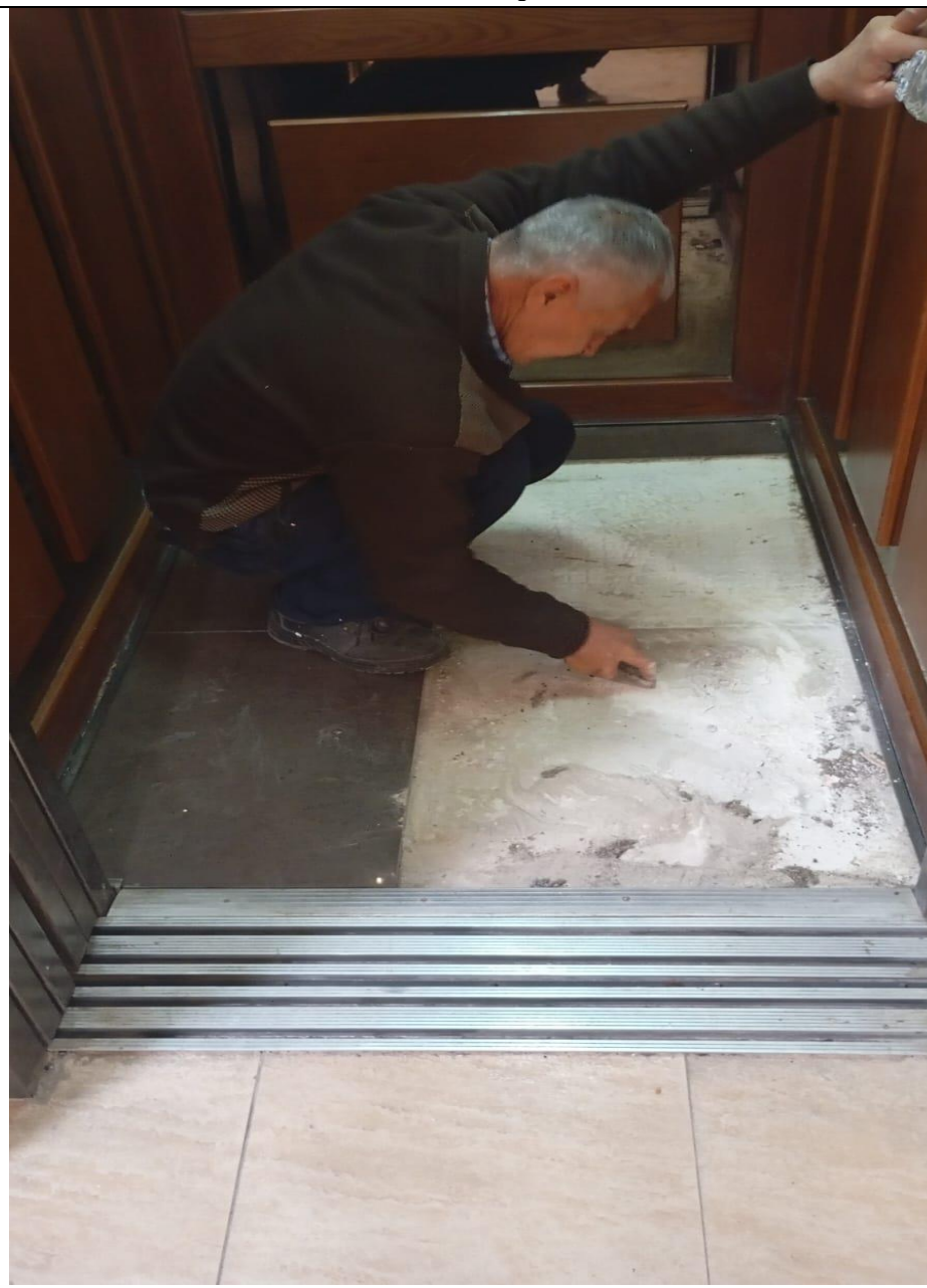
Замена плитки в лифте 4й подъезд
