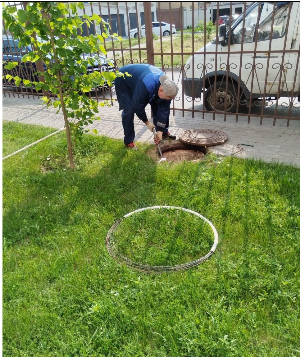
Устранение забоя канализации
