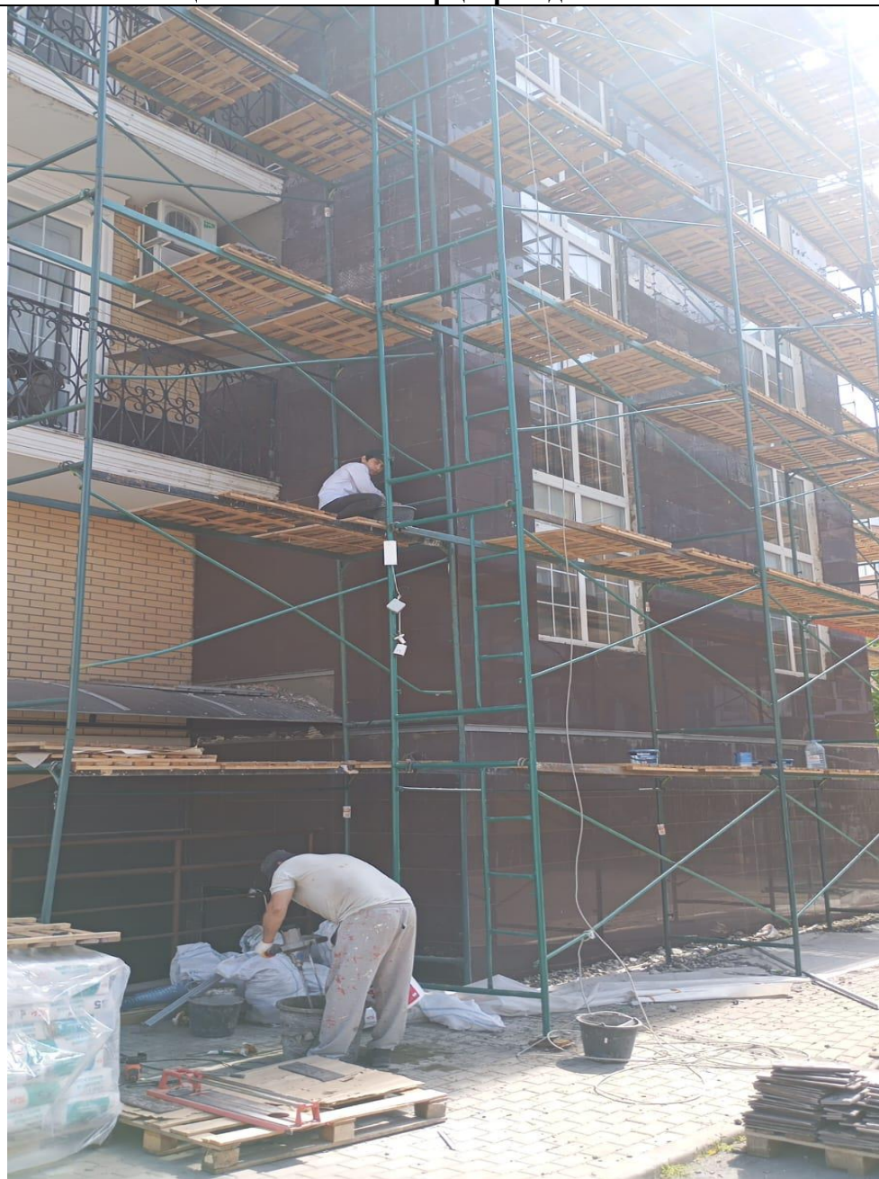
Облицовка плиткой с торца фасада по всей высоте
