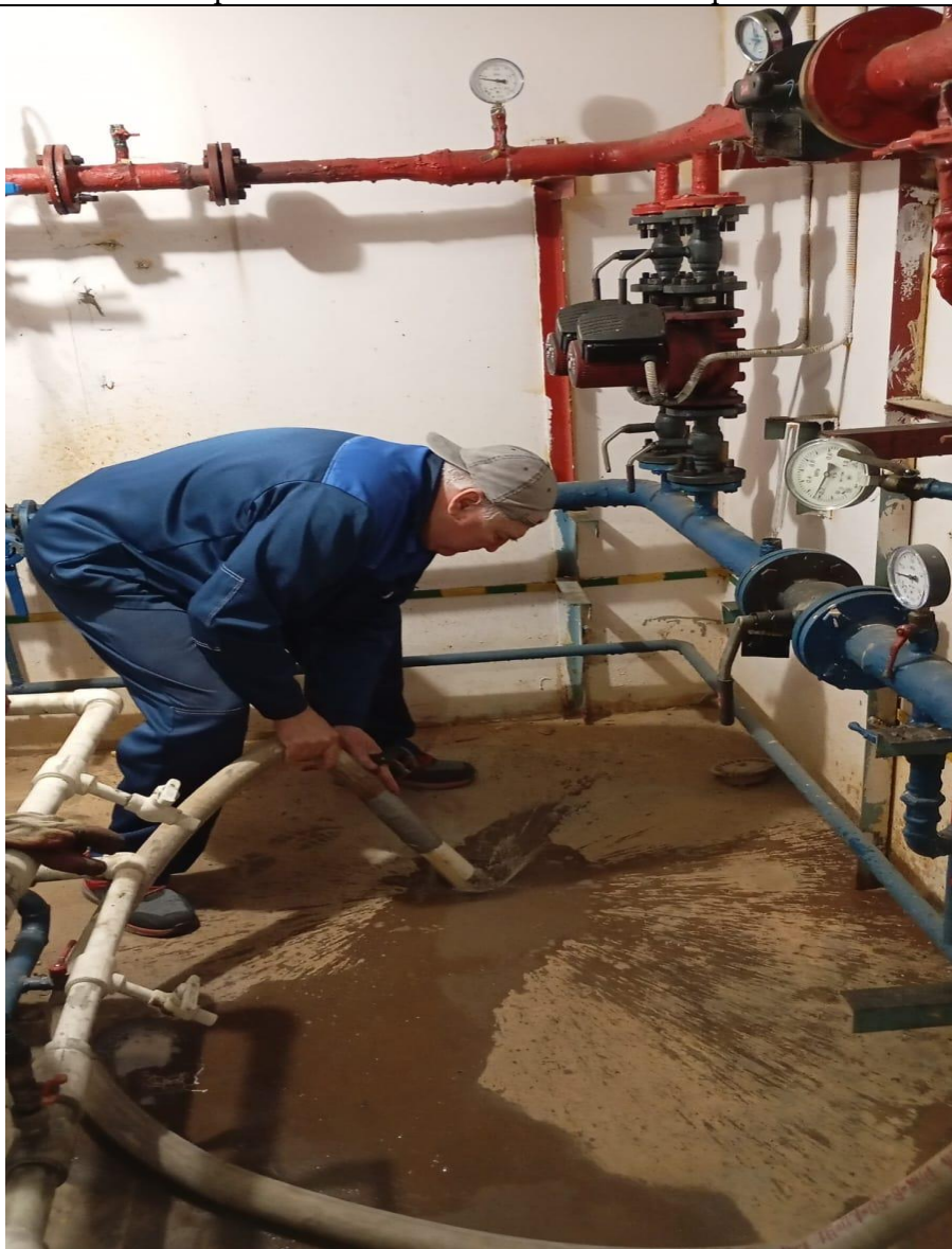
Промывка системы отопления литер Б
