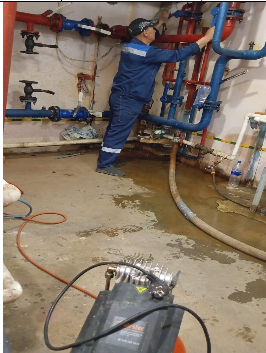
Промывка системы отопления литер А
