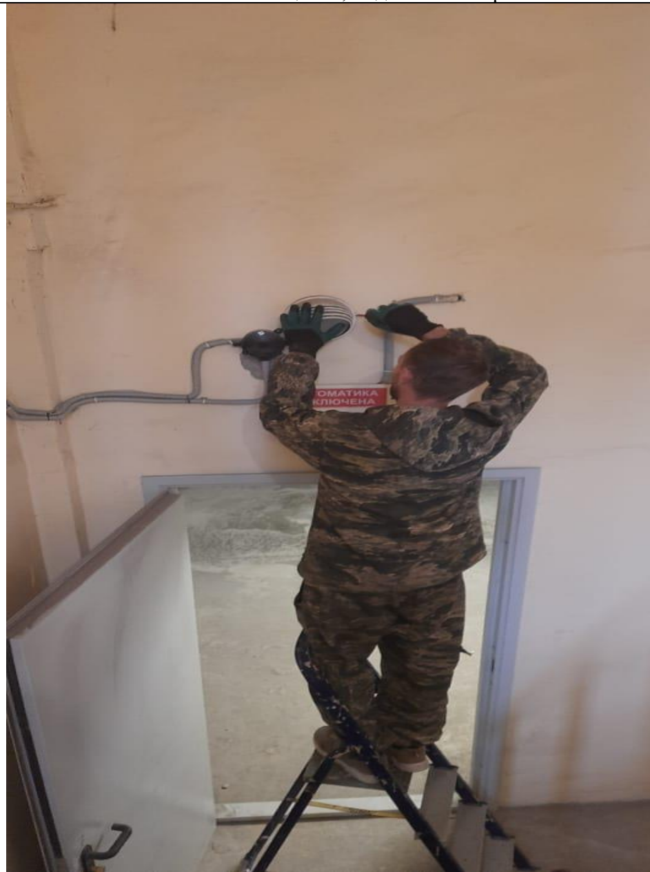
Замена ламп освещения, подземной парковки
