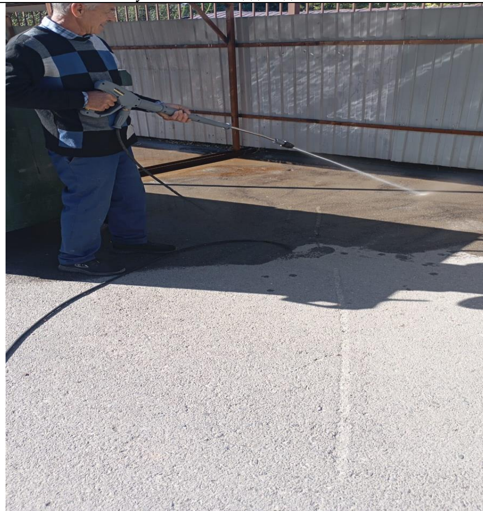
Обслуживание площадки для вывоза ТБО
