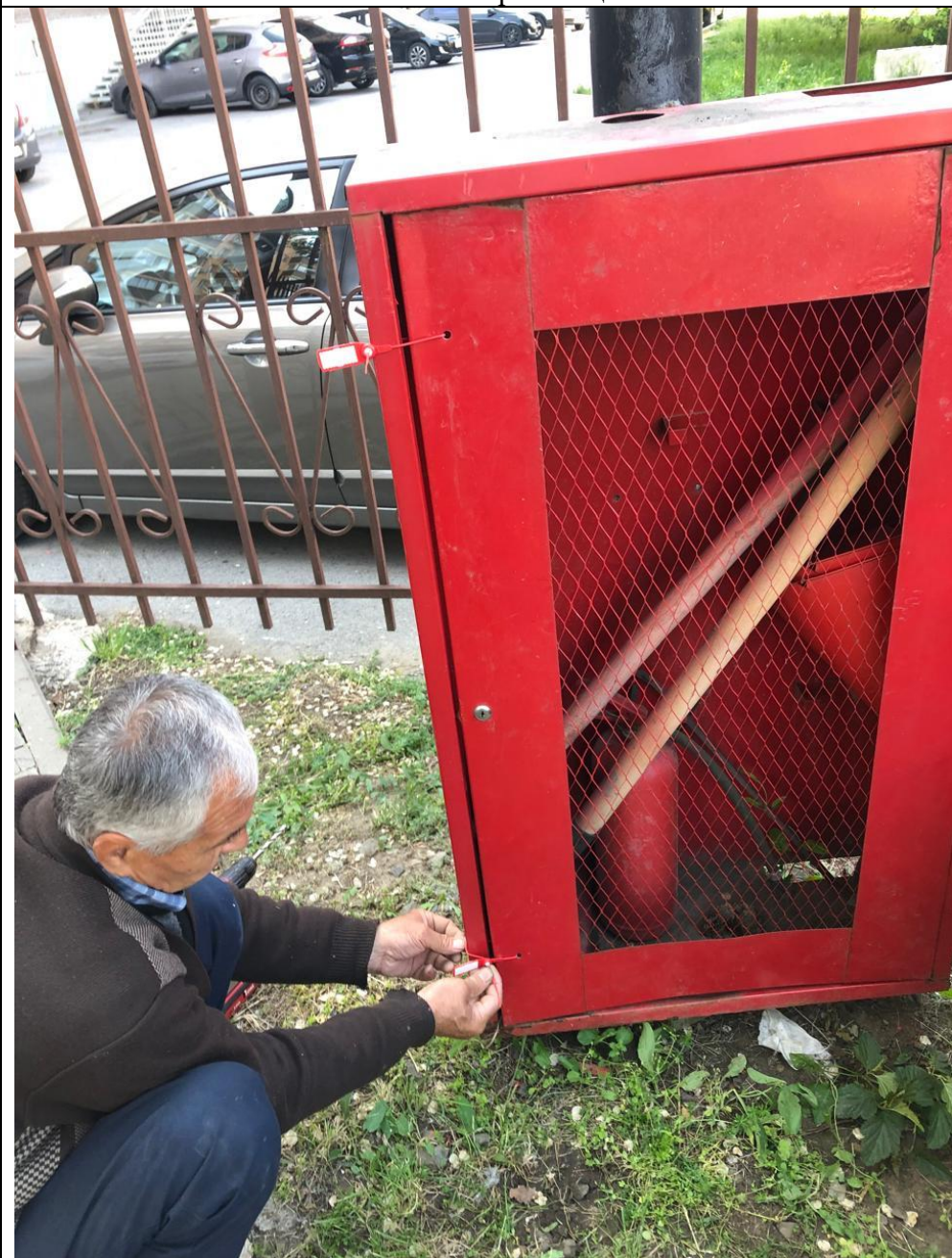
Ремонт пожарного щита.
