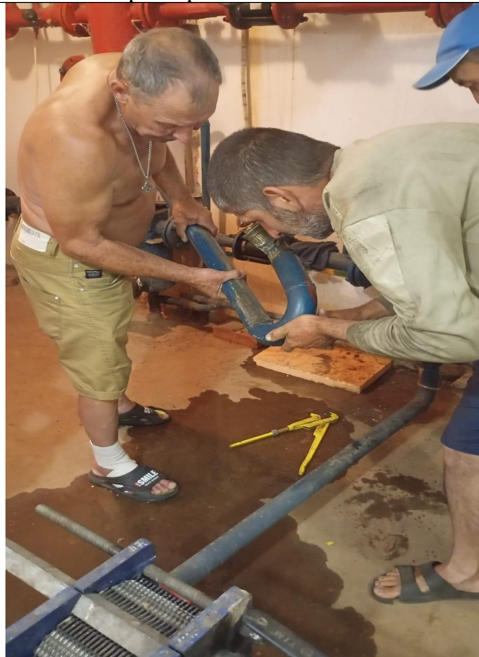
Сварочные работы система ХВ
