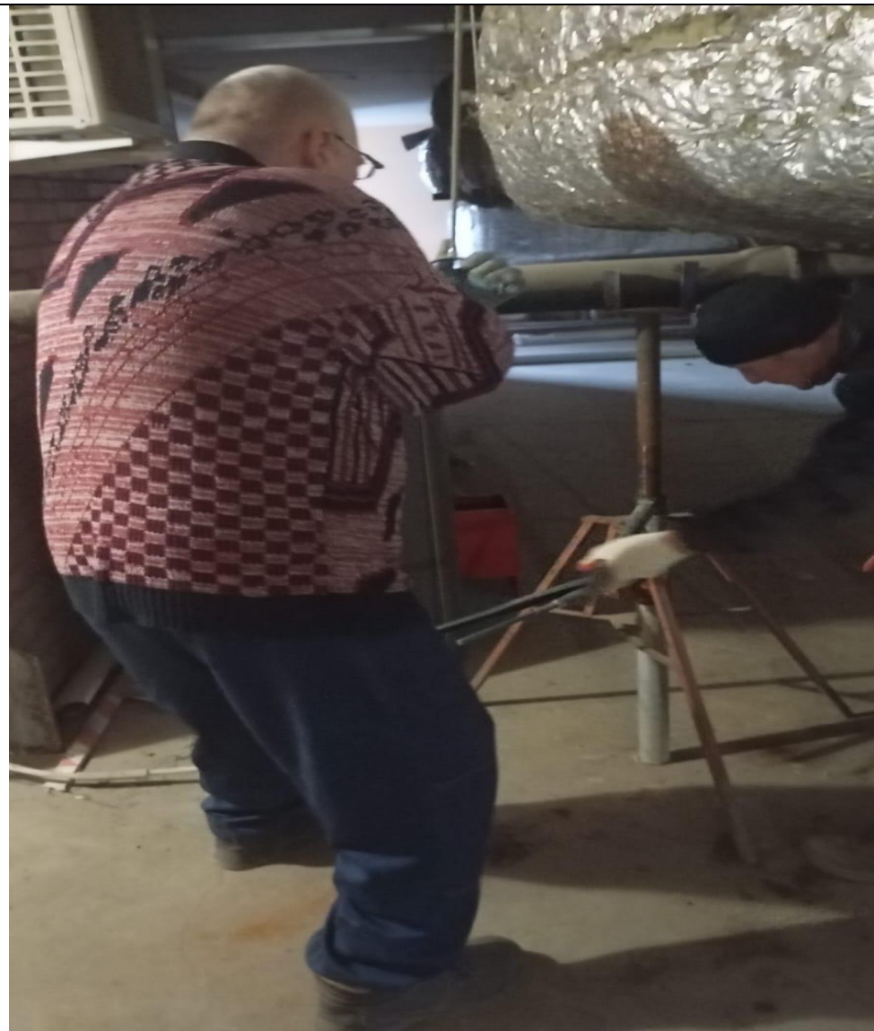
Ремонт канализационной системы
