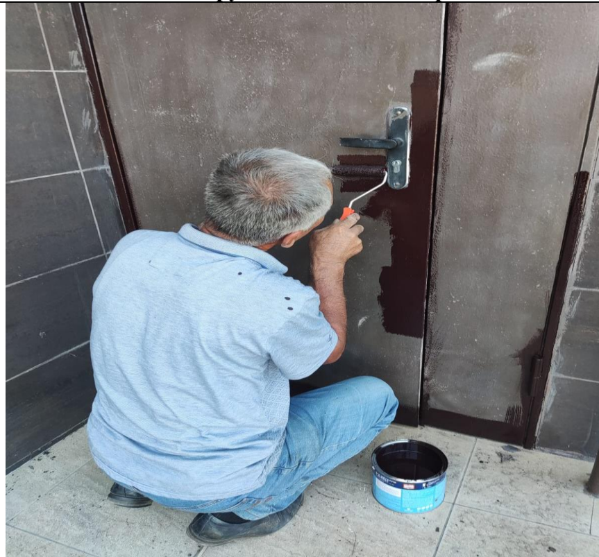
Замена ручек на входных дверях
