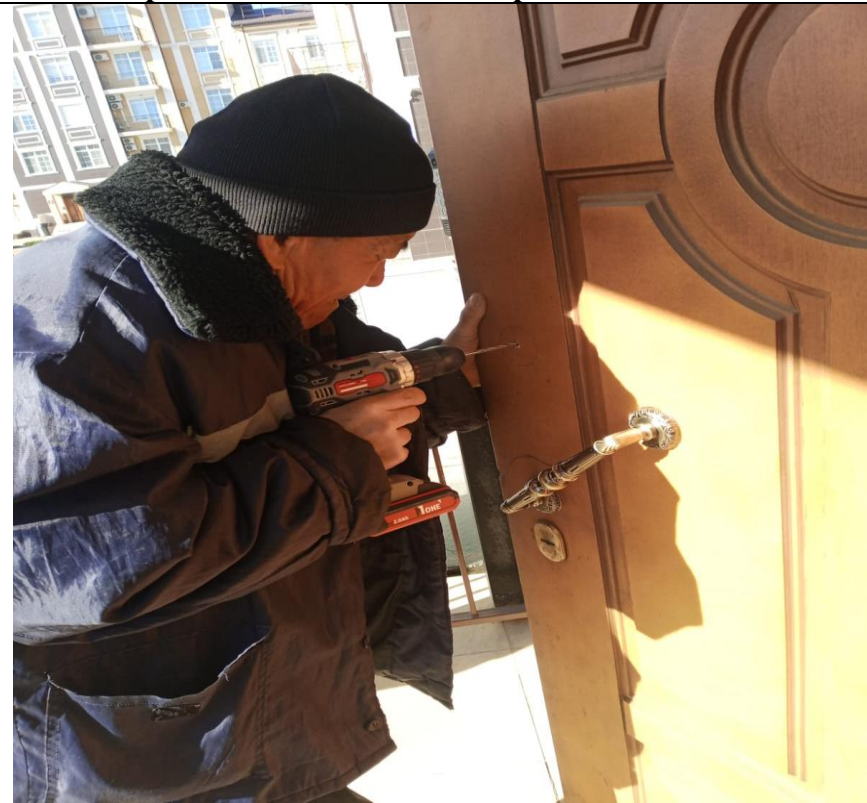
Покраска металлических дверей тех.помещений.
