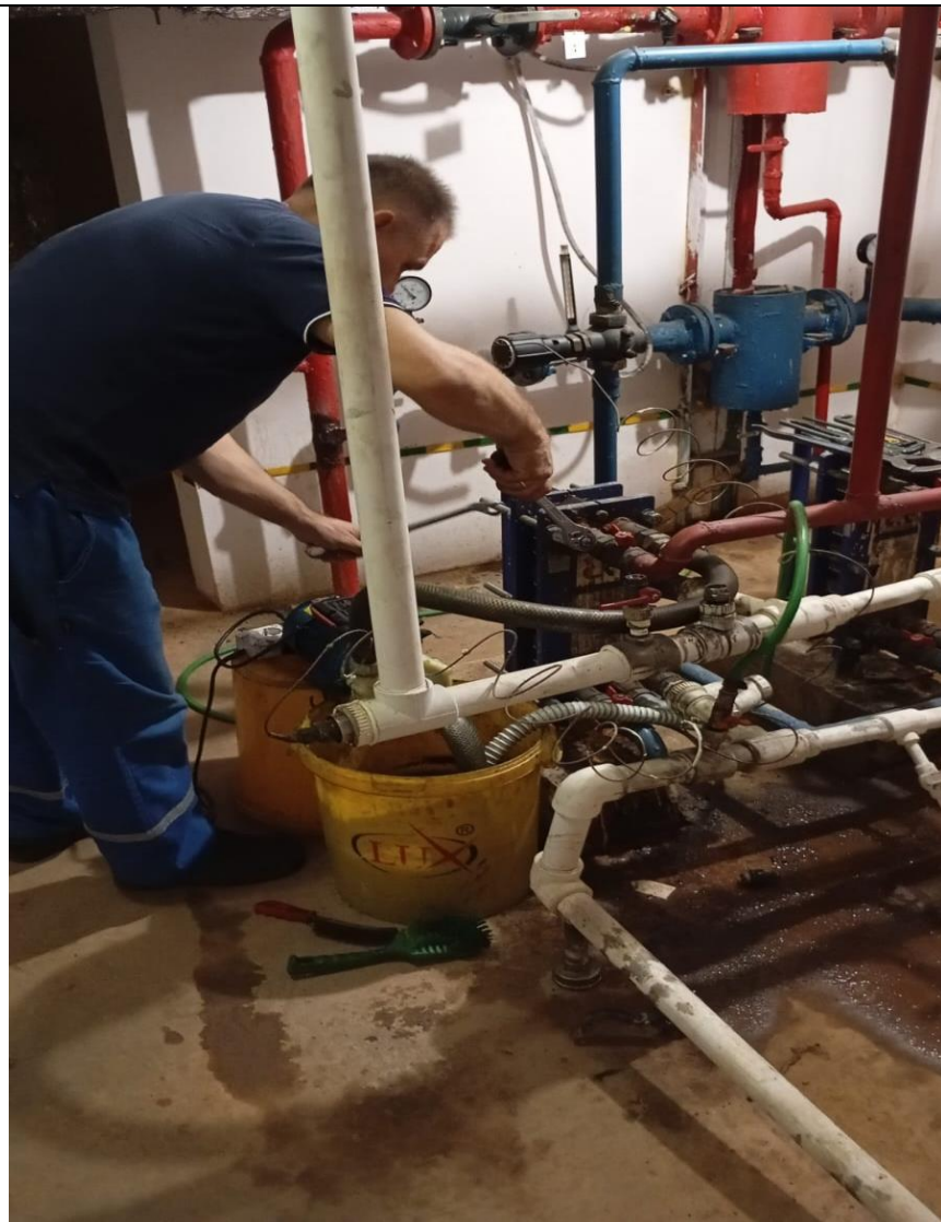
Замена пластин теплообменника в ИТП.
