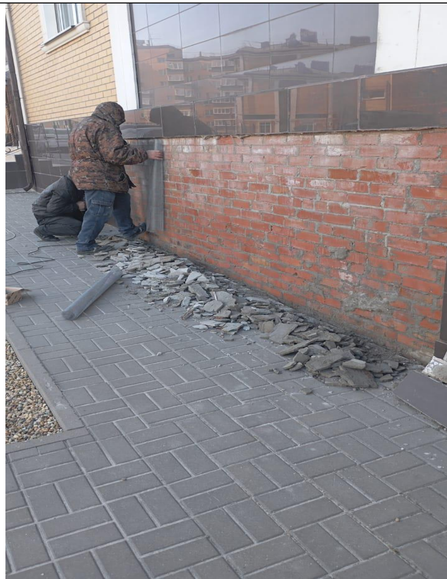
Восстановление плитки на фасаде здания
