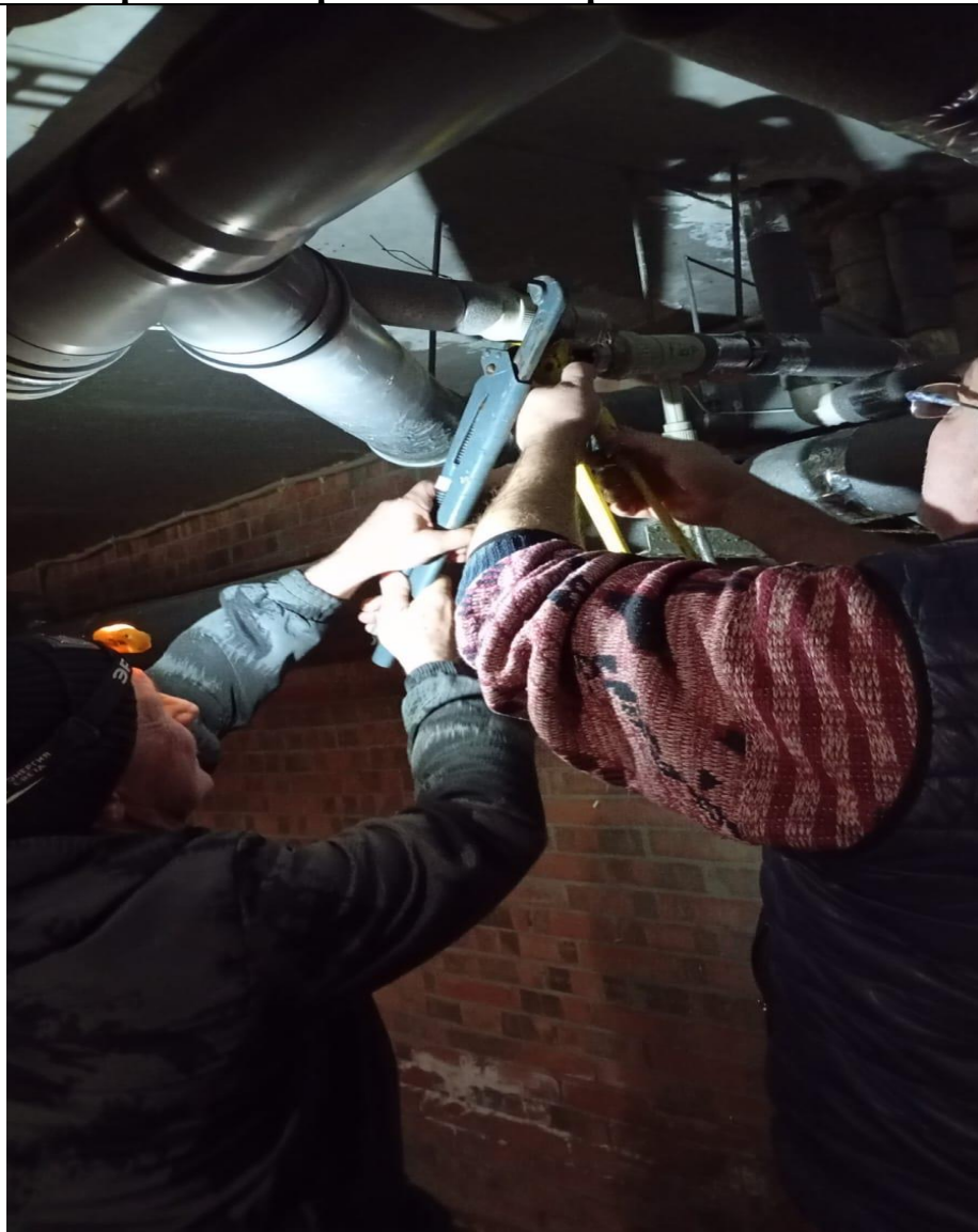
Прочистка грязевиков и обратных клапанов
