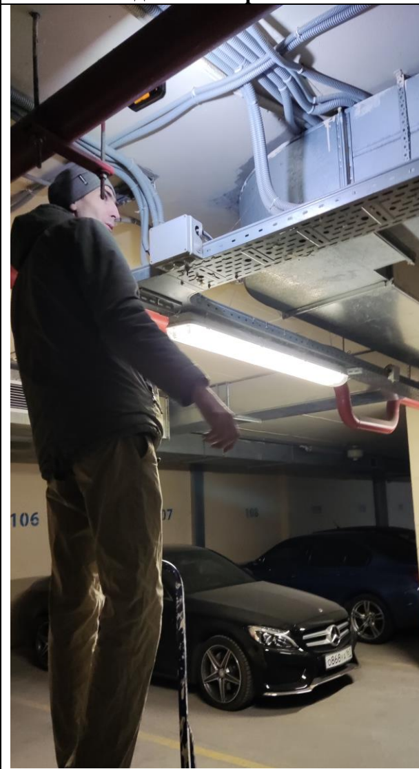
Замена ламп и светильников на подземной парковке.
