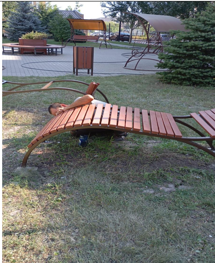
Окраска и ремонт лежака
