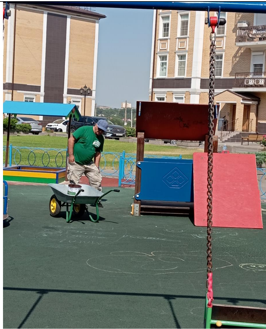
Ремонт детской площадки
