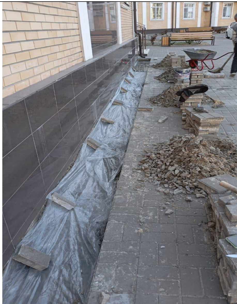
Гидроизоляция фундамента здания
