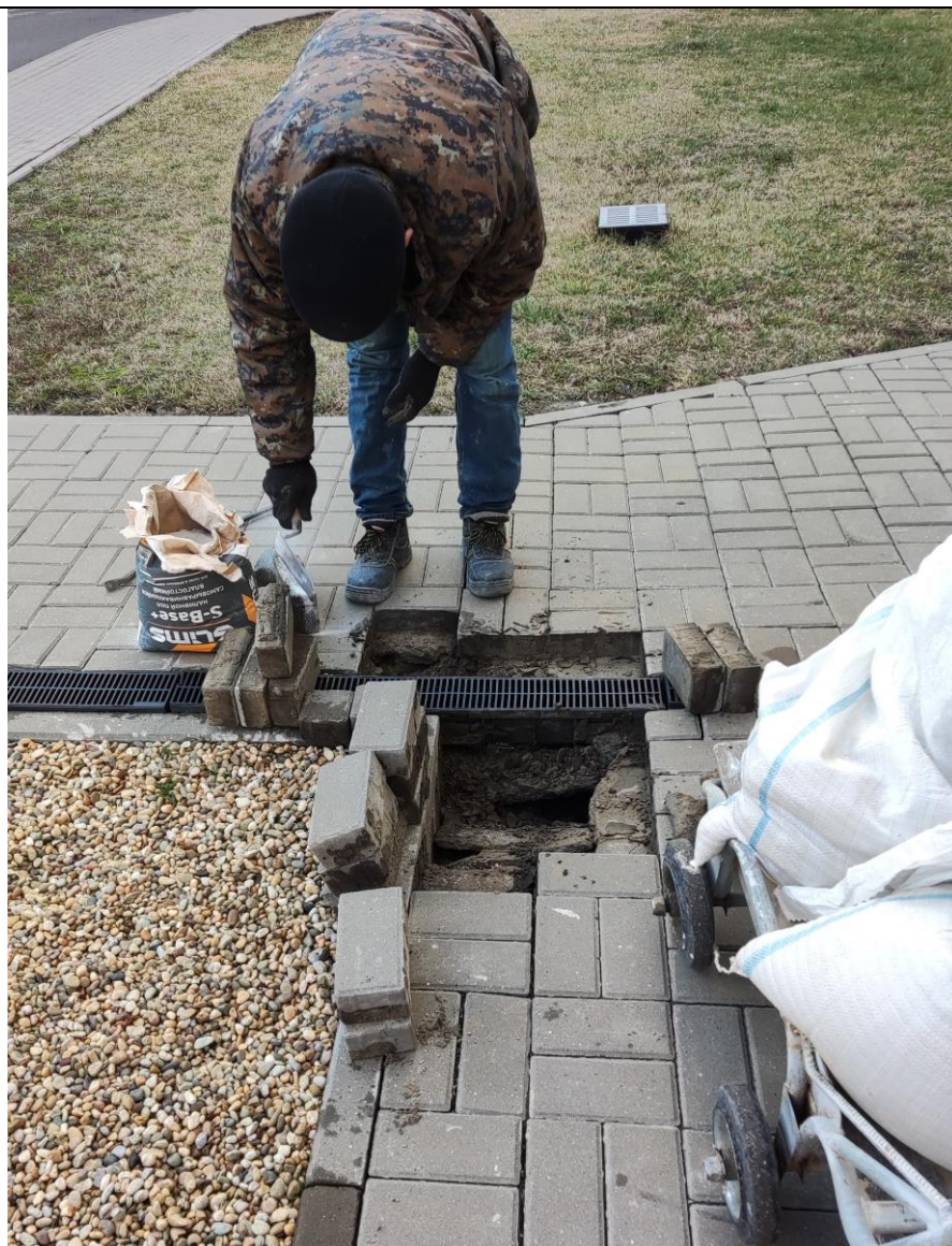
Восстановление тротуарной плитки.
