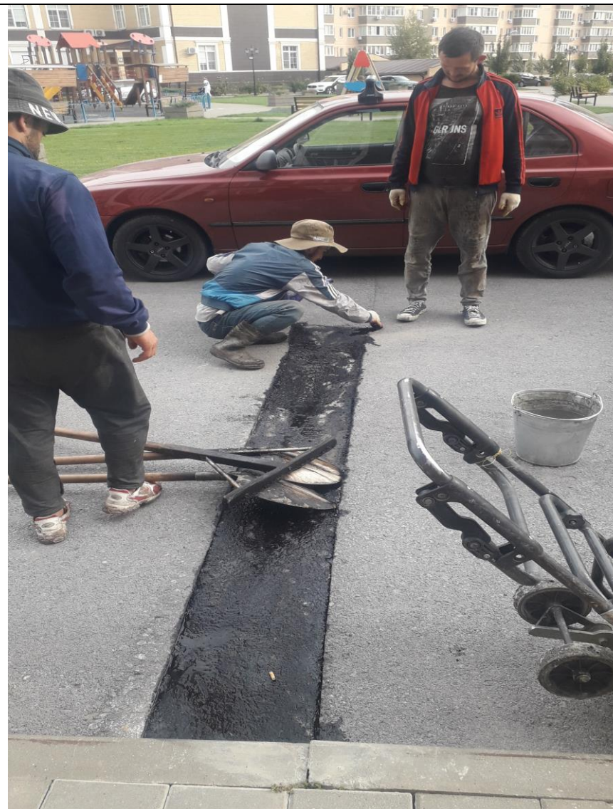
Асфальтирование проезжей части.
