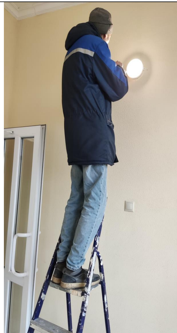
Замена светильников в МОП.
