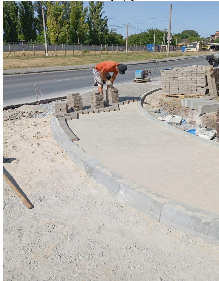
Восстановление тротуарной плитки
