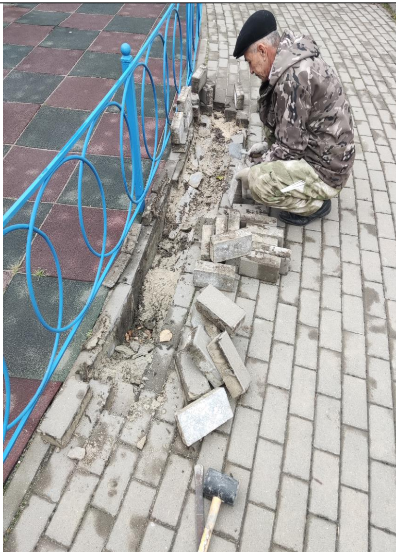
Демонтаж/монтаж тротуарной плитки.
