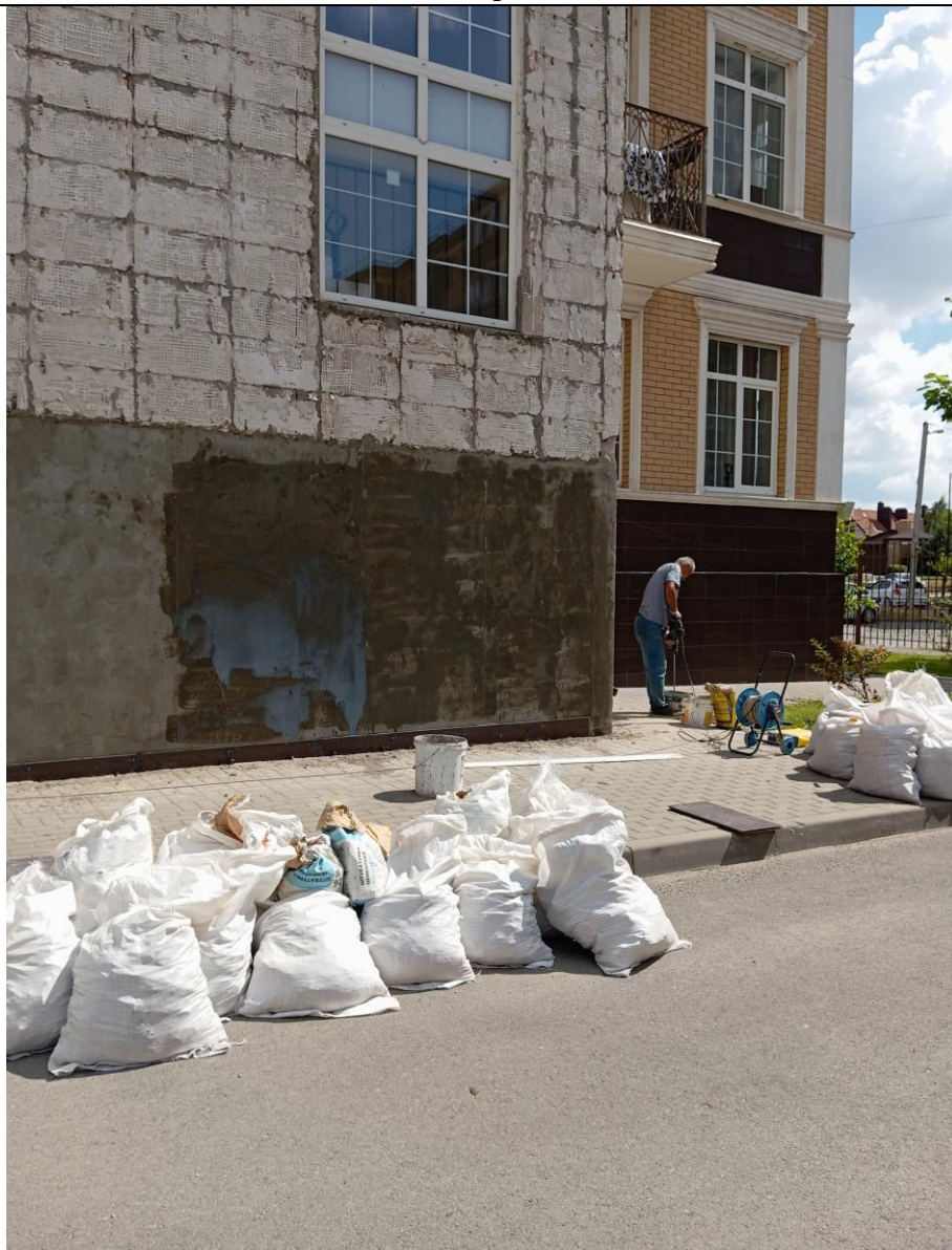
Восстановление фасадной плитки
