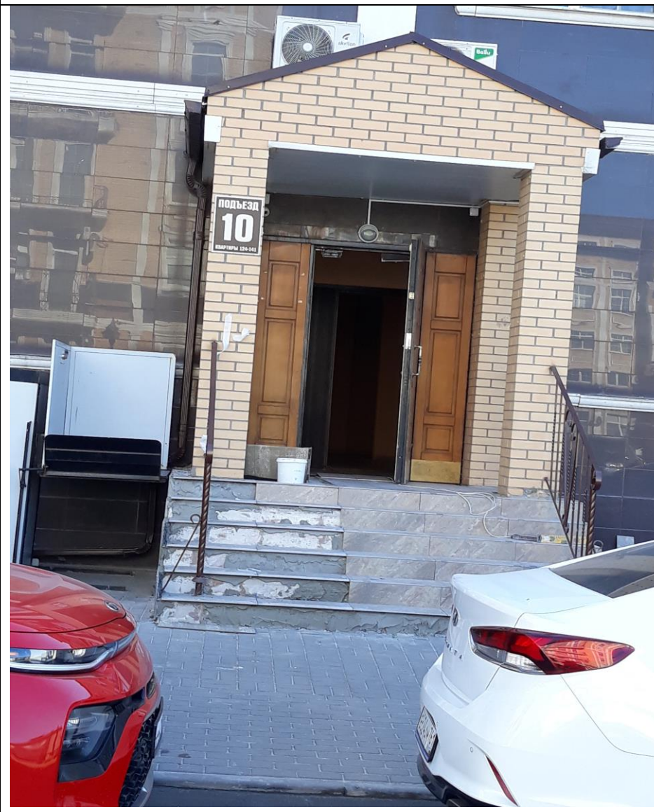
Замена напольной плитки входных групп.
